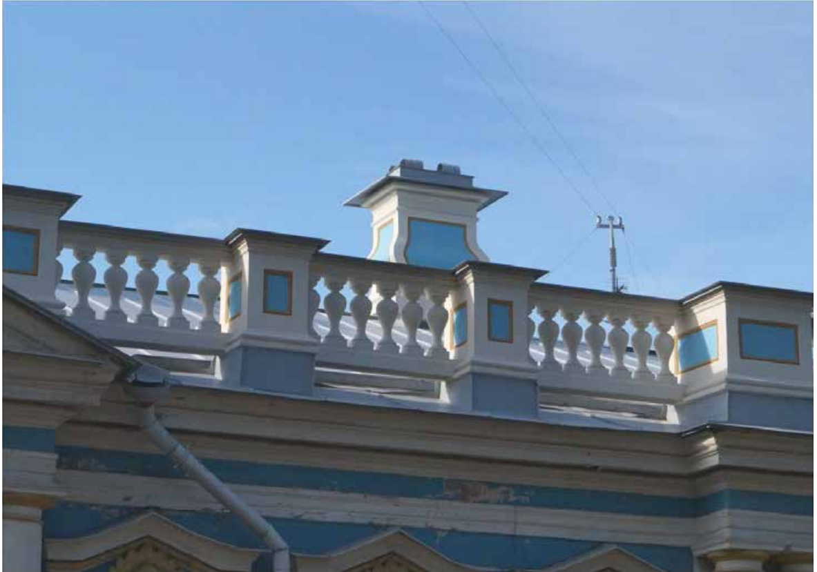
Фото 58. Вид на существующую антенну (точка подключения проектируемых сетей радиовещания) на крыше здания Правой Циркумференции.
