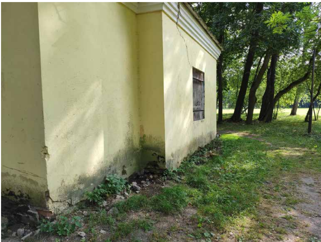
Фото 5. Вид на северный фасад туалета и прилегающую территорию.
