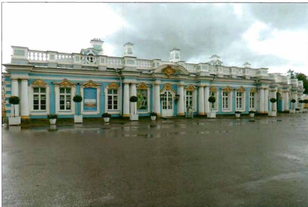
2. Общий вид с северо-запада.
