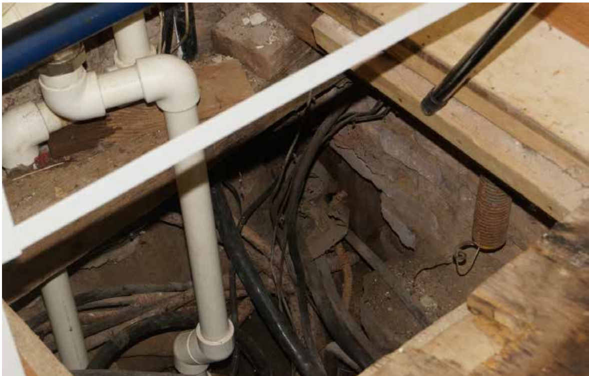
Фото 60. Вид на выход (вход) сетей проводного радиовещания из (в) здания Правой Циркумференции в существующей трубе.
