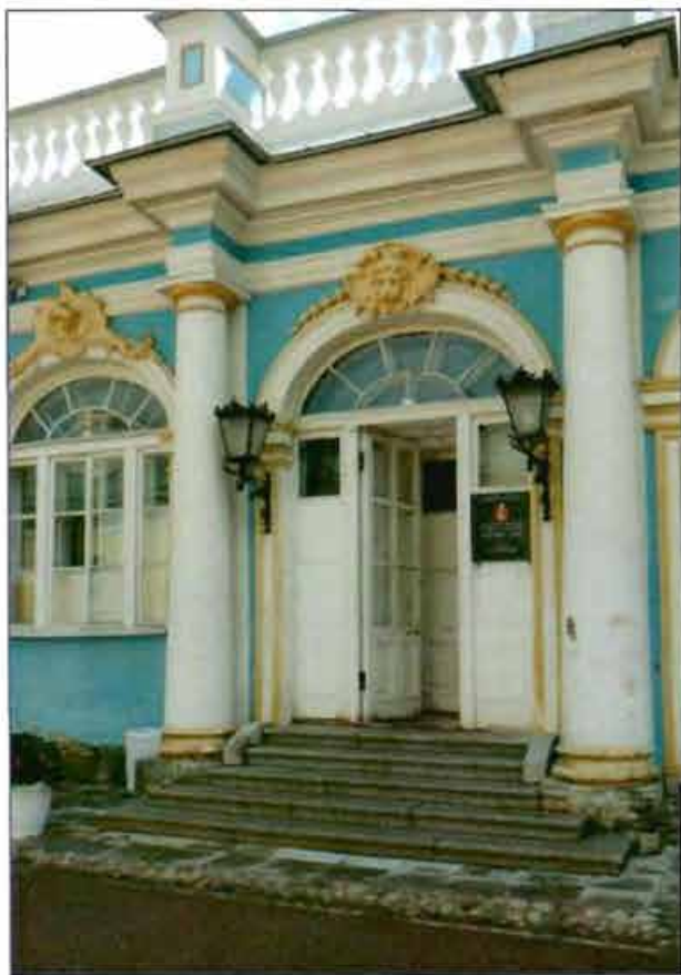
7. Северо-западный фасад. Фрагмент. Главный вход.
