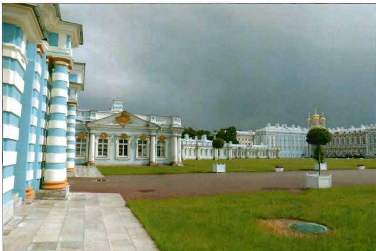
5. Общий вид с юго-запада.
