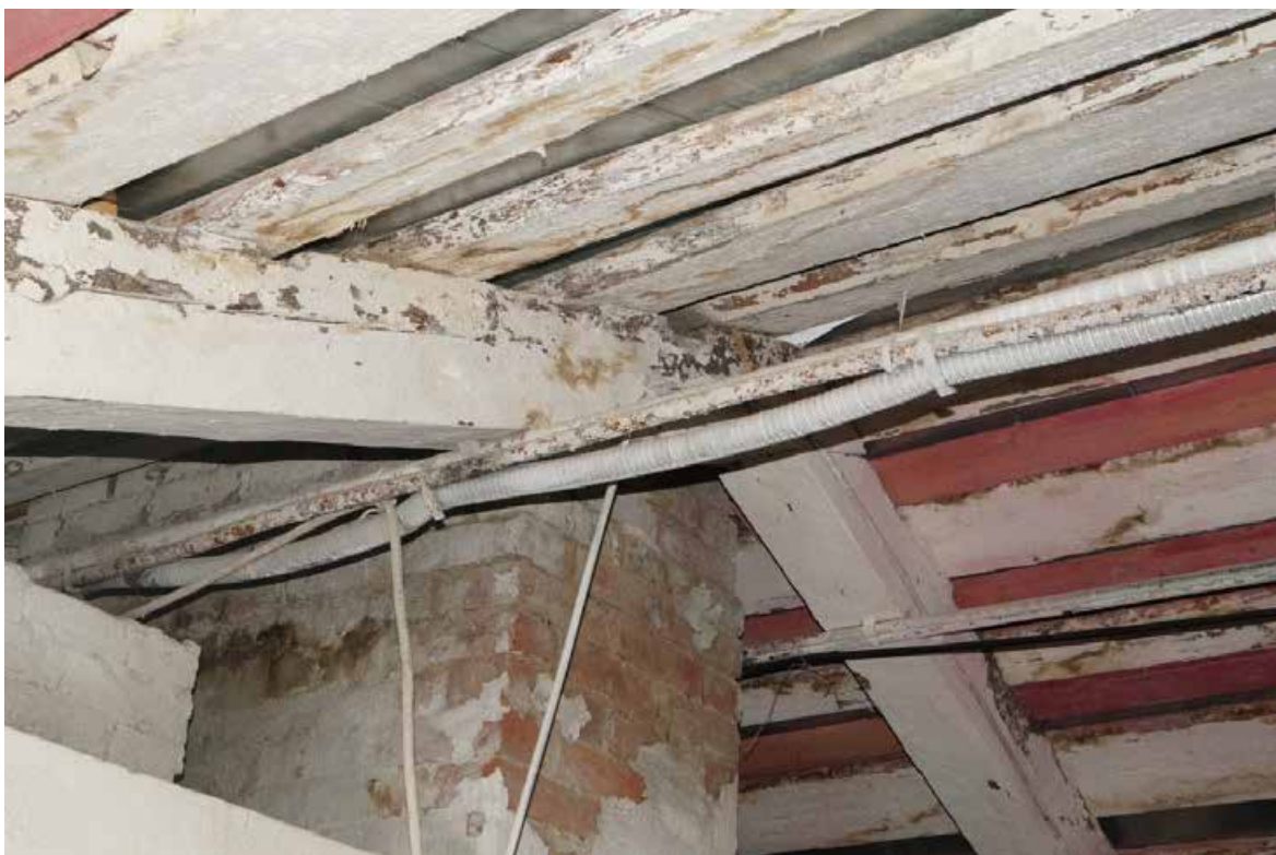
Фото 62. Вид на зону прокладки сетей проводного радиовещания (вне конструкций, в зоне существующих сетей под кровлей чердака здания Правой Циркумференции).
