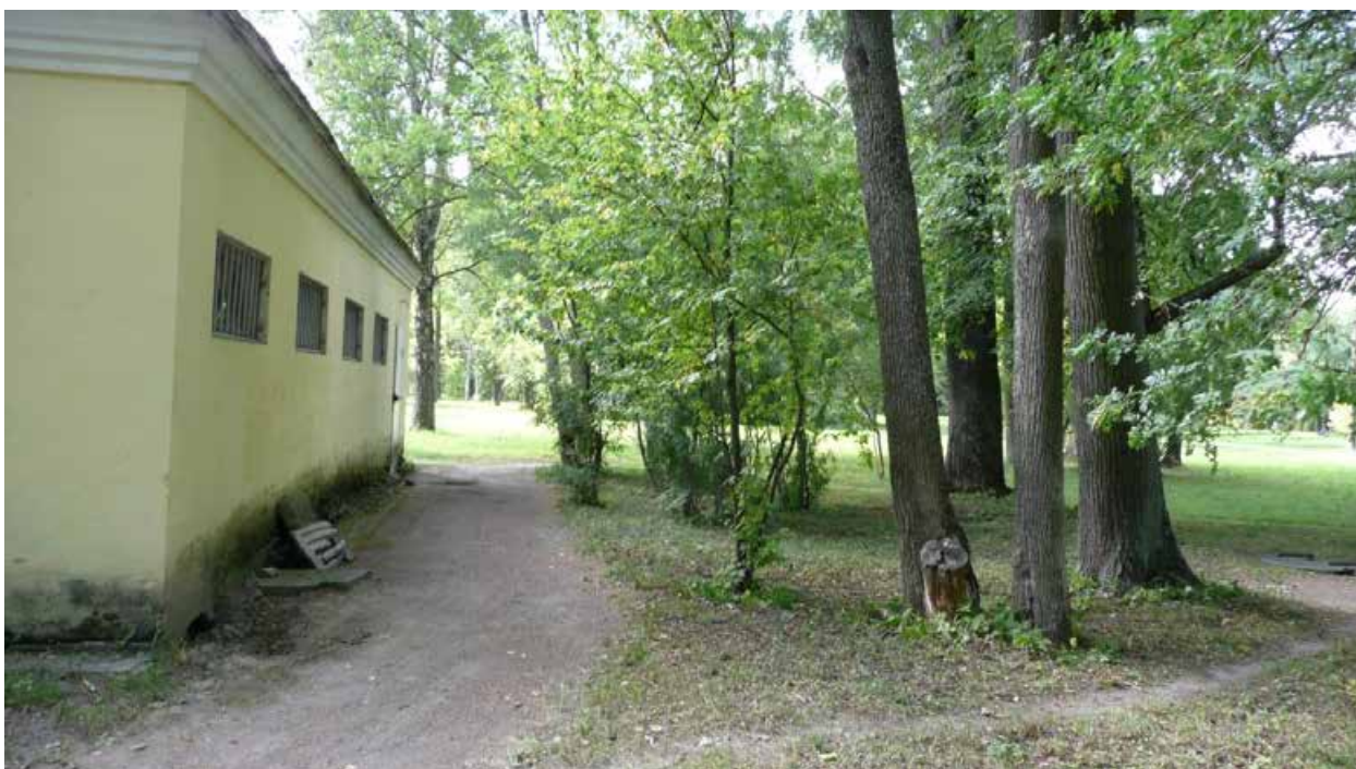
Фото 6. Вид на восточный фасад здания туалета и прилегающую территорию, вокруг туалета устроена набивная площадка.
