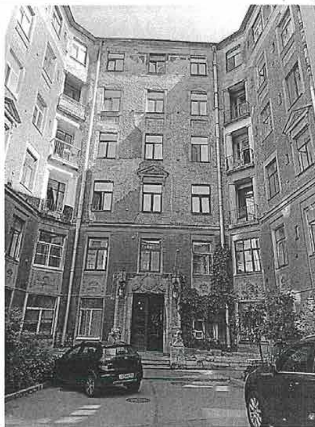
Фото 22. Дворовые фасады внутреннего двора, где расположена парадная № 9. Ненадлежащее состояние штукатурной отделки фасадов.
