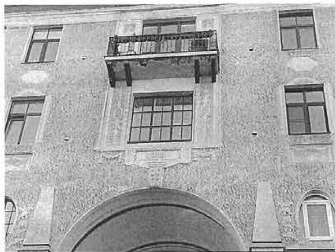
Фото 2. Фрагмент лицевого фасада со стороны наб. реки Фонтанки. Наблюдается утраты штукатурной отделки балконной плиты.
