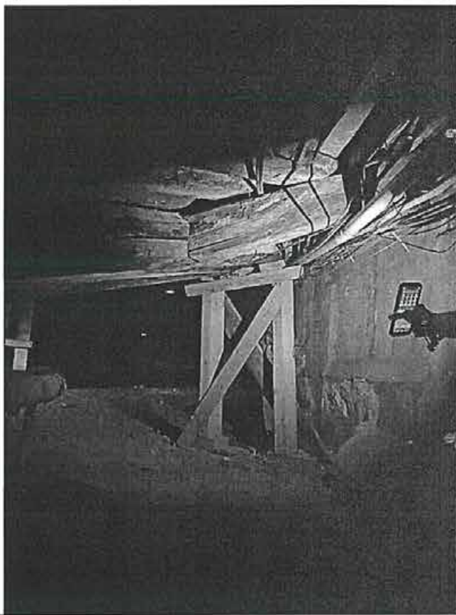
Фото 78. Фрагмент крыши. Имеется подпорная конструкция.
