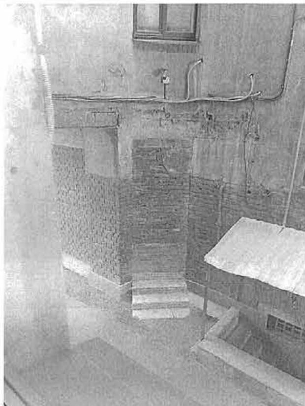
Фото 112. Выполнена закладка проема кирпичом помещения 1-Н
