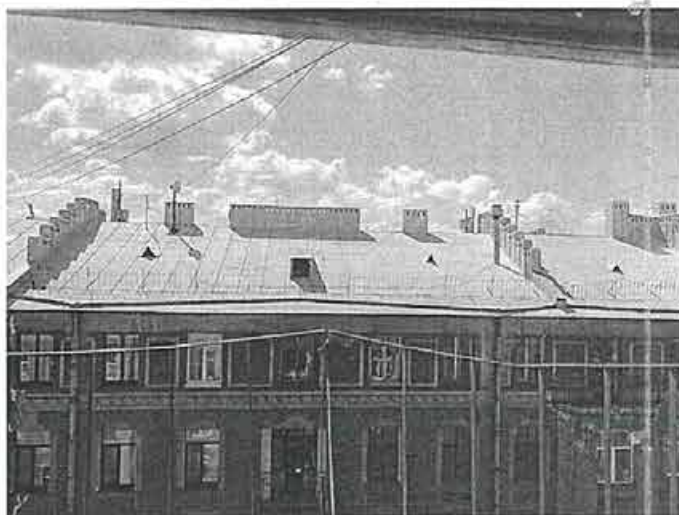
Фото 68. Фрагмент кровли, имеются сквозные отверстия.
