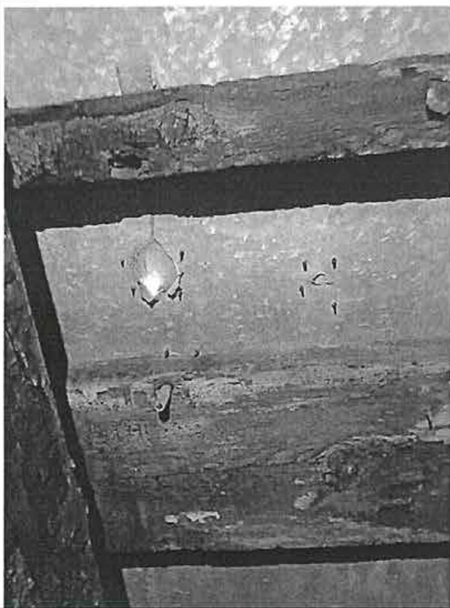
Фото 67. Фрагмент кровли, имеются сквозные отверстия, следы пожара.
