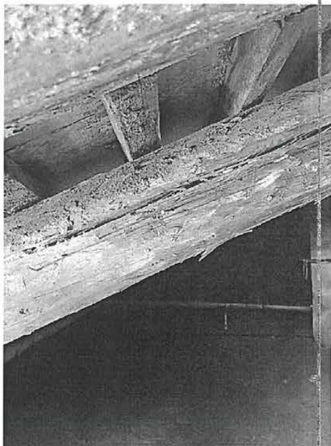
Фото 76. Фрагмент крыши. Наблюдаются трещины стропильных ног.
