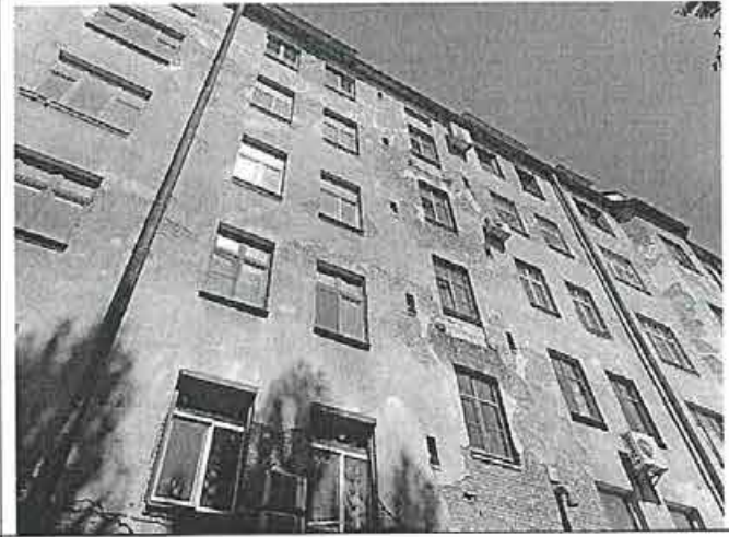
Фото 58. Фрагмент дворового фасада внешнего контура. Балконы в уровне 4 и 6 этажей черной лестничной клетки (где расположены квартиры №№ 156, 157) отсутствуют. Выполнена закладка нижней части указанных проемов блоками из газобетона. Взамен балконных дверей установлены окна
