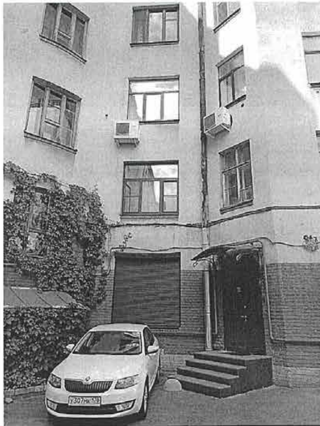
Фото 104. Фрагмент квартиры № 108 (1 этаж). Устройство входа на месте оконного проема и рольставней на окнах
