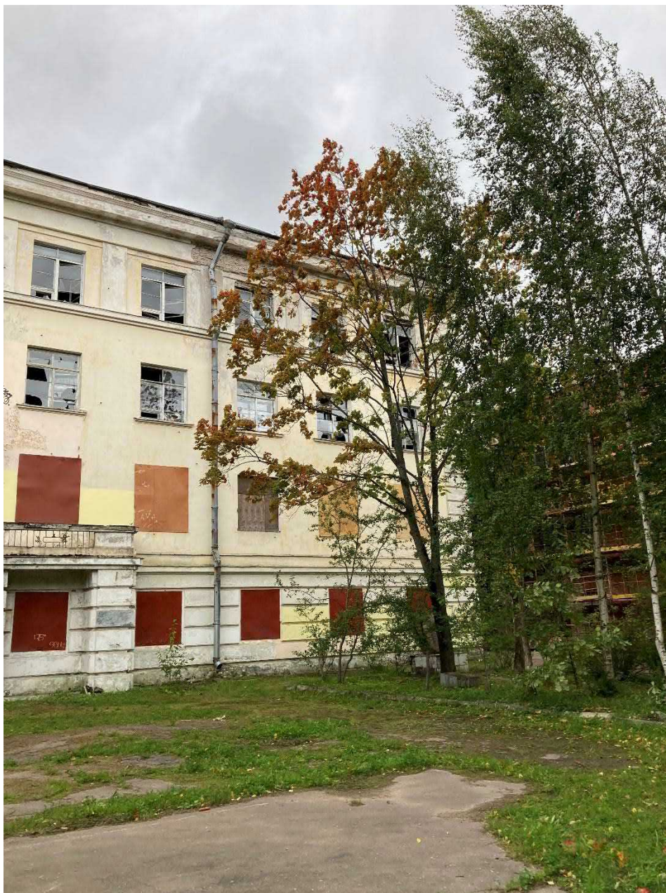
Фото 3. Здание, фасад по ул. Юты Бондаровской. Справа от главного входа в здание (северный фасад)
