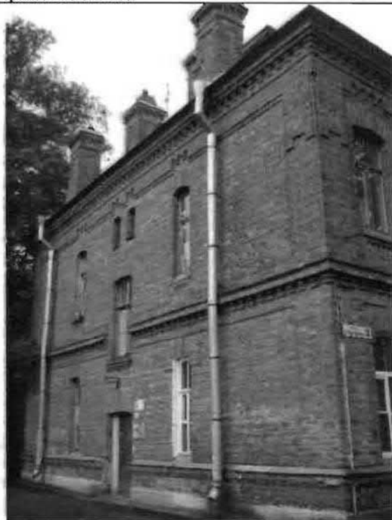
Фото 148. Северный фасад. Общий вид.
