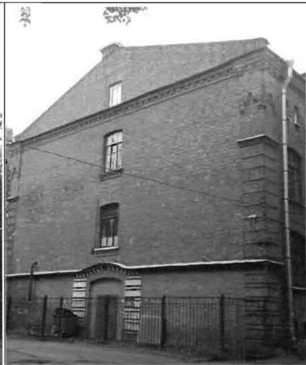
Фото 50. Южный фасад. Общий вид.
