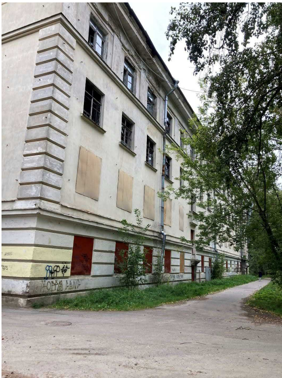
Фото 15. Здание со стороны южного фасада.
