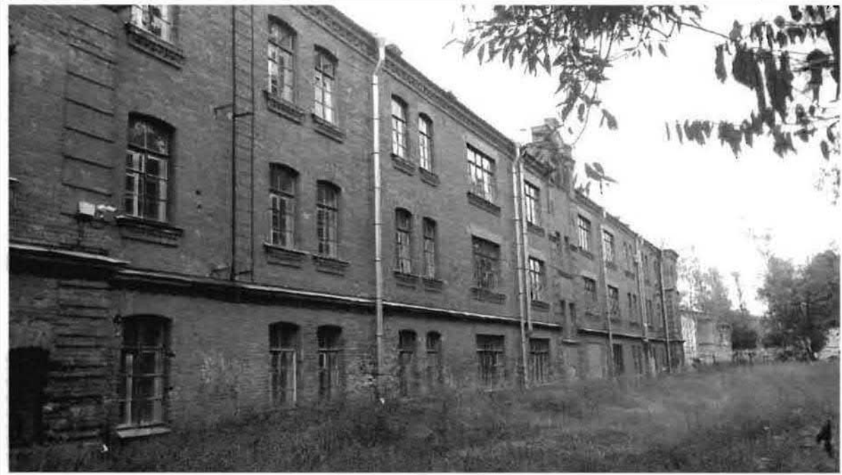
Фото 48. Западный фасад. Общий вид.
