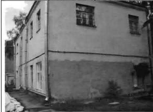
Фото 45. Южный, западный фасад. Общий вид.
