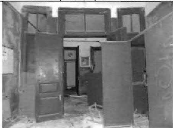
Фото 101. Дверной проем тамбура. Общий вид.
