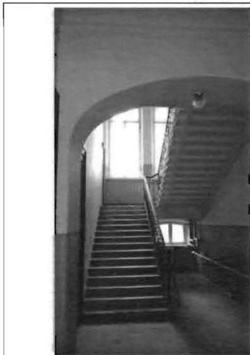
Фото 174. Парадная лестница в центральной части здания. Общий вид.
