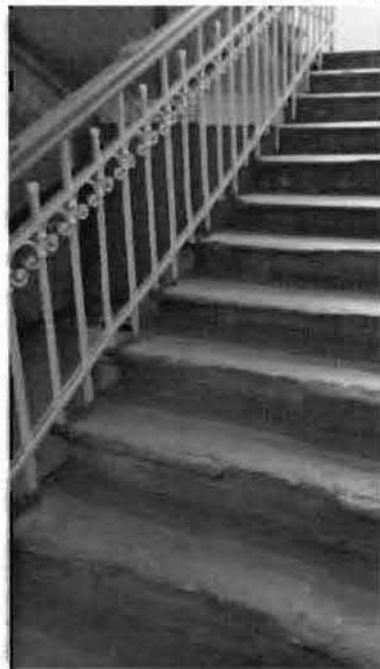
Фото 57. Лестница в центральной части здания. Фрагмент.
