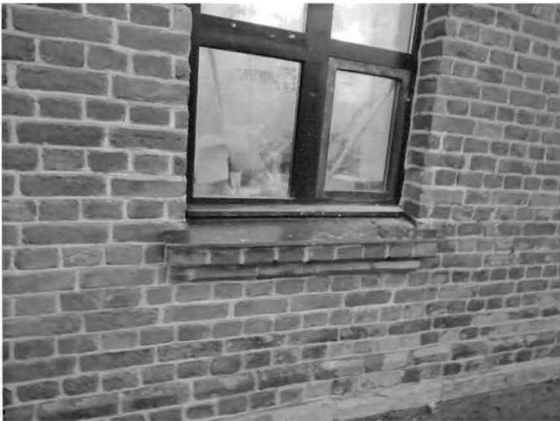
Ступенчатые подоконные доски. Съемка 20.11.2012, Воронина Н.В.
