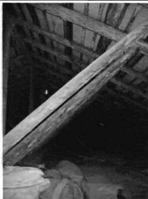
Фото 27. Конструкции крыши. Фрагмент.
