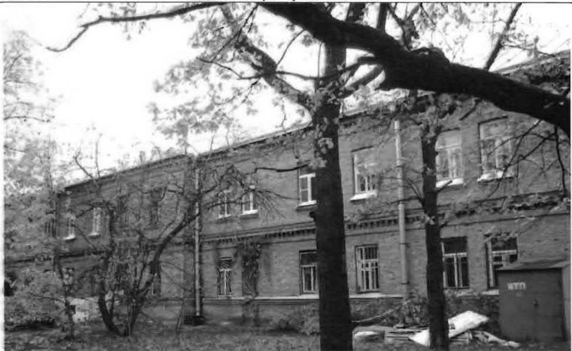
Фото 84. Южный фасад. Общий вид.
