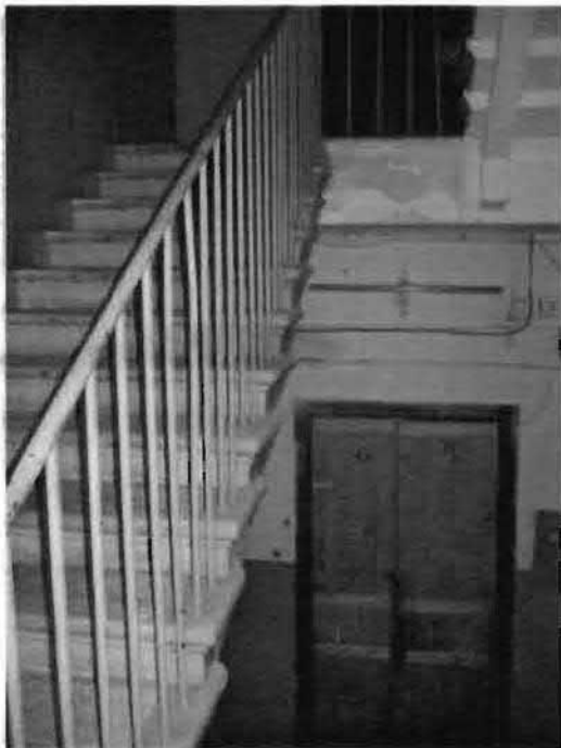
Фото 143. Лестница № 1 в северной части здания. Общий вид.
