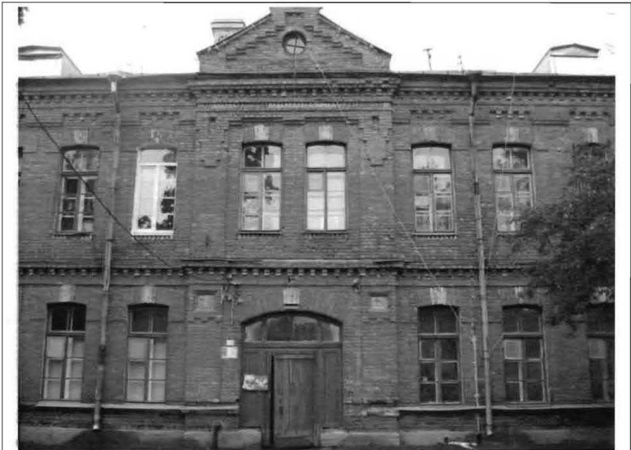
Фото 104. Восточный фасад. Центральная часть. Общий вид.
