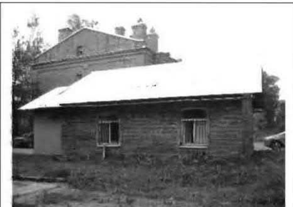
Фото 156. Западный фасад. Общий вид.
