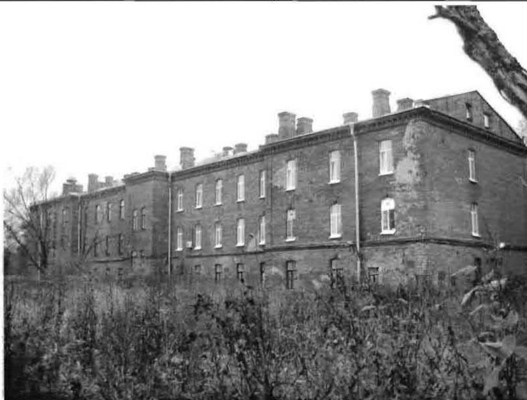
Фото 14. Восточный фасад. Общий вид.
