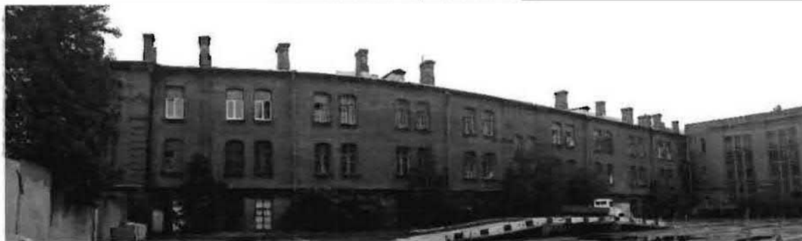
Фото 29. Западный фасад. Общий вид.
