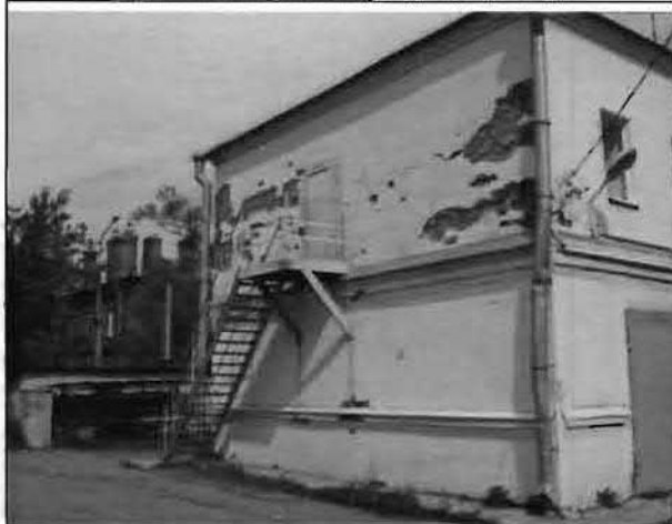
Фото 112. Южный фасад. Общий вид.
