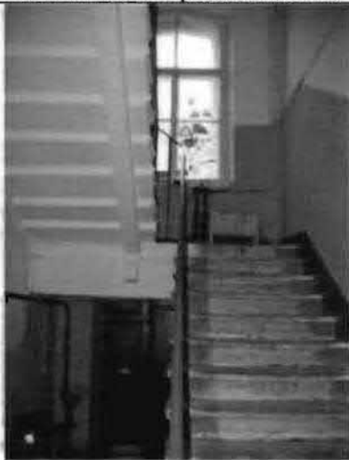
Фото 168. Лестница в южной части здания. Общий вид.
