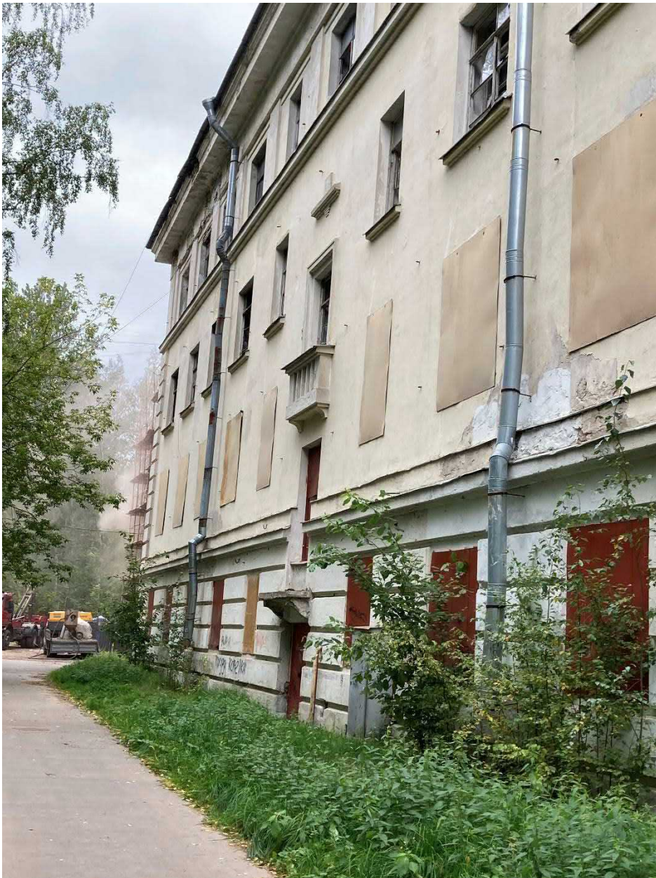
Фото 17. Здание со стороны южного фасада.
