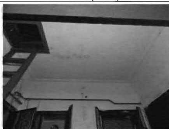
Фото 102. Отделка потолка тамбура. Общий вид.
