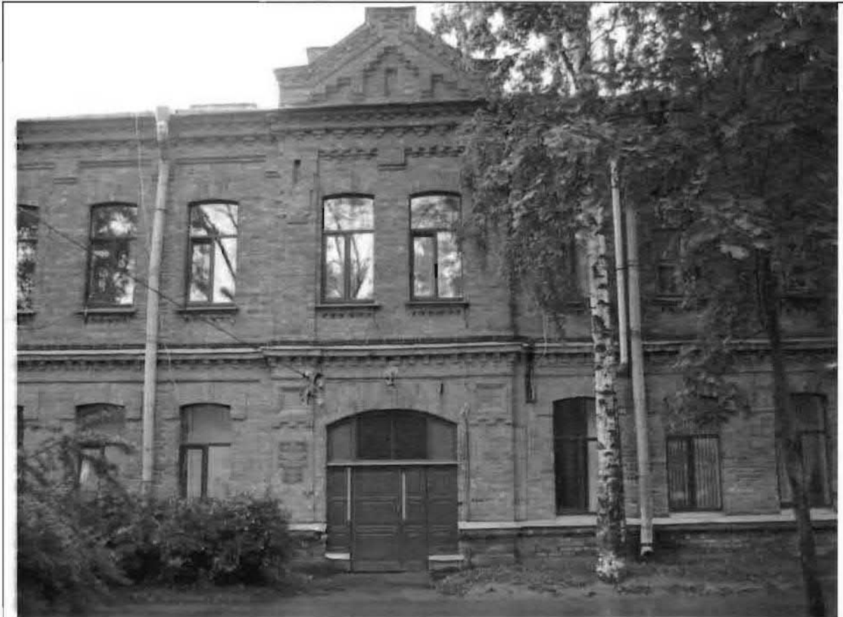
Фото 164. Восточный фасад. Фрагмент центральной части фасада.
