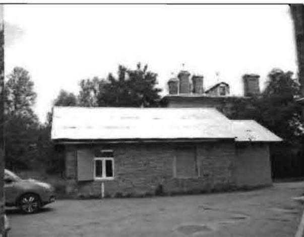
Фото 154. Южный фасад. Общий вид.
