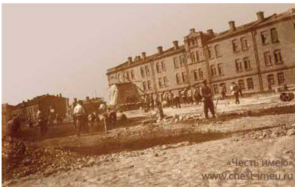
Фото 11. Строительство памятника Каспийцам. www.chet-imeu.ru
