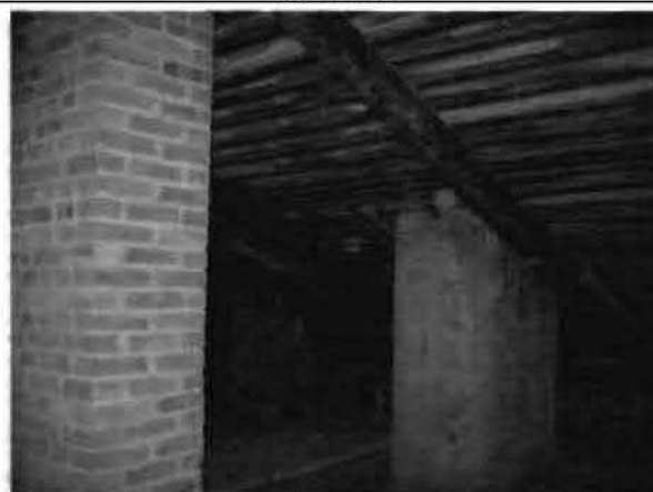
Фото 152. Конструкции крыши. Фрагмент.
