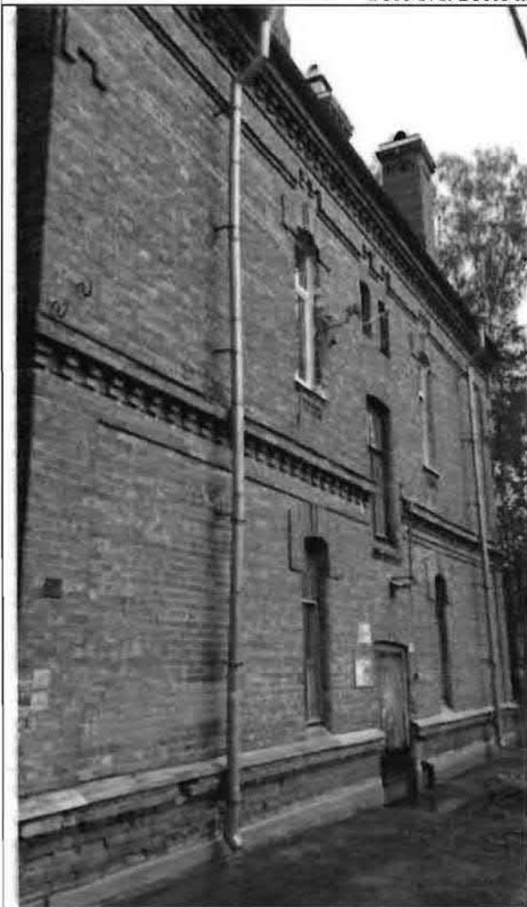
Фото 172. Южный фасад. Общий вид.
