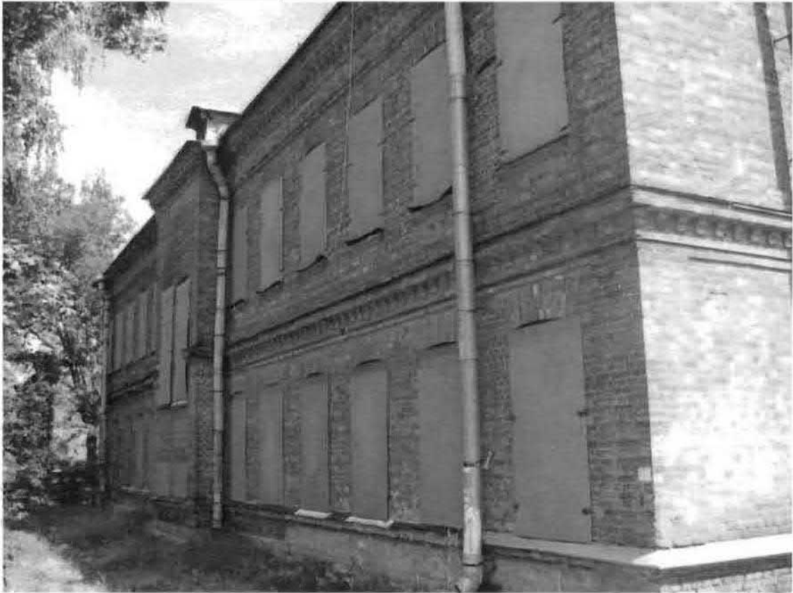
Фото 119. Западный фасад. Общий вид.
