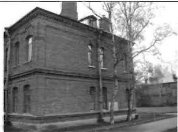
Фото 160. Северный фасад. Общий вид.
