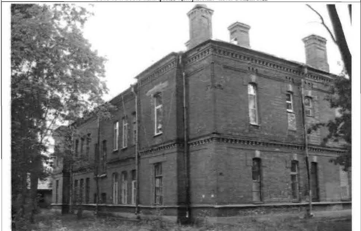
Фото 105. Западный, южный фасады. Общий вид.
