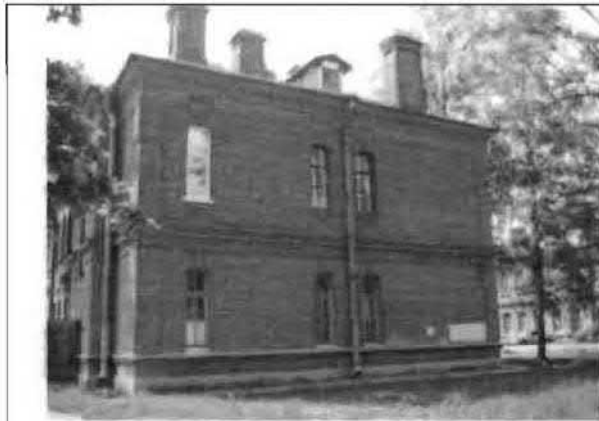
Фото 159. Северный фасад. Общий вид.
