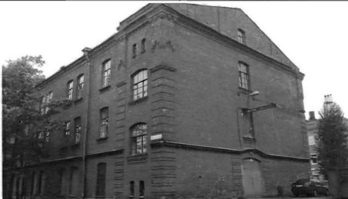
Фото 30. Северный фасад. Общий вид.
