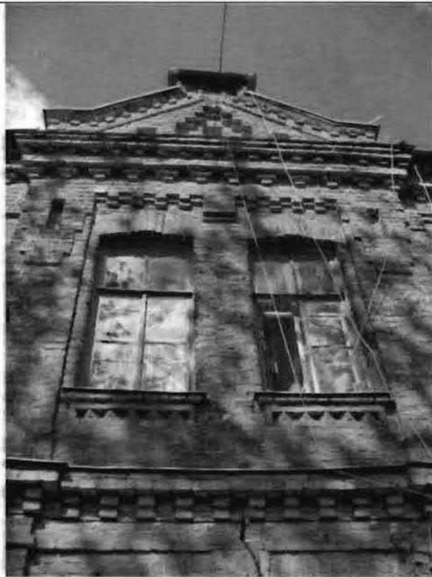
Фото 177. Восточный фасад. Центральная часть. Фрагмент.
