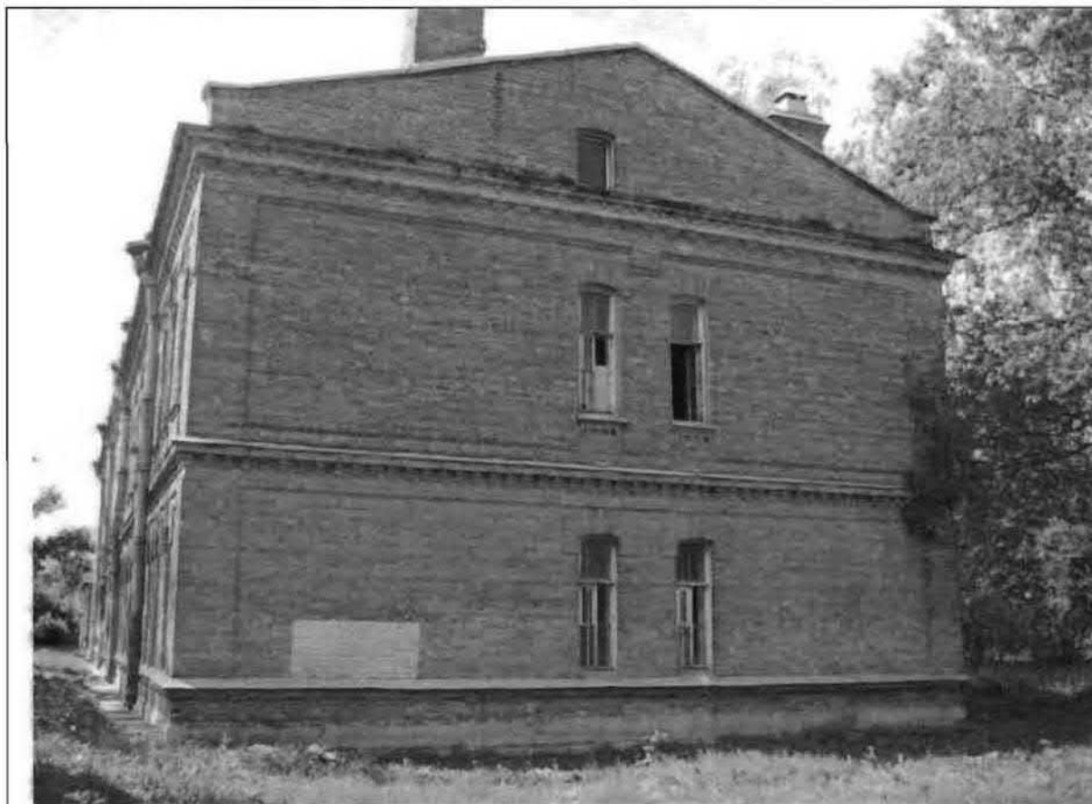
Фото 180. Северный фасад. Общий вид.
