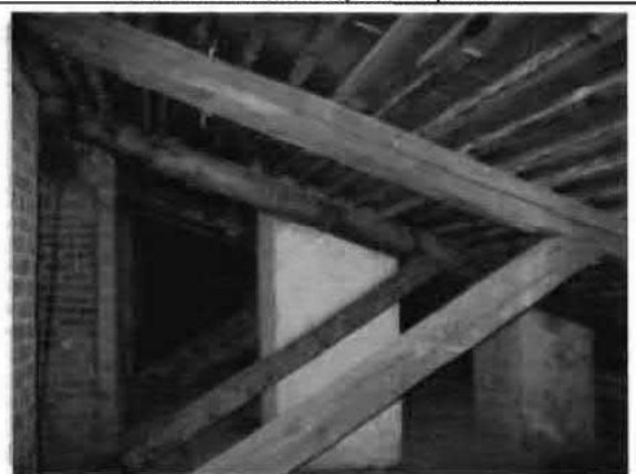
Фото 141. Конструкции крыши. Фрагмент.
