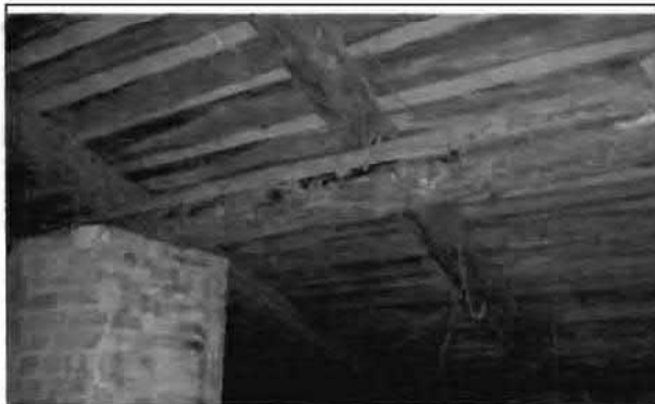
Фото 62. Конструкции крыши. Общий вид.
