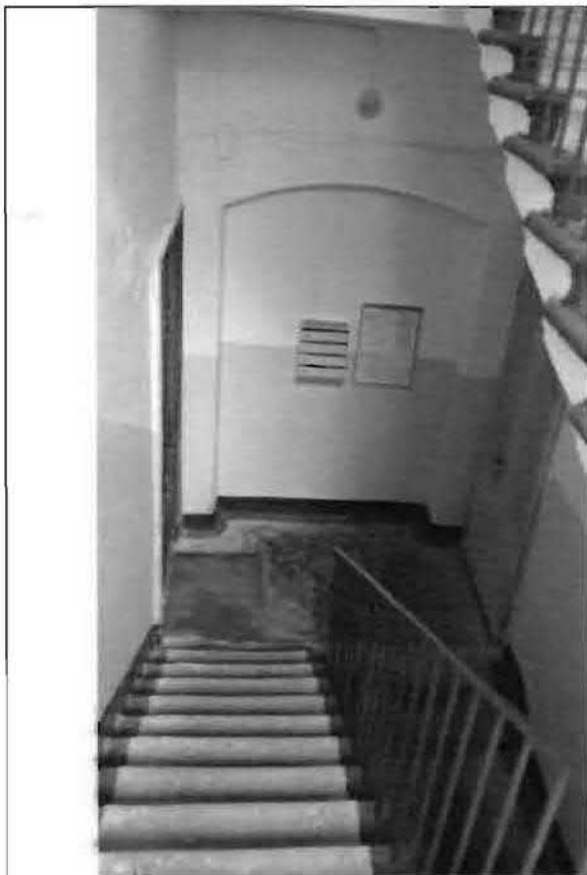
Фото 130. Лестница № 1 в южной части здания. Общий вид.
