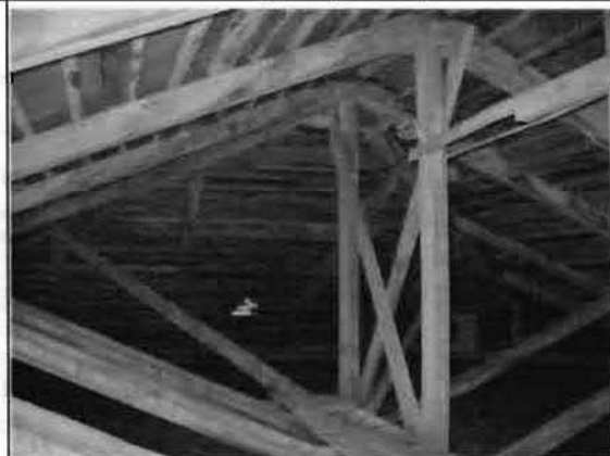
Фото 82. Конструкции крыши. Общий вид.
