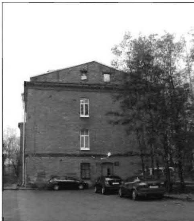
Фото 15. Северный фасад. Общий вид.
