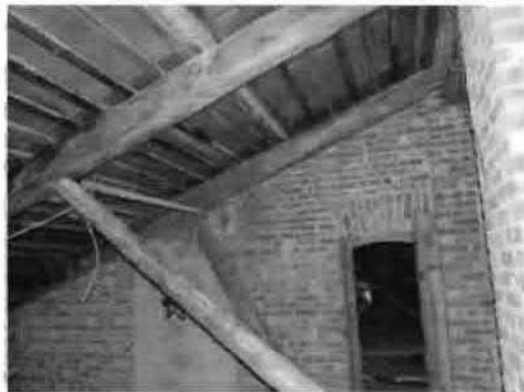
Фото 127. Конструкции крыши. Общий вид.
