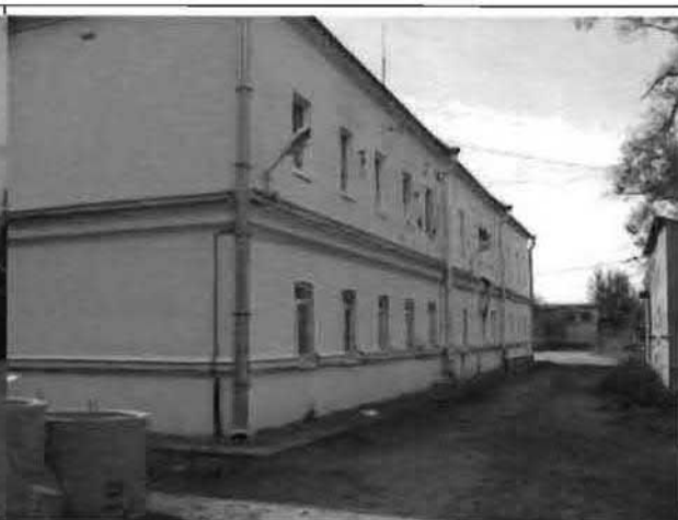
Фото 111. Западный фасад. Общий вид.
