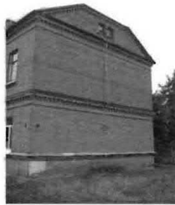
Фото 86. Западный фасад. Общий вид.
