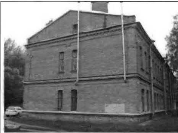
Фото 166. Южный фасад. Общий вид.
