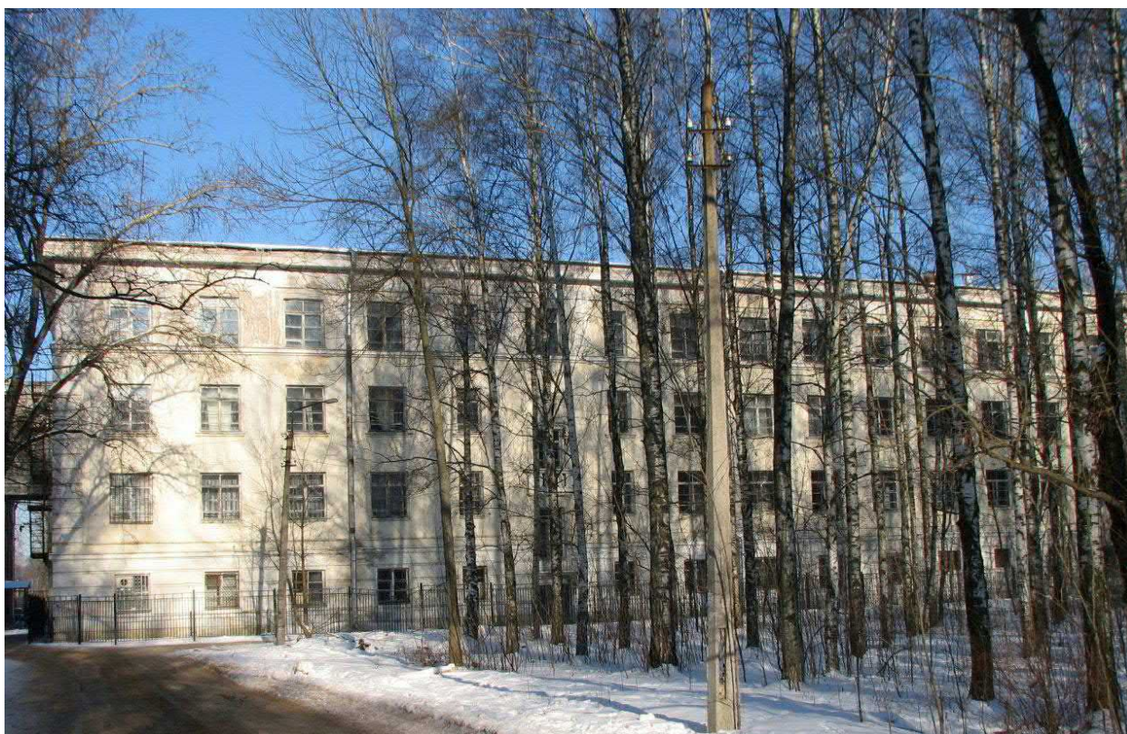
Фото 21. 2012г. Южный фасад. www.citywalls.ru
