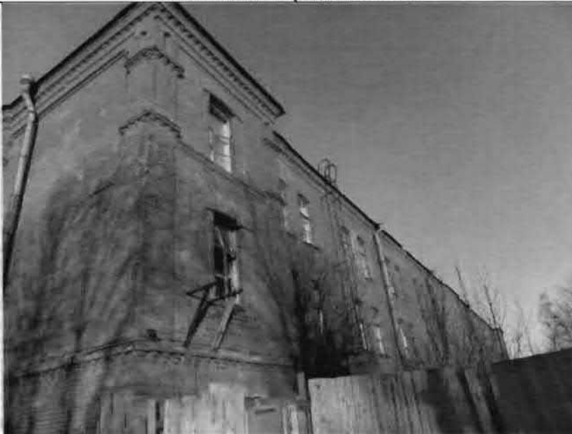
Фото 2. Восточный фасад. Общий вид. 29.12.2015.
