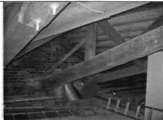
Фото 77. Конструкции крыши. Общий вид.
