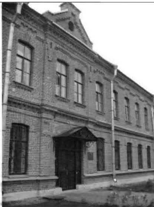
Фото 135. Западный фасад. Фрагмент центральной части фасада.
