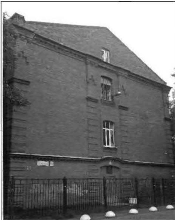
Фото 49. Северный фасад. Общий вид.
