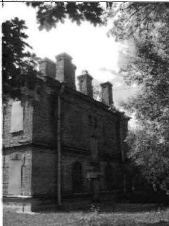
Фото 118. Северный фасад. Общий вид.
