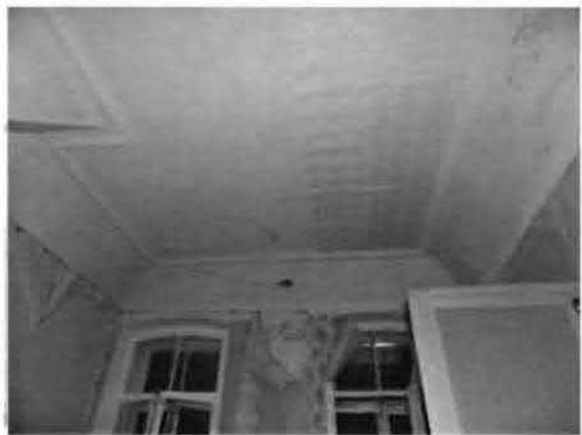
Фото 121. Помещение 1-го этажа.
