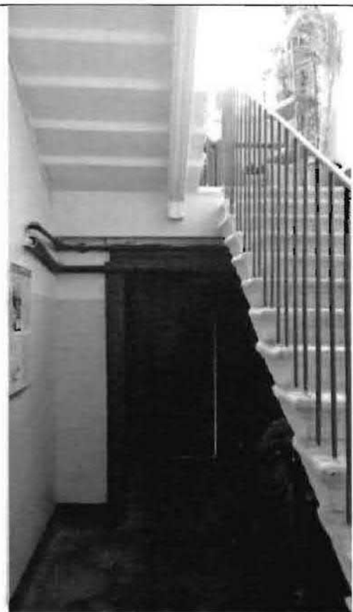
Фото 131. Лестница № 2 в северной части здания. Общий вид.
