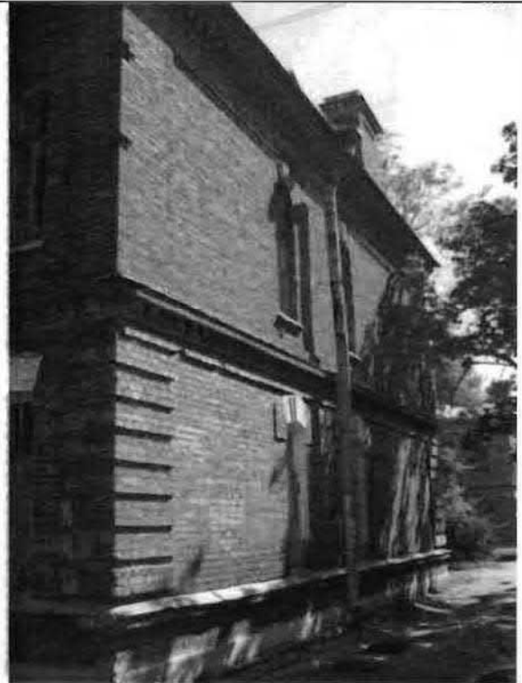
Фото 138. Южный фасад. Общий вид.
