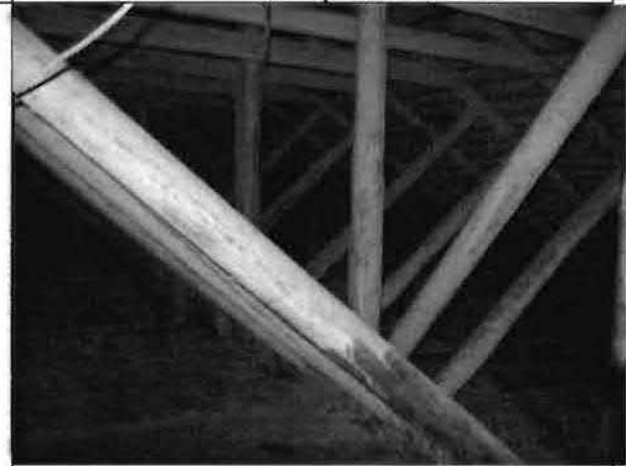
Фото 88. Конструкции крыши. Общий вид.
