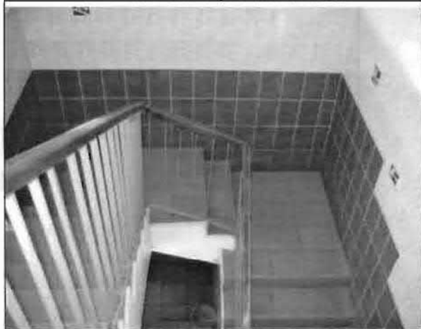
Фото 114. Лестница. Общий вид.
