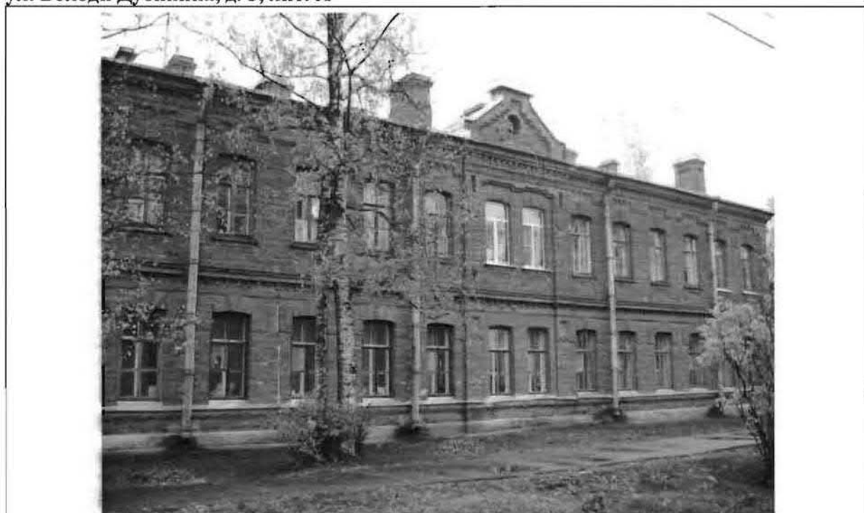
Фото 157. Западный фасад. Общий вид.
