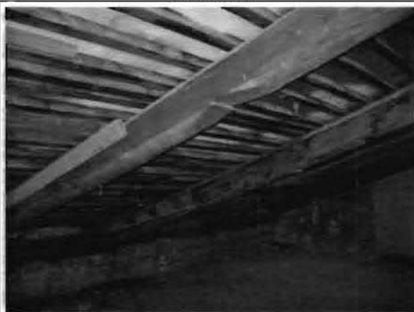
Фото 151. Конструкции крыши. Фрагмент.
