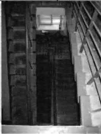
Фото 87. Лестница № 1. Общий вид.
