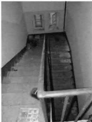
Фото 124. Лестница в южной части здания. Общий вид.
