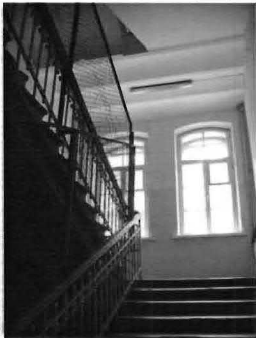
Фото 56. Лестница в центральной части здания. Фрагмент.
