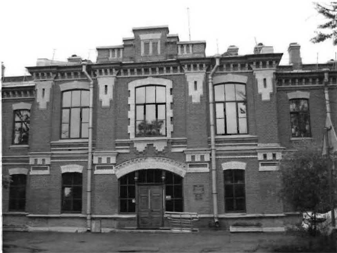
Фото 65. Северный фасад. Фрагмент центральной части фасада.
