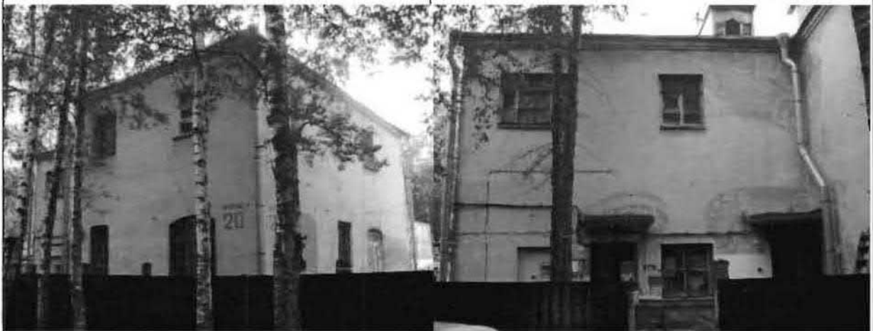
Фото 43. Северный, восточный фасады. Общий вид.
