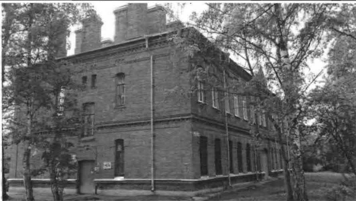
Фото 170. Северный, западный фасады. Общий вид.
