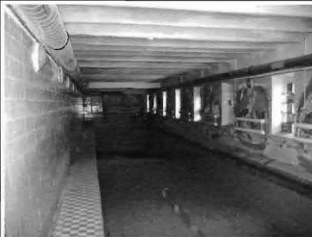
Фото 26. Интерьер. Помещение в уровне 1-го этажа. Система прусских сводов по металлическим балкам. Общий вид.
