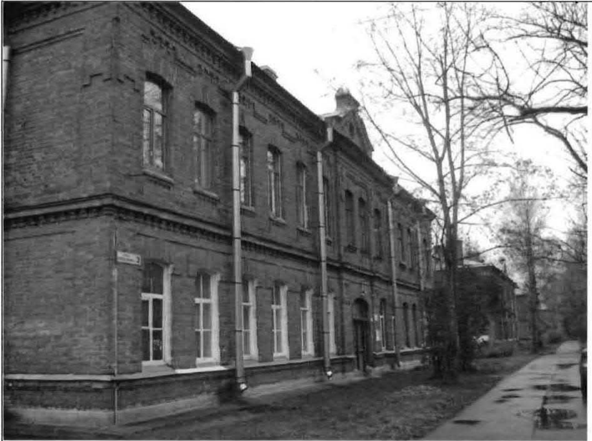
Фото 146. Западный фасад. Общий вид.
