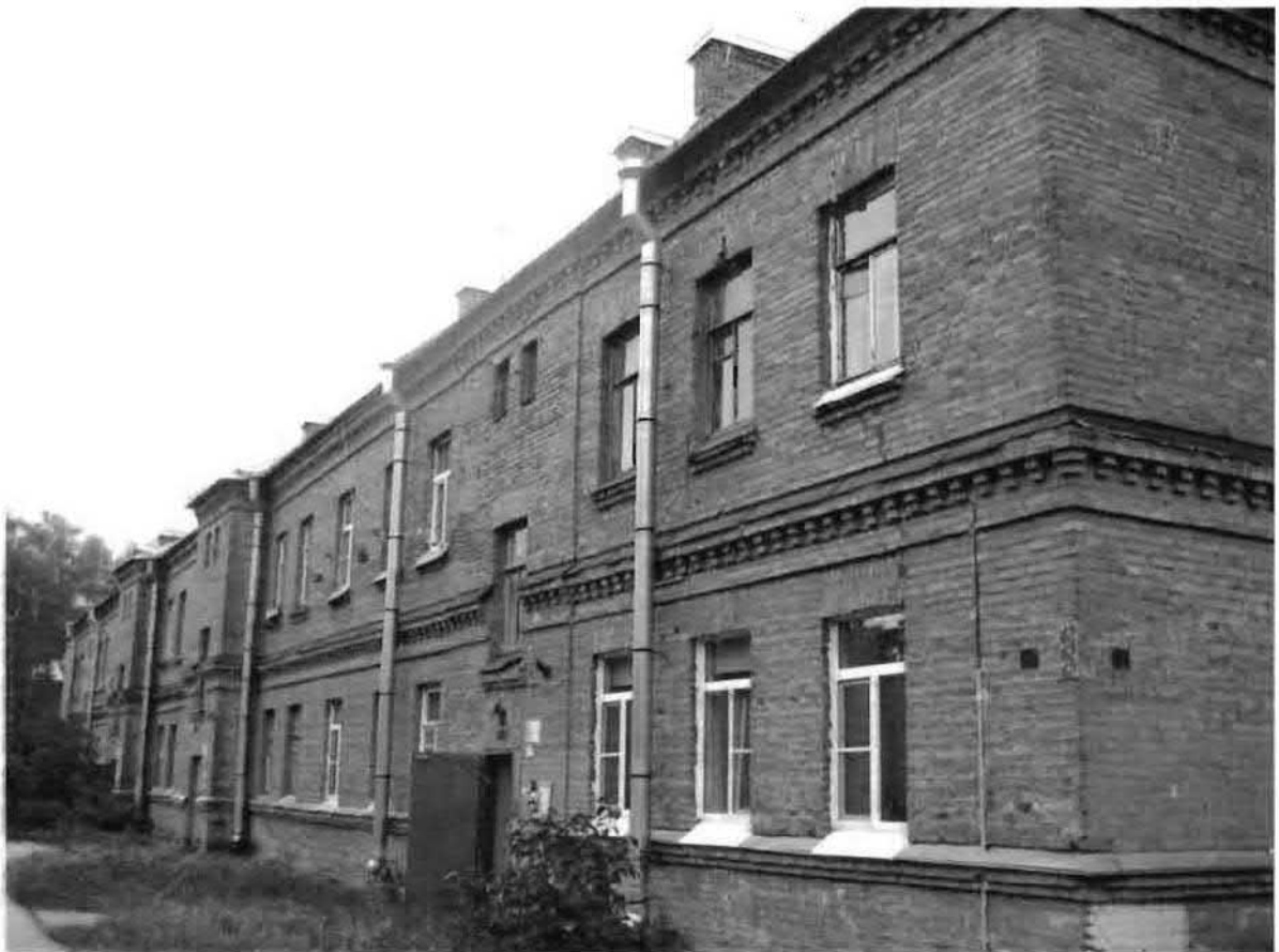
Фото 83. Северный фасад. Общий вид.
