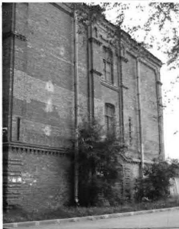
Фото 5. Южный фасад. Общий вид.
