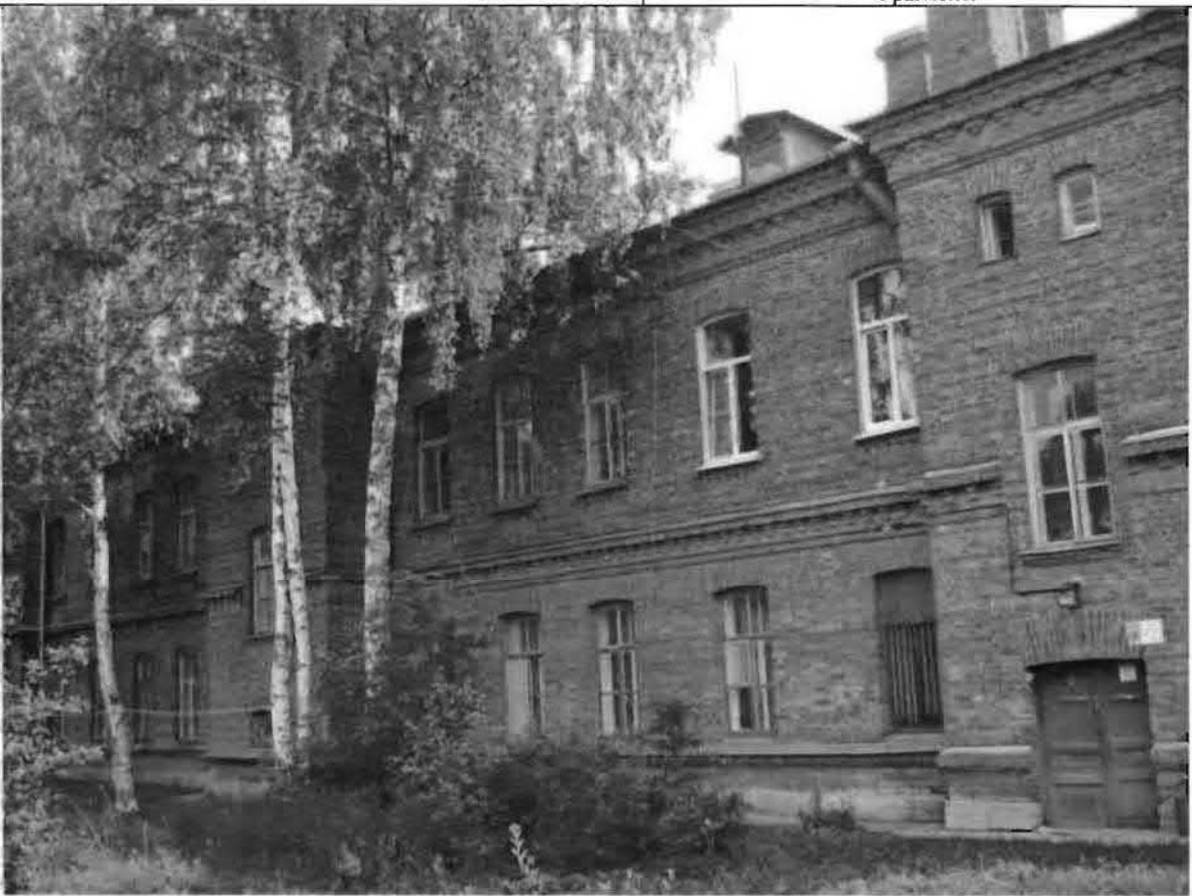
Фото 179. Западный фасад. Общий вид.
