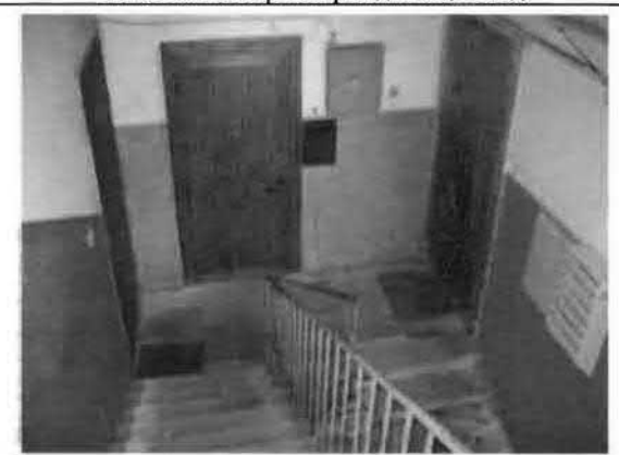
Фото 162. Лестница № 2 в северной части здания. Фрагмент.
