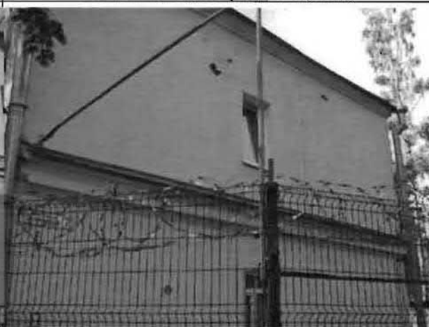
Фото 113. Северный фасад. Общий вид.
