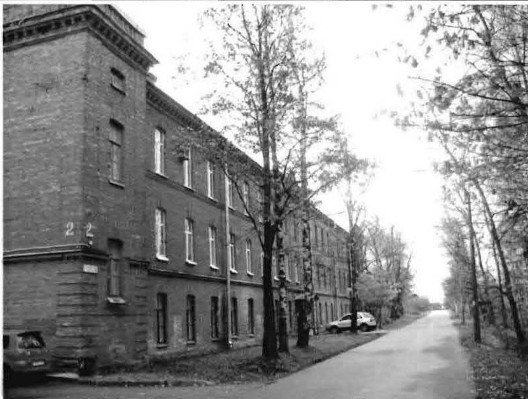
Фото 13. Западный фасад. Общий вид.
