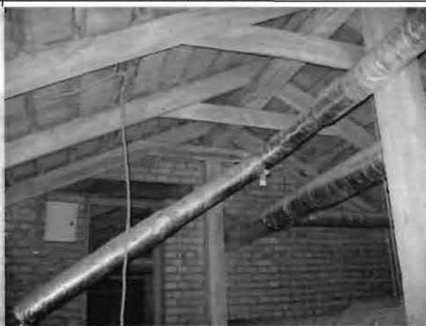
Фото 115. Конструкции крыши. Фрагмент.
