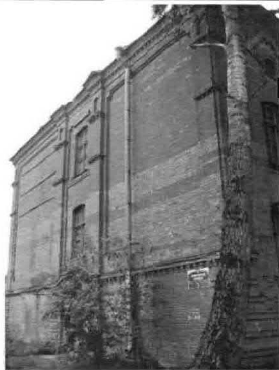
Фото 6. Северный фасад. Общий вид.
