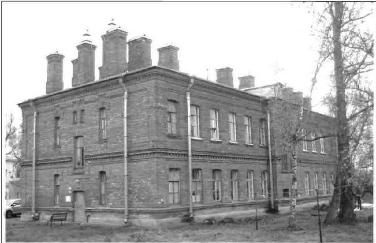
Фото 129. Западный, северный фасады. Общий вид.
