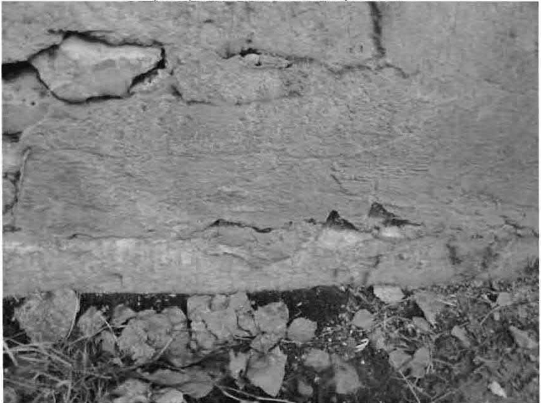
Цоколь, облицованный известняковой скобой. Съемка 27.11.2012, Воронина Н.В.
