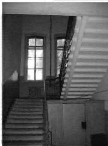
Фото 150. Парадная лестница в центральной части здания. Общий вид.
