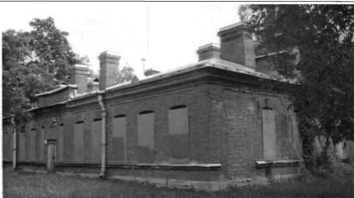
Фото 98. Западный фасад. Общий вид.
