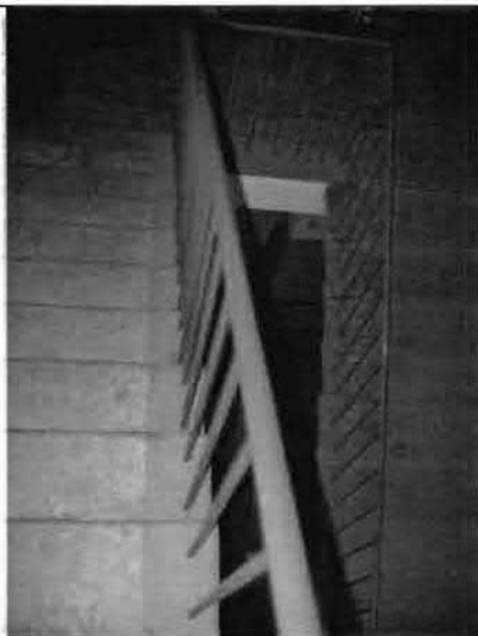
Фото 149. Лестница № 1 в северной части здания. Общий вид.
