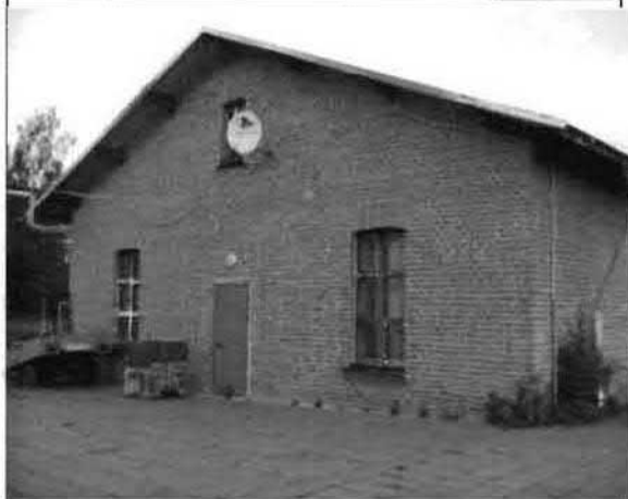
Фото 21. Южный фасад. Общий вид.
