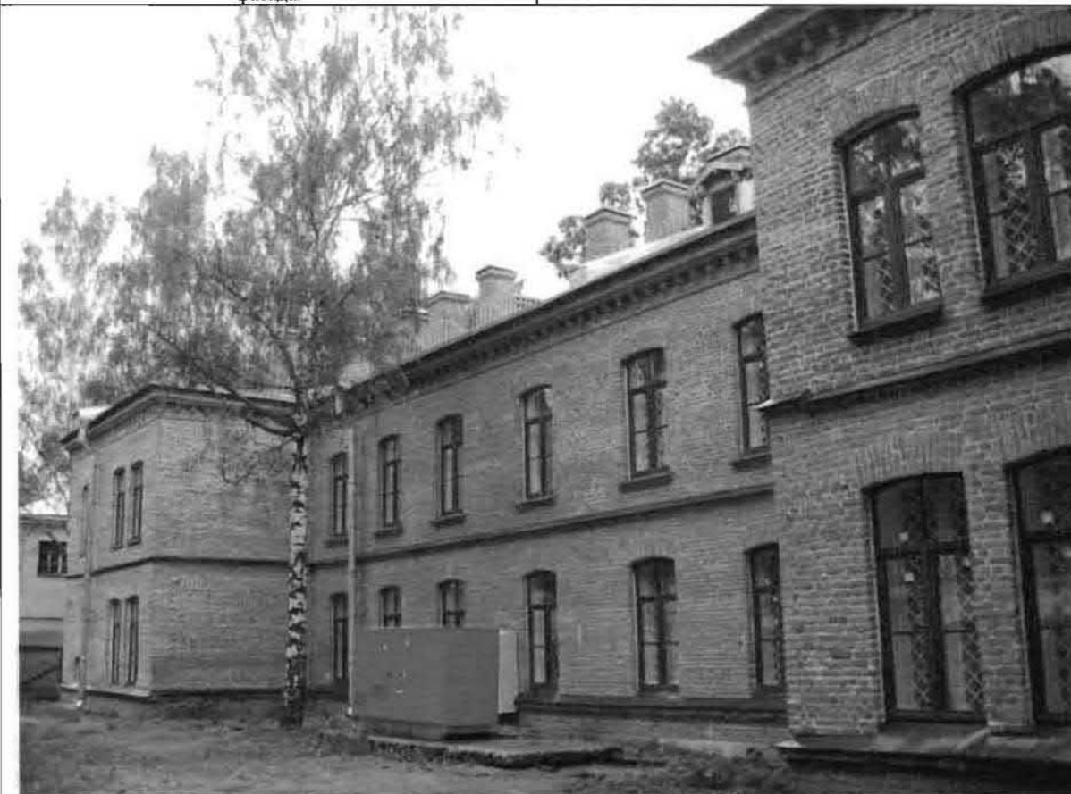
Фото 42. Западный фасад. Общий вид.
