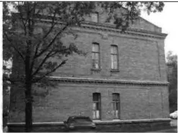
Фото 167. Северный фасад. Общий вид.
