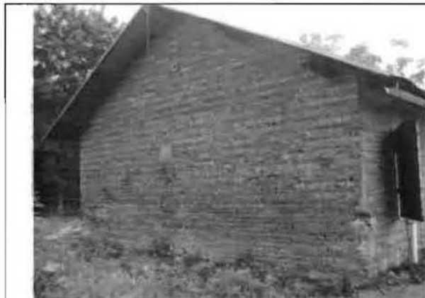
Фото 155. Северный фасад. Общий вид.
