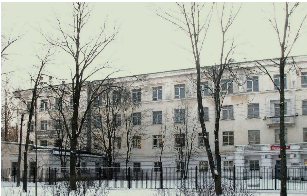
Фото 20. 2012г. Северный фасад. www.citywalls.ru
