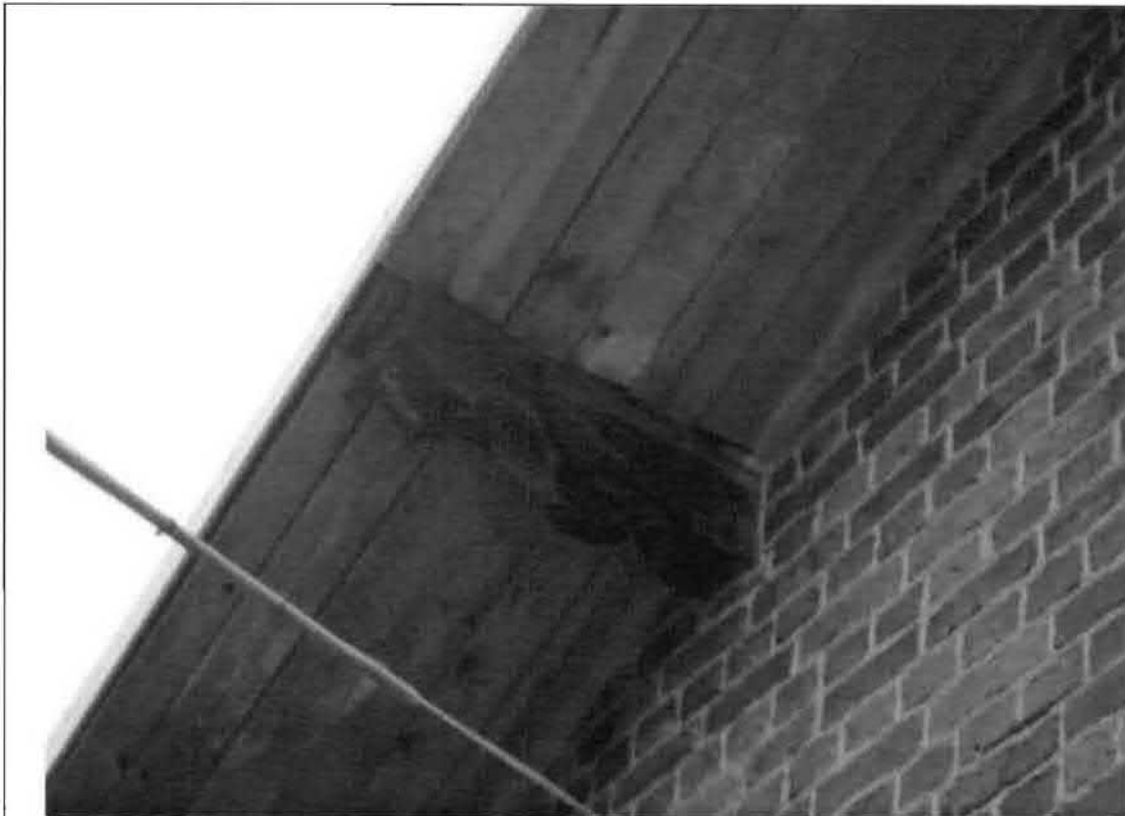
Деревянные кобылки. Съёмка 20.11.2012, Воронина Н.В.
