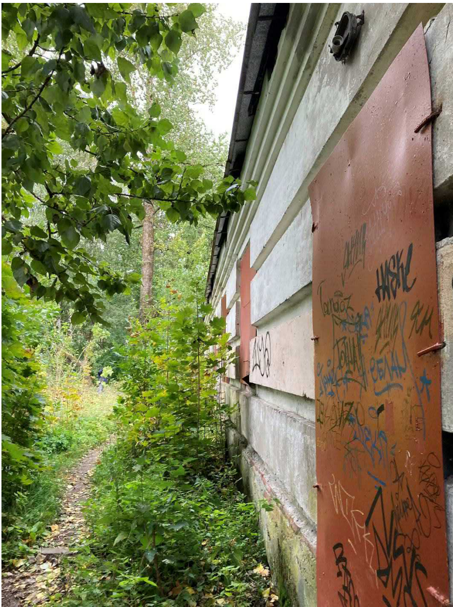
Фото 9. Территория, тропинка вдоль пристройки-столовой со стороны юго-восточного фасада
