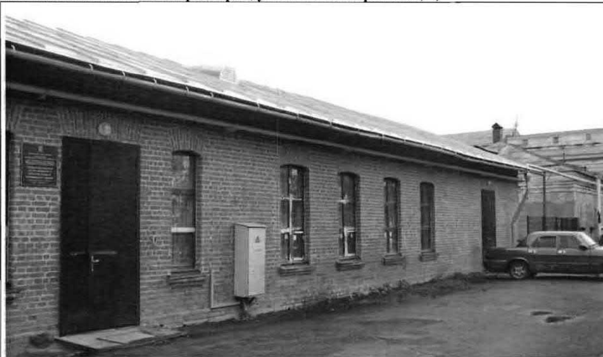
Фото 18. Западный фасад. Общий вид.
