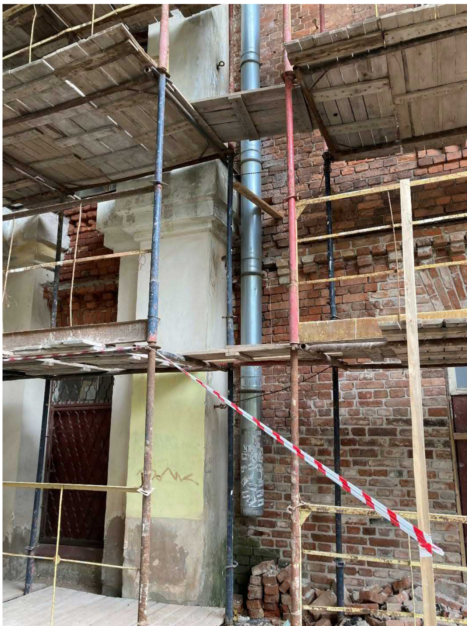
Фото 21. Здание со стороны северо-западного фасада. Примыкание галереи к ОКН регионального значения «Казармы 148-го пехотного Каспийского полка (с территорией) по адресу ул. Юты Бандеровской, д.21
