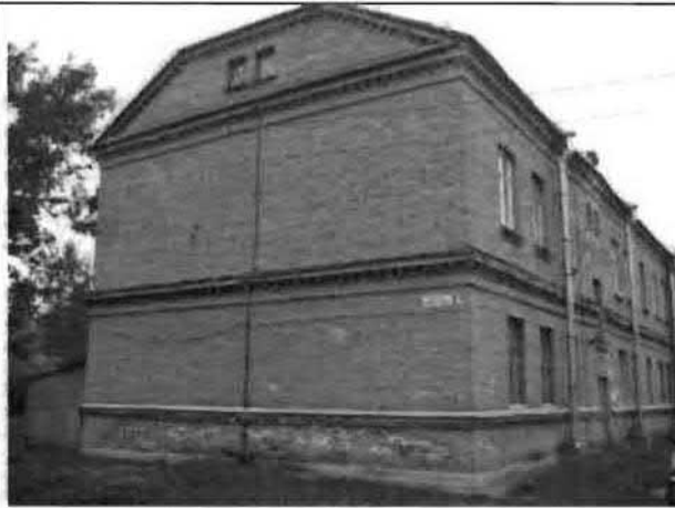
Фото 85. Восточный фасад. Общий вид.
