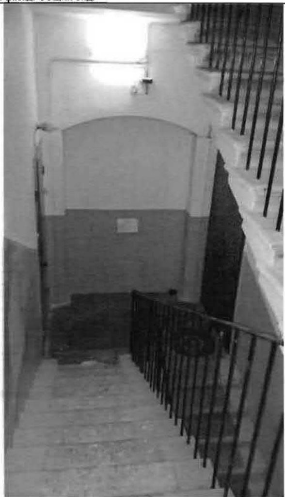
Фото 173. Лестница № 1 в северной части здания. Фрагмент.
