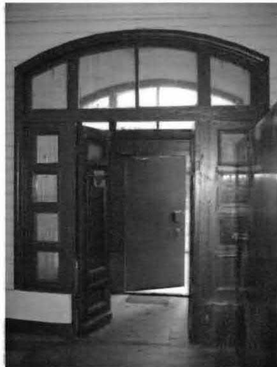
Фото 107. Дверной проем тамбура. Общий вид.
