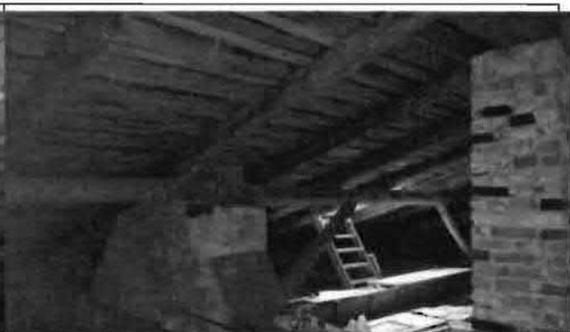
Фото 63. Конструкции крыши. Общий вид.
