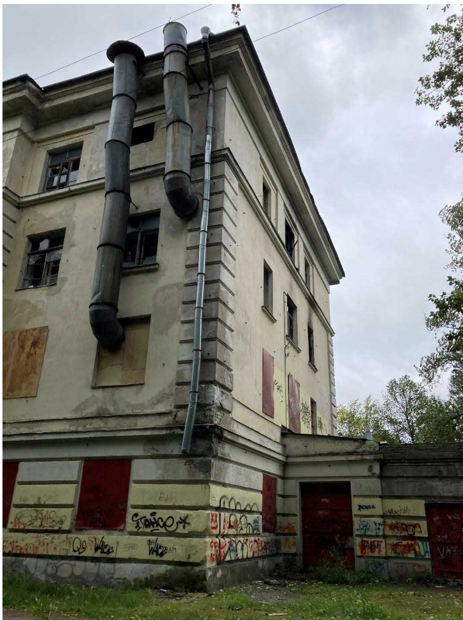
Фото 12. Здание, пристройка-столовая со стороны юго-юго-восточного фасада
