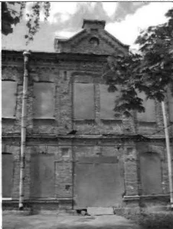
Фото 117. Восточный фасад. Фрагмент центральной части фасада.
