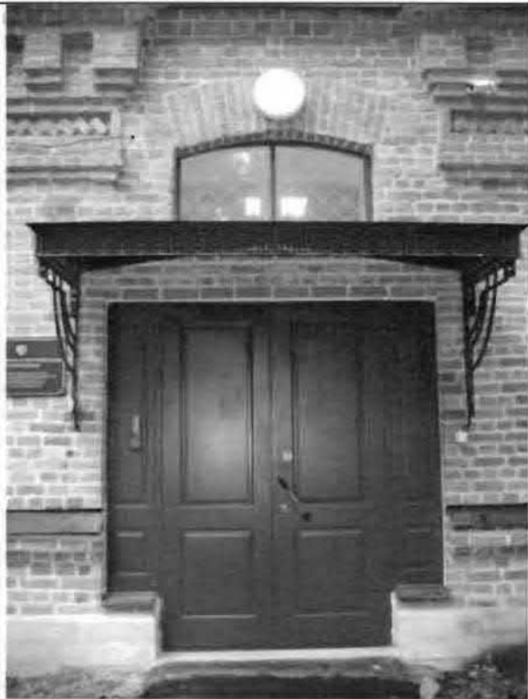
Фото 41. Дверной проем восточного фасада. Общий вид.
