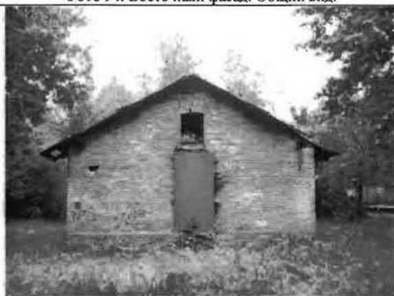
Фото 96. Западный фасад. Общий вид.
