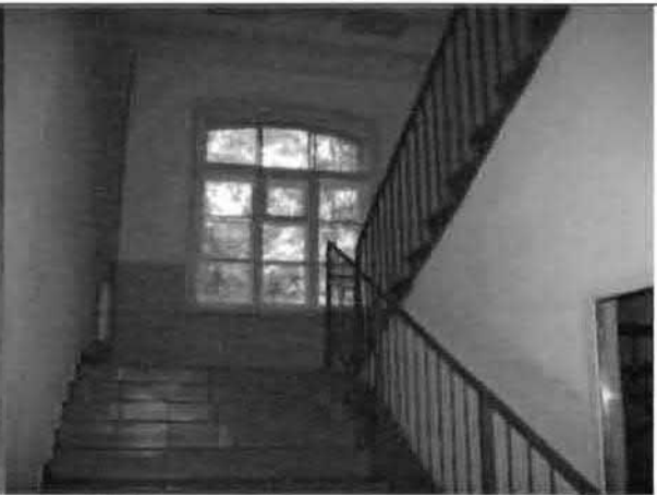
Фото 59. Интерьер. Лестница в северной части здания. Фрагмент.
