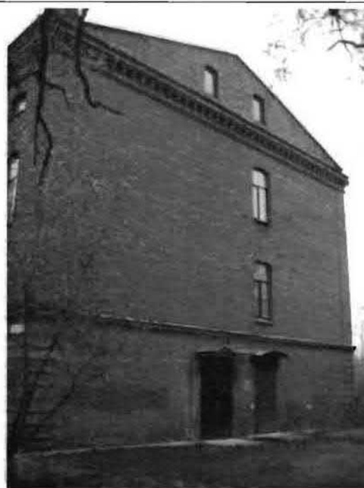
Фото 16. Южный фасад. Общий вид.
