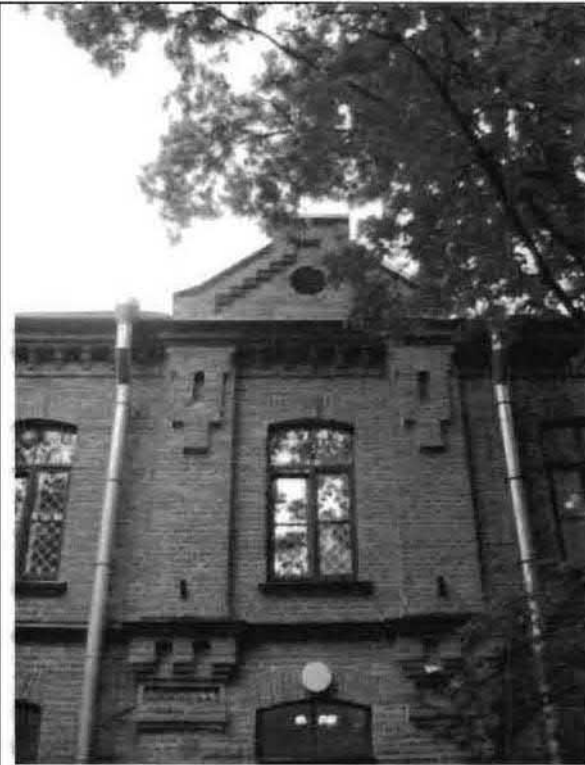
Фото 40. Восточный фасад. Фрагмент центральной части фасада.
