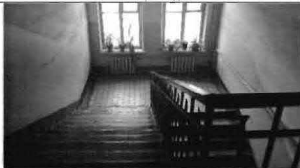
Фото 34. Интерьер. Лестница. Общий вид.
