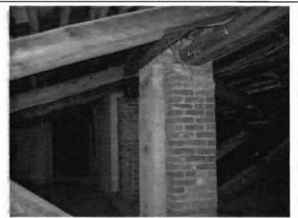
Фото 142. Конструкции крыши. Фрагмент.
