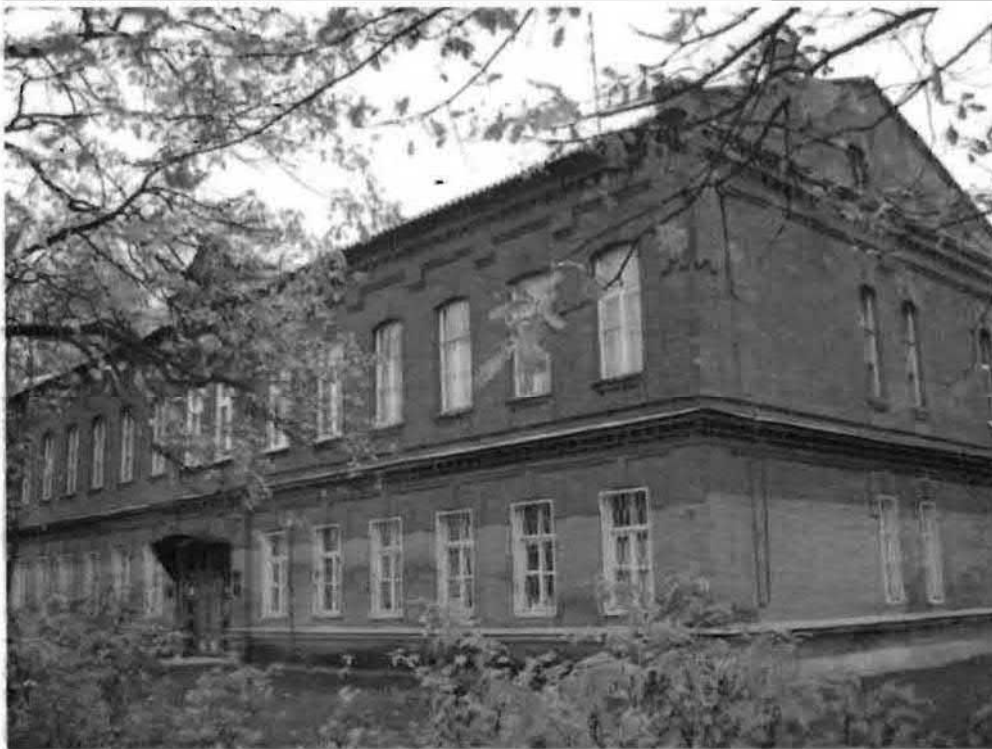
Фото 89. Западный, южный фасады. Общий вид.
