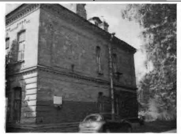
Фото 140. Северный фасад. Общий вид.
