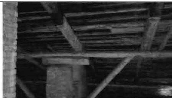
Фото 38. Конструкции крыши. Фрагмент.
