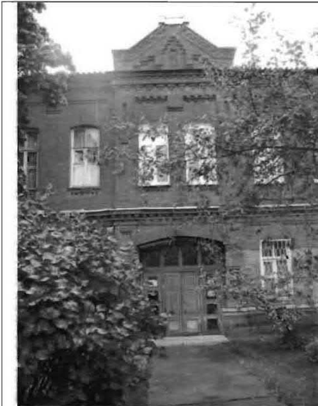
Фото 90. Восточный фасад. Центральная часть. Общий вид.
