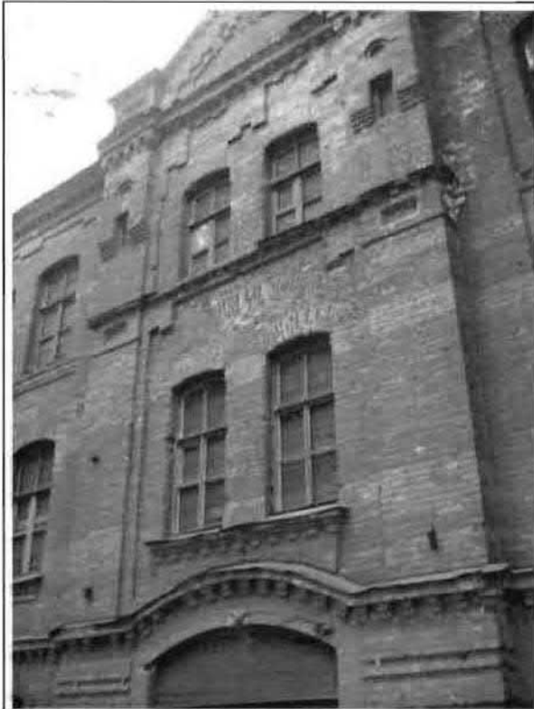
Фото 3. Западный фасад. Фрагмент центральной части фасада.
