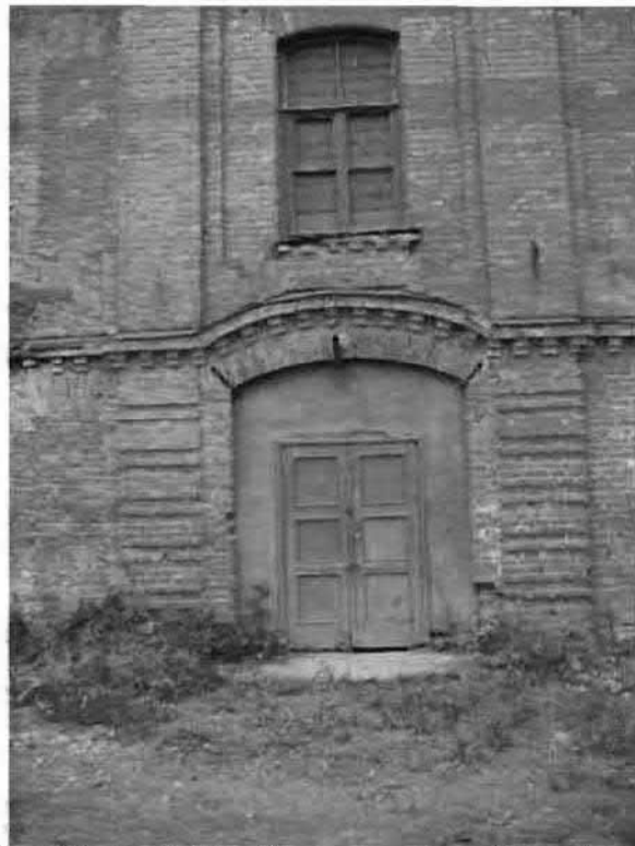
Фото 4. Западный фасад. Фрагмент центральной части фасада.
