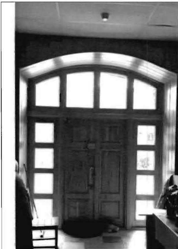
Фото 92. Помещение в уровне 1-го этажа.
