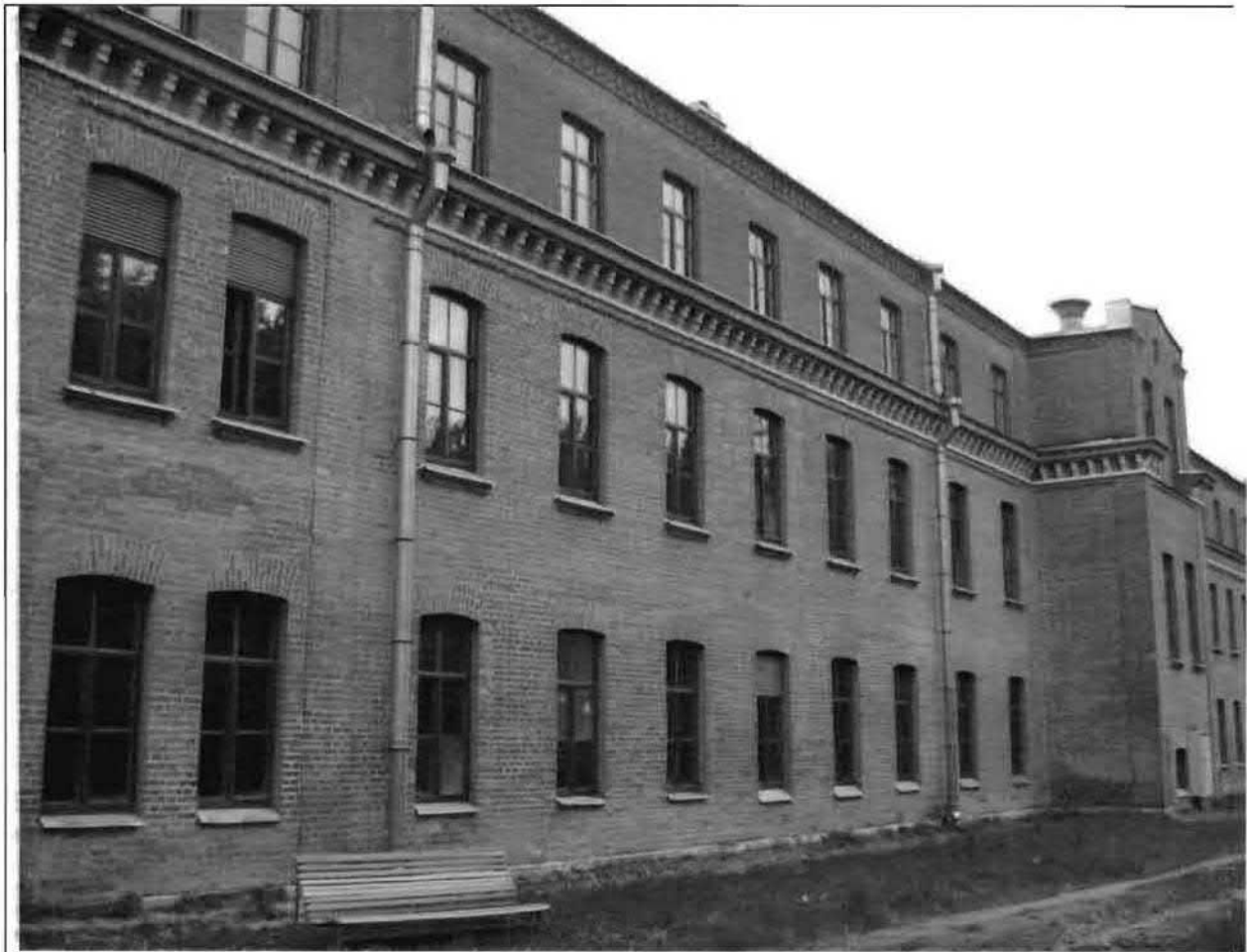
Фото 66. Южный фасад. Общий вид. 05.07.2016.
