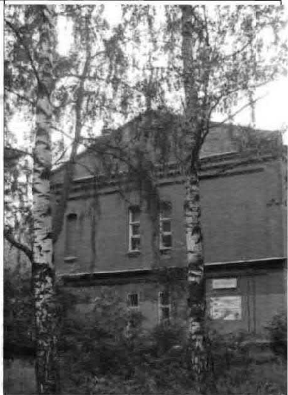
Фото 91. Северный фасад. Общий вид.
