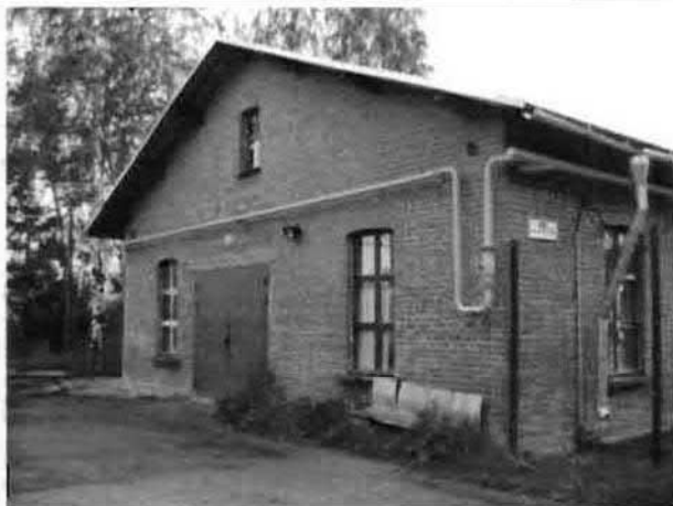
Фото 20. Северный фасад. Общий вид.
