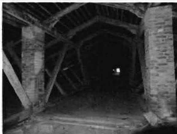
Фото 12. Конструкции крыши. Общий вид. 29.12.2015.
