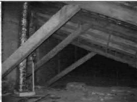
Фото 76. Конструкции крыши. Общий вид.
