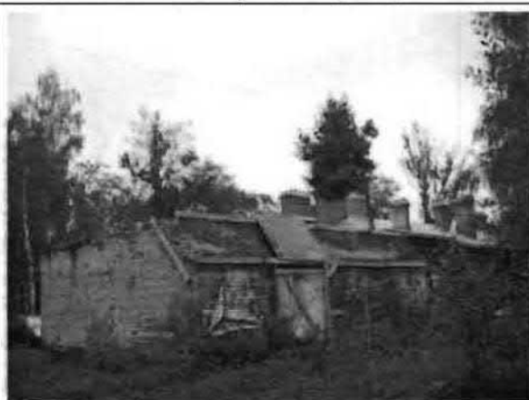
Фото 186. Западный, северный фасады. Общий вид.
