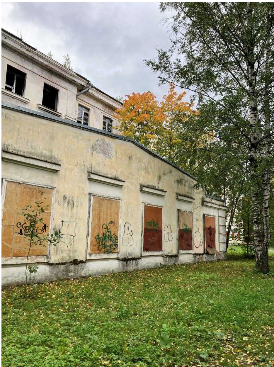
Фото 7. Пристройка-столовая со стороны юго-восточного фасада.
