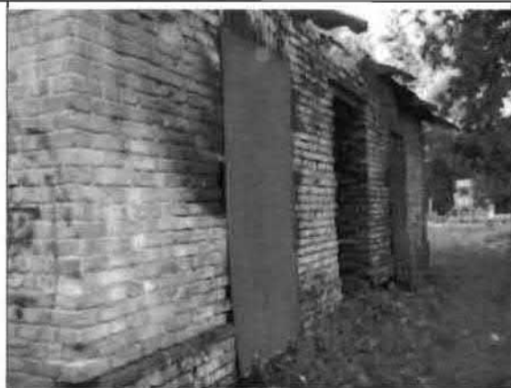
Фото 95. Северный фасад. Общий вид.
