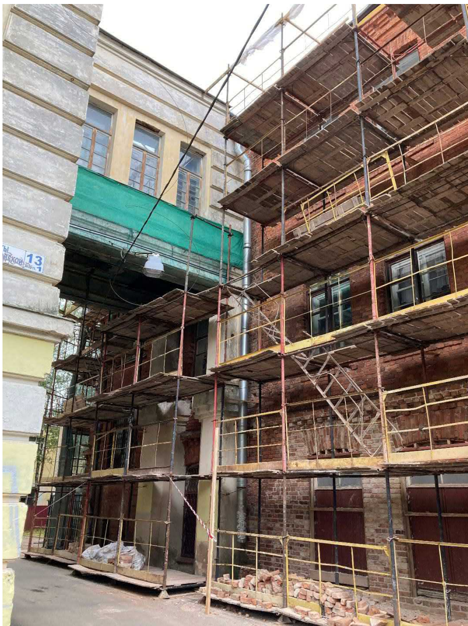
Фото 20. Здание со стороны северо-западного фасада. Примыкание галереи к ОКН регионального значения «Казармы 148-го пехотного Каспийского полка (с территорией) по адресу ул. Юты Бандеровской, д.21
