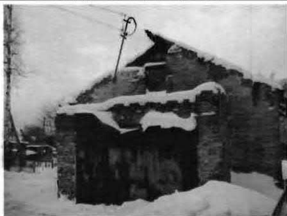
Фото 184. Восточный фасад. Общий вид. 14.01.2015.
