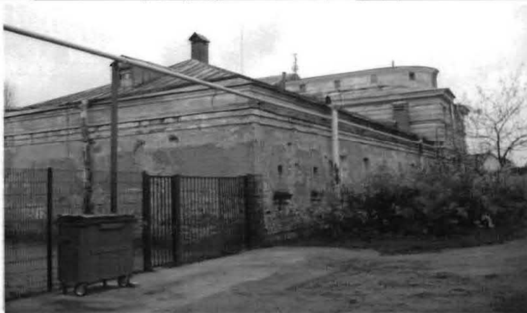
Фото 24. Западный, северный фасады. Общий вид.
