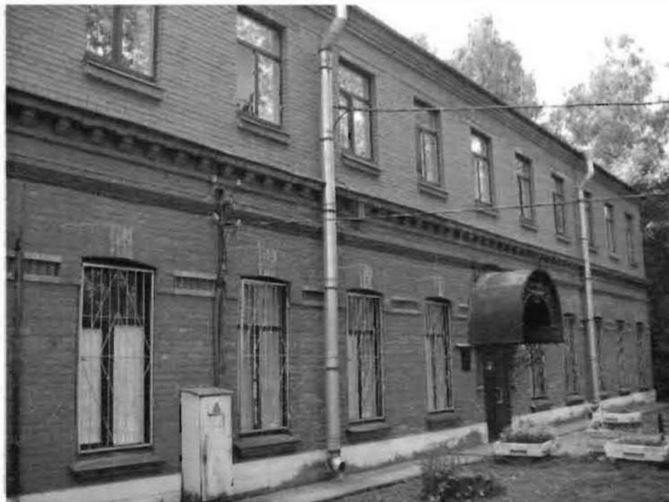
Фото 78. Западный фасад. Общий вид.
