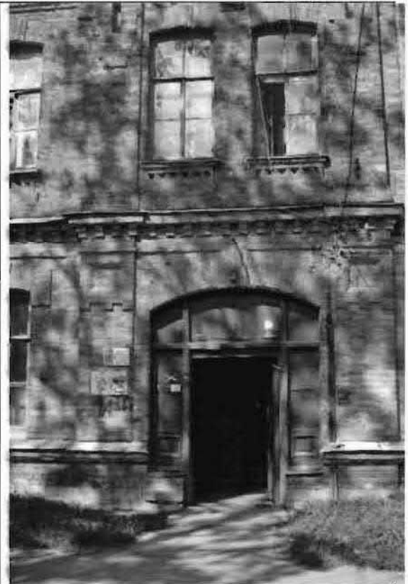
Фото 178. Восточный фасад. Центральная часть. Фрагмент.
