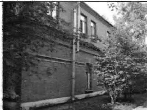
Фото 80. Северный фасад. Фрагмент.
