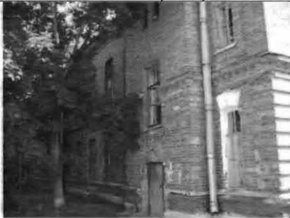
Фото 139. Западный фасад. Фрагмент.
