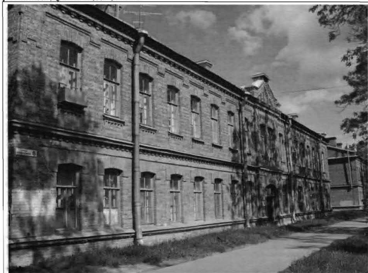
Фото 176. Восточный фасад. Общий вид.
