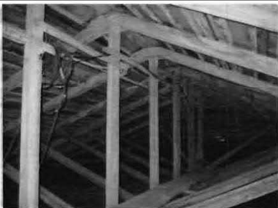
Фото 81. Конструкции крыши. Общий вид.
