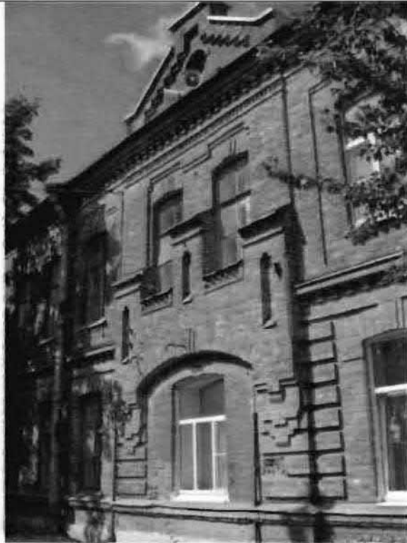
Фото 137. Восточный фасад. Фрагмент.
