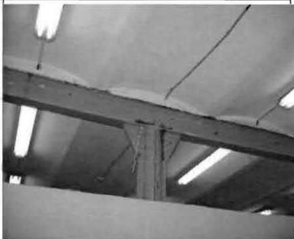
Фото 23. Интерьер. Металлические клепаные колонны и балки. Фрагмент.
