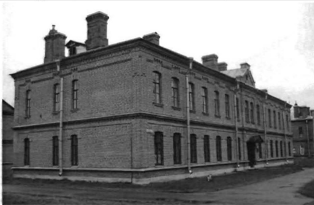
Фото 132. Западный, северный фасады. Общий вид.
