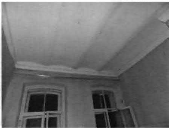
Фото 120. Помещение 1-го этажа. Общий вид.
