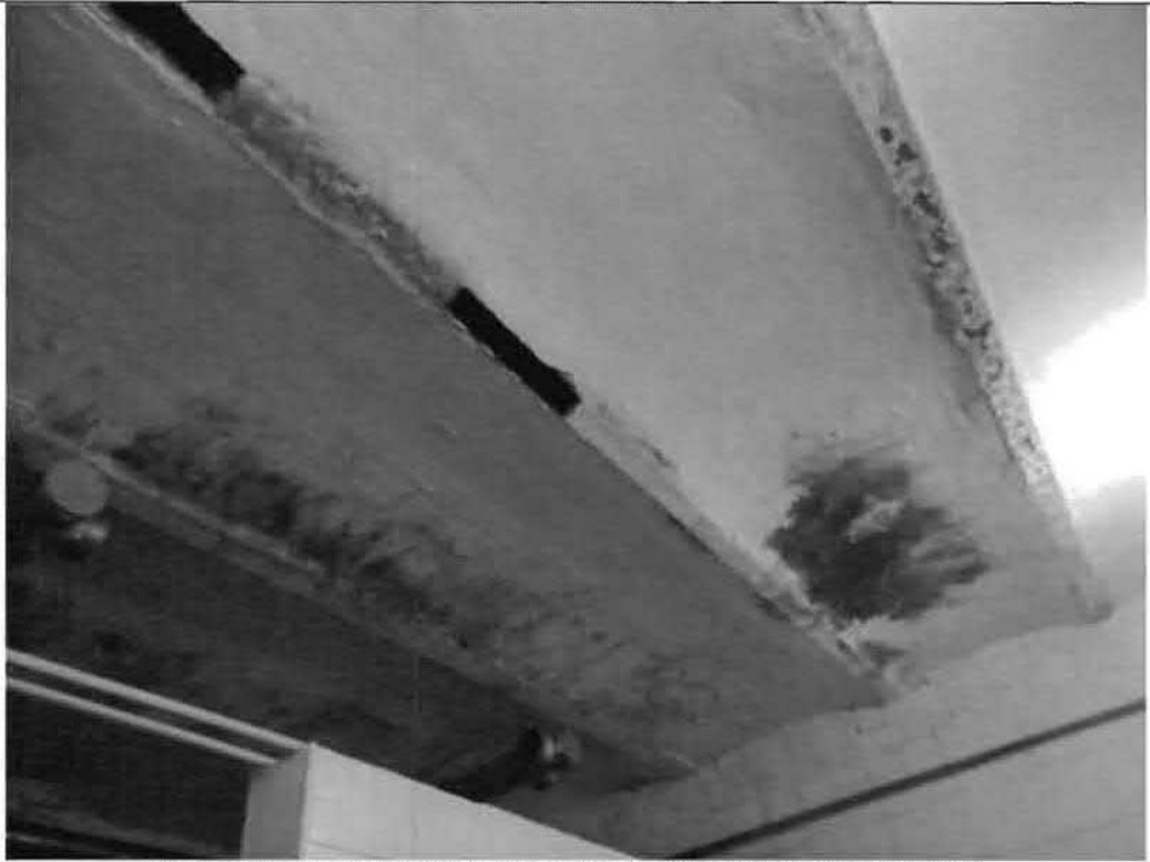
Своды по металлическим балкам. Съемка 27.11.2012, Воронина Н.В.
