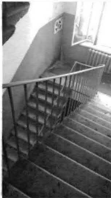
Фото 144. Лестница № 2 в южной части здания. Общий вид.
