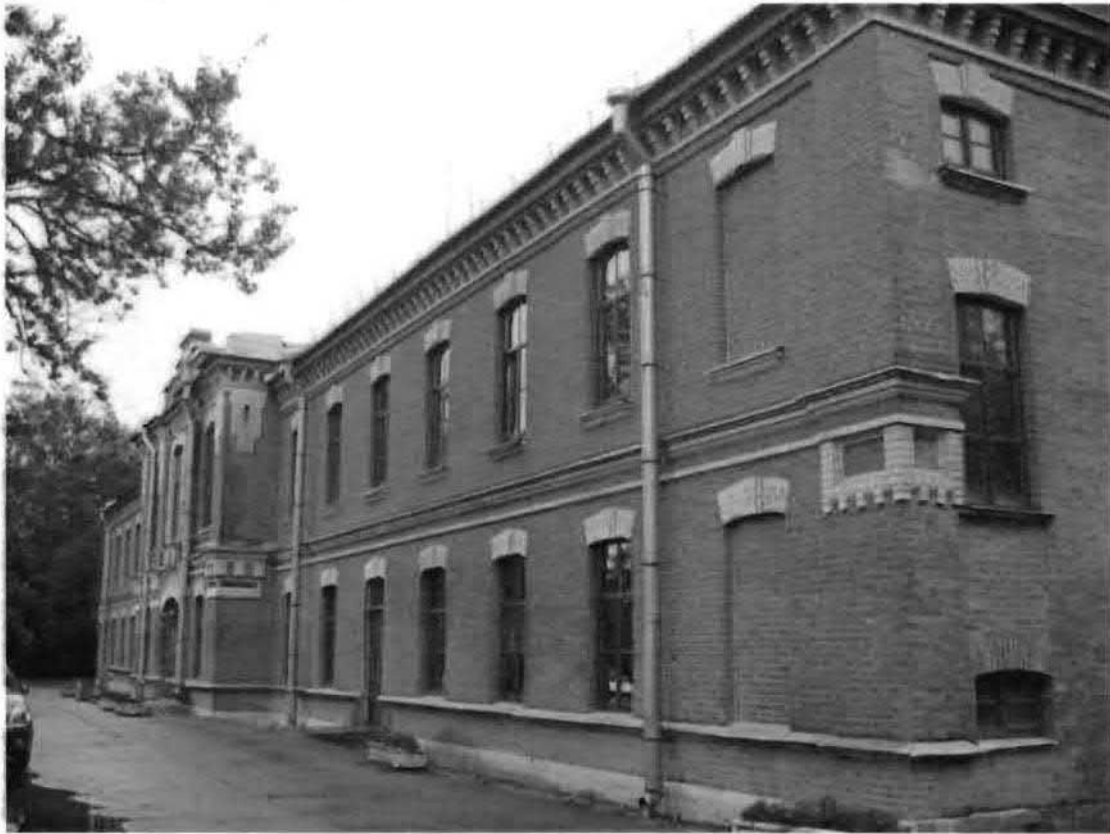
Фото 64. Северный фасад. Общий вид.
