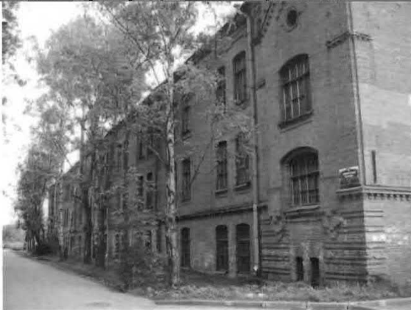
Фото 1. Западный фасад. Общий вид.
