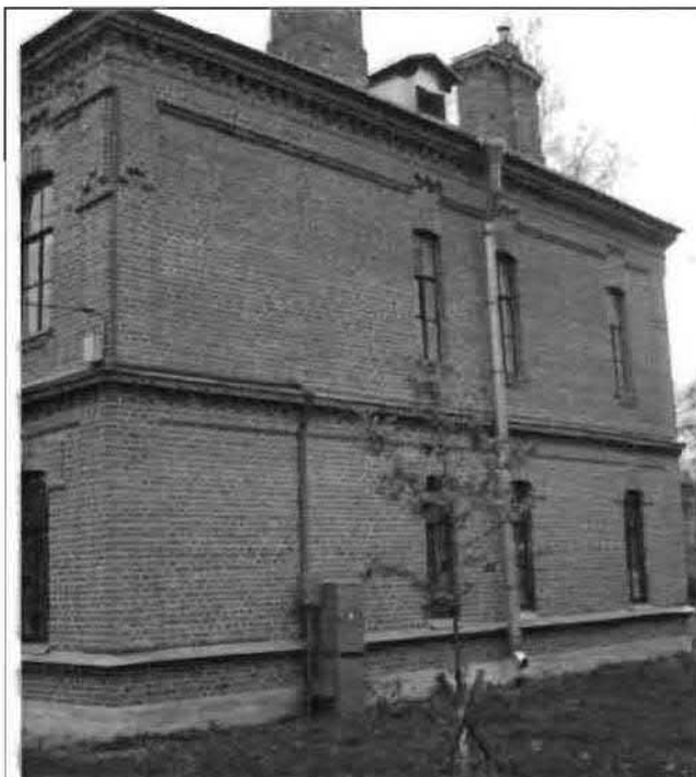
Фото 134. Южный фасад. Общий вид.
