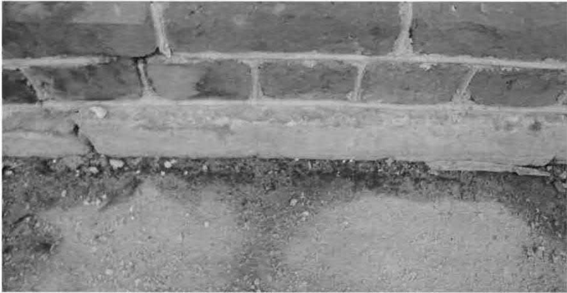
Цоколь, облицованный известняковой скобой. Съемка 20.11.2012, Воронина Н.В.
