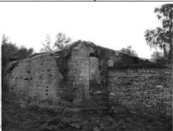
Фото 187. Северный фасад. Общий вид.
