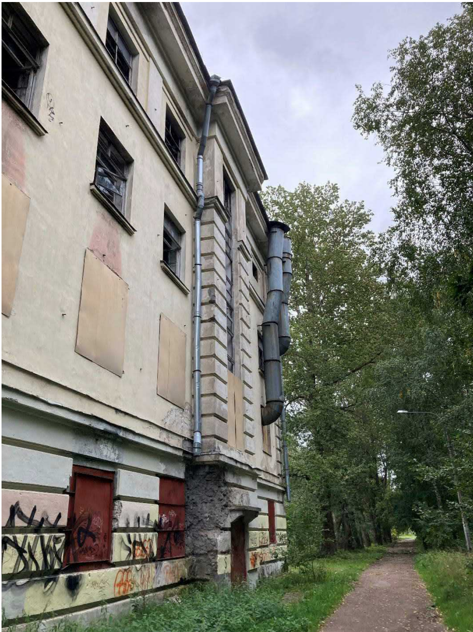
Фото 16. Здание со стороны южного фасада.
