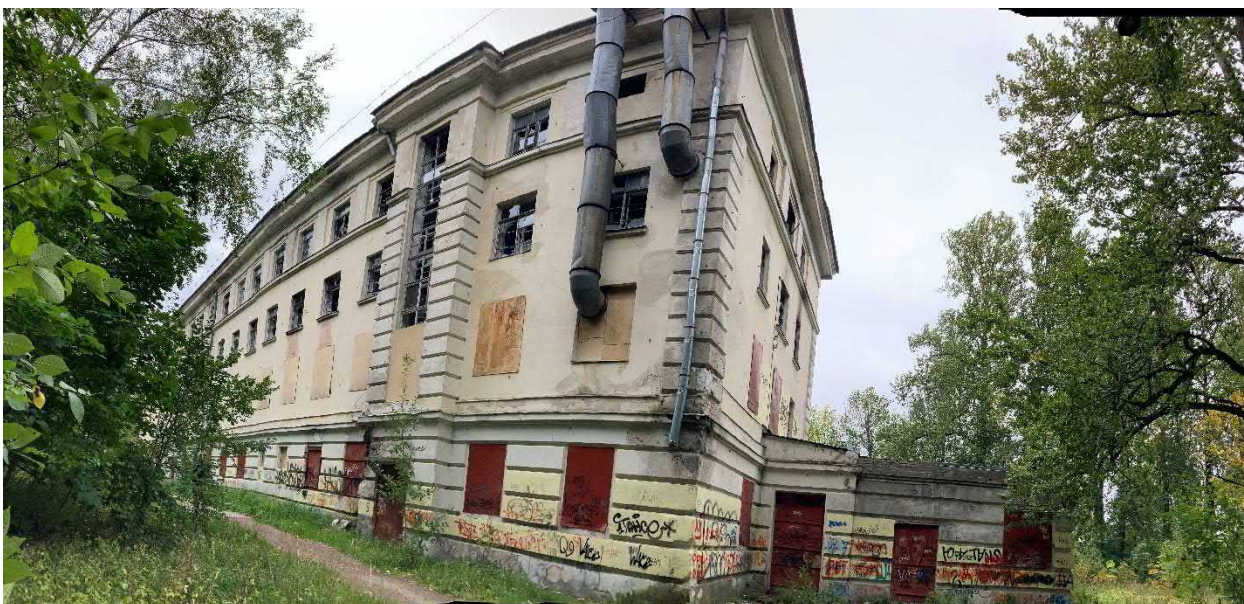
Фото 13. Здание, пристройка-столовая со стороны юго-юго-восточного фасада. Панорамный снимок
