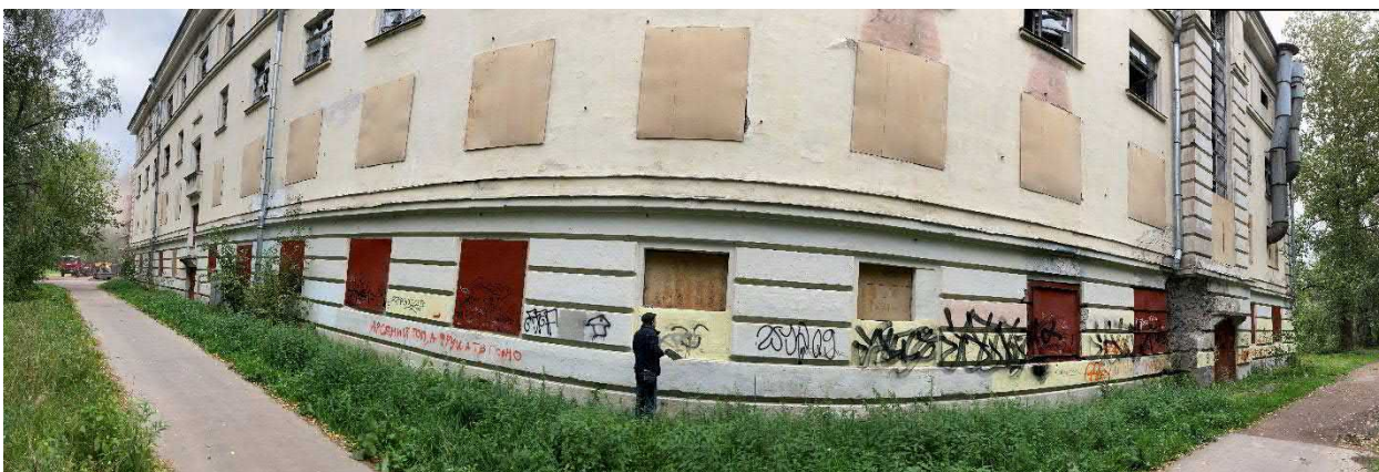
Фото 14. Здание со стороны южного фасада. Панорамный снимок
