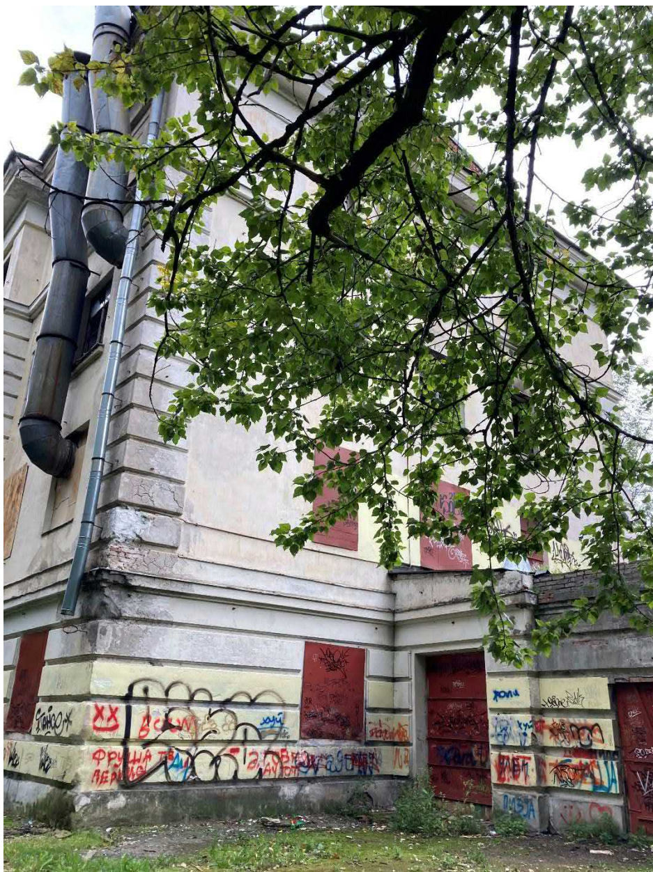
Фото 11. Пристройка-столовая со стороны юго-восточного фасада
