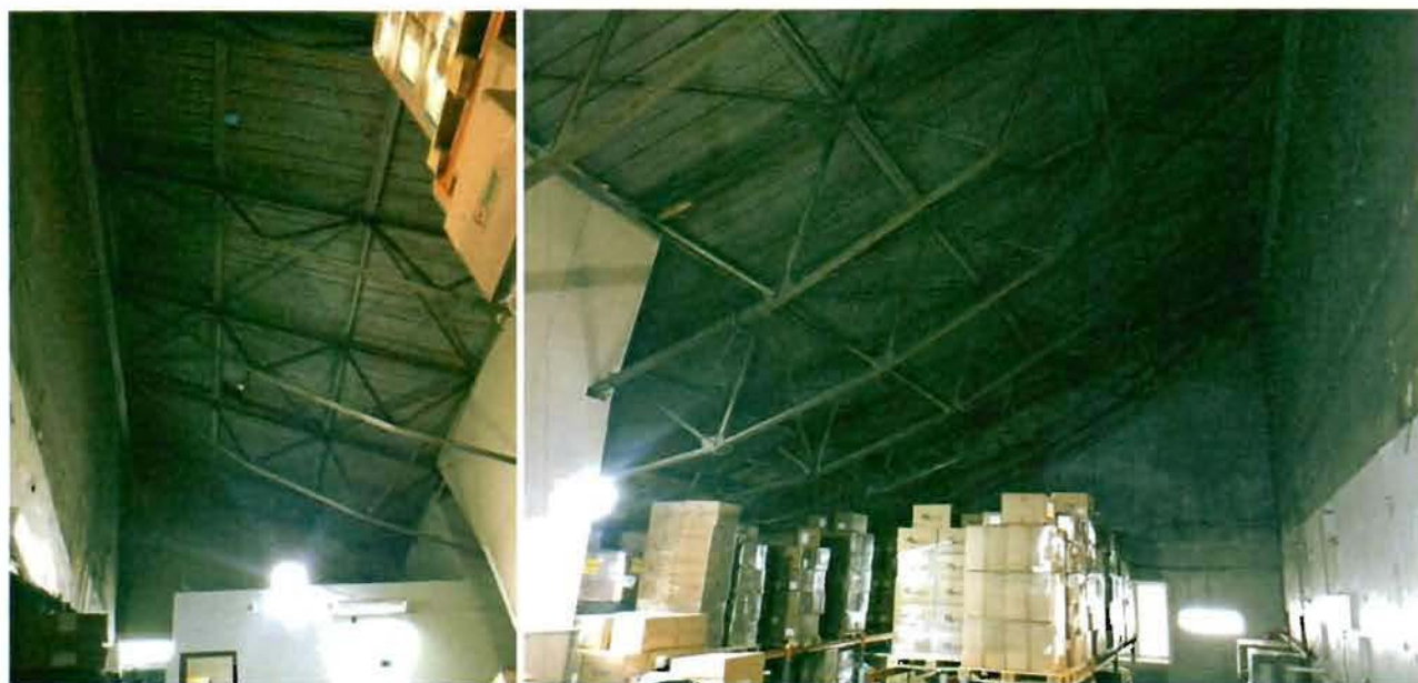
13, 14. Металлические фермы перекрытий складских помещений.
