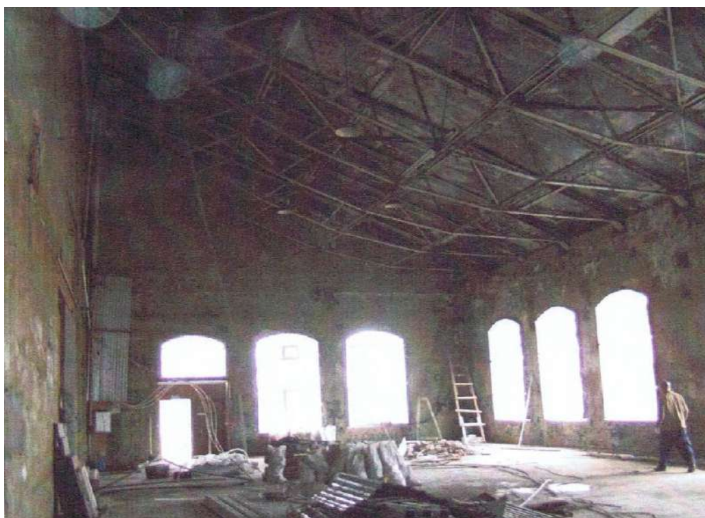
31. Металлические серповидные фермы (северная часть) до ремонта, сейчас защиты подвесным потолком // Источник: Архив КГИОП.
