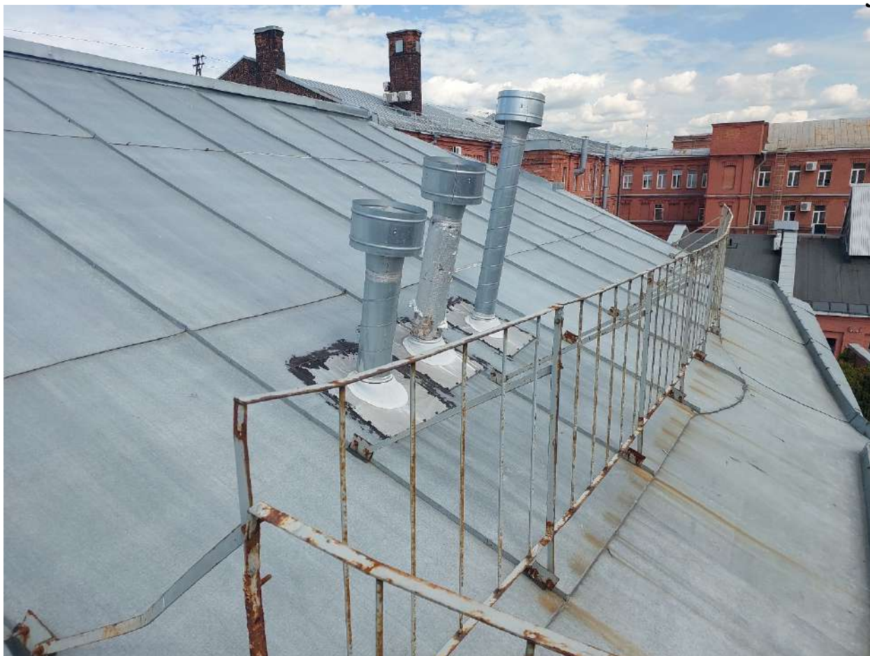
Фото 31. Общее состояние кровельного покрытия дворового корпуса. Дата фотофиксации: 26.09.2025г.
