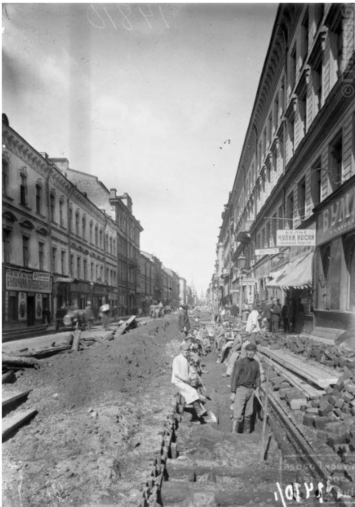
Илл. 21. Канализационные работы на улице Дзержинского (Гороховой улице) во время завершающего этапа (засыпка траншей). Фотография. 1920-е гг. Автор съемки: неизвестен.
