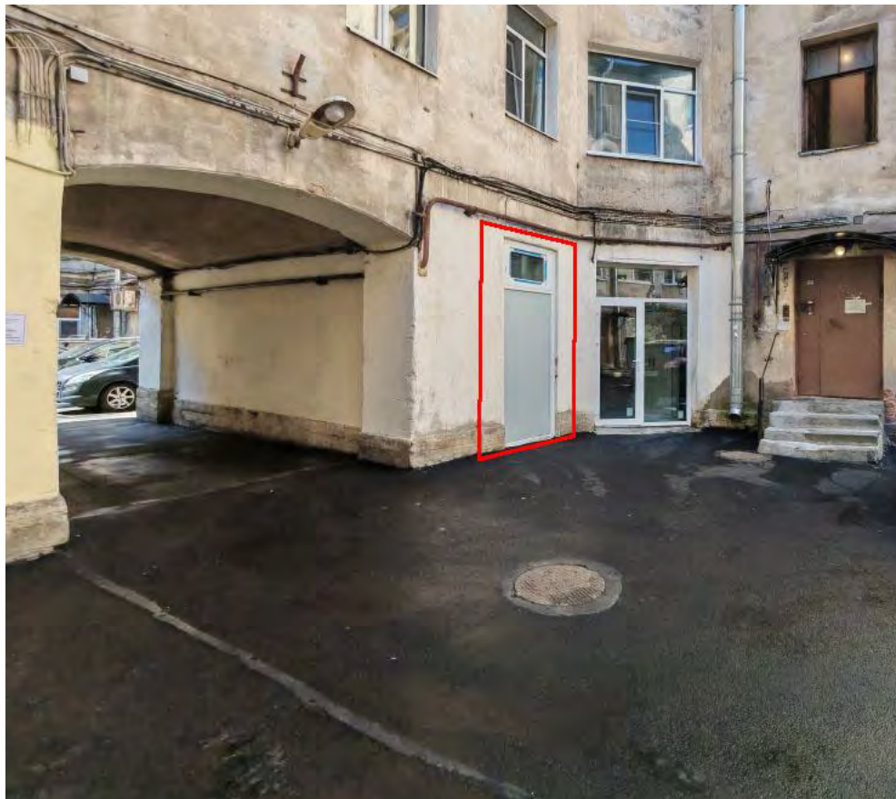
10. Выявленный объект культурного наследия «Дом Т.Г. Растеряевой». Современное оконное заполнение в помещении 13-Н на месте дверного проема с сохранением габаритов и конфигурации проема.
