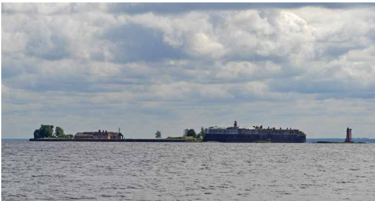
Фото 1. Общий вид на форт «Кроншлот» с севера
