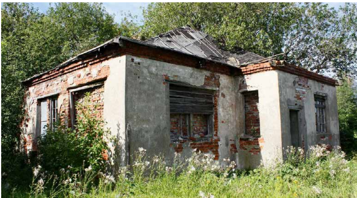
Фото 13. Юго-восточный и юго-западный фасады служебной постройки. Вид с юго-востока
