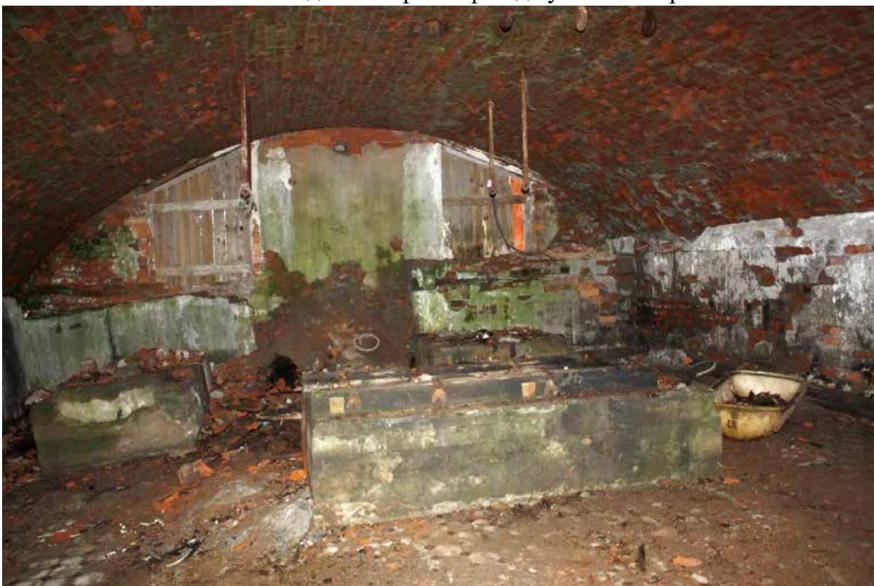
Фото 6. Помещение кухни. Вид с северо-запада
