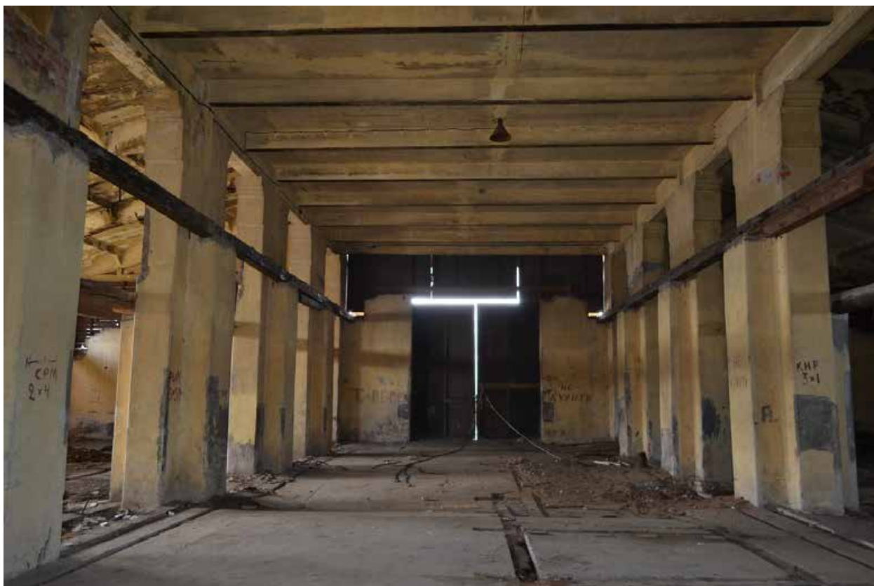
Фото 7. Помещения эллинга. Вид с северо-востока
