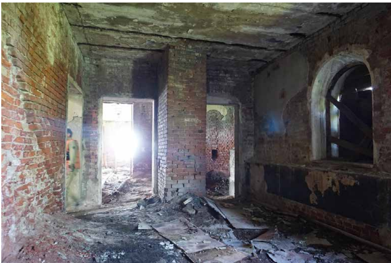
Фото 43. Помещения центрального ризалита. Вид с юго-востока
