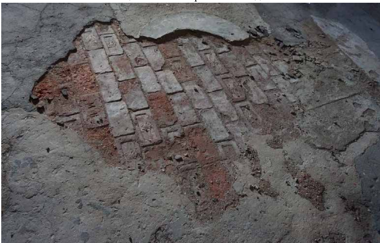
Фото 28. Помещения в южной части основного объема. Вид с юго-востока
