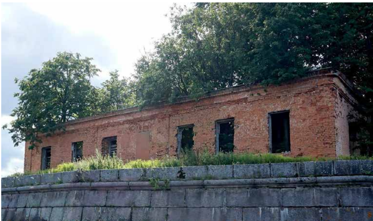
Фото 3. Северо-восточный фасад. Вид с северо-востока
