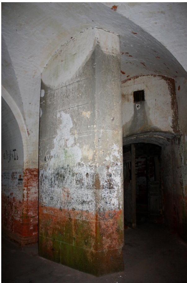
Фото 23. Помещения южного ризалита. Вид с юго-востока
