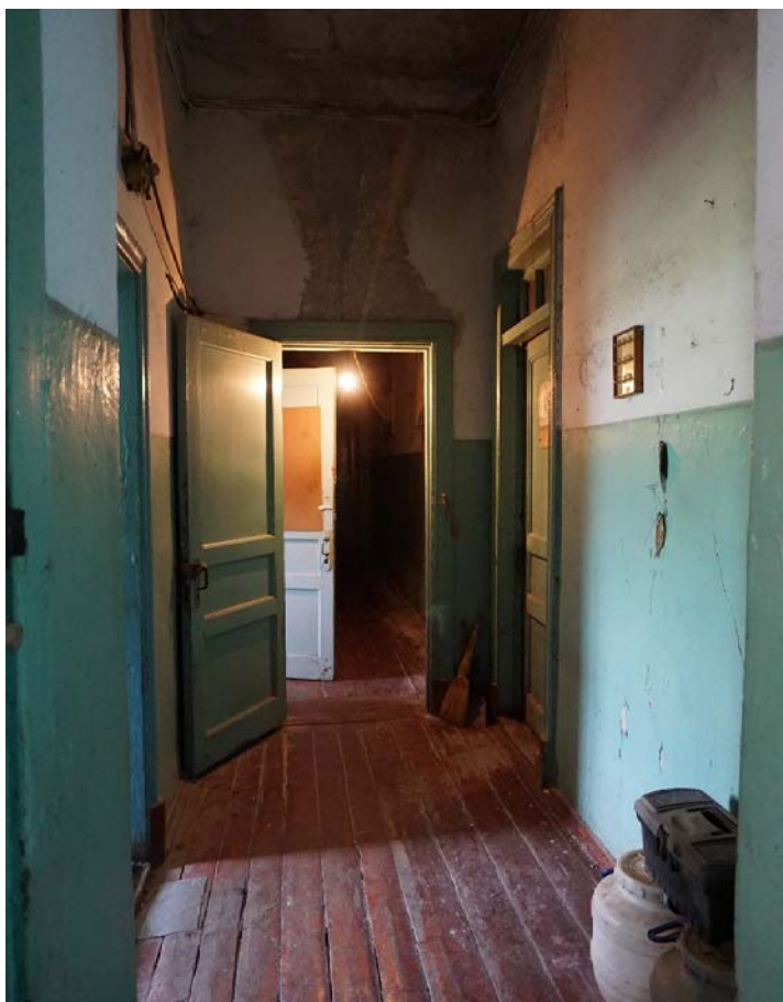
Фото 53. Помещения в северной части основного объема. Вид с северо-востока Крыша
