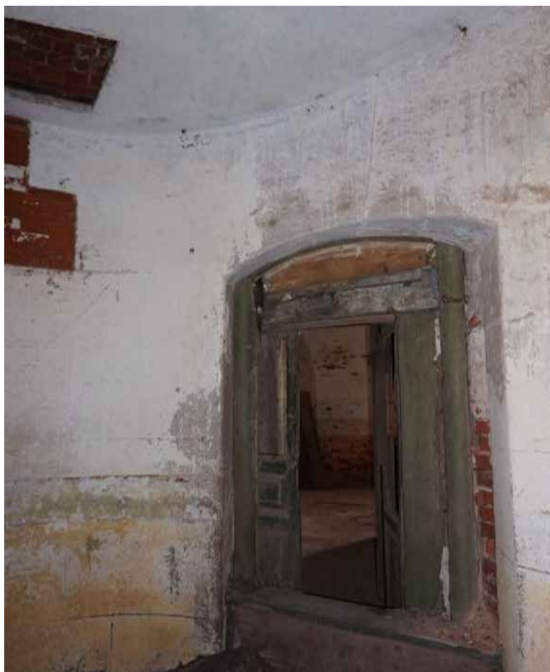
Фото 25. Помещения южного ризалита. Вид с юго-запада
