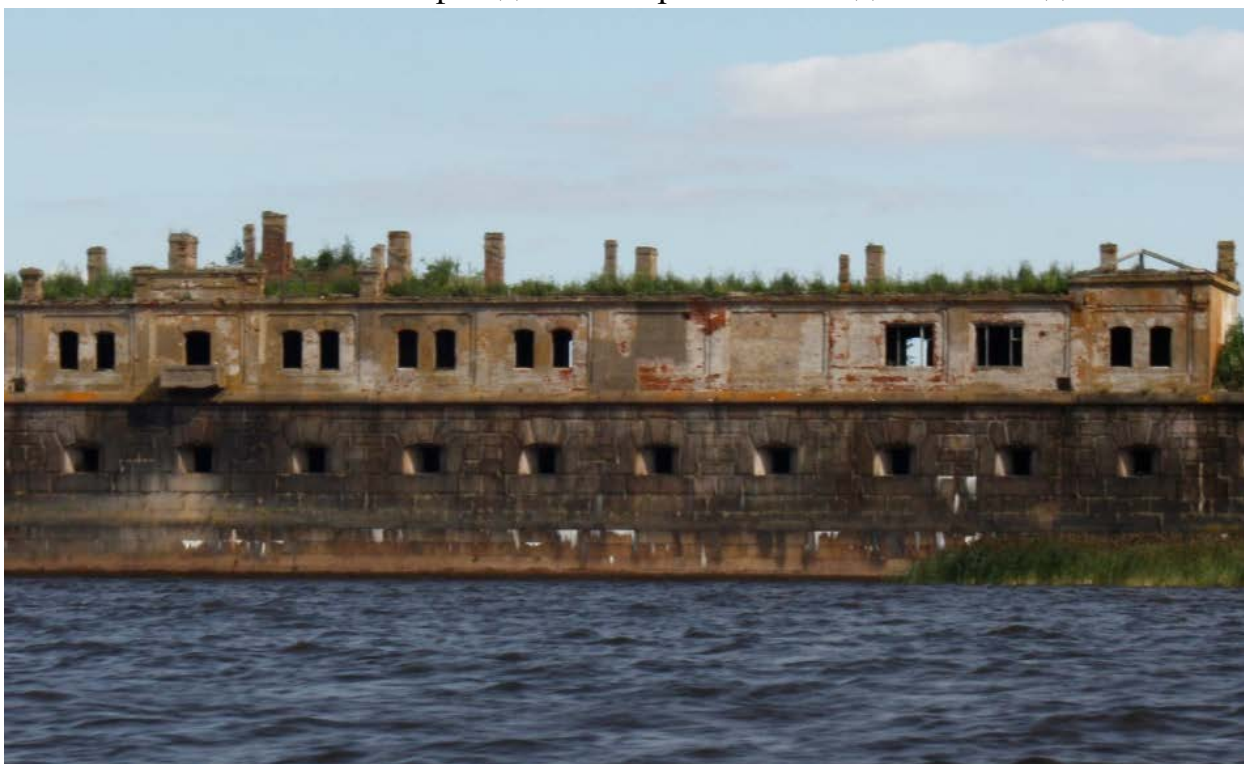
Фото 2. Северо-западный фасад основного объема и южного ризалита (фрагмент). Вид с северо-запада
