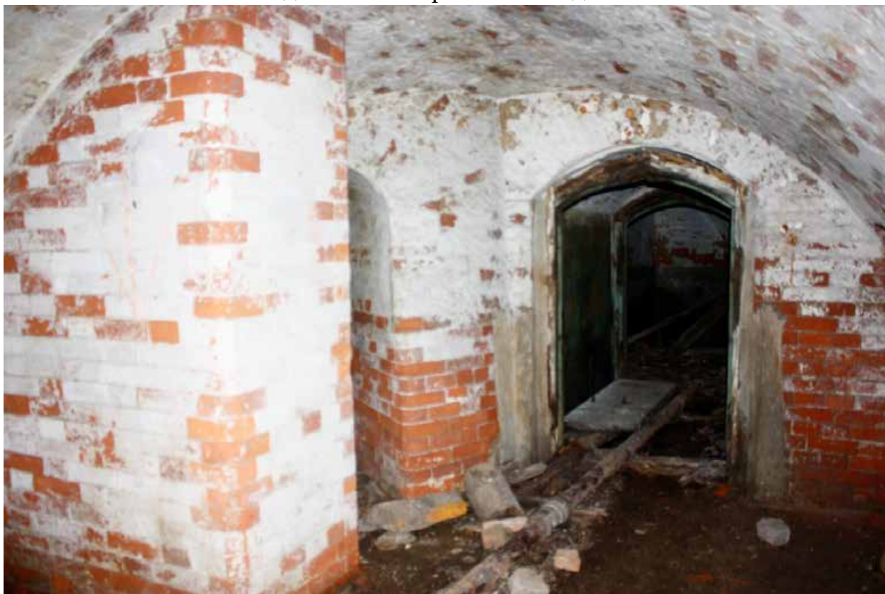
Фото 19. Подвал южного ризалита. Вид с юго-востока
