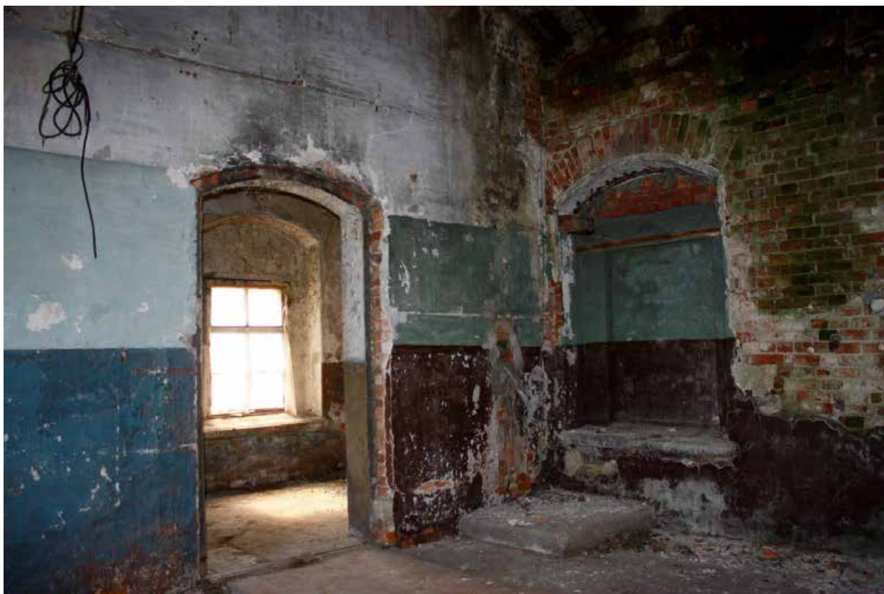
Фото 7. Помещения восточного ризалита цейхгауза. Вид с северо-востока
