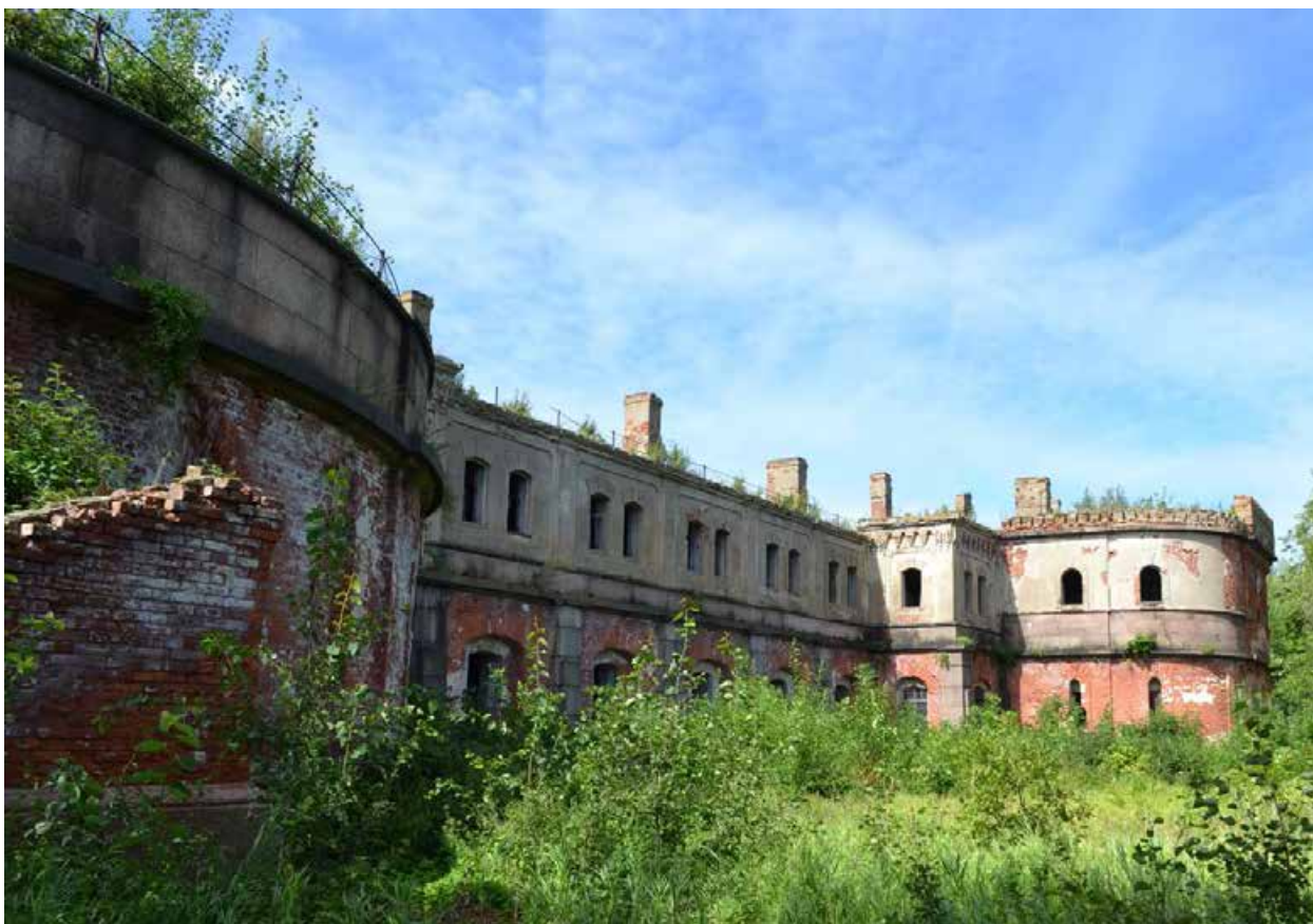
Фото 15. Юго-восточный фасад южной части основного объема. Вид с юго-востока
