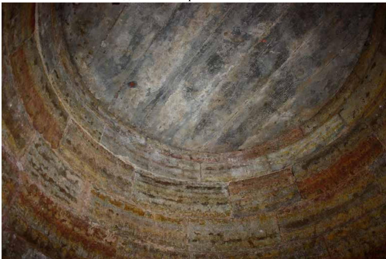
Фото 20. Подвал южного ризалита. Вид с юго-востока
