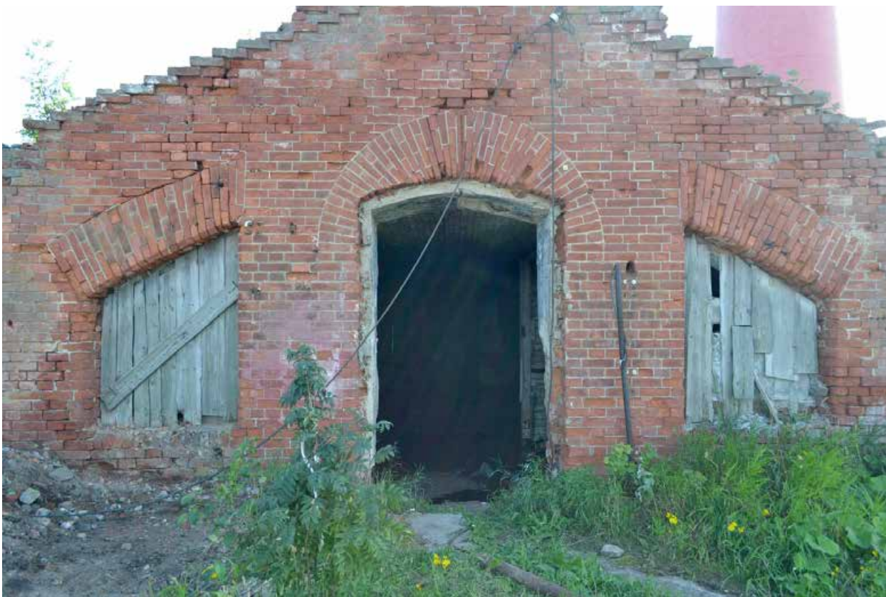
Фото 5. Вид на северный фасад кухни с севера
