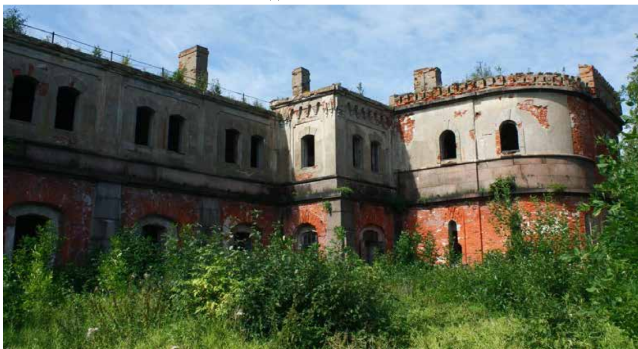
Фото 8. Юго-восточный фасад северной части основного объема. Вид с юго-востока
