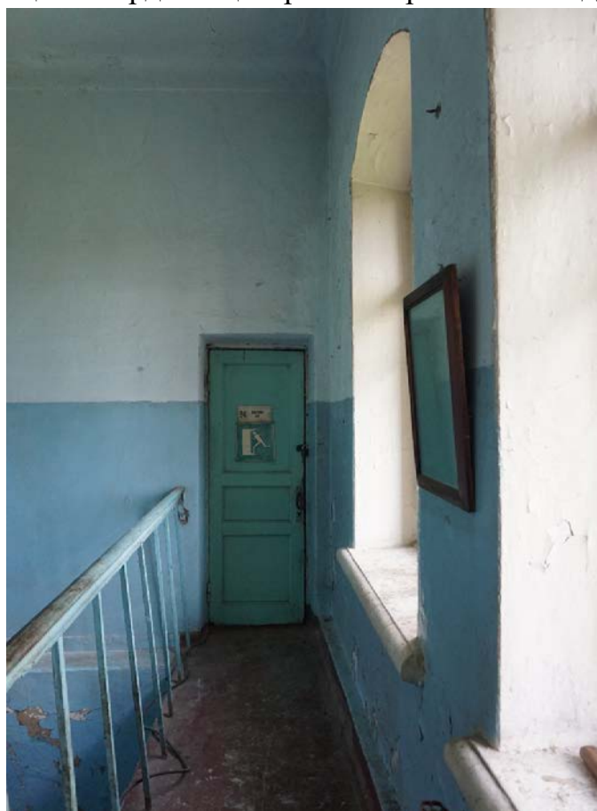
Фото 50. Помещения в северной части основного объема. Вид с юго-запада
