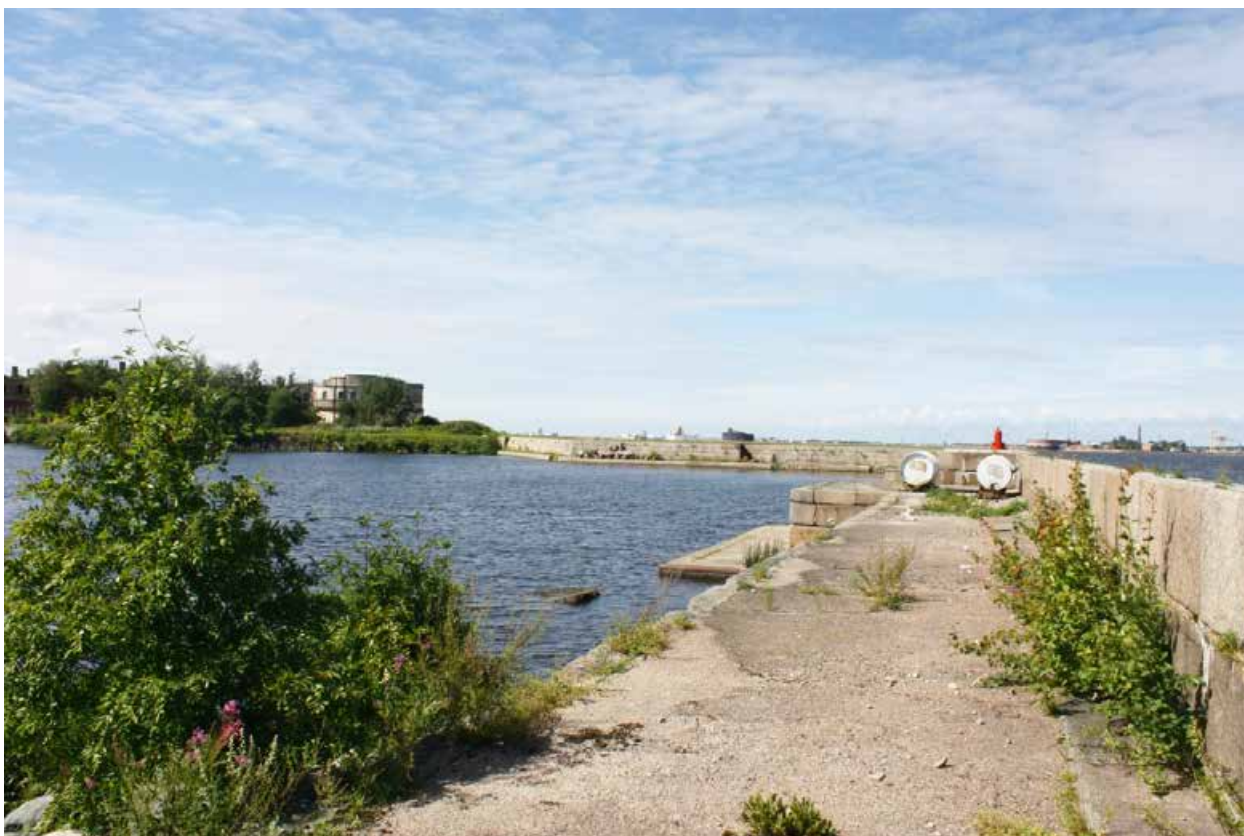
Фото 21. Восточный мол гавани. Вид с юго-востока
