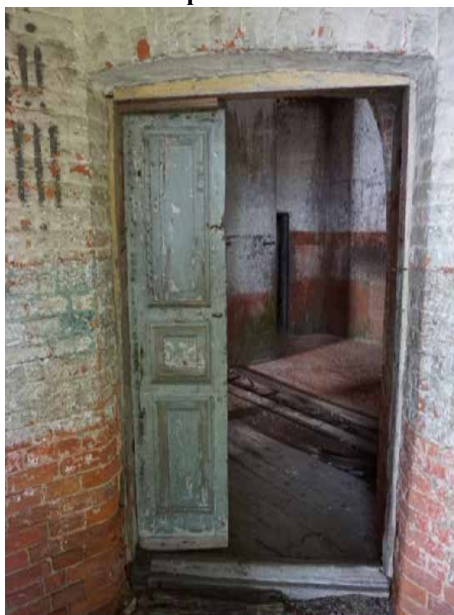
Фото 22. Помещения южного ризалита. Вид с юго-запада
