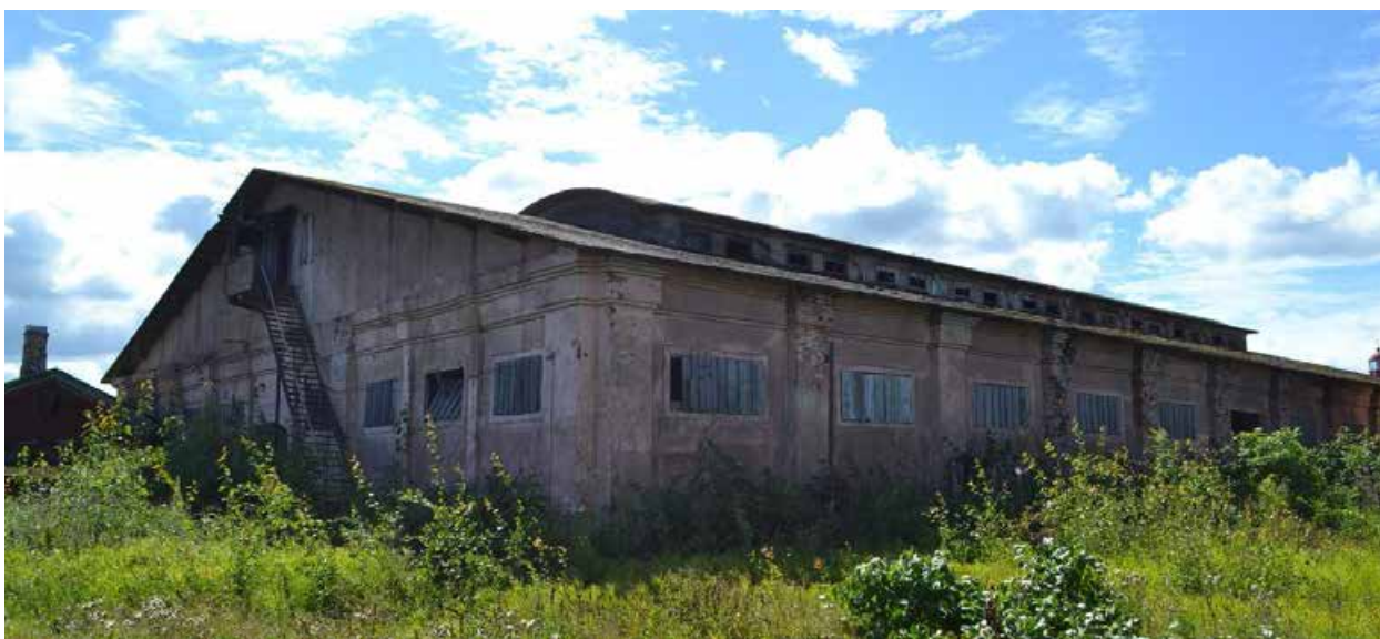
Фото 4. Северо-восточный и северо-западный фасады эллинга. Вид с северо-востока
