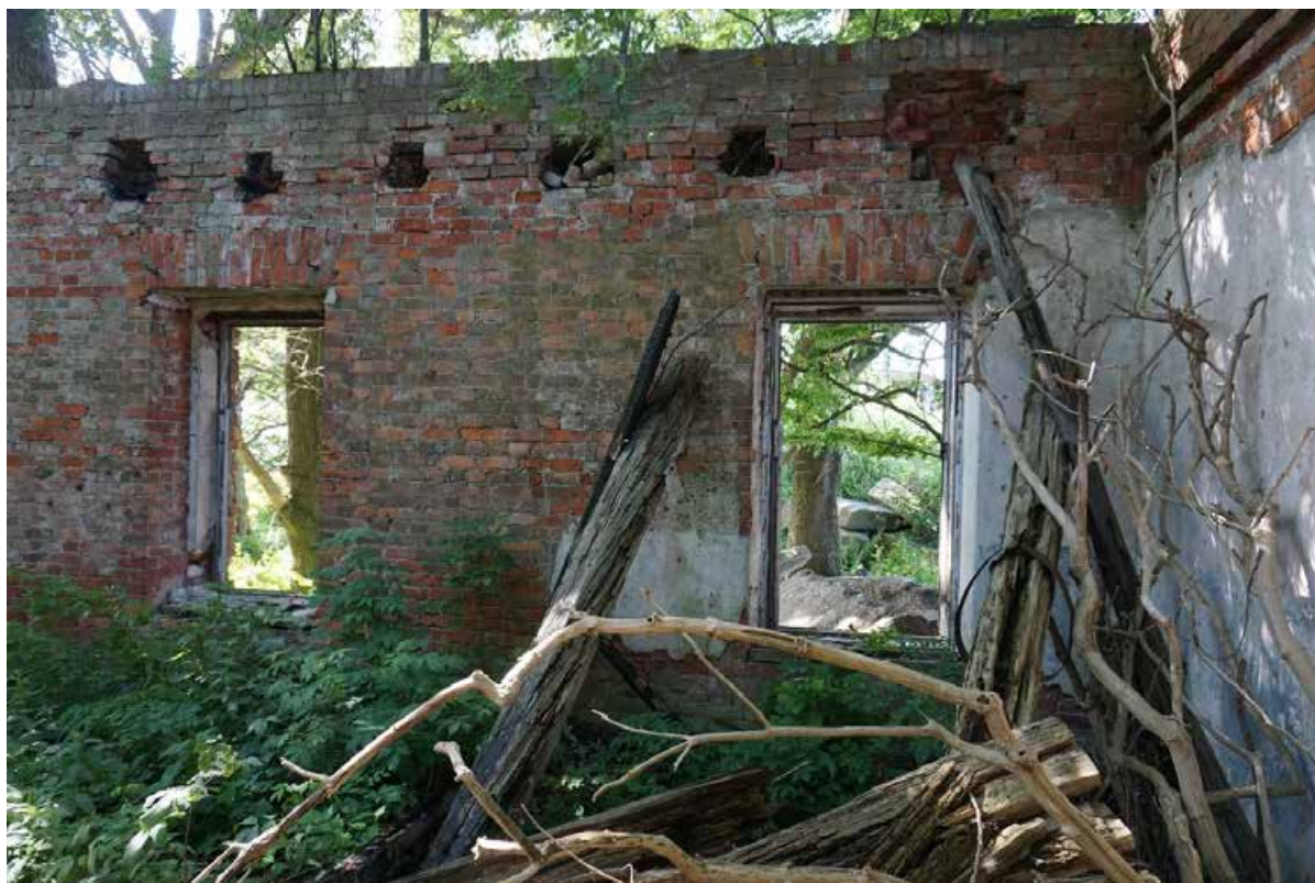
Фото 7. Помещения. Вид с северо-востока
