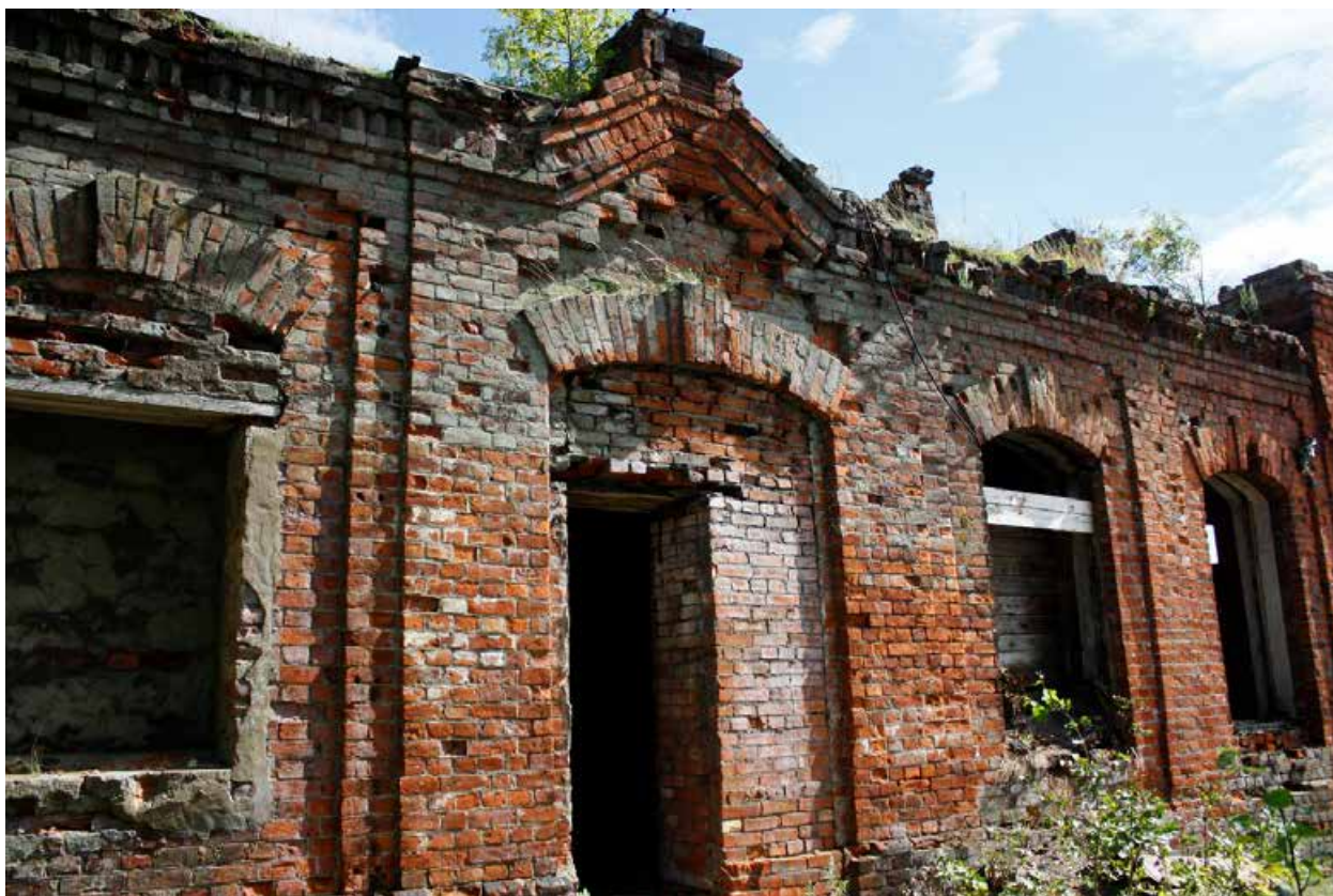
Фото 5. Центральная часть северо-западного фасада цейхгауза. Вид с северо-запада
