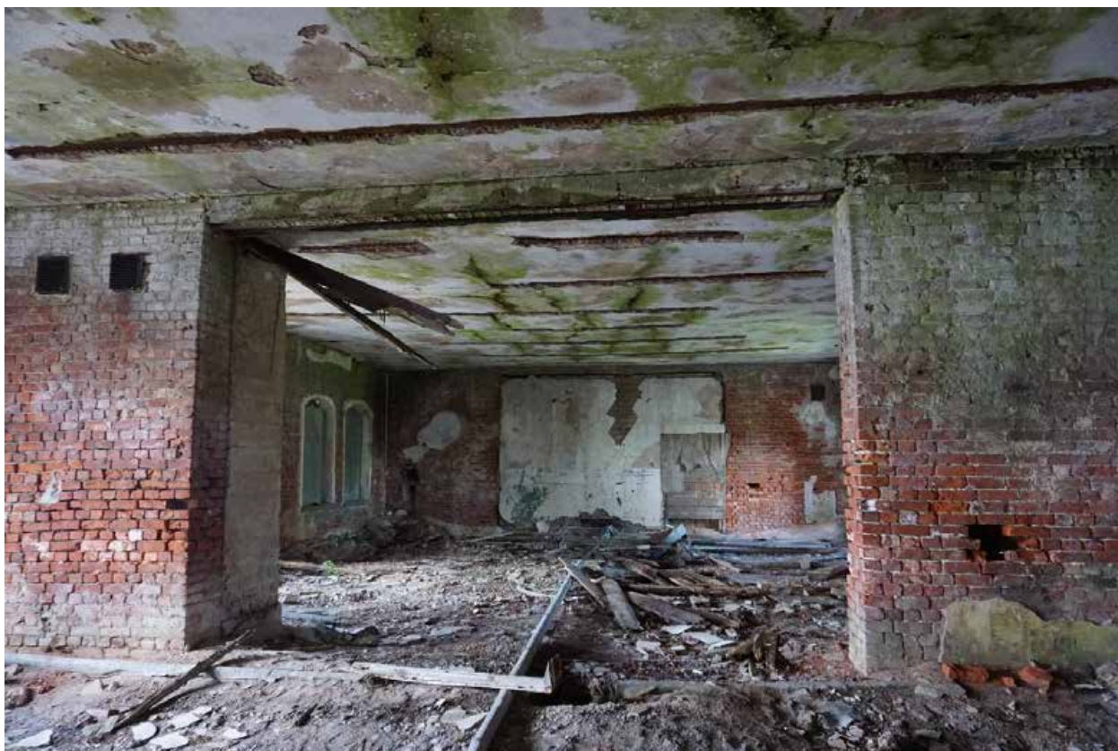
Фото 46. Помещения в центральной части основного объема. Вид с юго-запада
