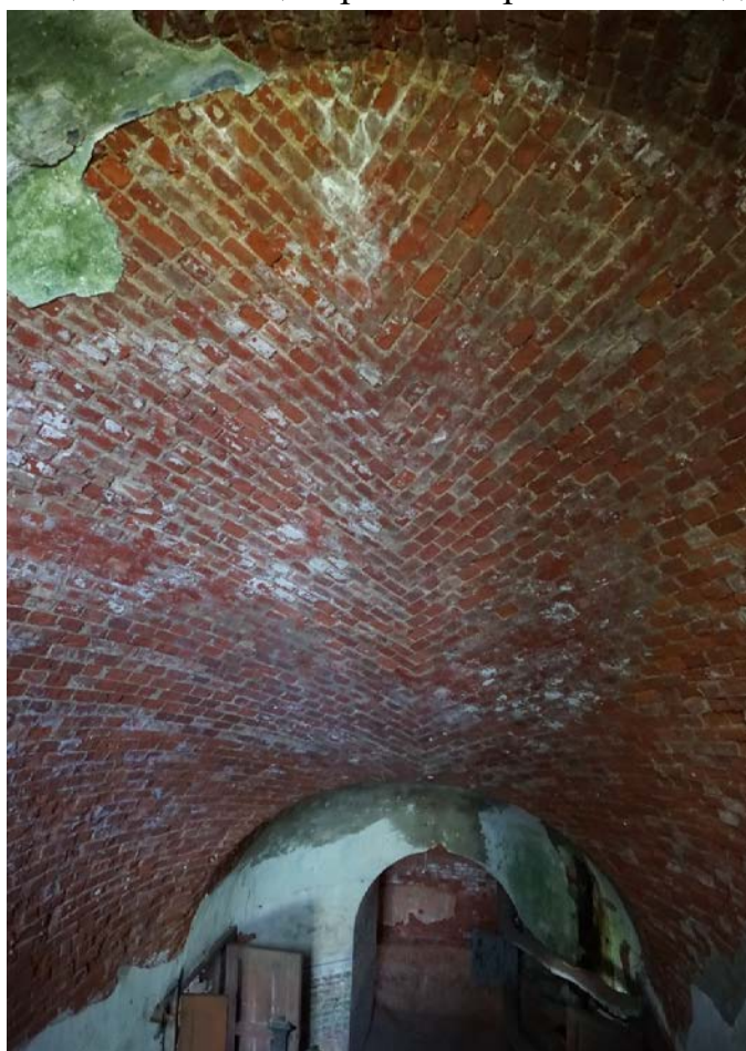
Фото 42. Лестница в объеме центрального ризалита. Вид с юго-востока
