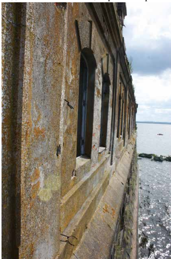
Фото 12. Фрагмент лицевого фасада.
