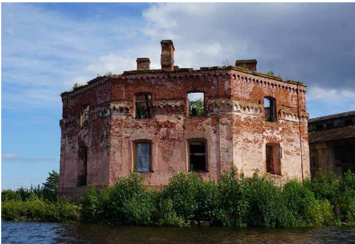
Фото 13. Вид на восьмигранную башню с северо-запада
