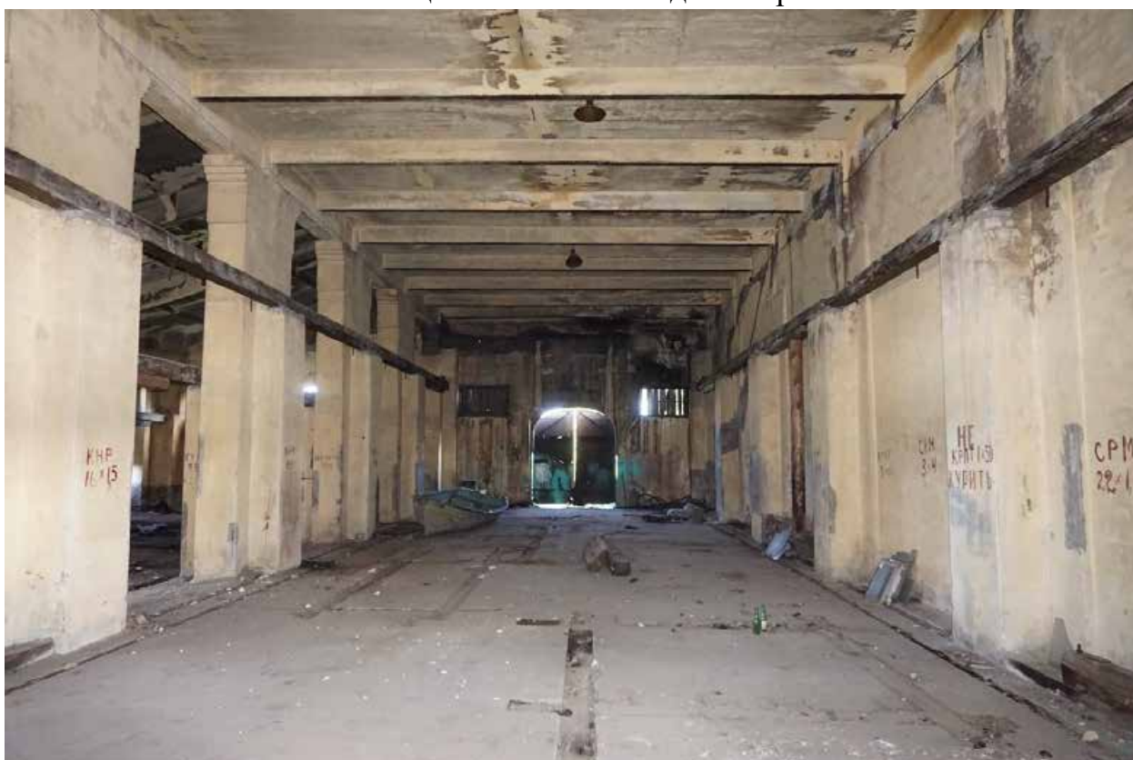
Фото 8. Помещения эллинга. Вид с юго-запада
