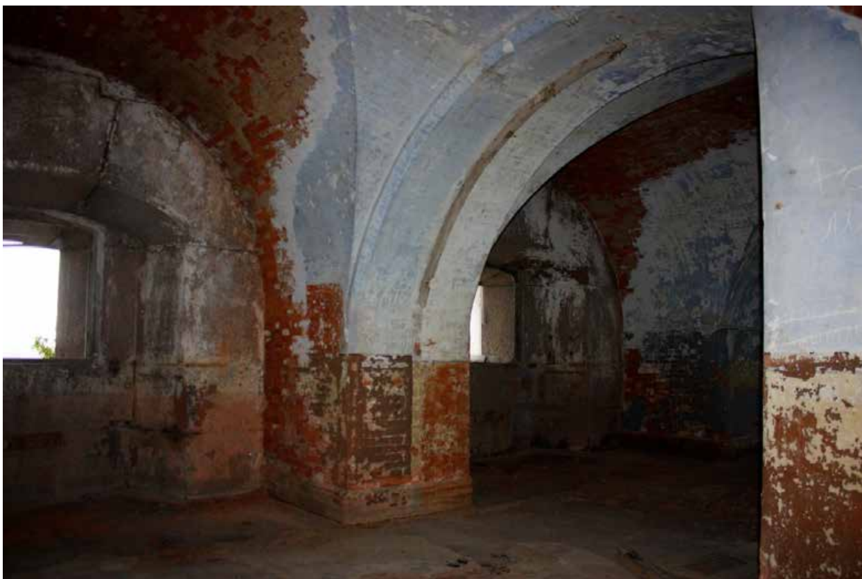
Фото 27. Помещения южного ризалита. Вид с юго-востока
