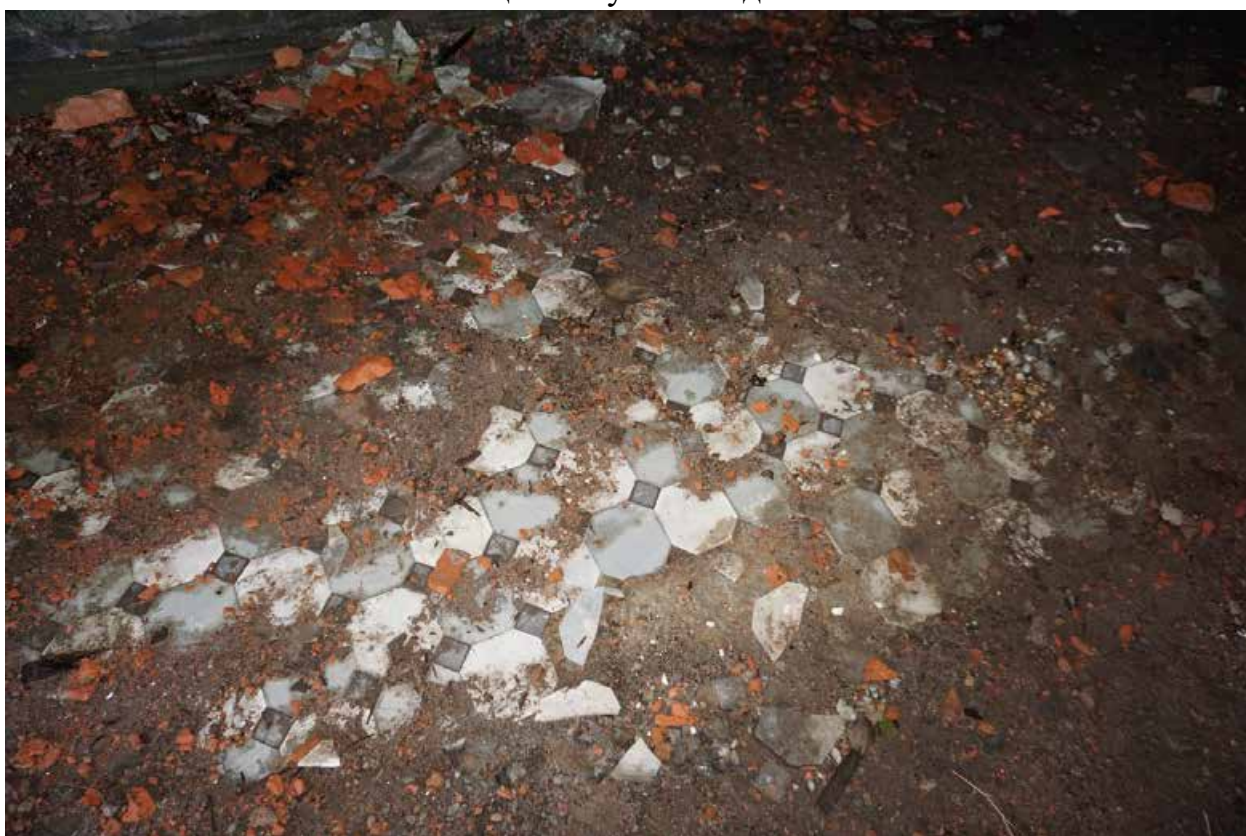
Фото 8. Помещение кухни. Вид с северо-запада
