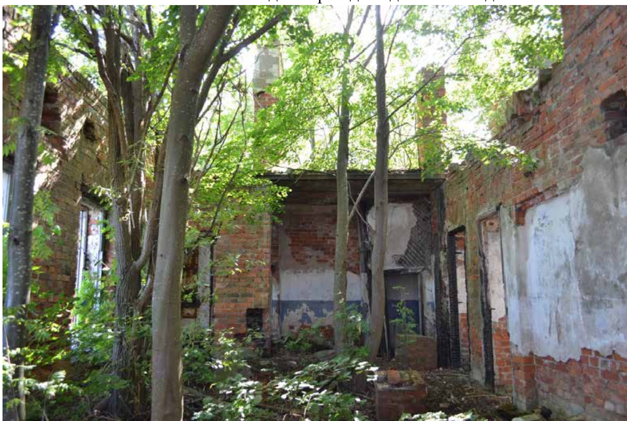
Фото 6. Помещения. Вид с северо-запада
