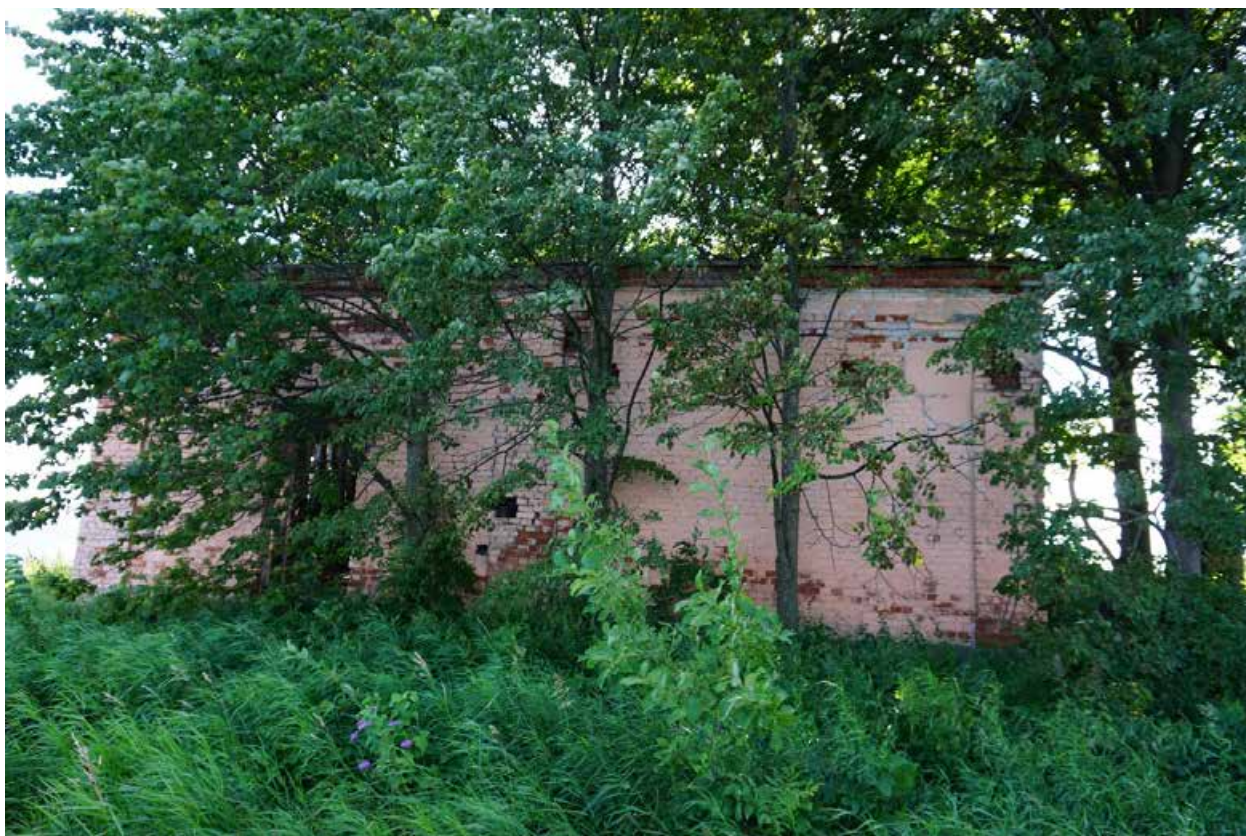
Фото 1. Вид на северо-западный фасад с северо-запада
