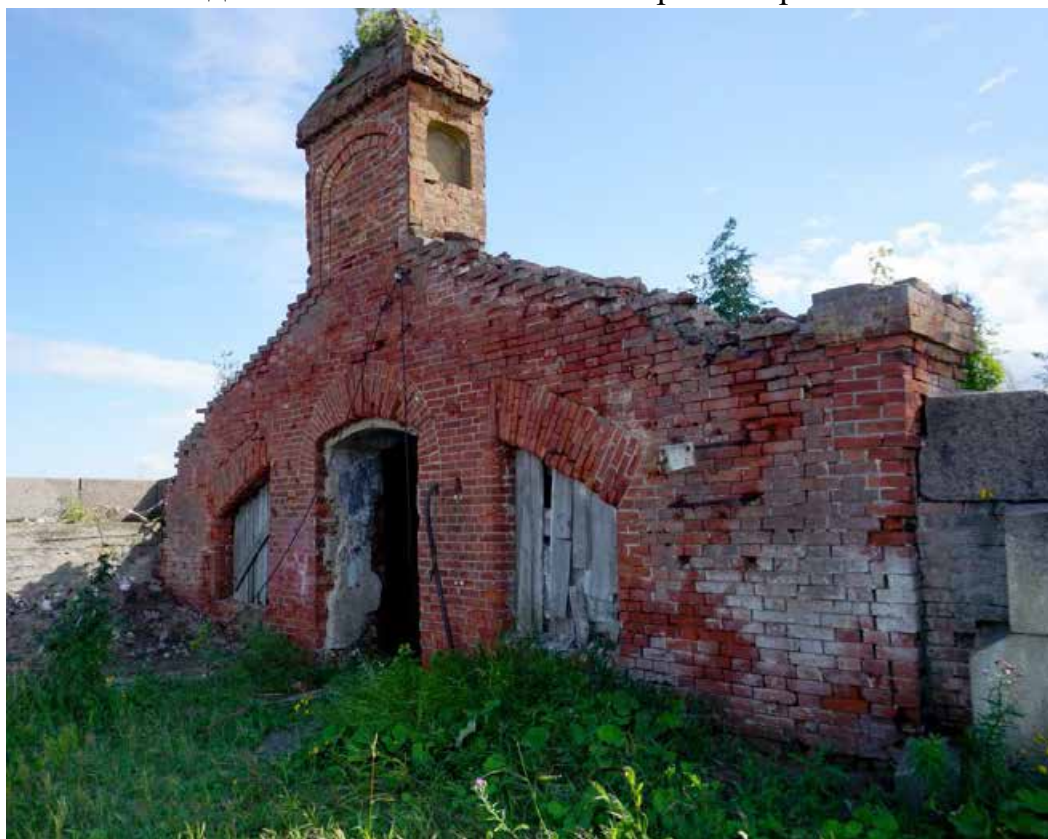
Фото 4. Вид на северный фасад кухни с севера
