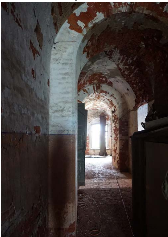
Фото 38. Помещения в центральной части основного объема. Вид с юго-запада
