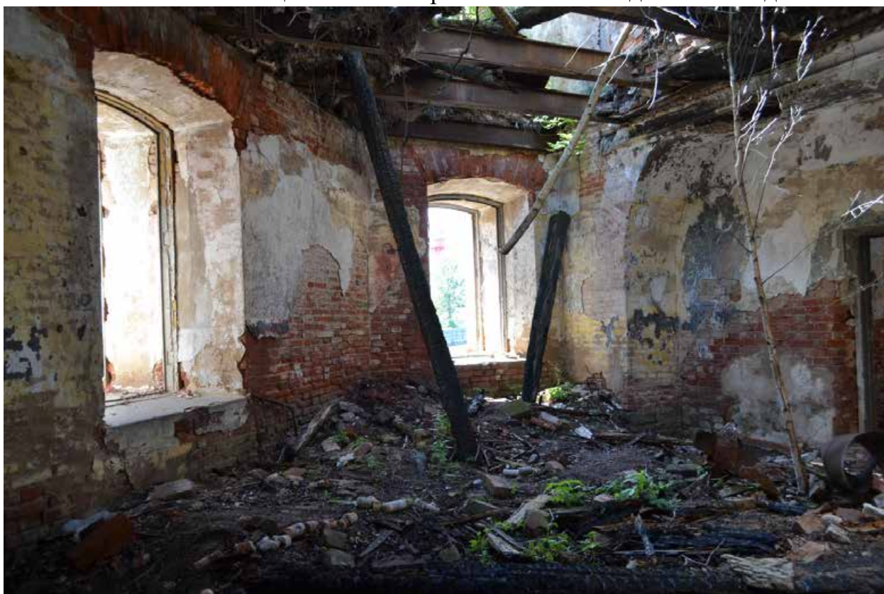
Фото 16. Помещения восьмигранной башни. Вид с северо-востока
