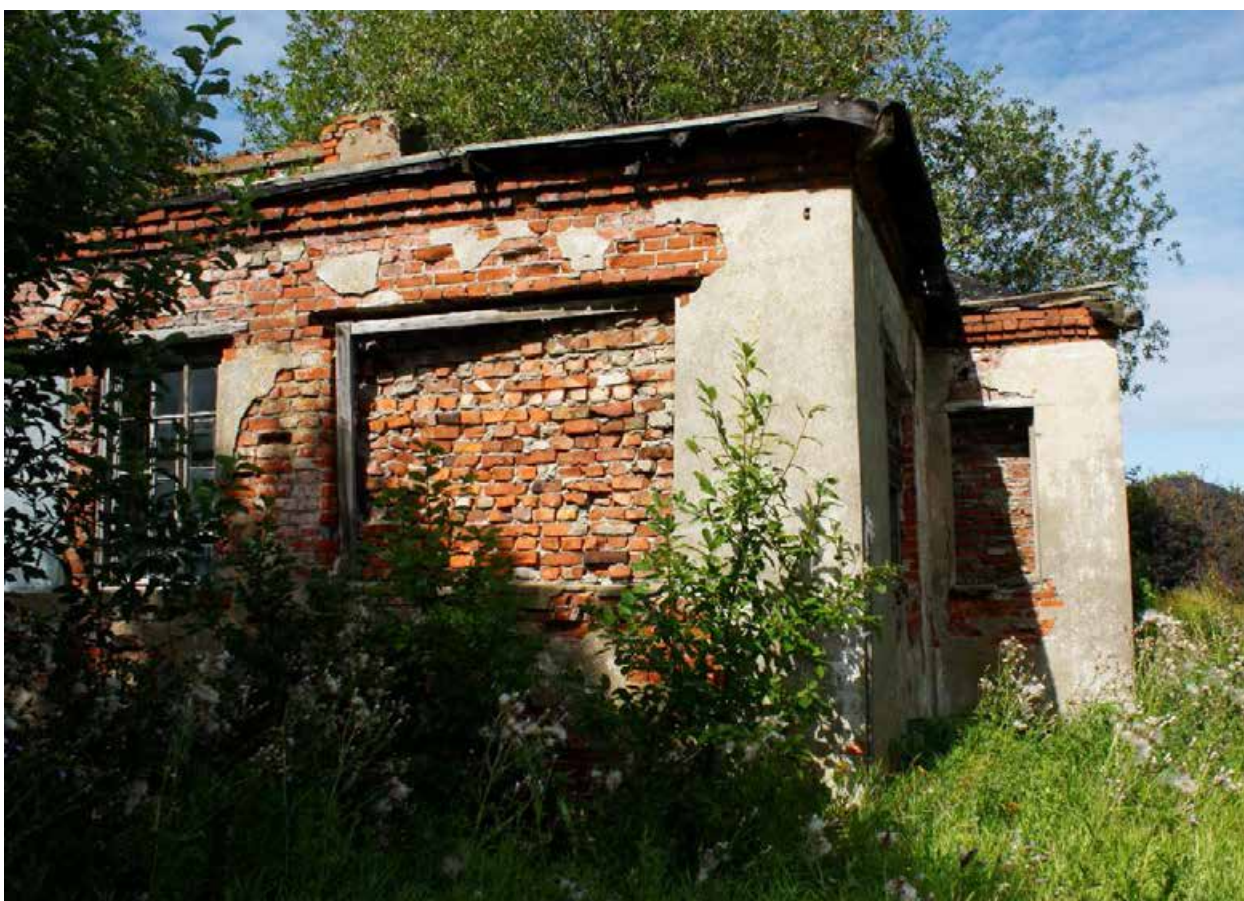
Фото 14. Правая часть юго-западного фасада служебной постройки. Вид с юга
