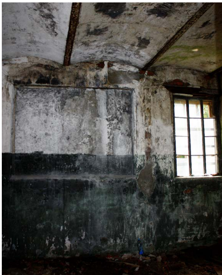
Фото 17. Помещения служебной постройки. Вид с северо-востока
