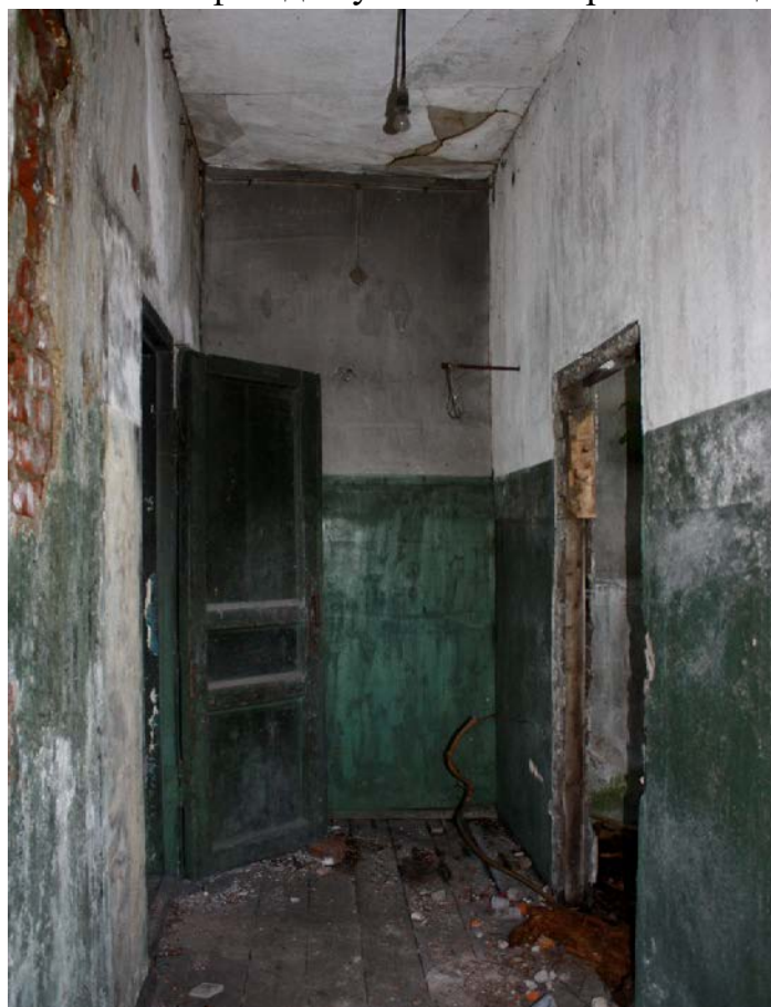
Фото 16. Помещения служебной постройки. Вид с юго-востока
