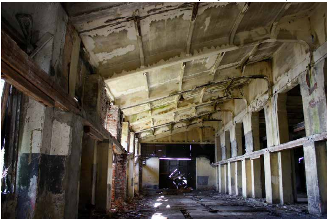
Фото 6. Помещения эллинга. Вид с северо-востока
