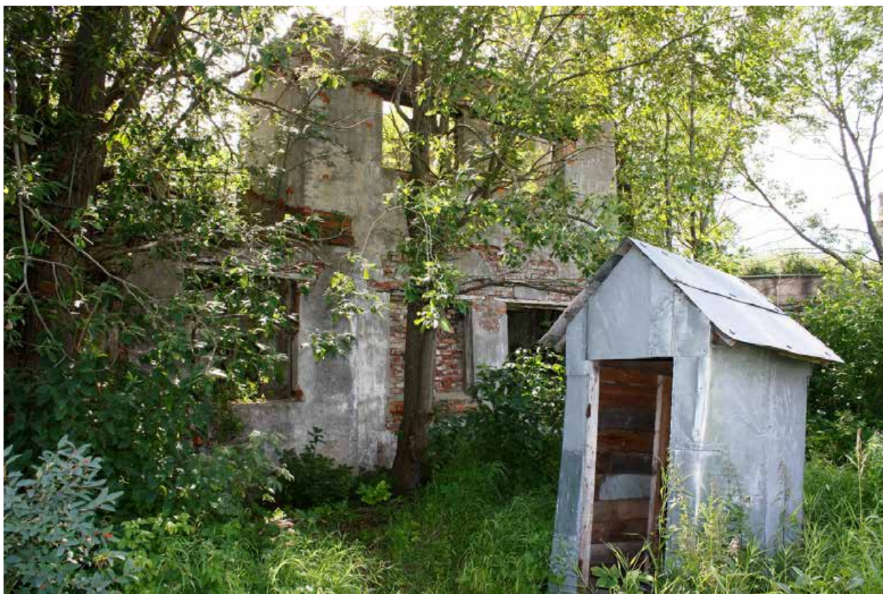
Фото 15. Северо-восточный фасад служебной постройки. Вид с северо-востока
