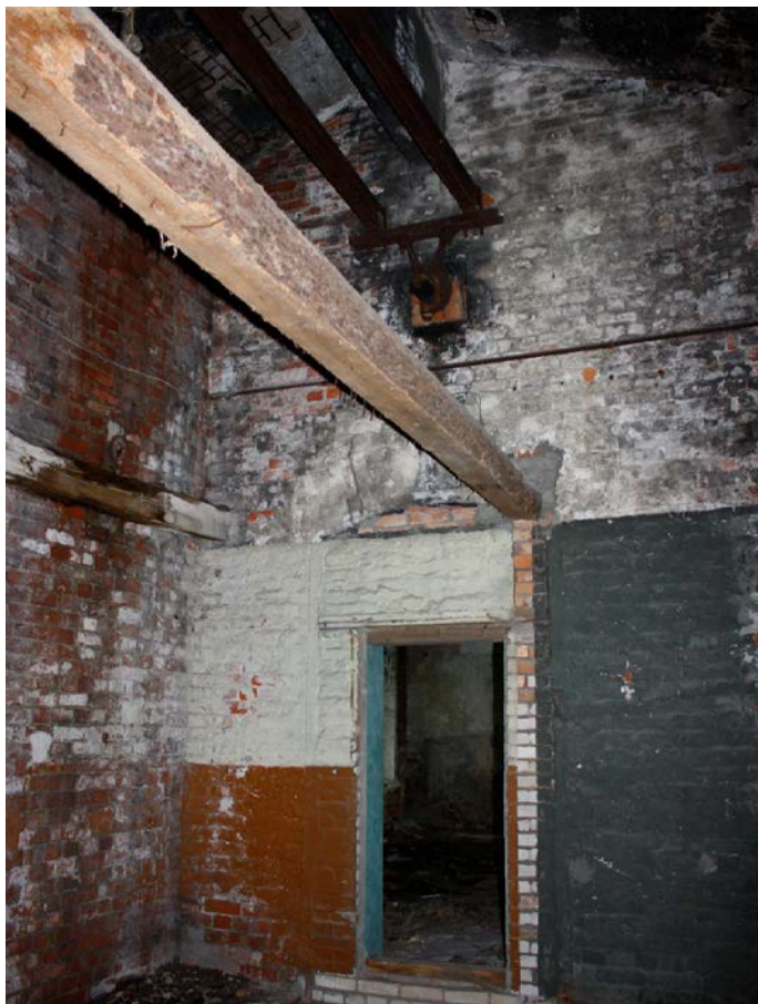
Фото 11. Помещения западного ризалита цейхгауза. Вид с северо-запада
