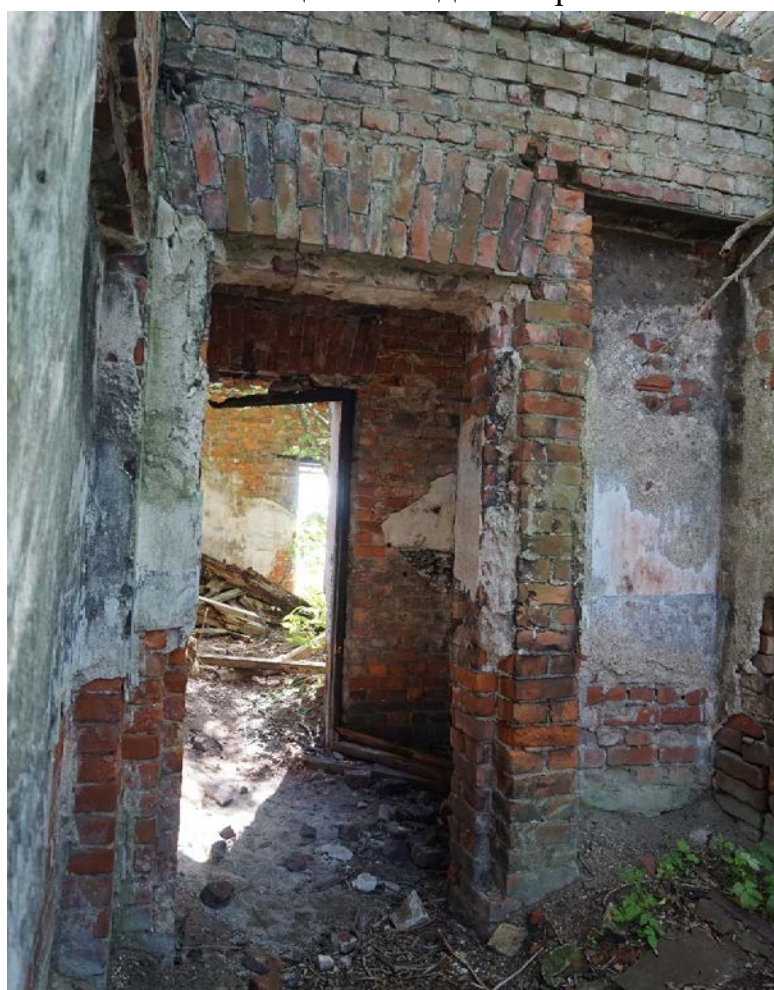
Фото 8. Помещения. Вид с северо-запада
