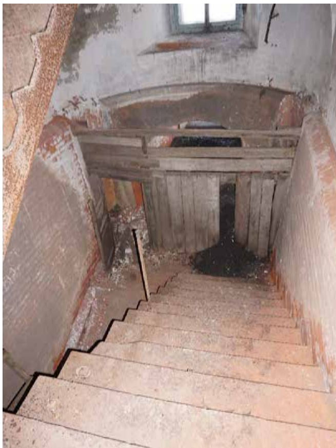
Фото 37. Лестница в помещении подвала в объеме центрального ризалита. Вид с северо-запада
