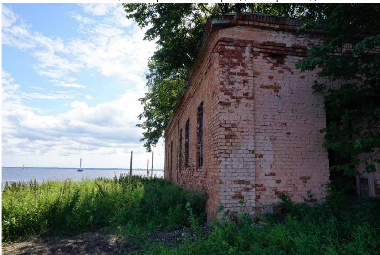
Фото 2. Угол северо-западного и северо-восточного фасадов. Вид с северо-востока
