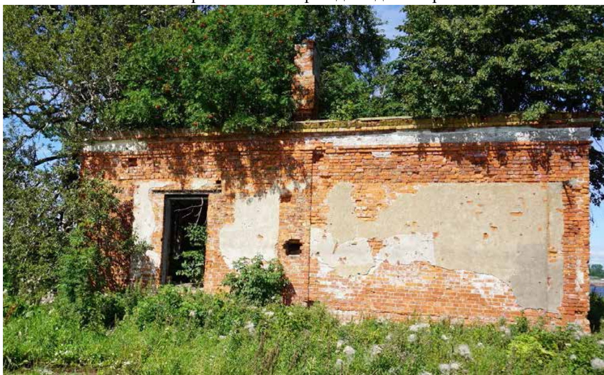
Фото 4. Юго-восточный фасад. Вид с юго-востока
