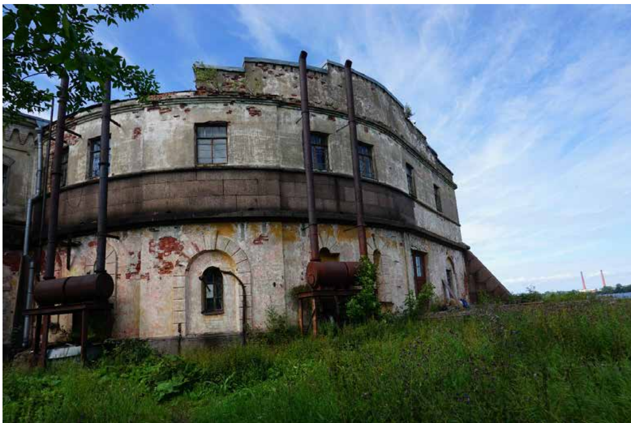
Фото 5. Юго-восточный фасад северного ризалита. Вид с юго-востока
