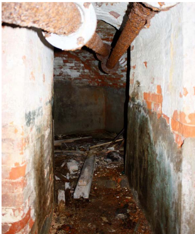
Фото 21. Подвал южного ризалита. Вид с юго-запада Первый этаж
