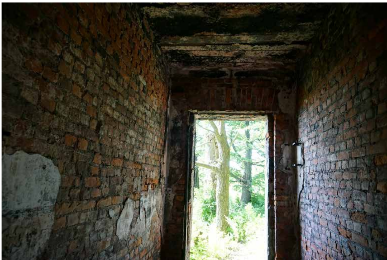
Фото 9. Помещения. Вид с северо-востока
