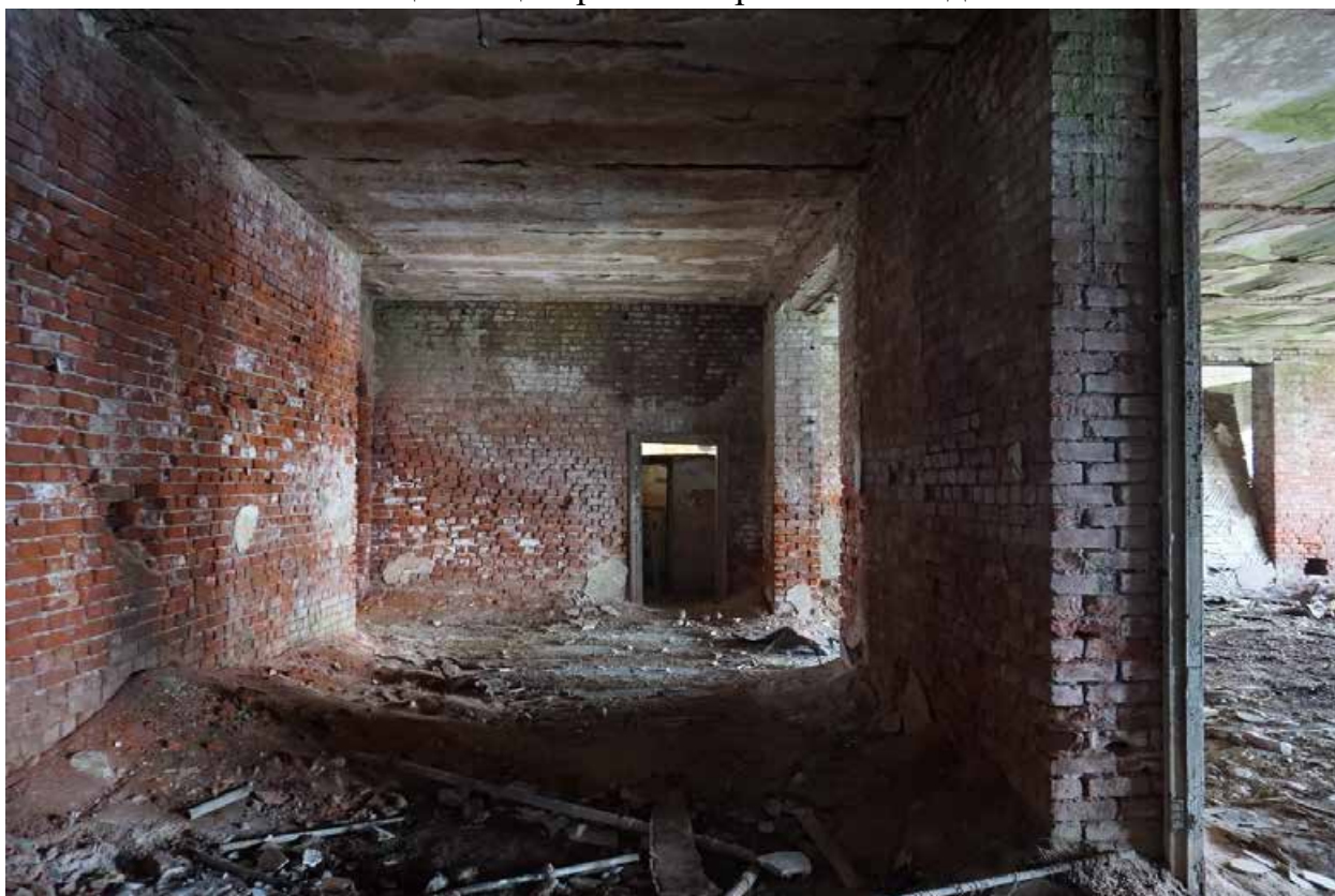
Фото 44. Помещения в центральной части основного объема. Вид с северо-востока
