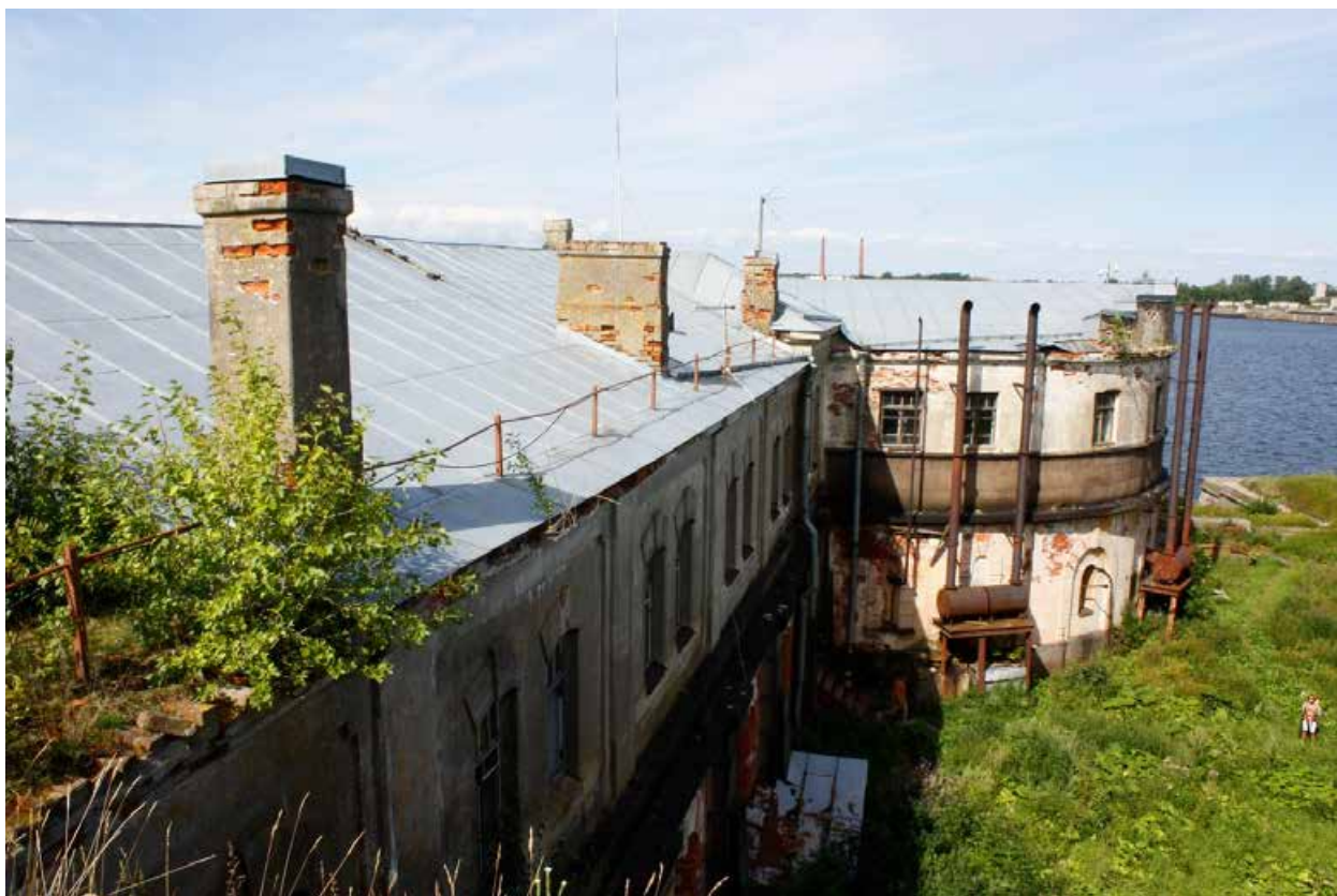
Фото 57. Крыша северной части центрального объема и северного ризалита. Вид с юга
