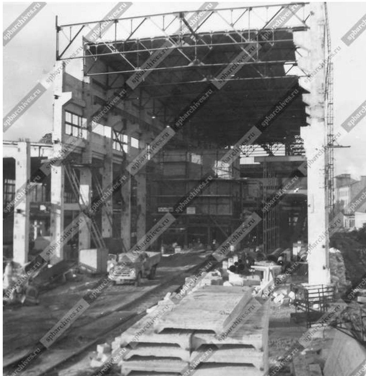
5. Строительство корпуса для котельной установки во время расширения эл. Станции. Дата съемки: 1977 г. // ЦГАКФФД СПб. Архивный шифр: Бр 73973.
