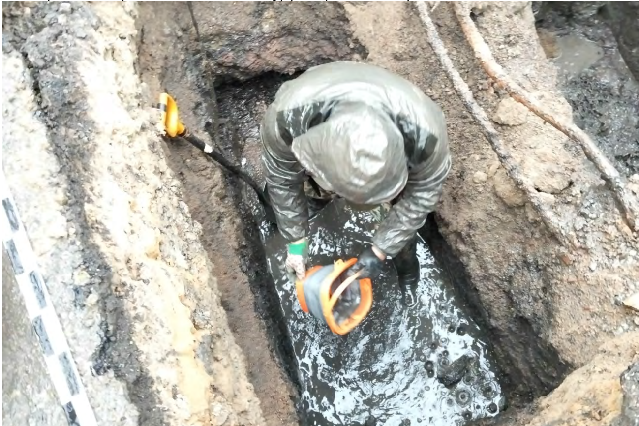
Рис. 31. Санкт-Петербург, Кузнецовская улица, дом 52, корпус 18, литера С, земельный участок с кадастровым номером: 78:14:0007622:5. Шурф 1. Откачка воды из шурфа. Рабочий момент. Вид с Ю.
