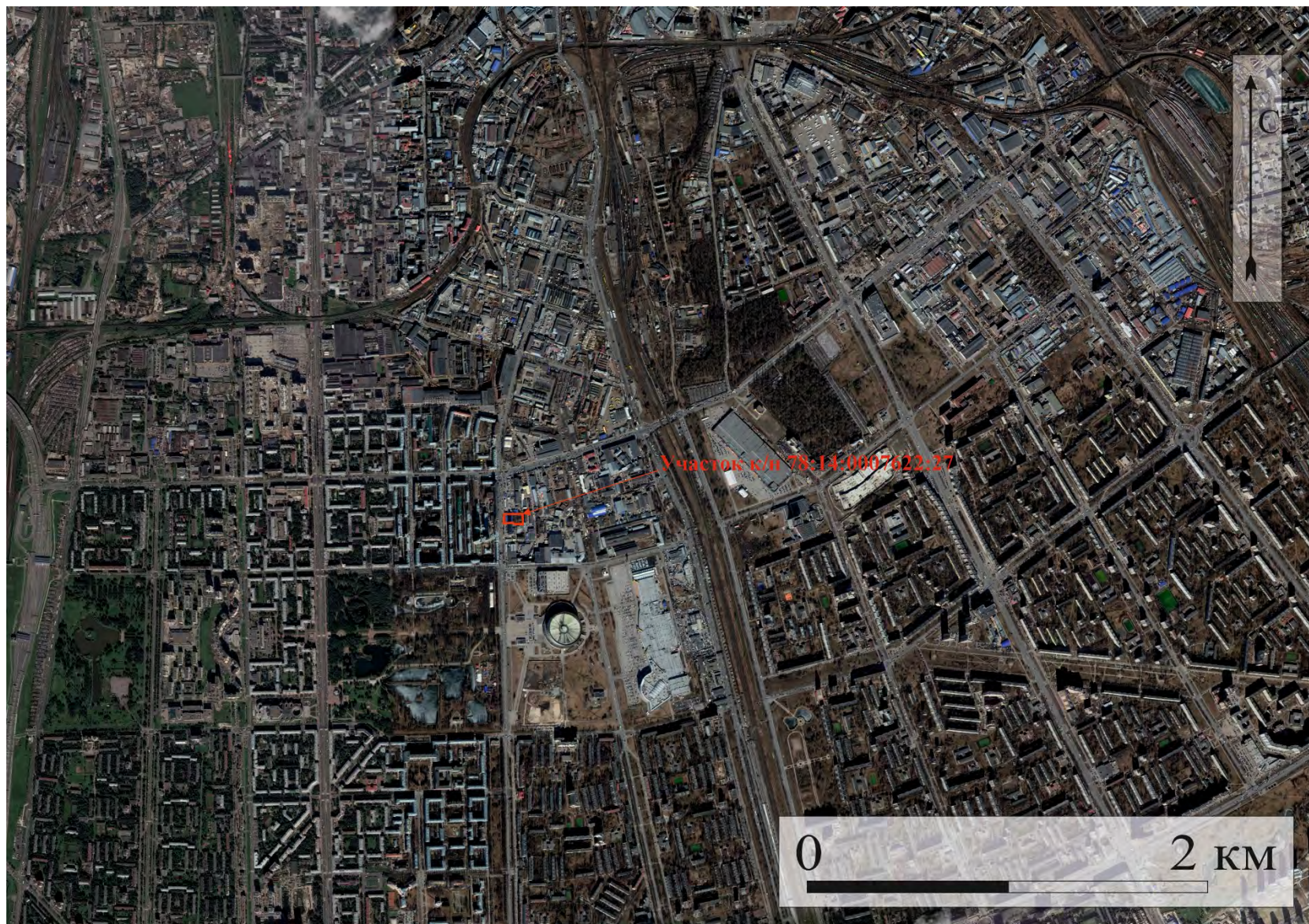
Рис. 4. Участок к/н 78:14:0007622:27 по адресу г. Санкт-Петербург, Кузнецовская улица, дом 52 на масштабированном космоснимке интернет ресурса Google Earth ( https://www.google.com/earth ). Дата обращения: 06.12.2025 г.
