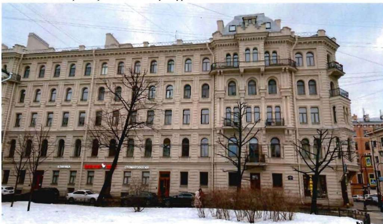
3. Вид на северный фасад объекта культурного наследия.
