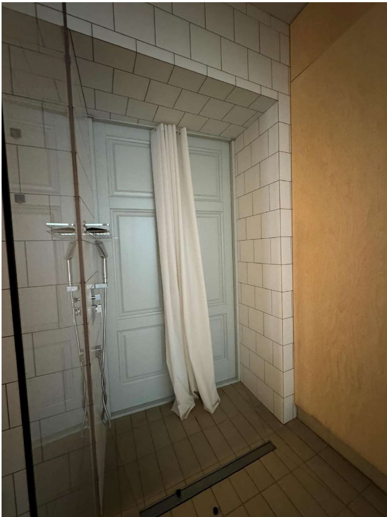
Фото 42. Интерьер помещения квартиры № 34 объекта культурного наследия.
