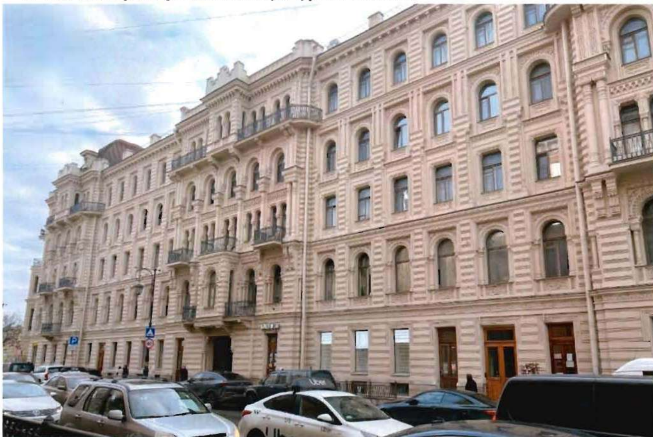
2. Вид на северный фасад объекта культурного наследия.
