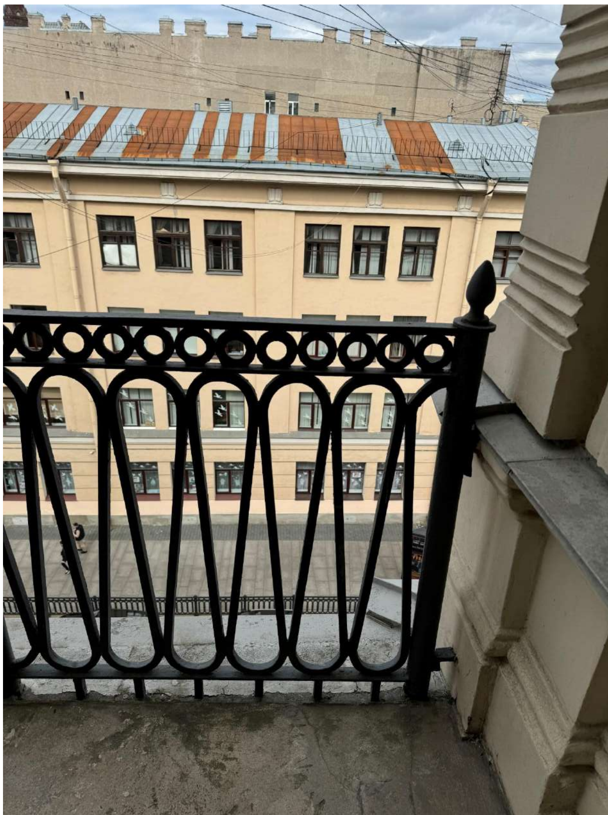
Фото 26. Восточный балкон квартиры № 34 объекта культурного наследия.
