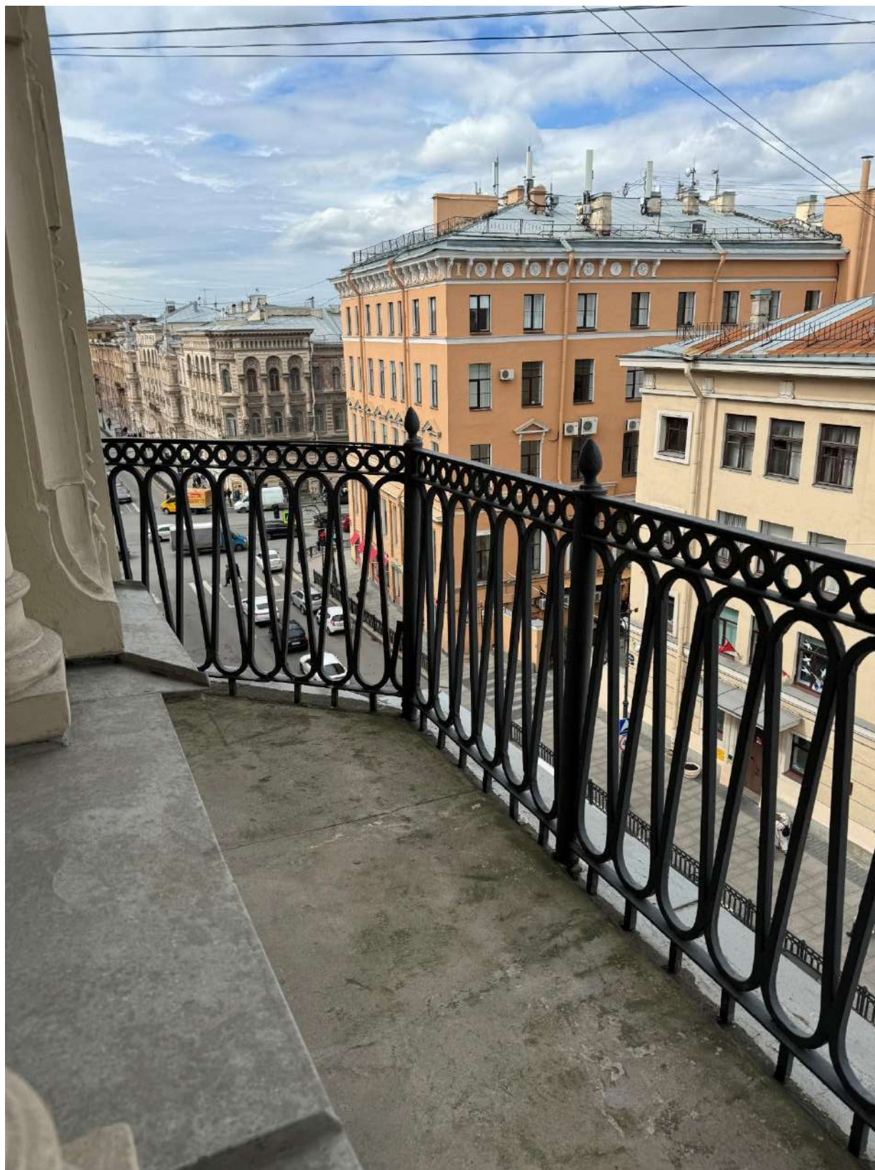
Фото 25. Восточный балкон квартиры № 34 объекта культурного наследия.
