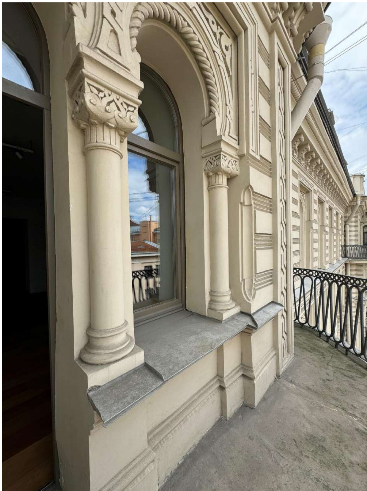
Фото 27. Восточный балкон квартиры № 34 объекта культурного наследия.
