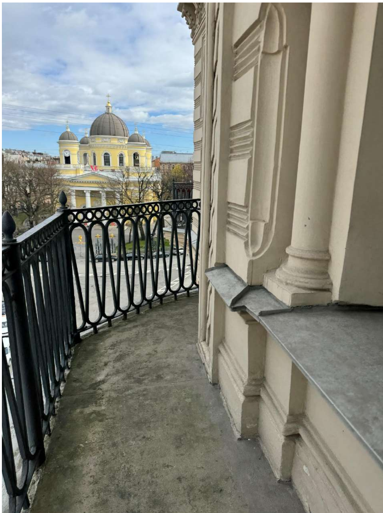
Фото 29. Западный балкон квартиры № 34 объекта культурного наследия.
