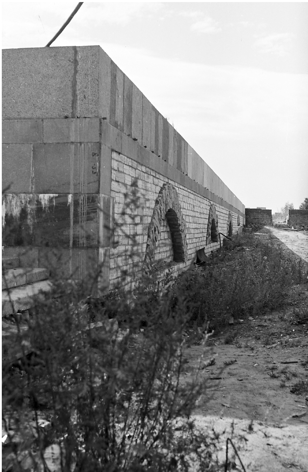
13. Оформление фасада подпорной стенки в сторону Большого пруда. 1959 // Архив ОАО «ЛенНИИПроект»
