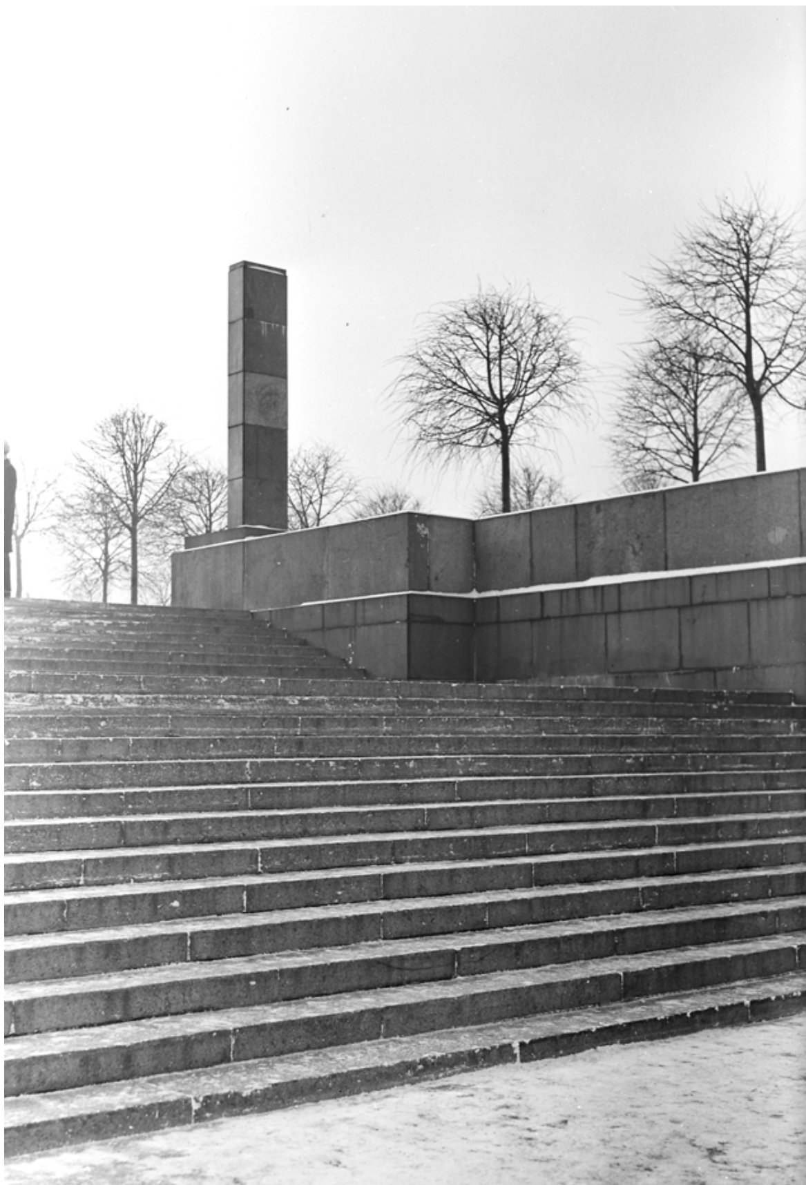
22. Подпорная стенка главной лестницы, завершающаяся обелиском. 1968 // Архив ОАО «ЛенНИИПроект»
