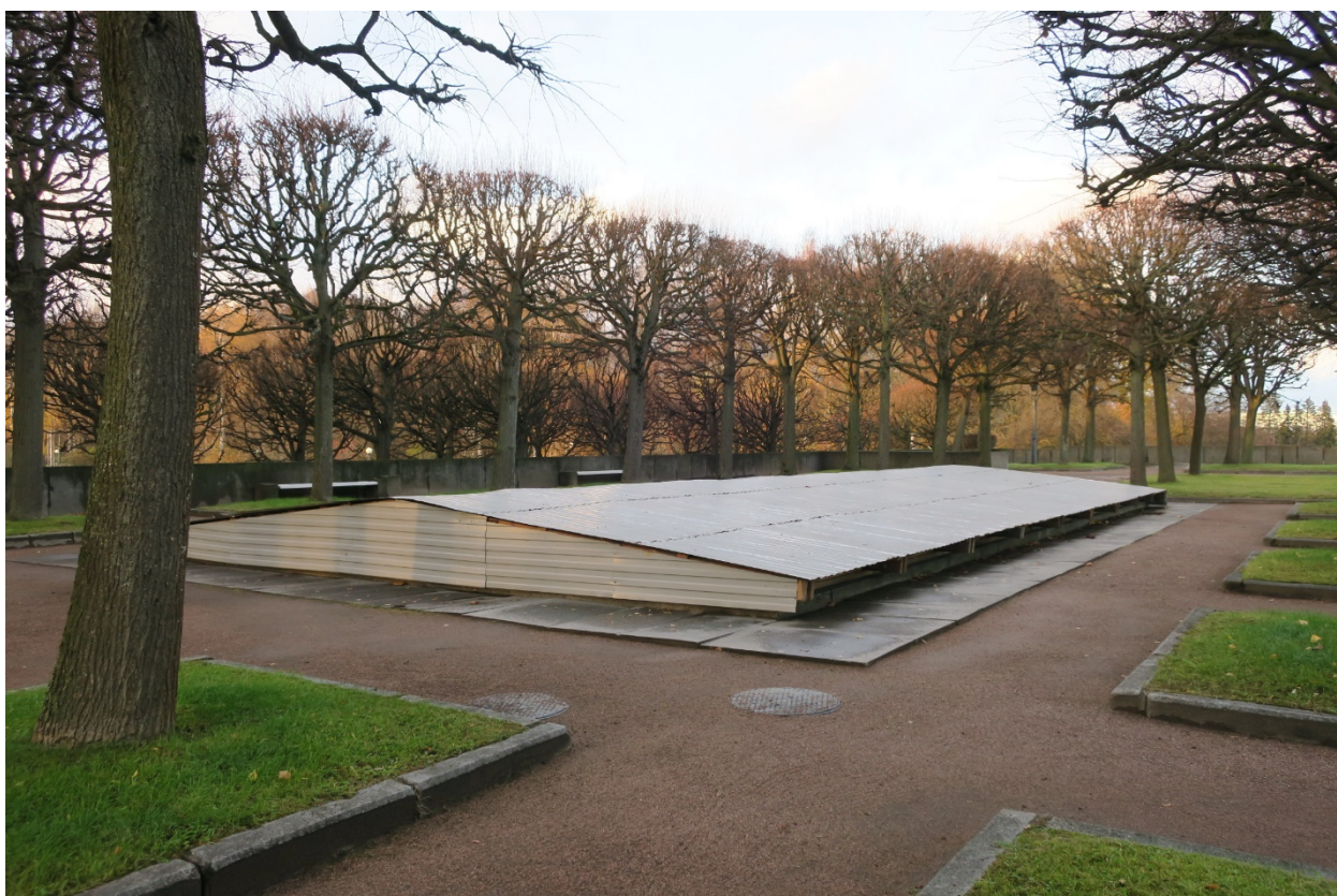
1. Мемориальный бассейн художественно-обособленного участка «Вечный огонь» объекта культурного наследия федерального значения «Кладбище Пискаревское», расположенного по адресу: г. Санкт-Петербург, пр. Непокоренных, д. 72 литера А. 15.10.2021
