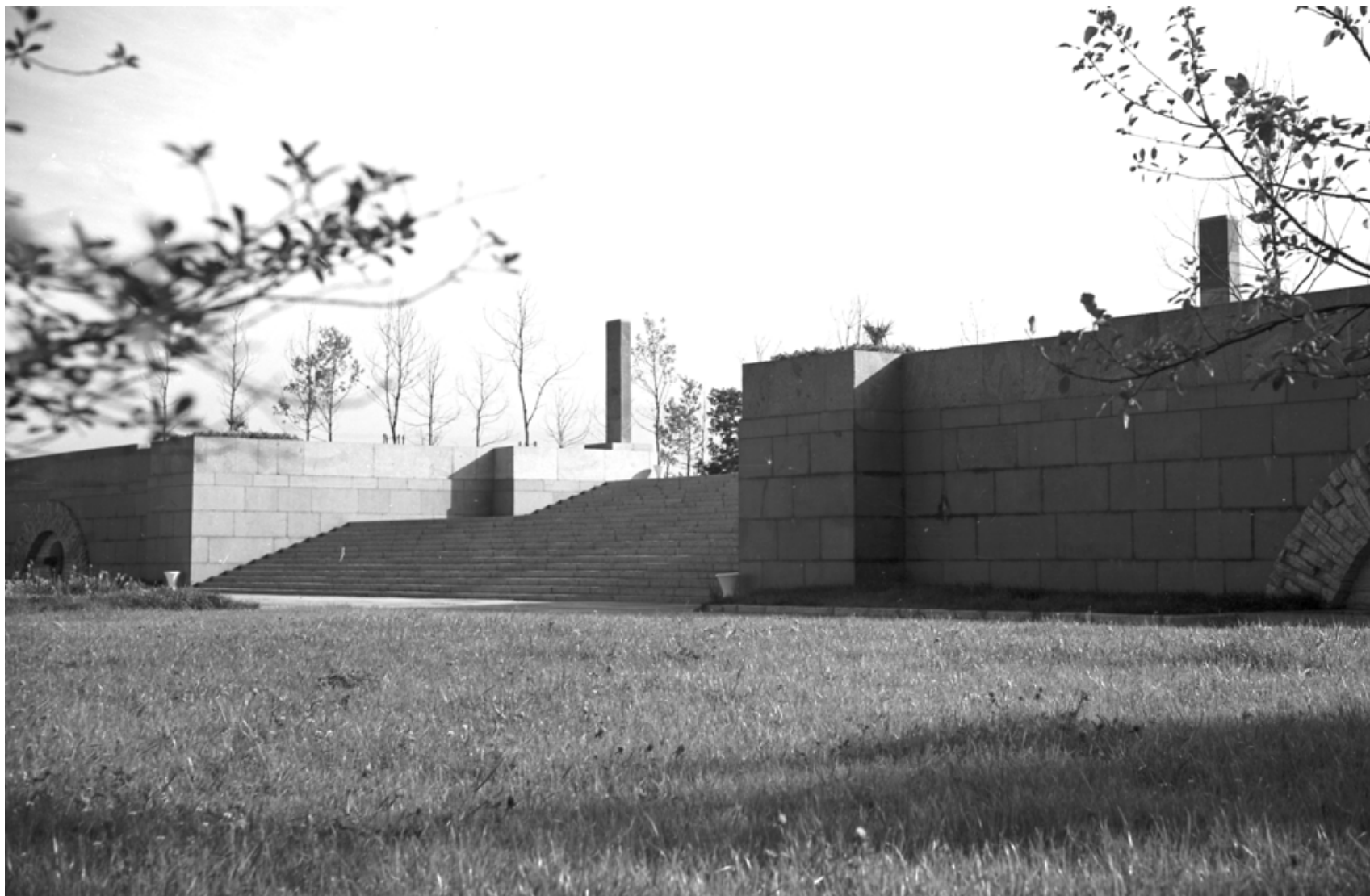
17. Главная лестница. Стенки с фонтанами «слезницы». 1960 // Архив ОАО «ЛенНИИПроект»
