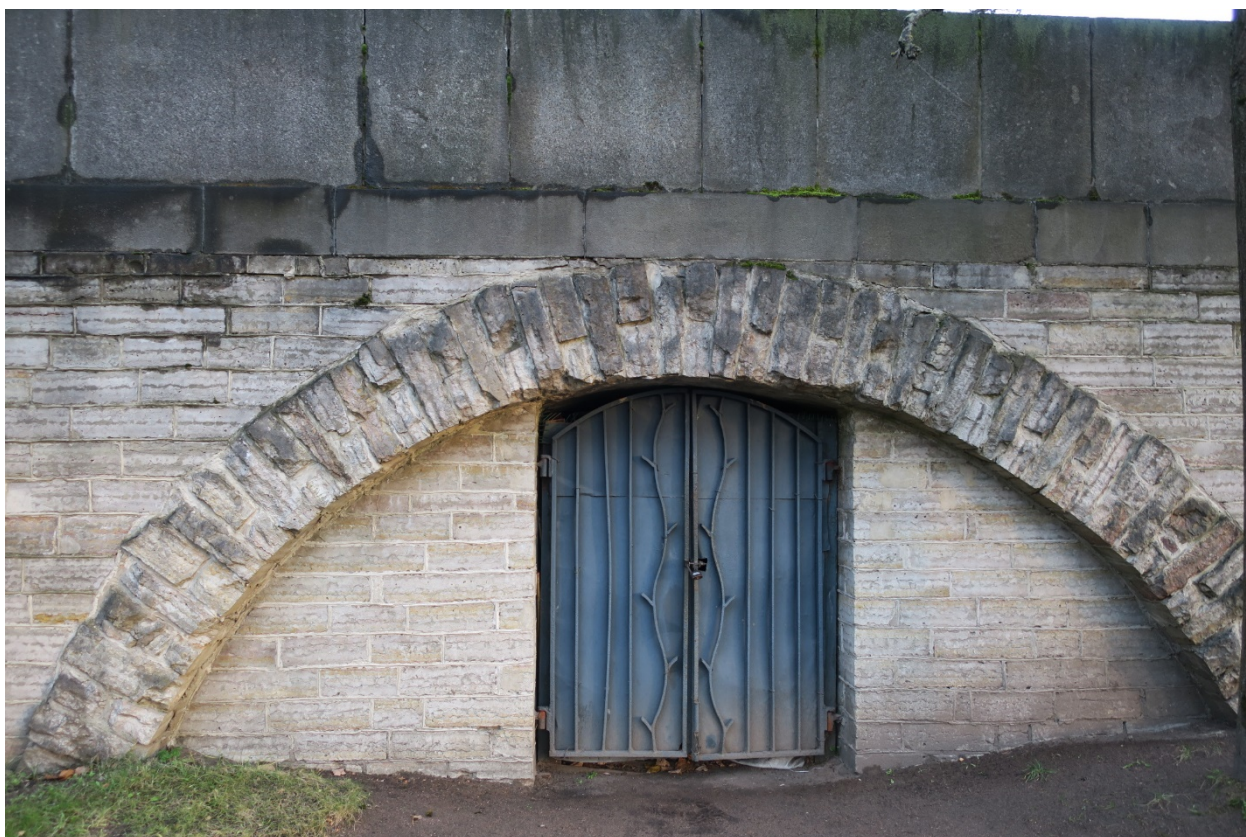
11. Западная подпорная стенка террасы художественно-обособленного участка «Вечный огонь» объекта культурного наследия федерального значения «Кладбище Пискаревское», расположенного по адресу: г. Санкт-Петербург, пр. Непокоренных, д. 72 литера А. Фрагмент. 15.10.2021
