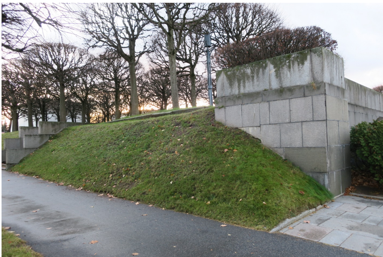
16. Восточная сторона террасы художественно-обособленного участка «Вечный огонь» объекта культурного наследия федерального значения «Кладбище Пискаревское», расположенного по адресу: г. Санкт-Петербург, пр. Непокоренных, д. 72 литера А. 15.10.2021
