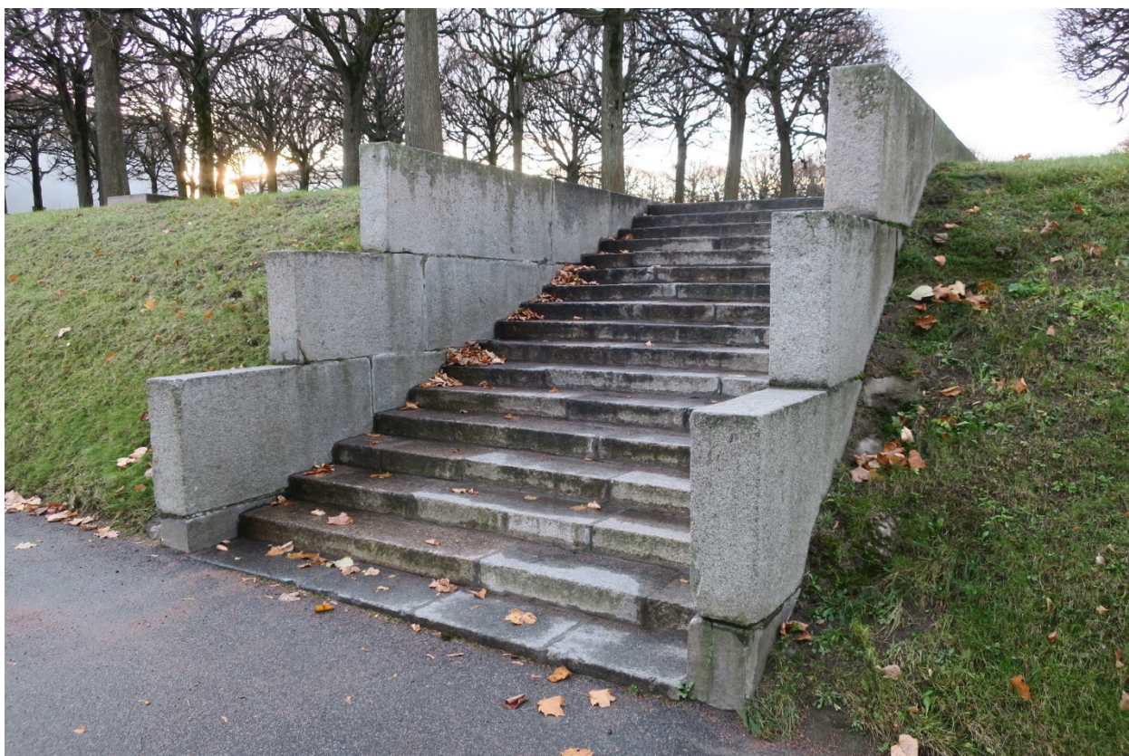
17. Лестница восточной стороны террасы художественно-обособленного участка «Вечный огонь» объекта культурного наследия федерального значения «Кладбище Пискаревское», расположенного по адресу: г. Санкт-Петербург, пр. Непокоренных, д. 72 литера А. 15.10.2021
