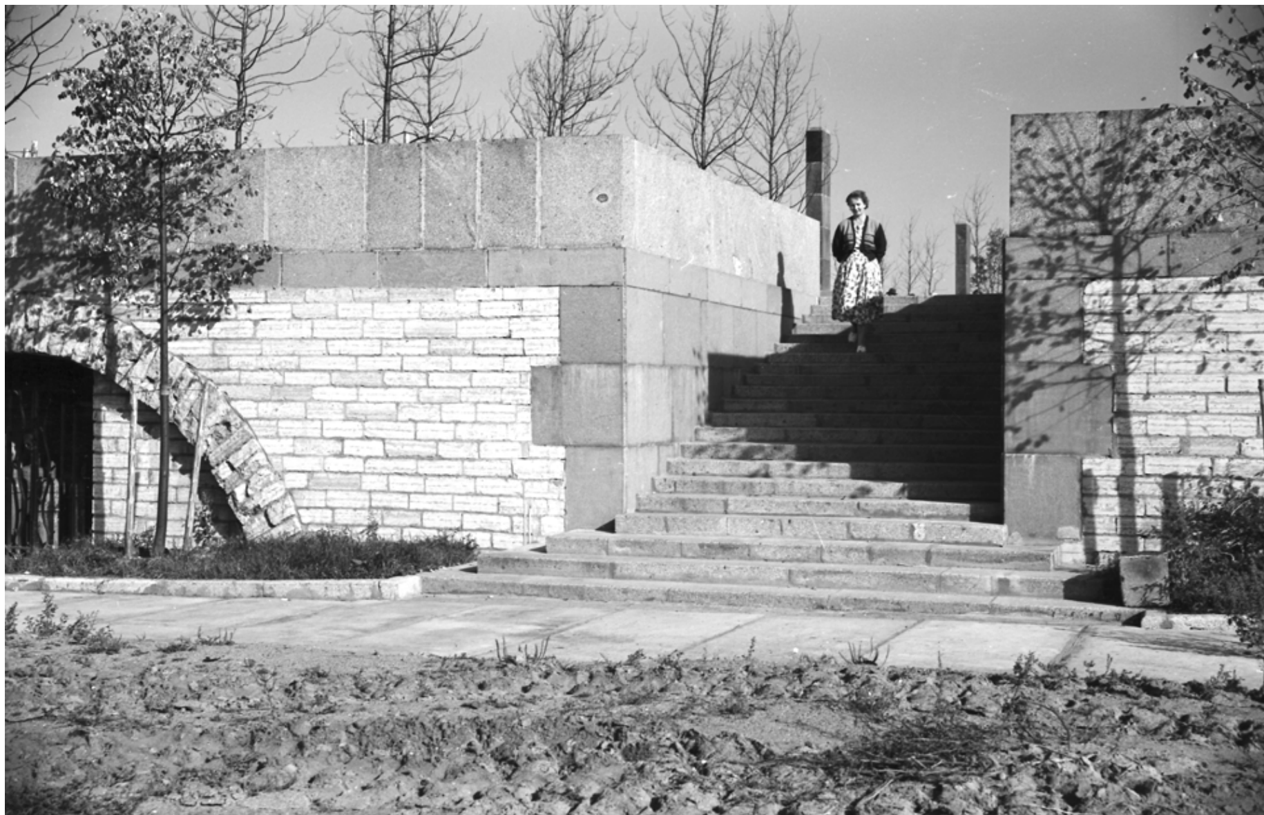
18. Главная лестница. Стенки с фонтанами «слезницы». 1960 // Архив ОАО «ЛенНИИПроект»
