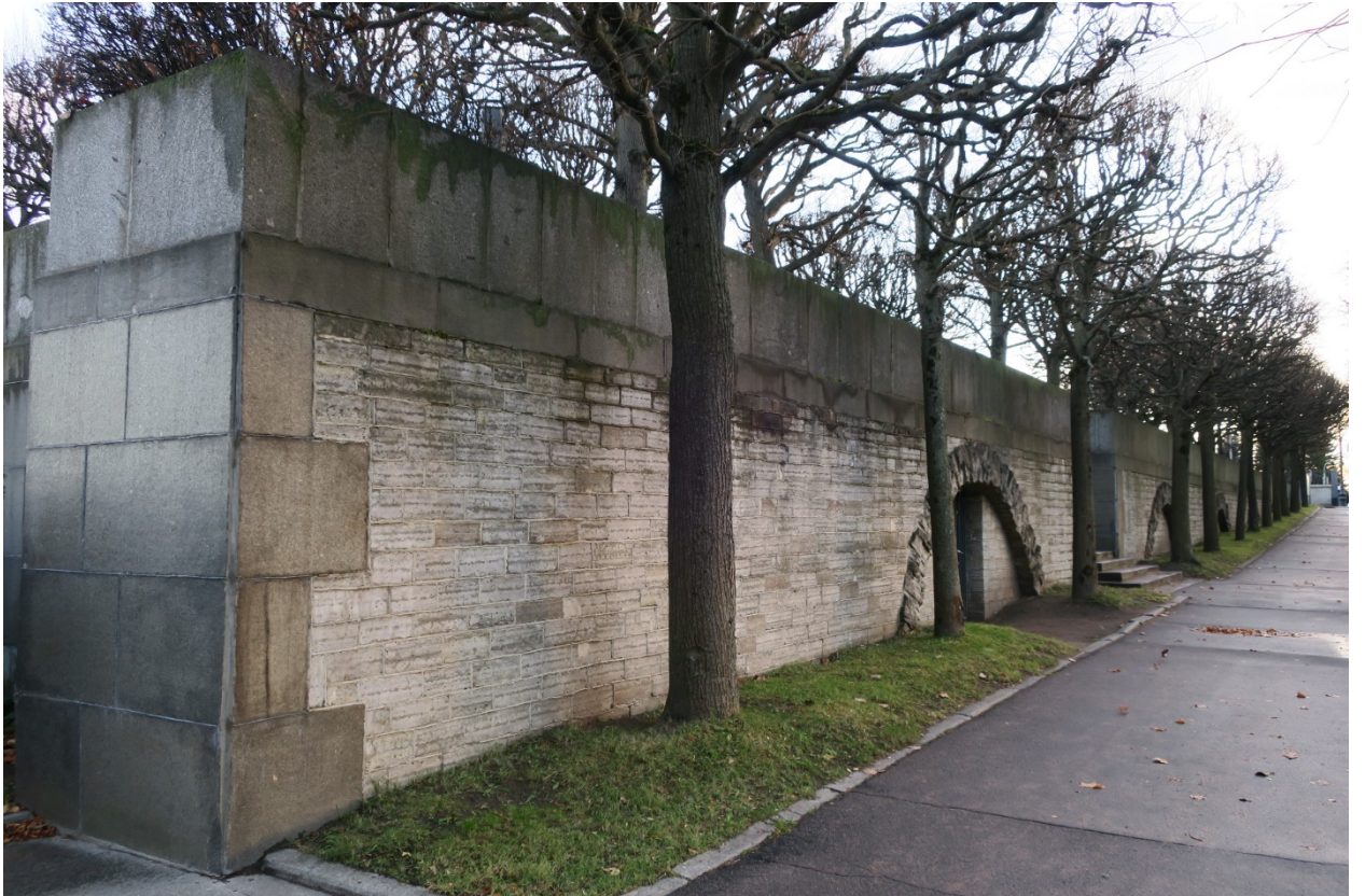
10. Западная подпорная стенка террасы художественно-обособленного участка «Вечный огонь» объекта культурного наследия федерального значения «Кладбище Пискаревское», расположенного по адресу: г. Санкт-Петербург, пр. Непокоренных, д. 72 литера А. 15.10.2021
