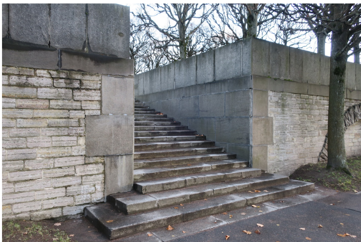
12. Боковая лестница западной подпорной стенки террасы художественно-обособленного участка «Вечный огонь» объекта культурного наследия федерального значения «Кладбище Пискаревское», расположенного по адресу: г. Санкт-Петербург, пр. Непокоренных, д. 72 литера А. 15.10.2021
