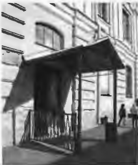
19. Оформление входа в здание корпуса по Таможенному переулку
