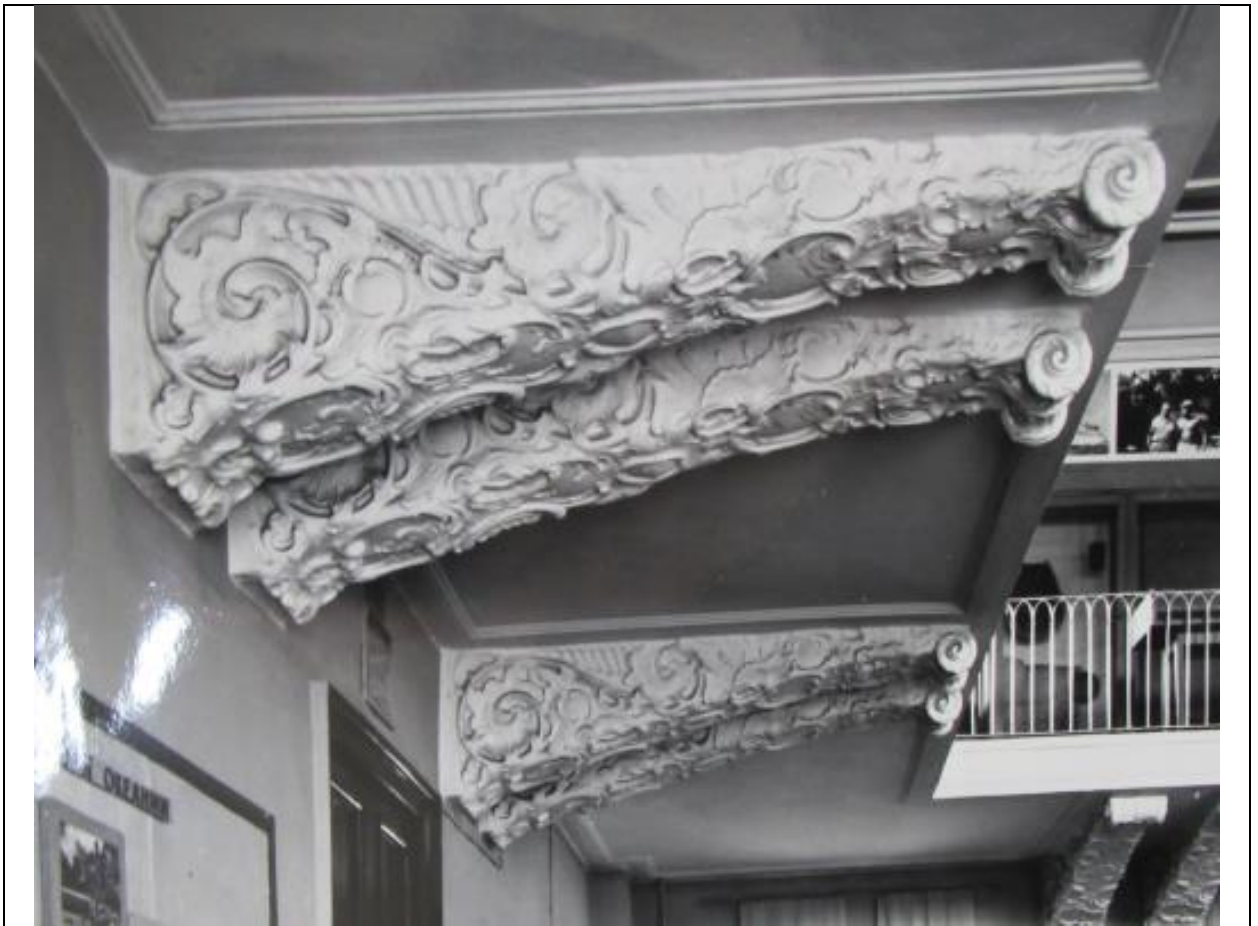
19. Консоли, поддерживающие галерею второго яруса двусветного зала восточной части здания, 2 этаж, фото 1981 г.
