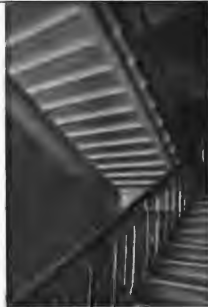
20. Фрагмент лестницы корпуса по Таможенному переулку
