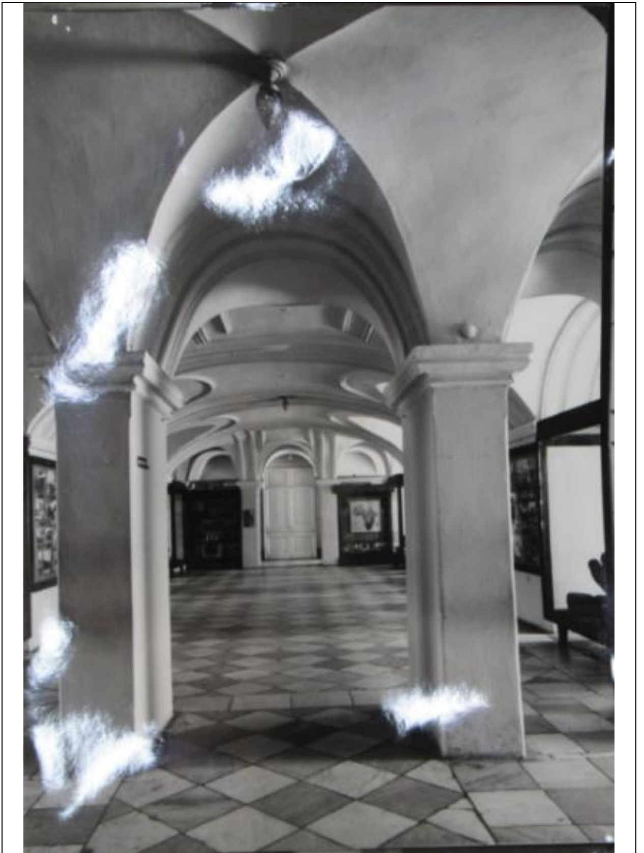
20. Большой прямоугольный зал восточной части здания, 1 этаж, фото 1981 г. Архив КГИОП, Паспорт объект культурного наследия «Здание Кунсткамеры».
