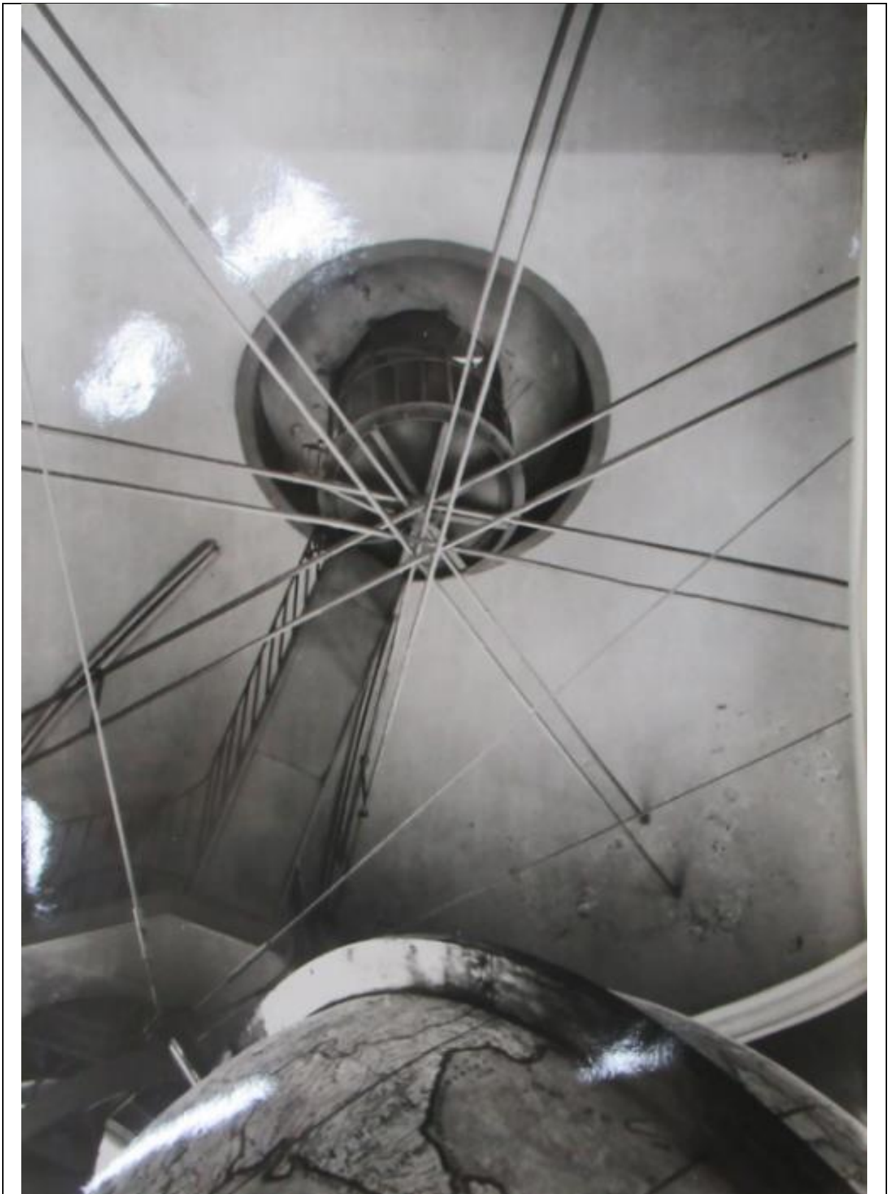
23. Переход в венчающую башенку из помещения третьего яруса башни, фото 1981 г. Архив КГИОП, Паспорт объект культурного наследия «Здание Кунсткамеры».
