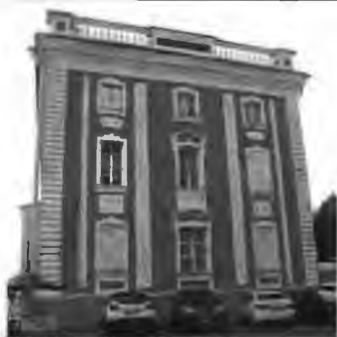
3. Восточный фасад корпуса по Университетской набережной
