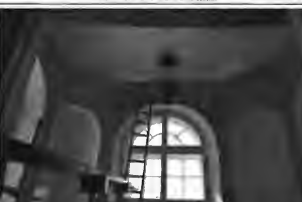
14. Фрагмент интерьера выставочного зала
