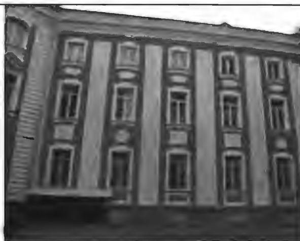
4. Фрагмент северного дворового фасада корпуса по Университетской набережной
