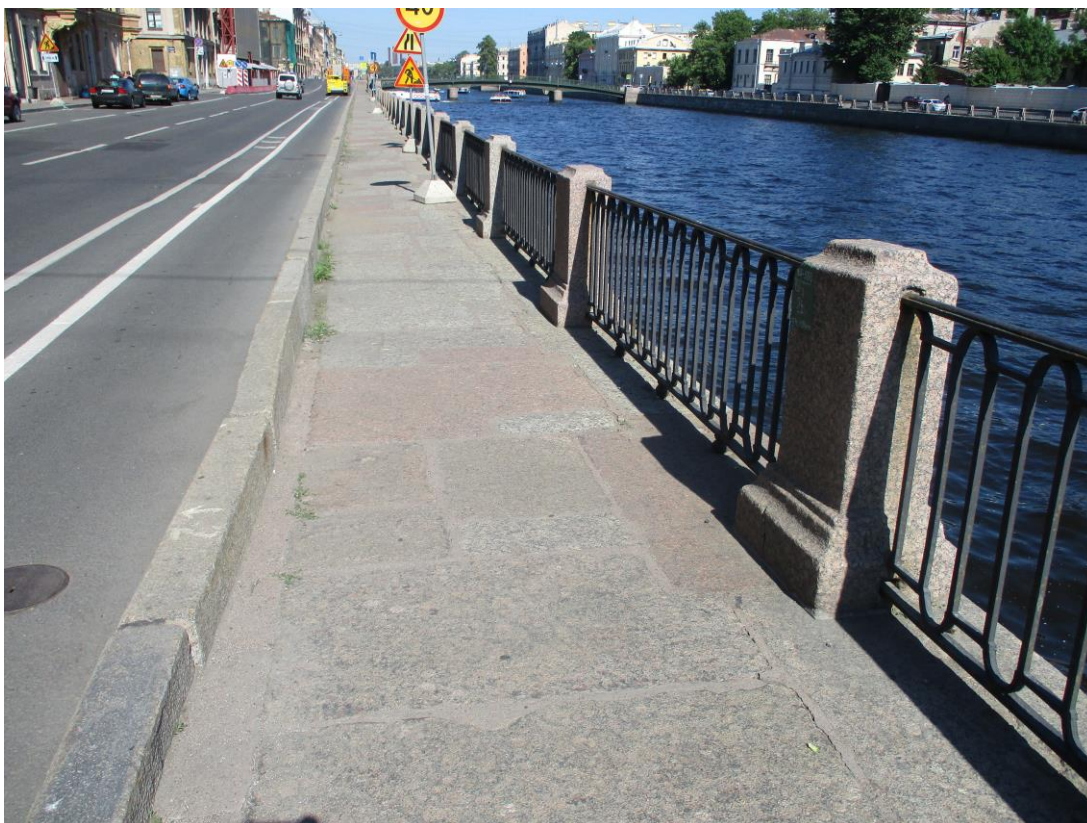
Фото 6. Гранитные плиты мощения и ограждение набережной из парапетных тумб и металлических звеньев между ними.
