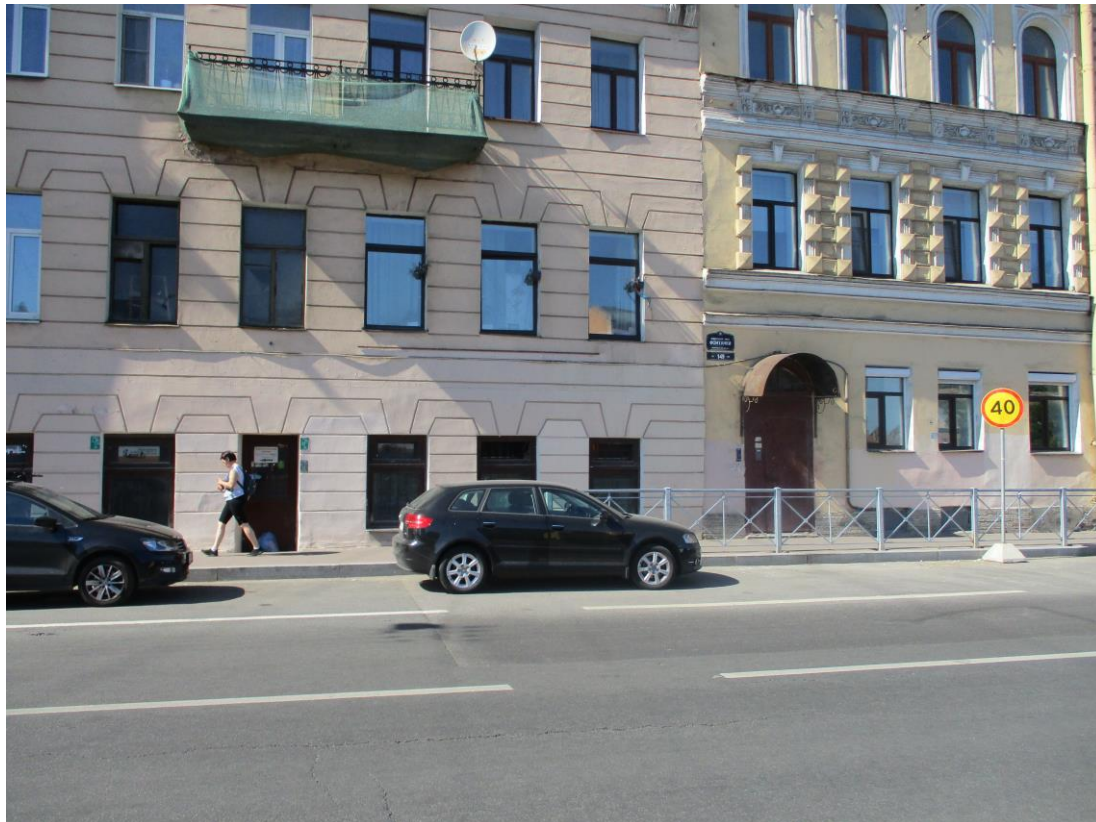
Фото 5. Вид на проезжую часть в зоне проведения предполагаемых работ и на здания, расположенные по адресу: наб. реки Фонтанки, дд.149-151.
