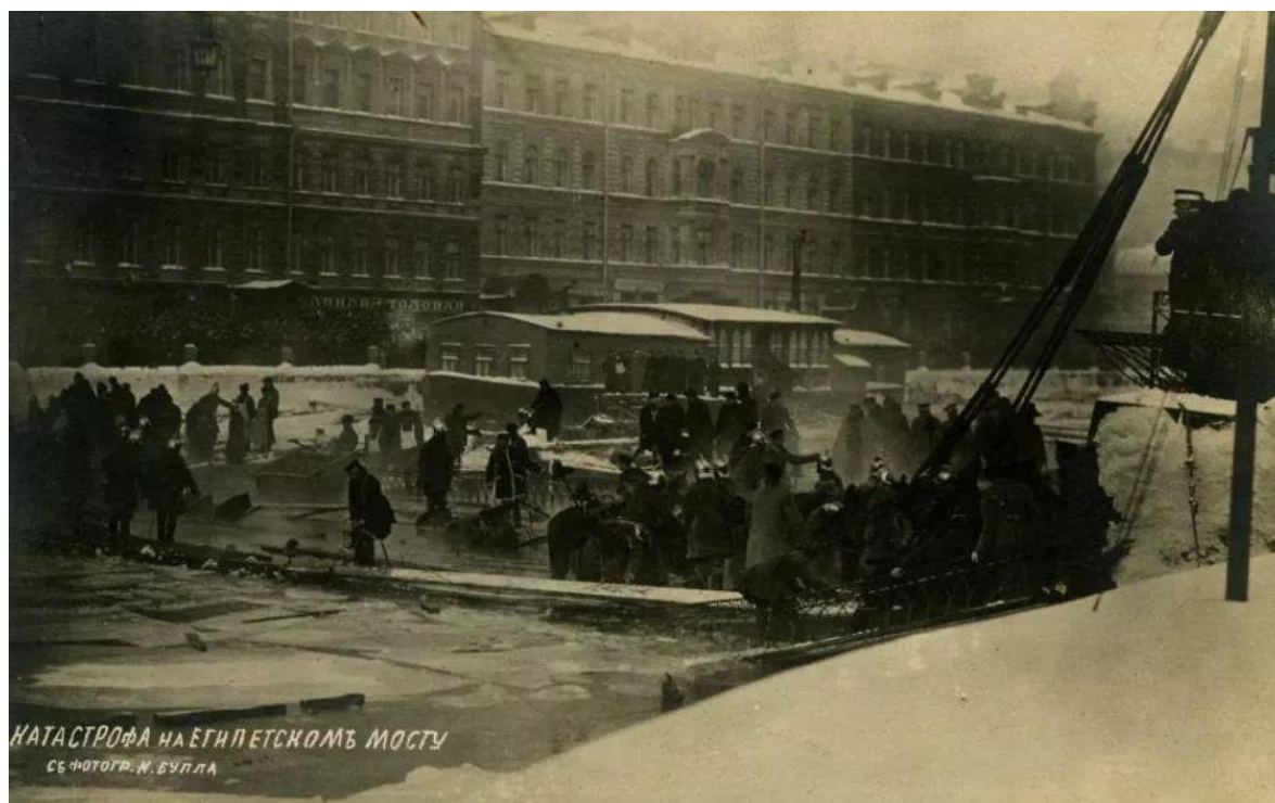
Рис. 7. Катастрофа на Египетском мосту. Фото 1905 г. ЦГАКФФД: Д 17309 (20 января 1905 г., фото ателье К.Буллы) размещено на Retro View of Mankind's Habitat [Электронный ресурс]. Режим доступа: https://pastvu.com/ .
