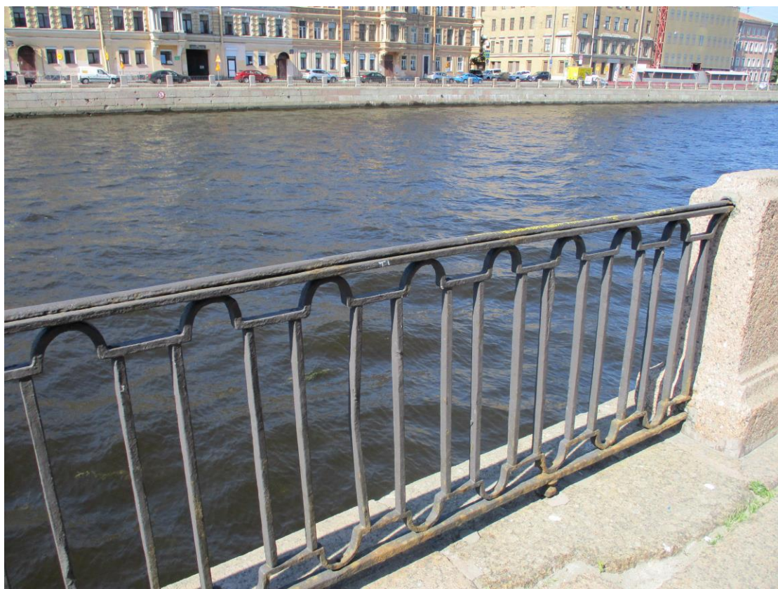
Фото 3. Ограждение набережной из парапетных тумб и металлических звеньев между ними.
