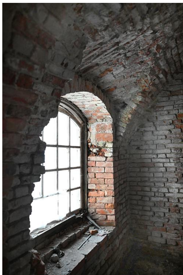
13. ОКН федерального значения «Бастин Зотов». Оконный проем каземата №1 под аппарелью. Распалубка свода и оконный откос. (17.07.2025 г.)
