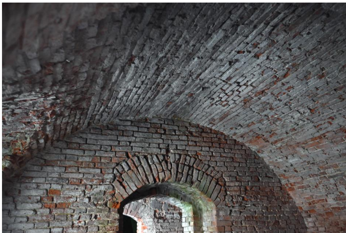
12. ОКН федерального значения «Бастион Зотов». Каземат №1. Перекрышка дверного проема. (17.07.2025 г.)
