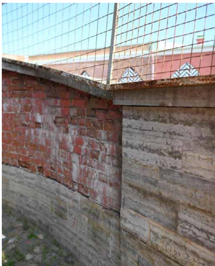
18. ОКН федерального значения «Бастион Зотов». Аппарель. Нижняя тумба южной стенки. (17.07.2025 г.)
