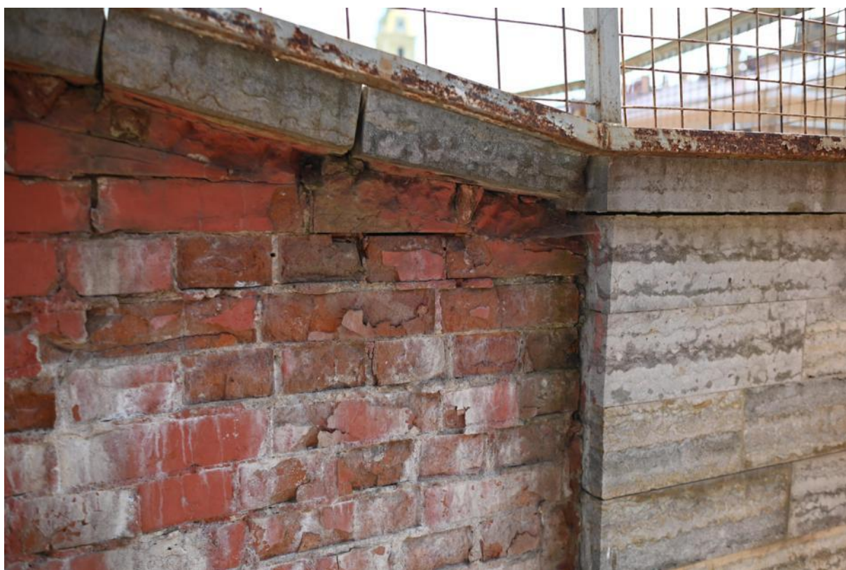
19. ОКН федерального значения «Бастион Зотов». Аппарель. Примыкание южной стенки аппарели к нижней тумбе. (17.07.2025 г.)
