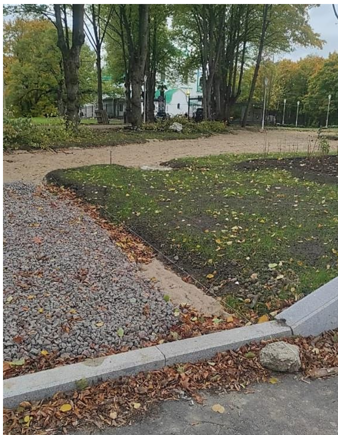
Фото 2. Вид на территорию прокладки сети.
