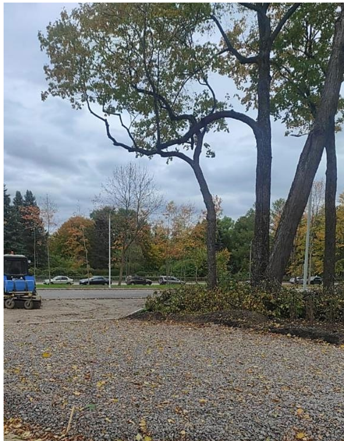
Фото 8. Вид на территорию прокладки сети.
