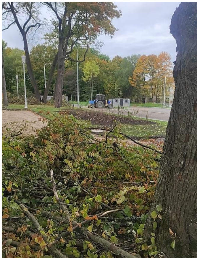
Фото 1. Вид участок подключения проектируемой сети к магистральной сети.
