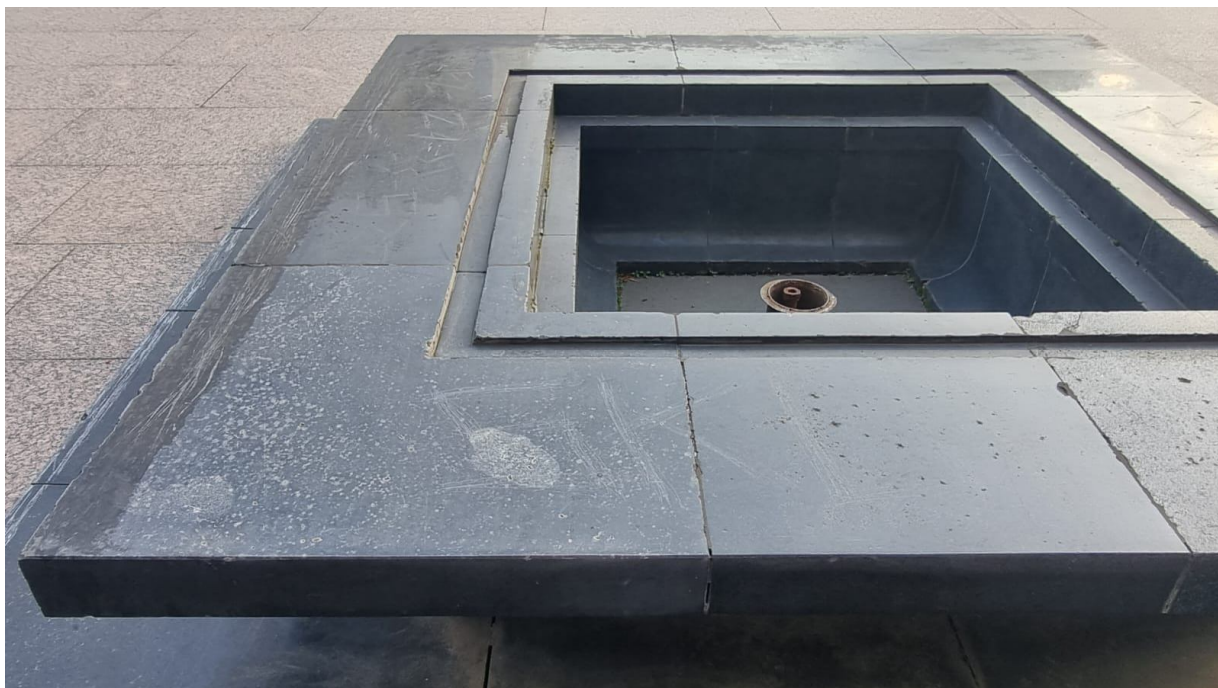
Фото 5. Дефекты полированной поверхности
