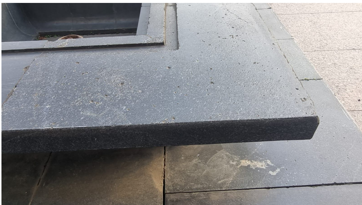
Фото 9. Дефекты полированной поверхности
