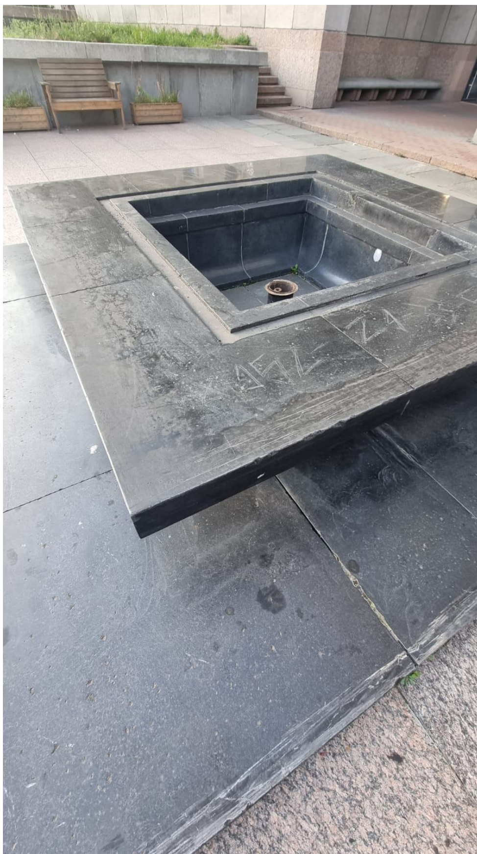
Фото 7. Дефекты полированной поверхности
