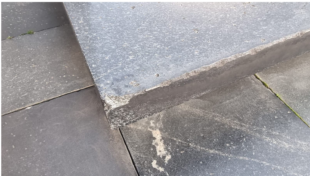
Фото 10. Дефекты полированной поверхности
