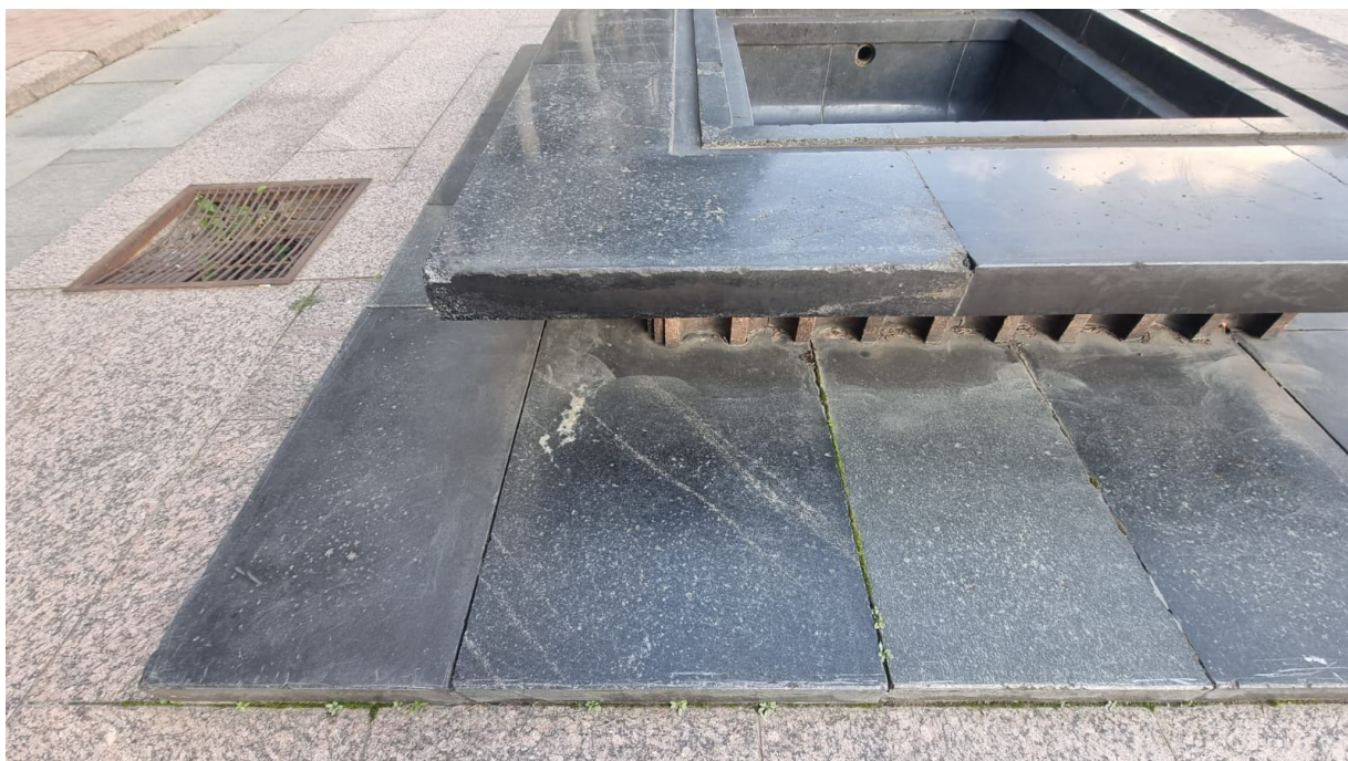
Фото 6. Дефекты полированной поверхности
