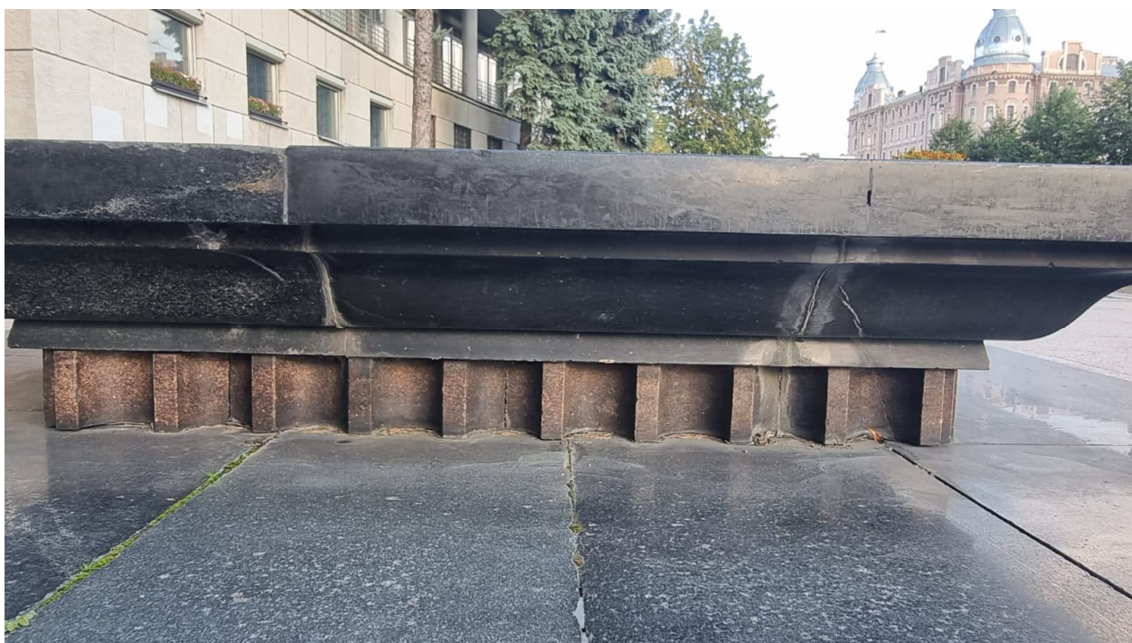
Фото 8. Дефекты полированной поверхности
