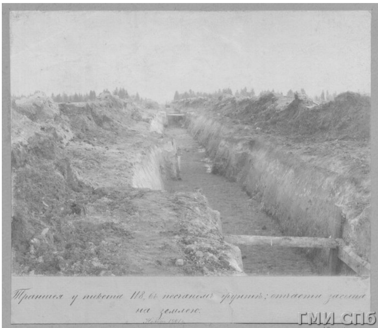
Илл. 21. Траншея у пикета 118 в песчаном грунте. Снимок из комплекта "Работы по кооптажу Демидовских ключей и устройству Таицкого водопровода". Фото 1901 г. СПбГБУК «Государственный музей истории Санкт-Петербурга».
