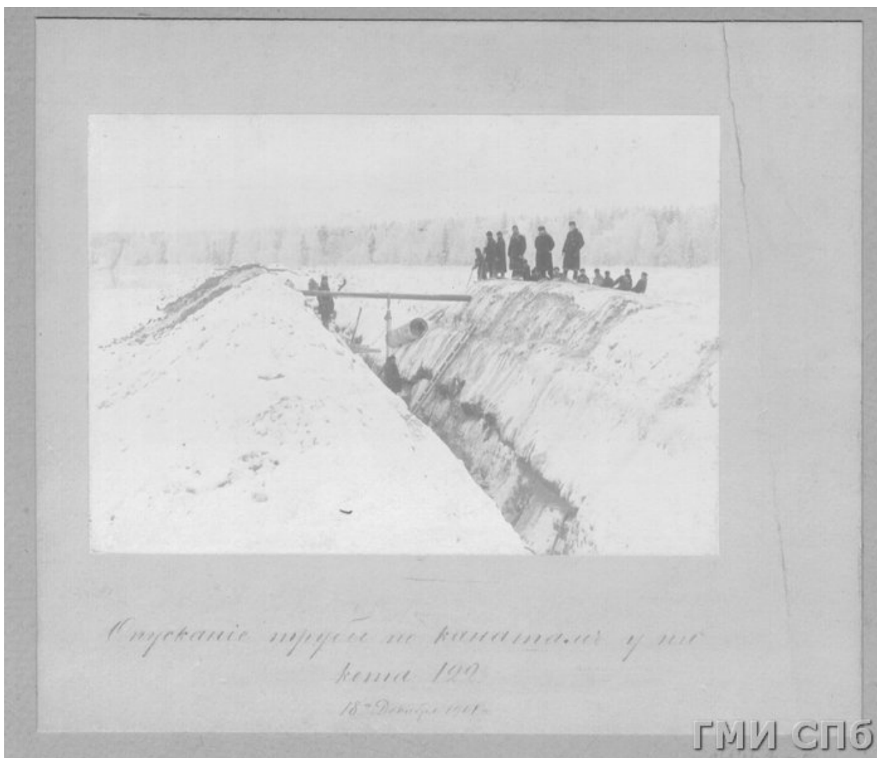
Илл. 22. Опускание трубы по канатам у пикета 122. Снимок из комплекта "Работы по кооптажу Демидовских ключей и устройству Таицкого водопровода". Фото 1901 г.
