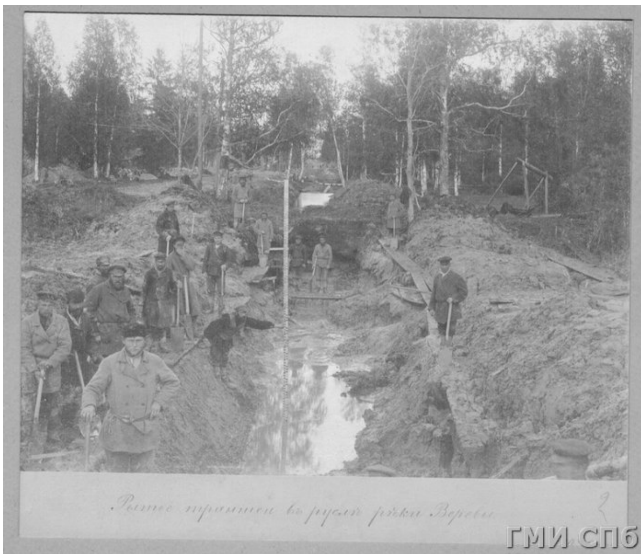
Илл. 23. Рытье траншеи в русле реки Верева. Снимок из комплекта "Работы по кооптажу Демидовских ключей и устройству Таицкого водопровода". Фото 1901-1902 гг.
