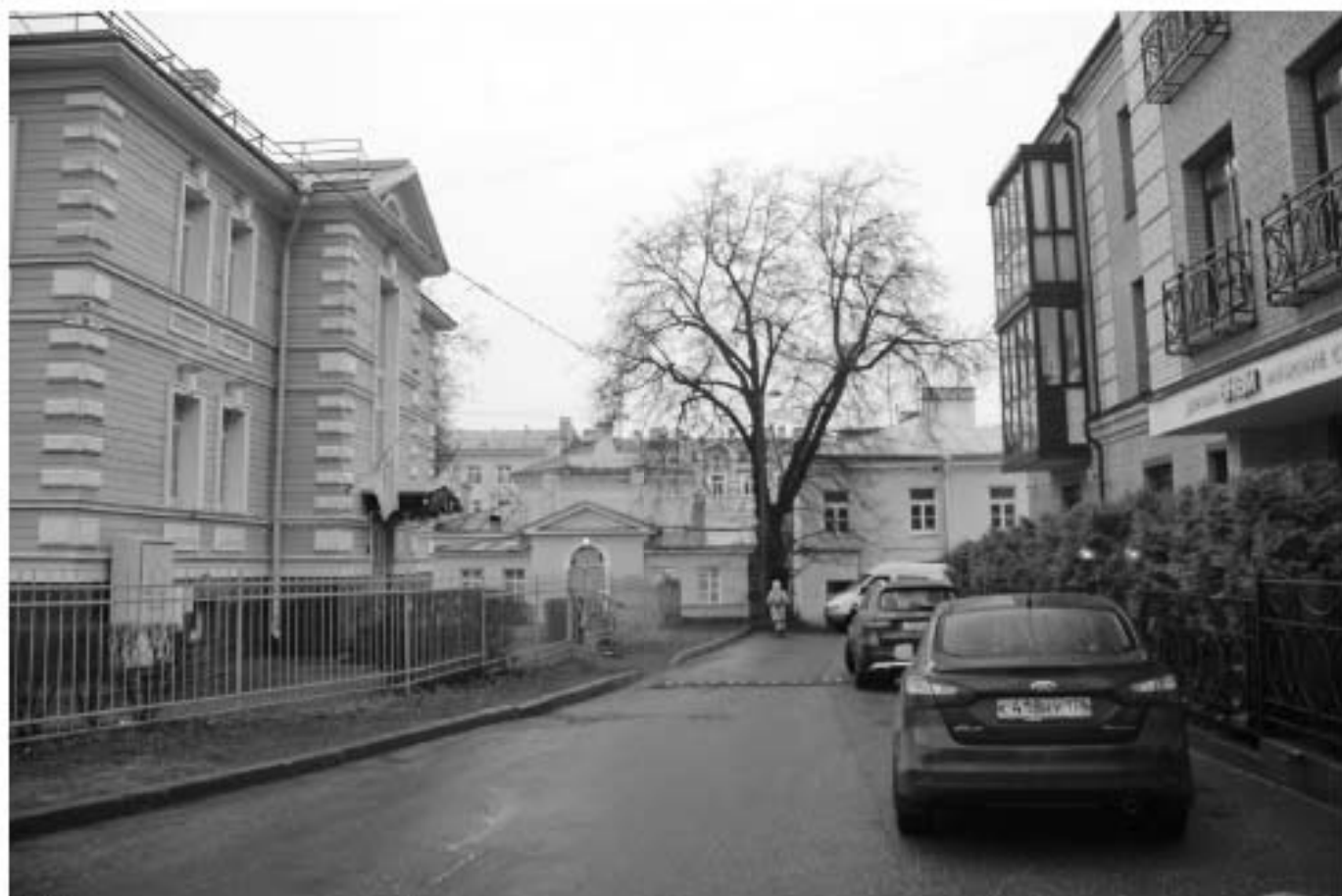
7 ОGN регионального значения «Городовая ратуша» Санкт-Петербург, г. Пушкин, Московская ул., д. 33, литера А Вид на северо-восток вдоль юго-восточной границы территории ОGN Дата съемки: 16.12.2025 г.
