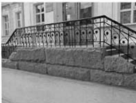
3. Крыльцо центрального входа
