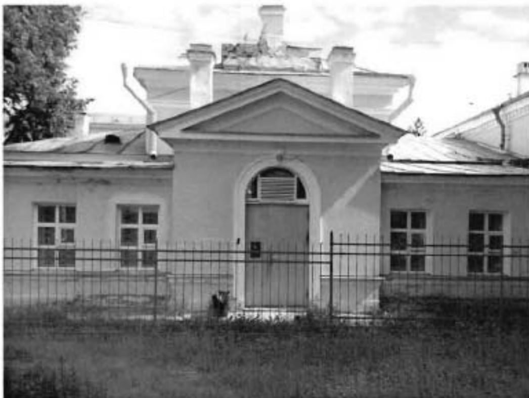
2. Южный фасад здания.
