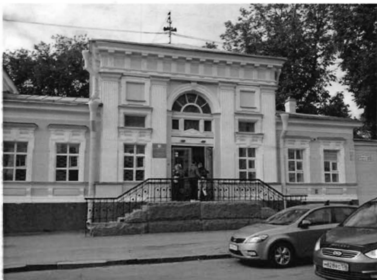
1. Северный фасад здания.
