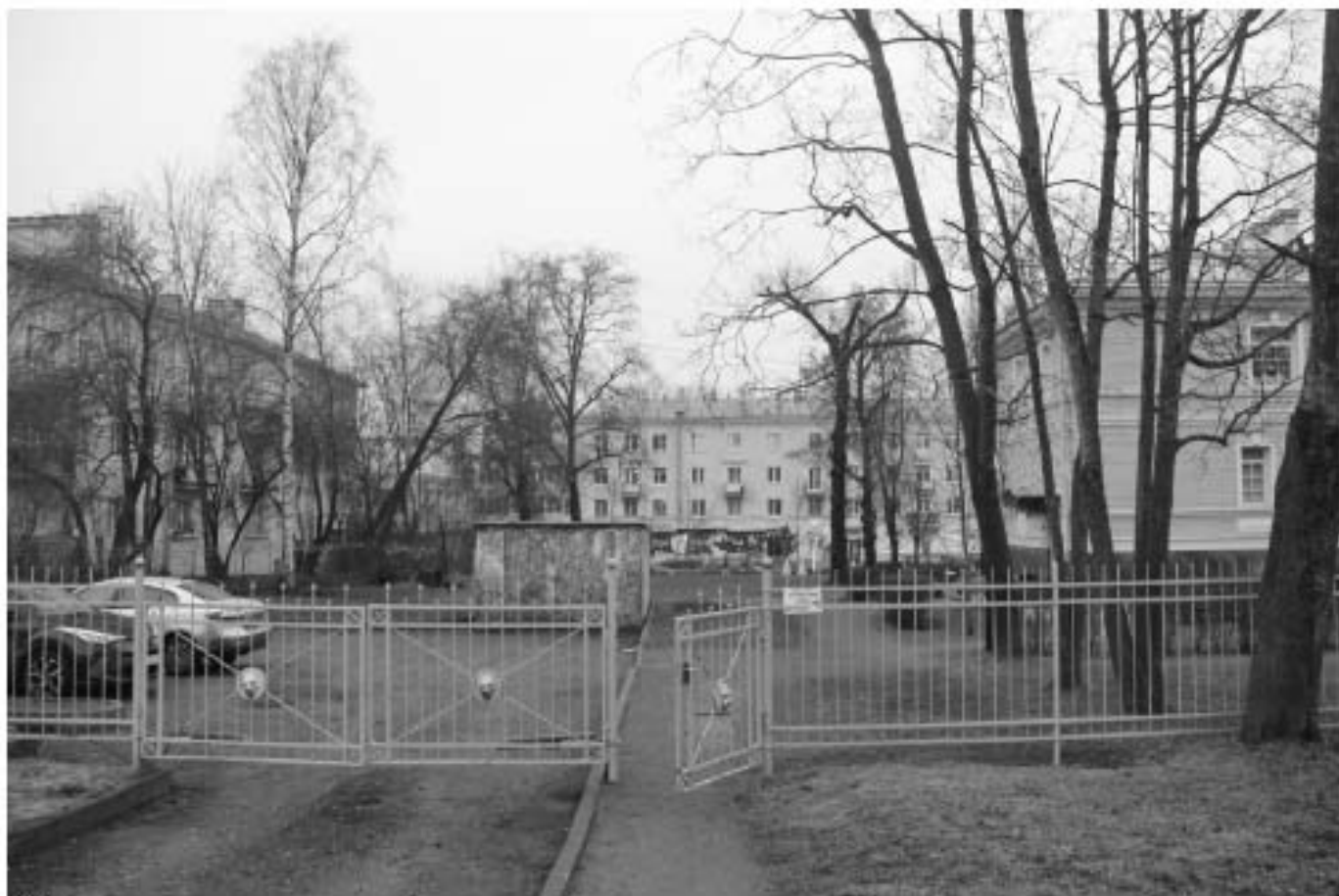
11 ОКН регионального значения «Городовая ратуша» Санкт-Петербург, г. Пушкин, Московская ул., д. 33, литера А Вид на северо-восток на юго-западный угол границы территории ОКН Дата съемки: 16.12.2025 г.
