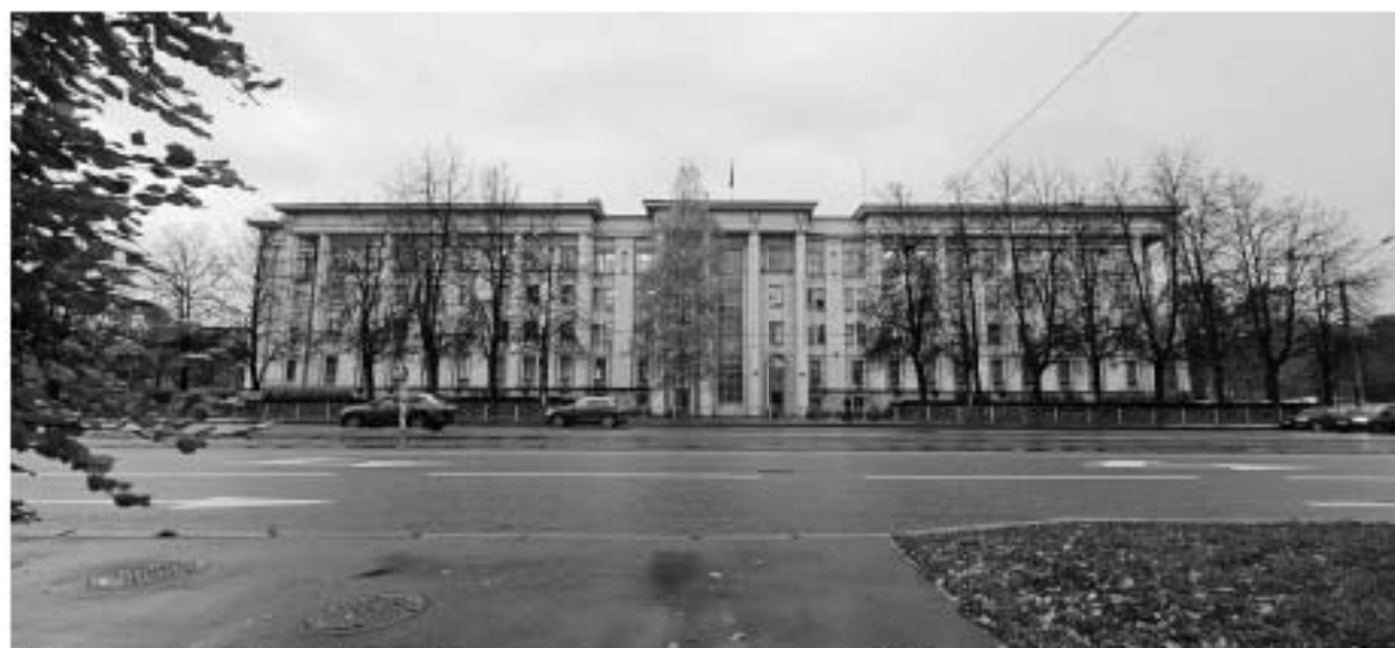
1. Общий вид объекта со стороны проспекта Обуховской Обороны. Главный (восточный) фасад.
