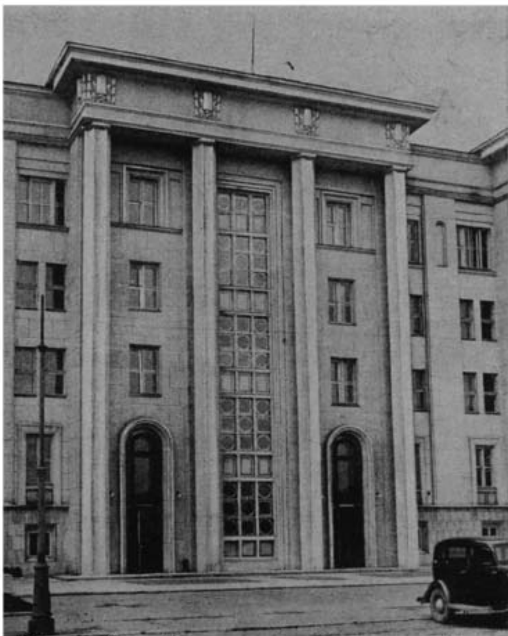
44. Восточный фасад (фасад на набережную) Володарского райсовета. Воспроизводится по изданию: Архитектура Ленинграда. 1940. №5. С.39.
