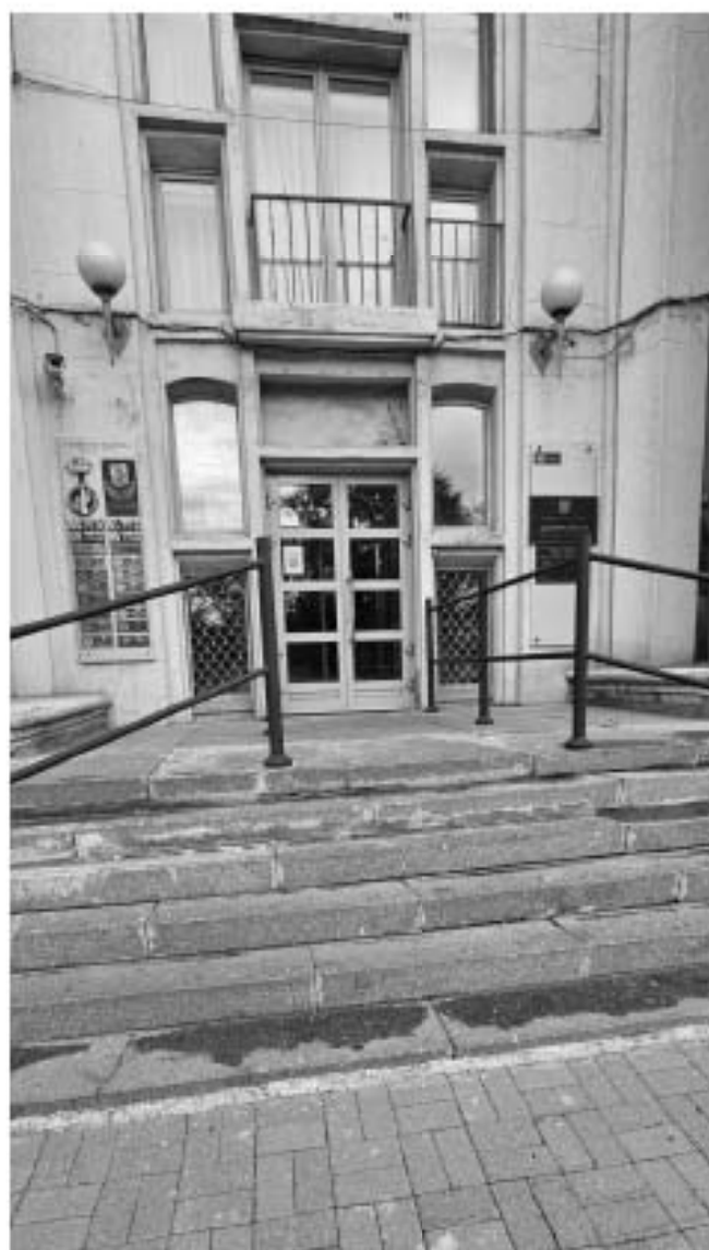
10. Фрагмент южного фасада. Главный вход.
