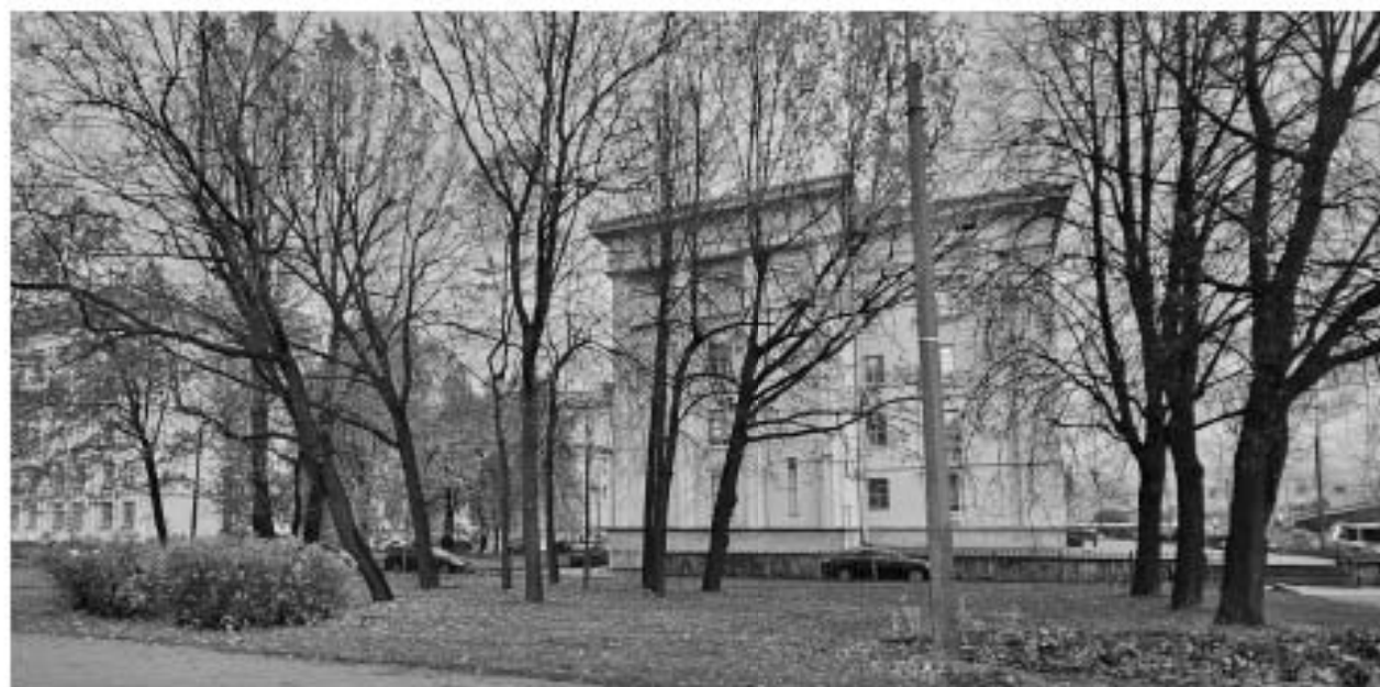
12. Общий вид объекта с запада. Дворовые фасады.
