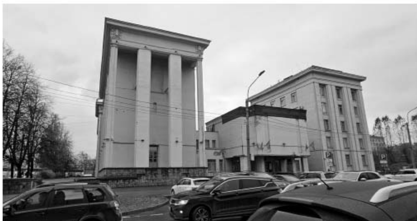
6. Северный фасад объекта и примыкающего к нему с запада позднего объема (Пр. Обуховской Обороны, д.163, лит.Б).
