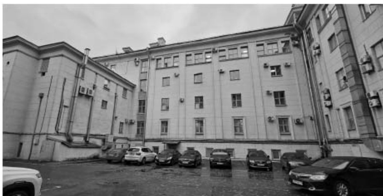
14. Фрагмент восточного фасада.
