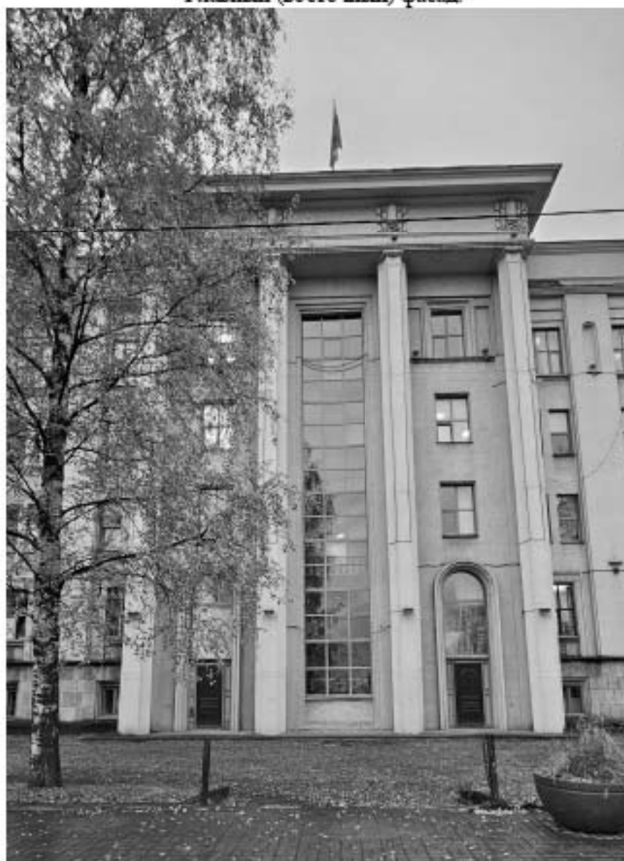
2. Центральная часть главного фасада.
