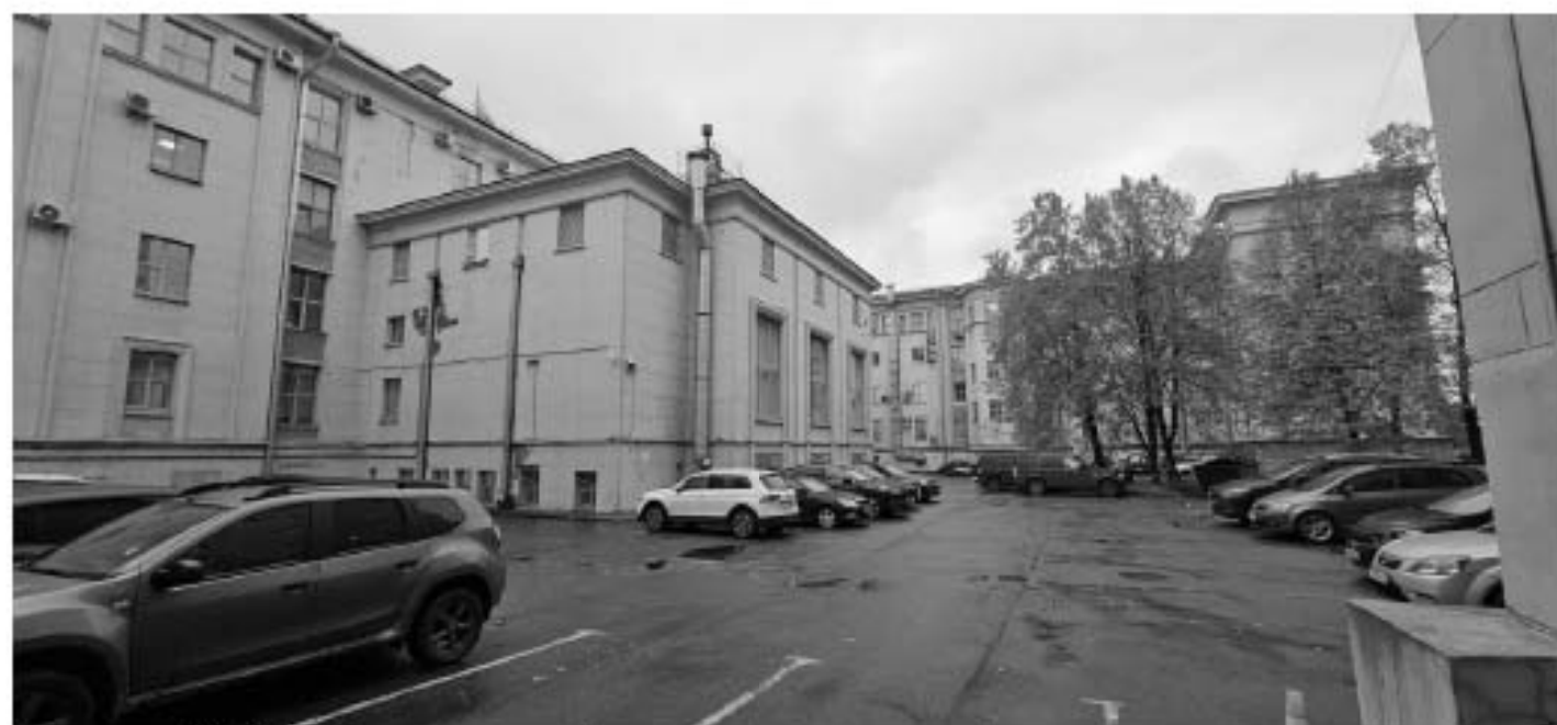
18. Общий вид дворовых фасадов и внутридворового пространства.
