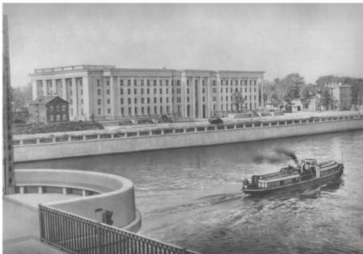
38. Вид здания Володарского райсовета с Володарского моста. Из книги: Архитектура СССР 1920-1940 гг.: Альбом. М. 1940.
