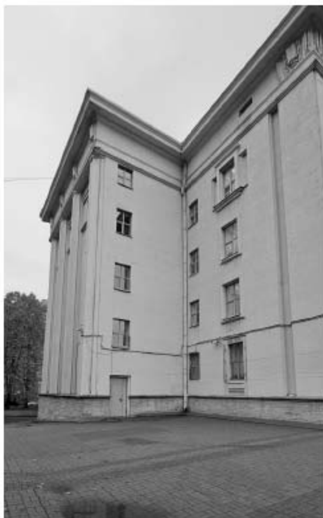
11. Фрагмент южного Фасада.
