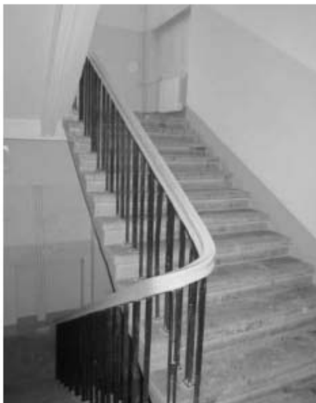
35. Вид конструкций лестницы в западной части здания (историческая лестница №1)
