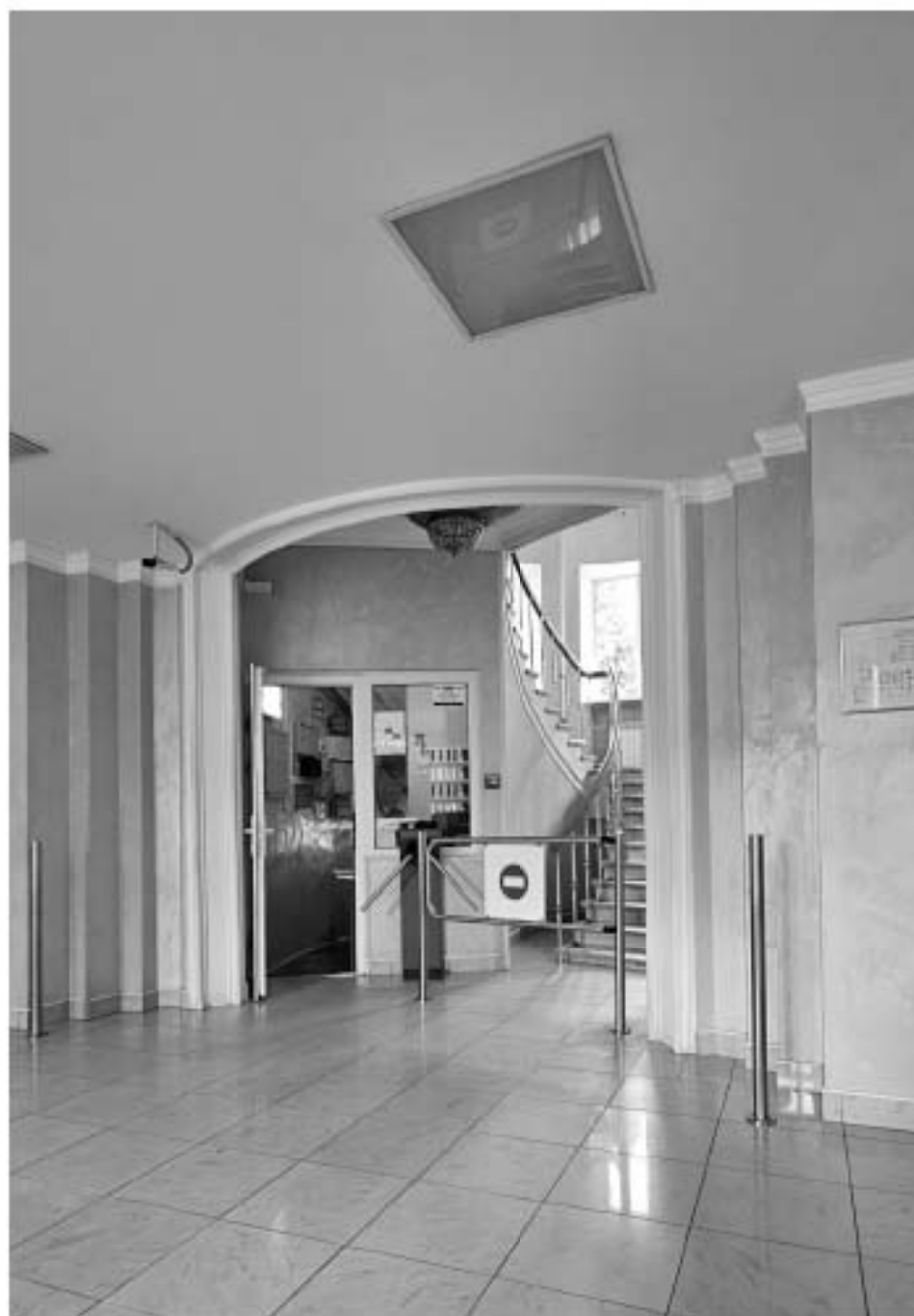
23. 1-й эт. Вестибюль. Вид на главную лестницу.
