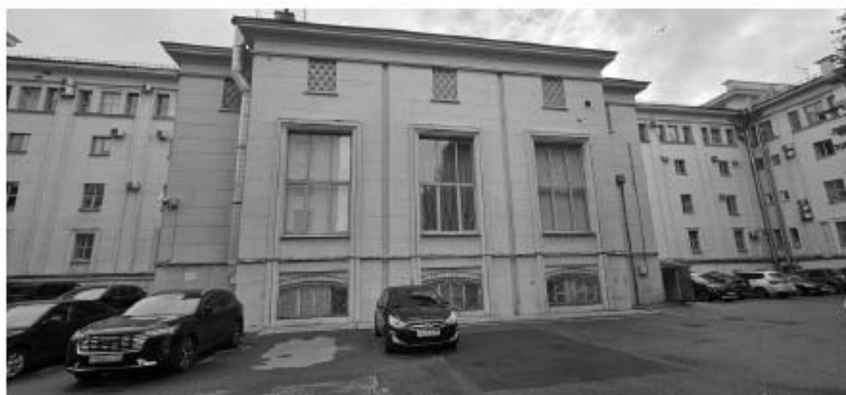
16. Фрагмент западного дворового фасада. Вид на объем актового зала.
