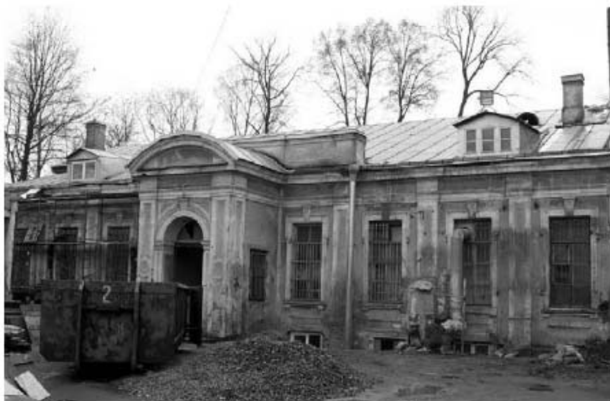
66. Исидоровская церковь. Реставрация фасадов. Вид с северо-запада. Ноябрь 2012 г. (с сайта: https://lavra.spb.ru/ )
