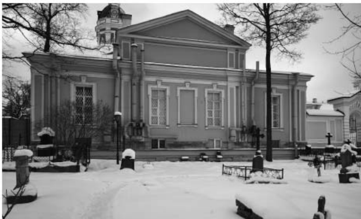
Фото 1. Восточный фасад церкви.
