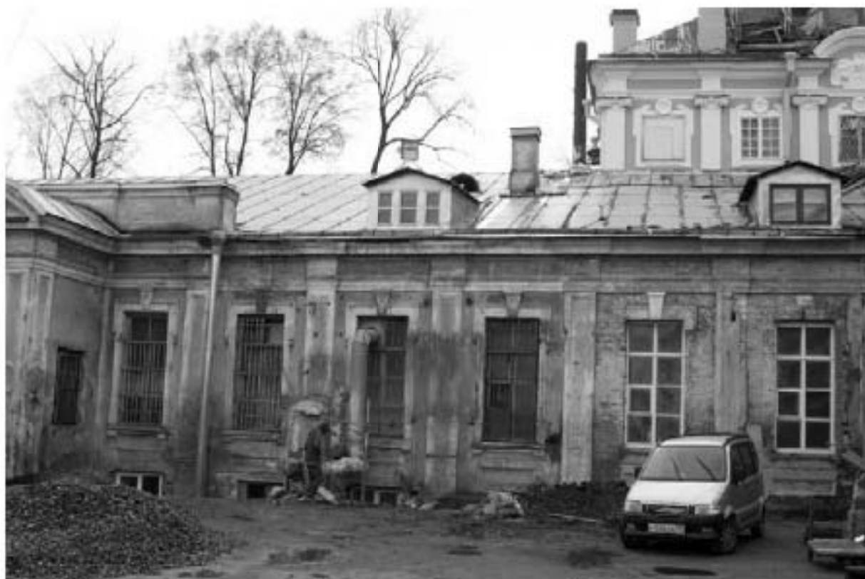
67. Исидоровская церковь. Реставрация фасадов. Вид с северо-запада. Ноябрь 2012 г. (с сайта: https://lavra.spb.ru/ )
