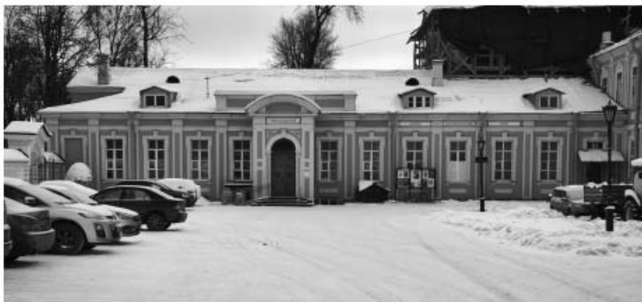
Фото 3. Северный фасад церкви. Главный вход.
