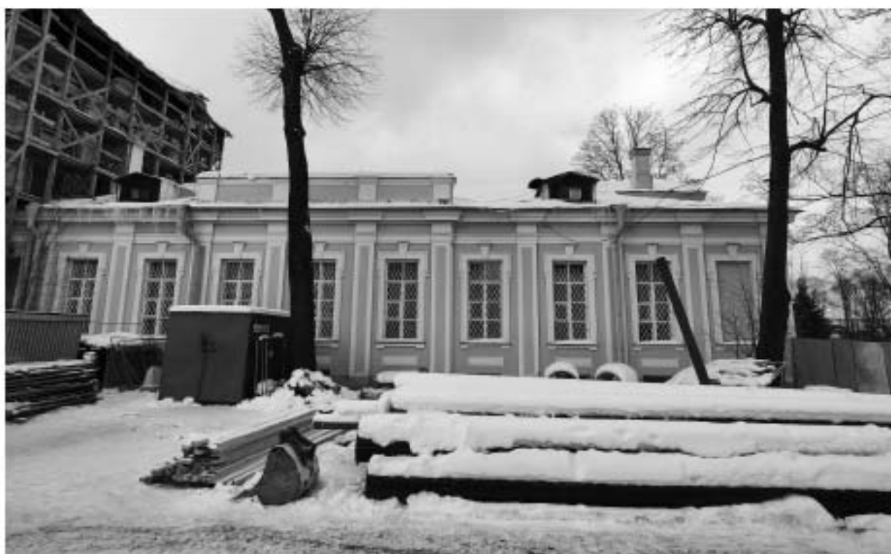
Фото 2. Южный фасад церкви.
