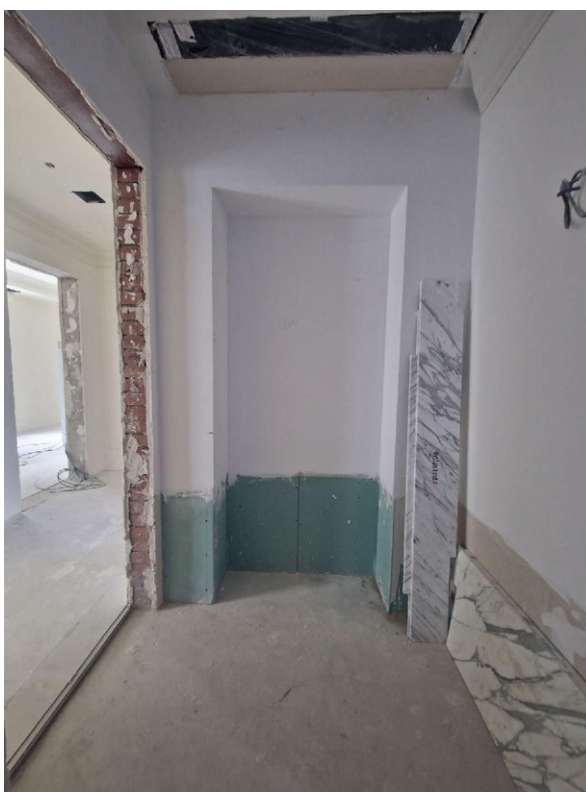
Фото 10. Общий вид на часть рассматриваемого помещения в границах объекта культурного наследия
