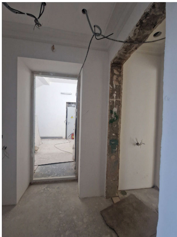
Фото 36. Общий вид на часть рассматриваемого помещения в границах объекта культурного наследия
