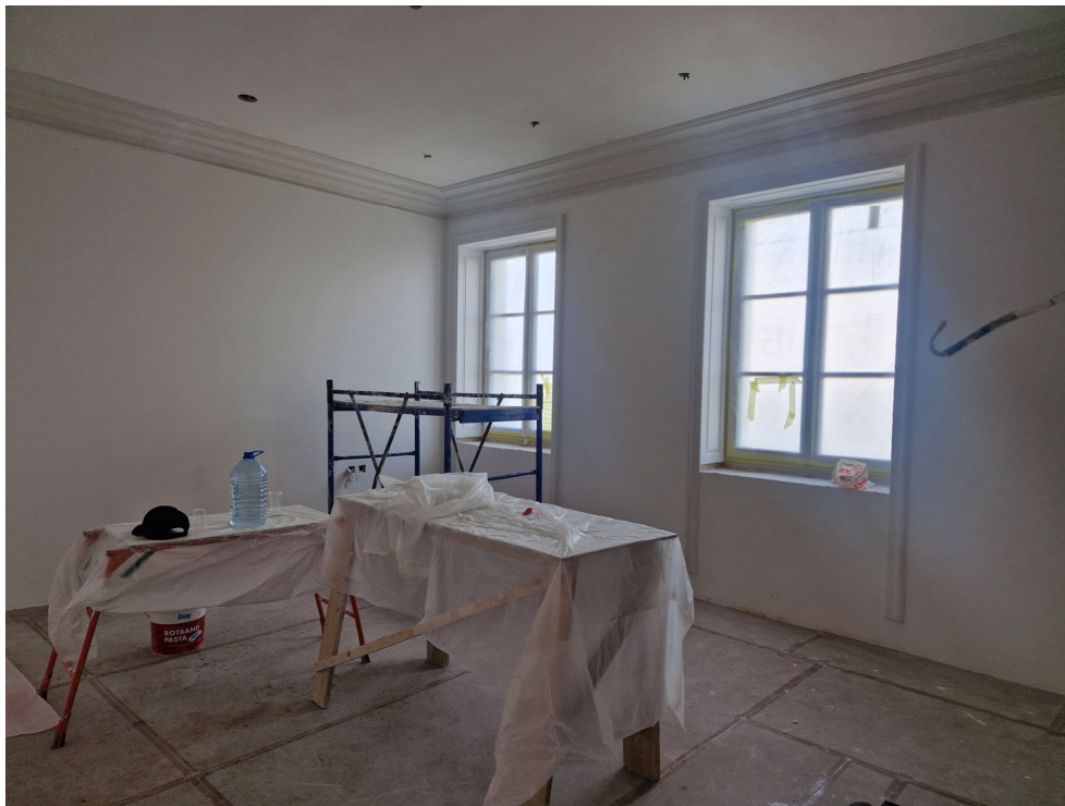
Фото 7. Общий вид на часть рассматриваемого помещения в границах объекта культурного наследия
