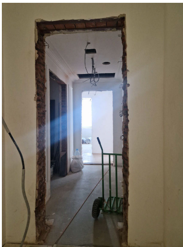
Фото 40. Общий вид на часть рассматриваемого помещения в границах объекта культурного наследия
