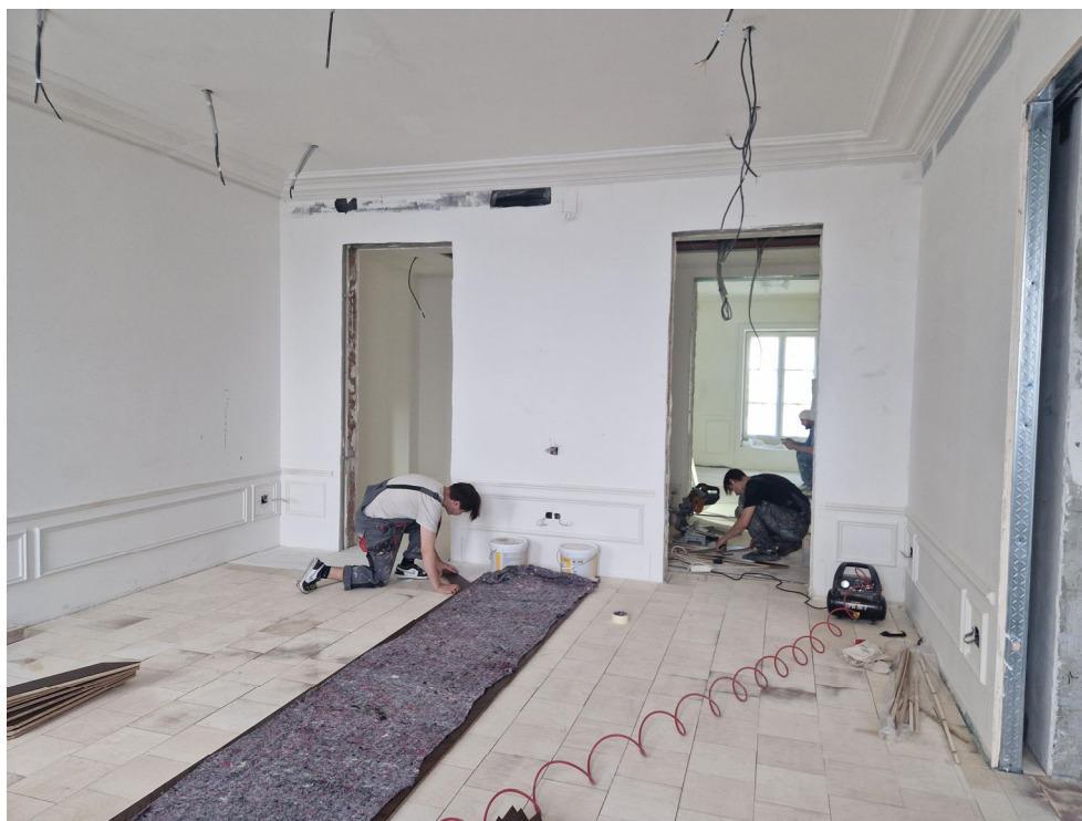
Фото 65. Общий вид на часть рассматриваемого помещения в границах объекта культурного наследия
