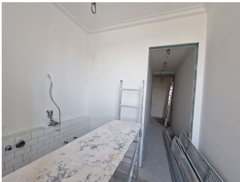
Фото 38. Общий вид на часть рассматриваемого помещения в границах объекта культурного наследия
