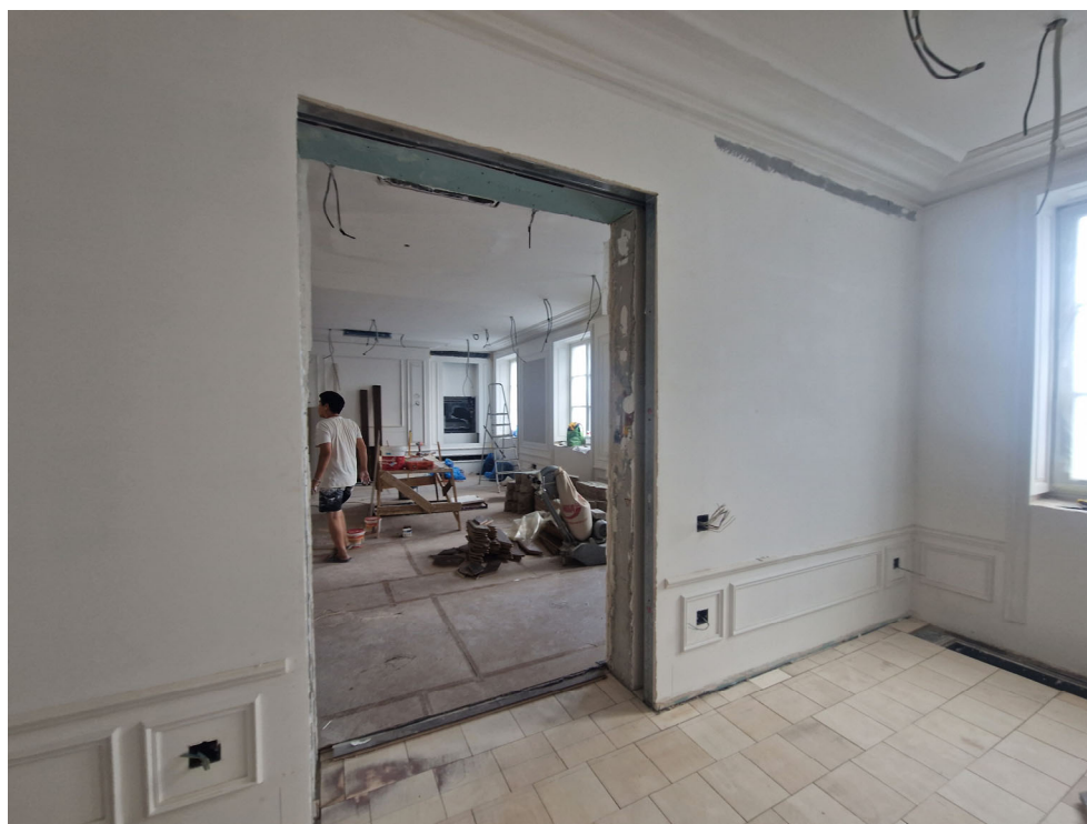
Фото 66. Общий вид на часть рассматриваемого помещения в границах объекта культурного наследия
