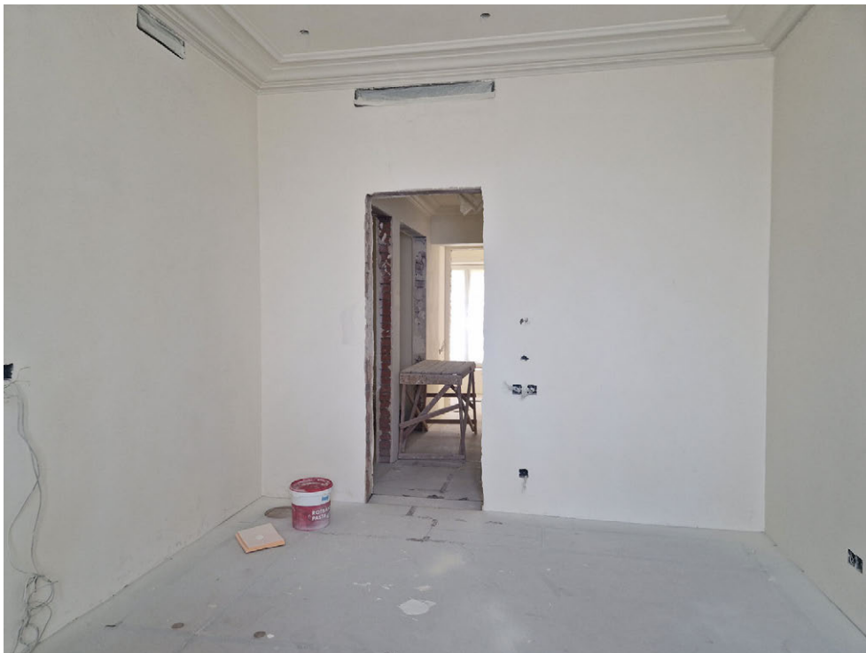
Фото 35. Общий вид на часть рассматриваемого помещения в границах объекта культурного наследия
