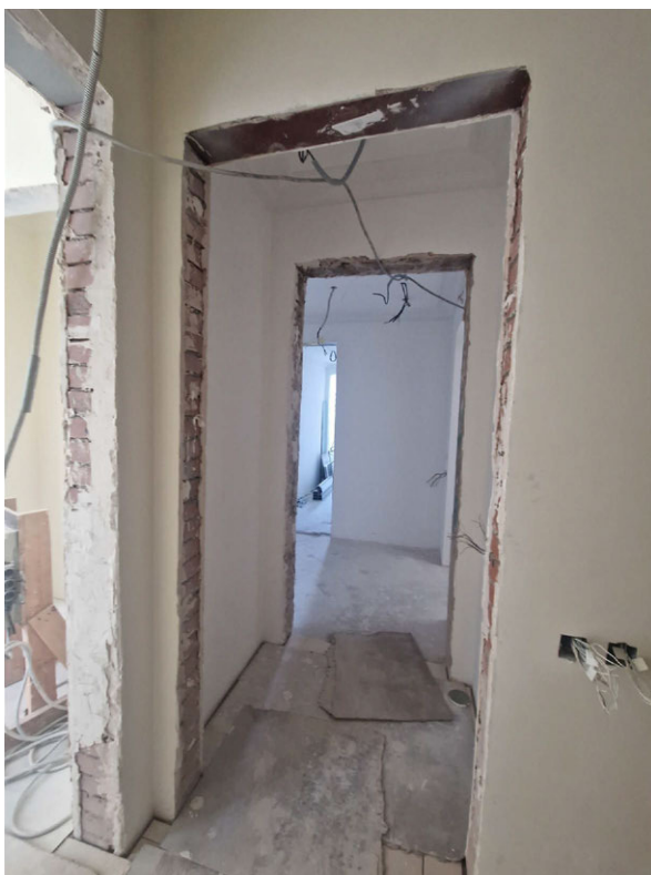
Фото 27. Общий вид на часть рассматриваемого помещения в границах объекта культурного наследия
