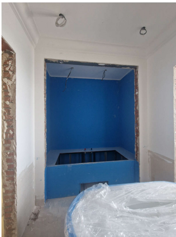
Фото 13. Общий вид на часть рассматриваемого помещения в границах объекта культурного наследия
