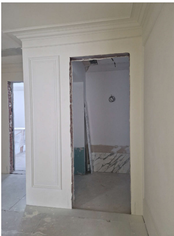
Фото 6. Общий вид на часть рассматриваемого помещения в границах объекта культурного наследия
