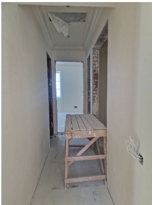
Фото 29. Общий вид на часть рассматриваемого помещения в границах объекта культурного наследия
