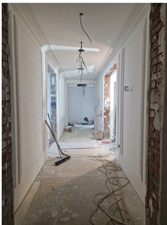
Фото 60. Общий вид на часть рассматриваемого помещения в границах объекта культурного наследия
