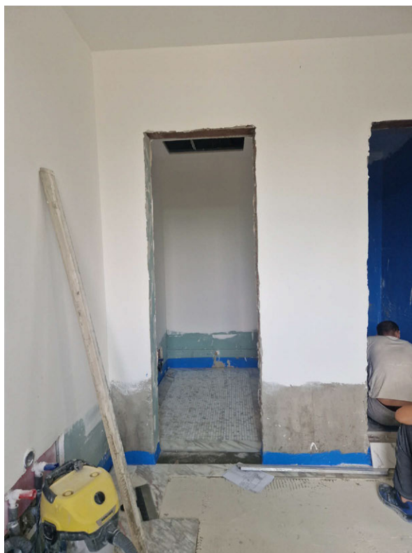
Фото 49. Общий вид на часть рассматриваемого помещения в границах объекта культурного наследия
