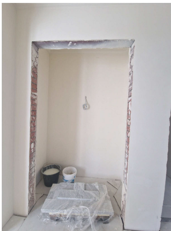
Фото 22. Общий вид на часть рассматриваемого помещения в границах объекта культурного наследия
