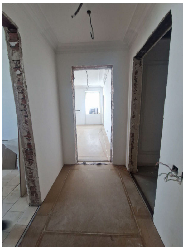
Фото 42. Общий вид на часть рассматриваемого помещения в границах объекта культурного наследия
