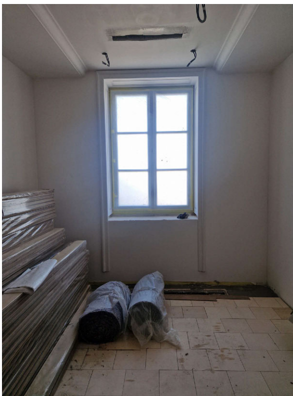
Фото 44. Общий вид на часть рассматриваемого помещения в границах объекта культурного наследия
