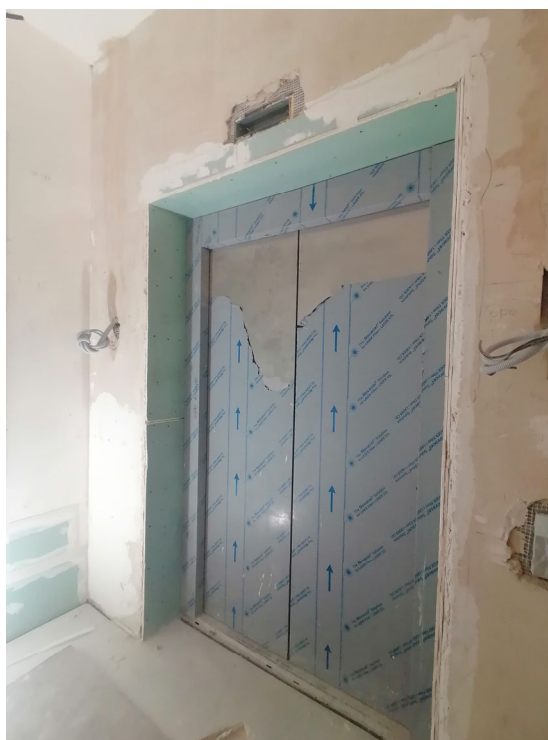
Фото 56. Общий вид на часть рассматриваемого помещения в границах объекта культурного наследия
