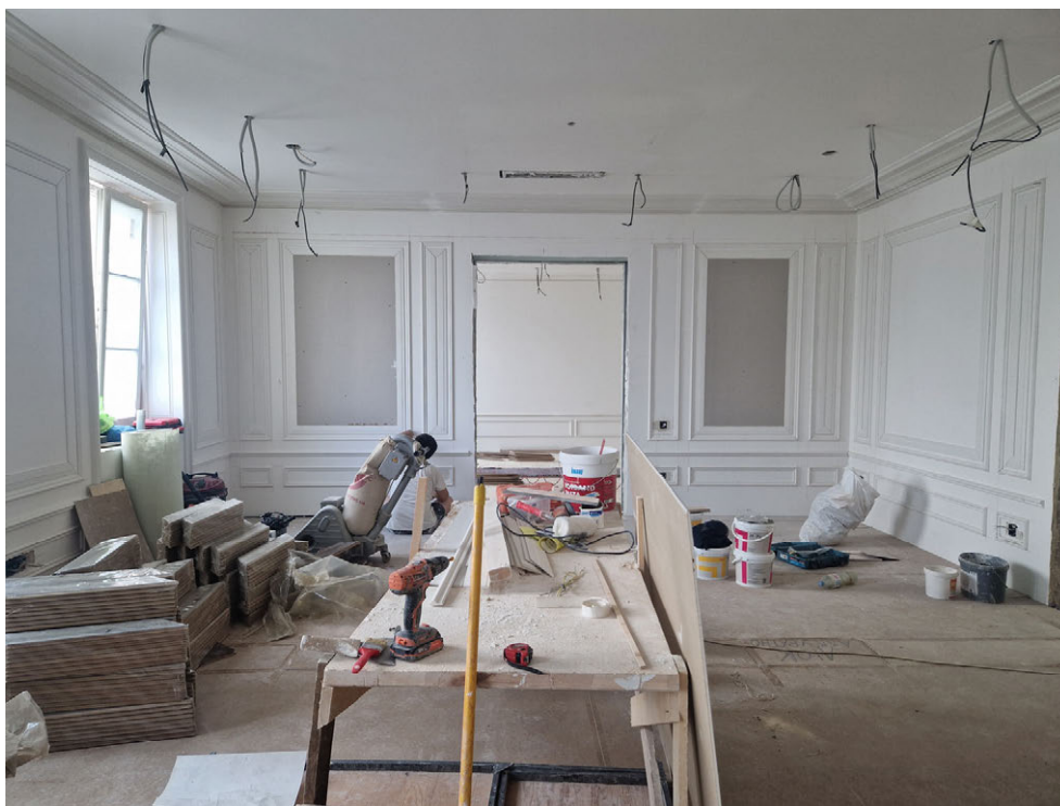
Фото 63. Общий вид на часть рассматриваемого помещения в границах объекта культурного наследия
