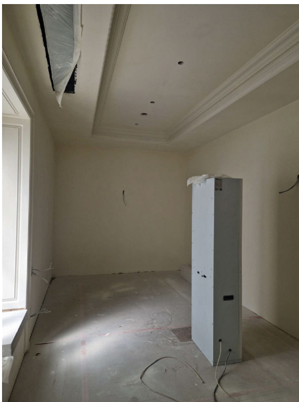
Фото 1. Общий вид на часть рассматриваемого помещения в границах объекта культурного наследия
