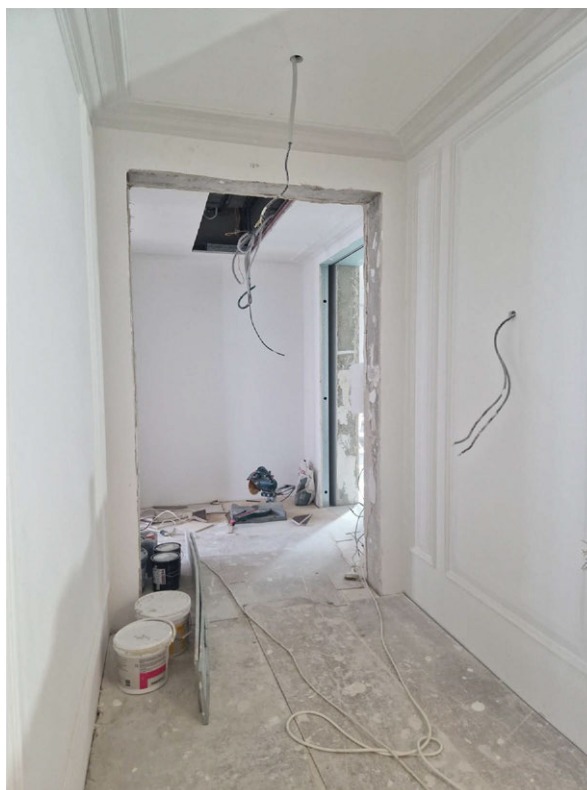
Фото 52. Общий вид на часть рассматриваемого помещения в границах объекта культурного наследия
