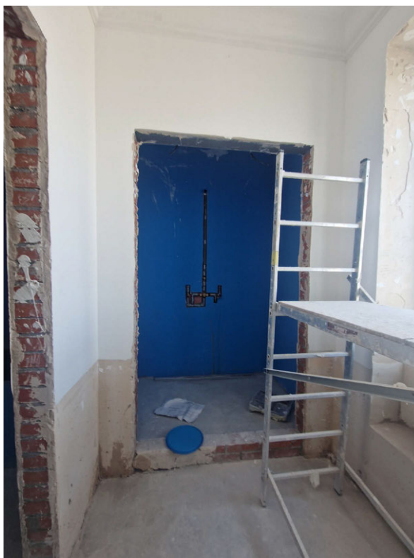
Фото 15. Общий вид на часть рассматриваемого помещения в границах объекта культурного наследия
