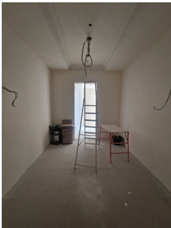
Фото 17. Общий вид на часть рассматриваемого помещения в границах объекта культурного наследия
