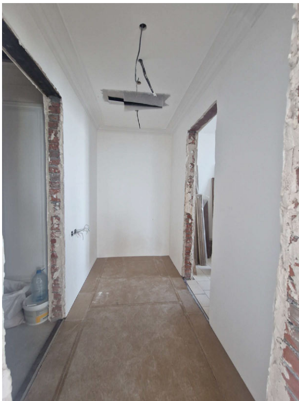
Фото 43. Общий вид на часть рассматриваемого помещения в границах объекта культурного наследия
