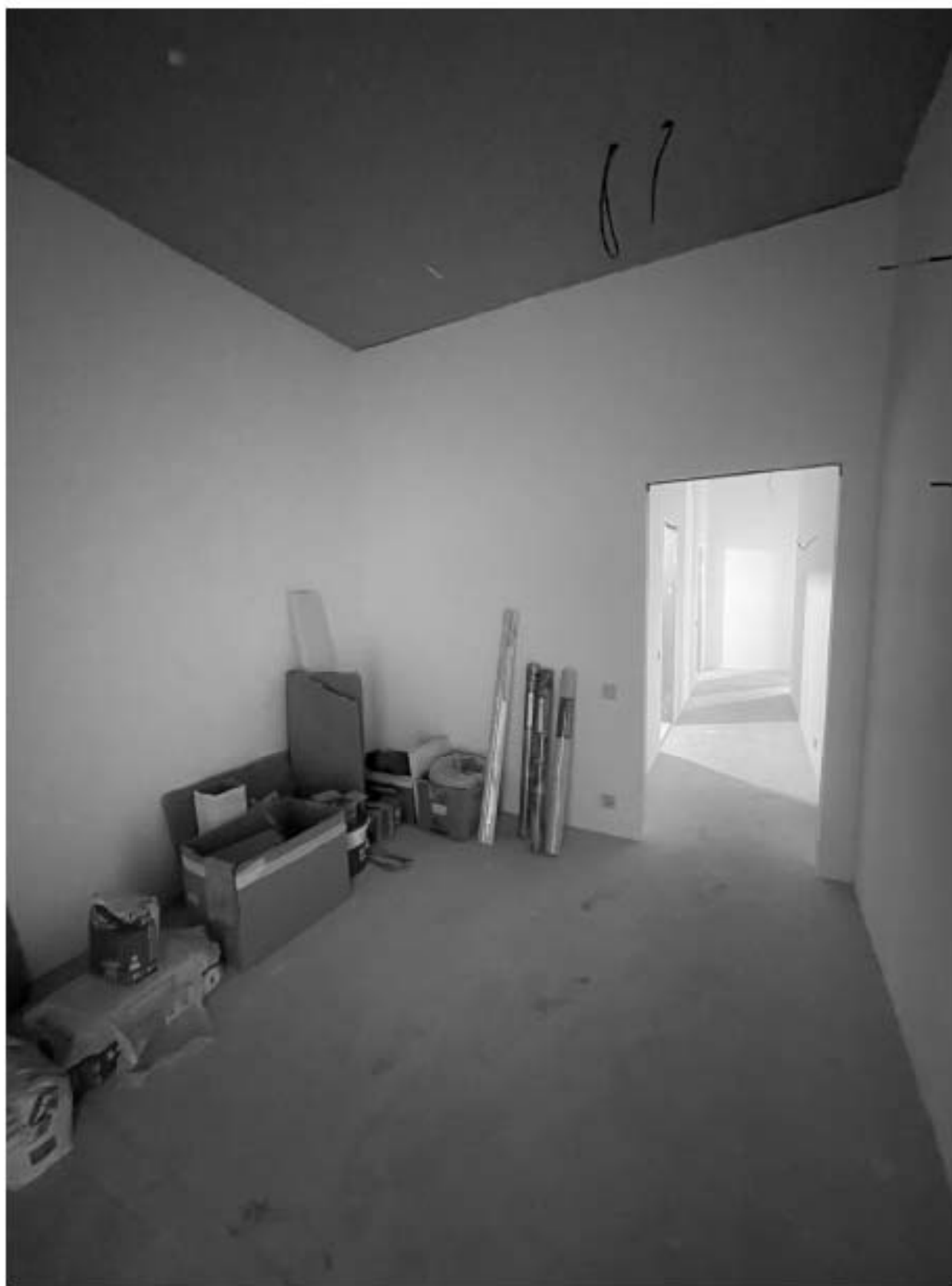
7. Фрагмент интерьера коридора. Помещение 4.
