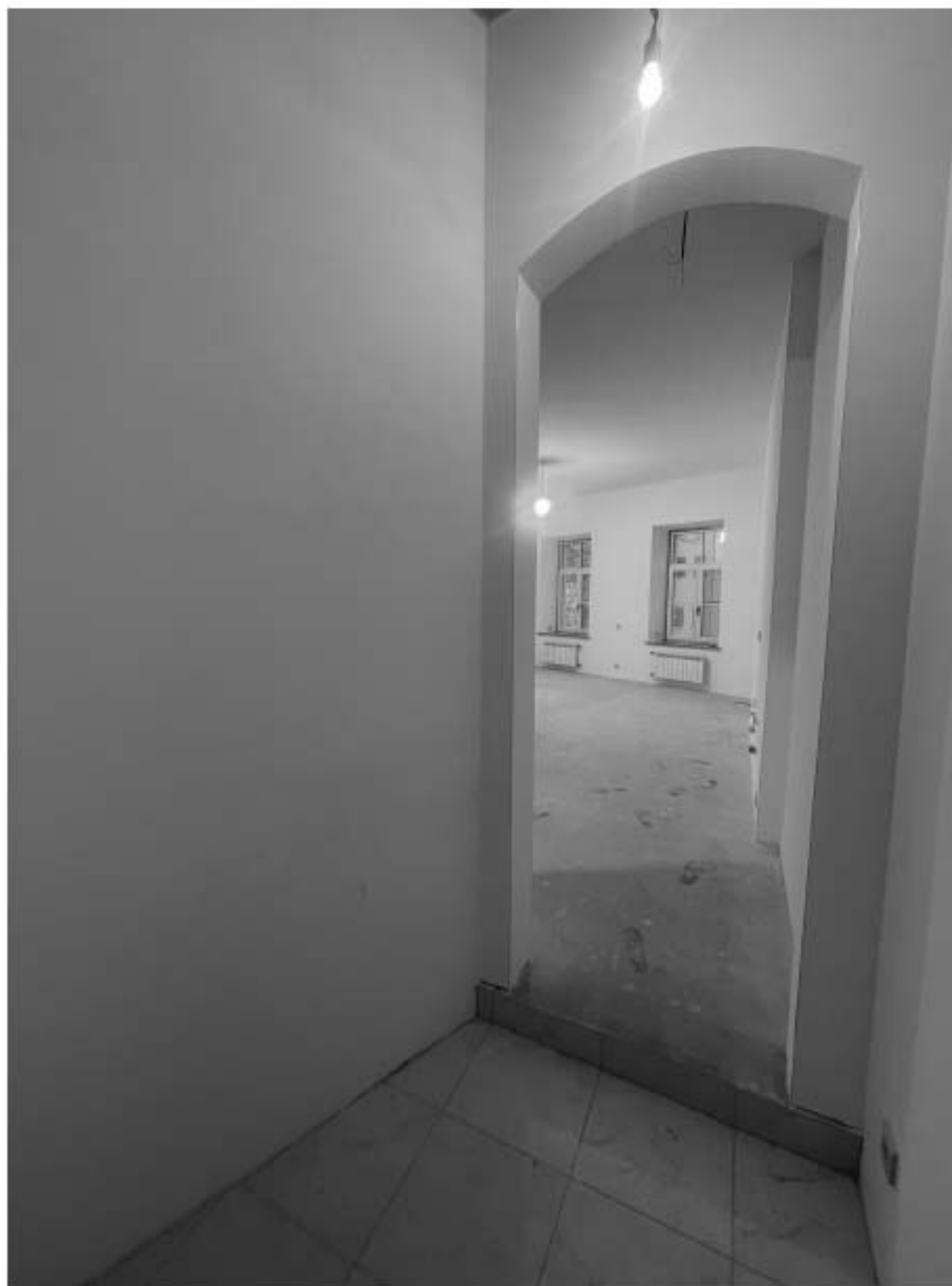
3. Фрагмент интерьера коридора. Помещение 1.
