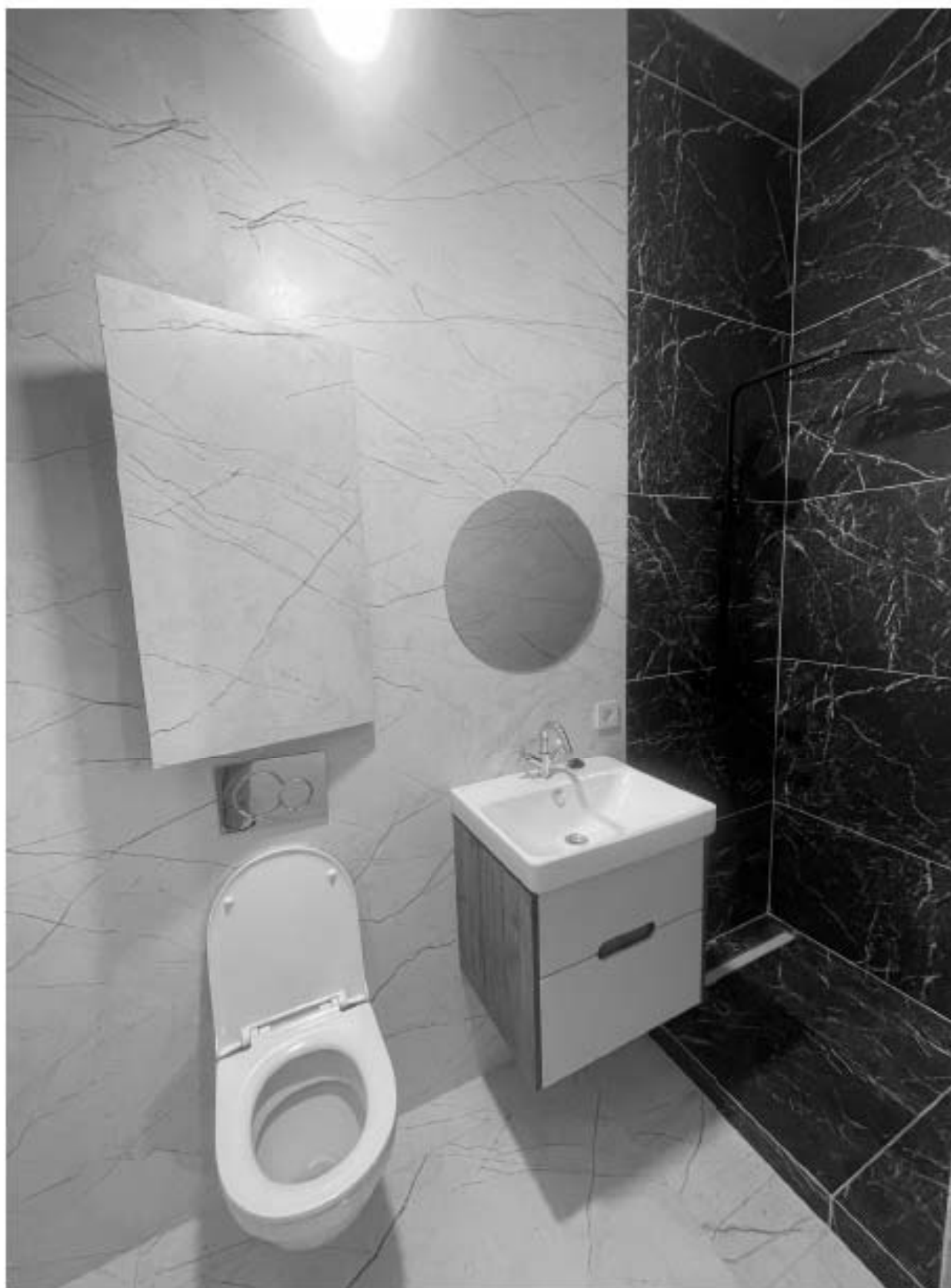
6. Фрагмент интерьера туалета. Помещение 2.
