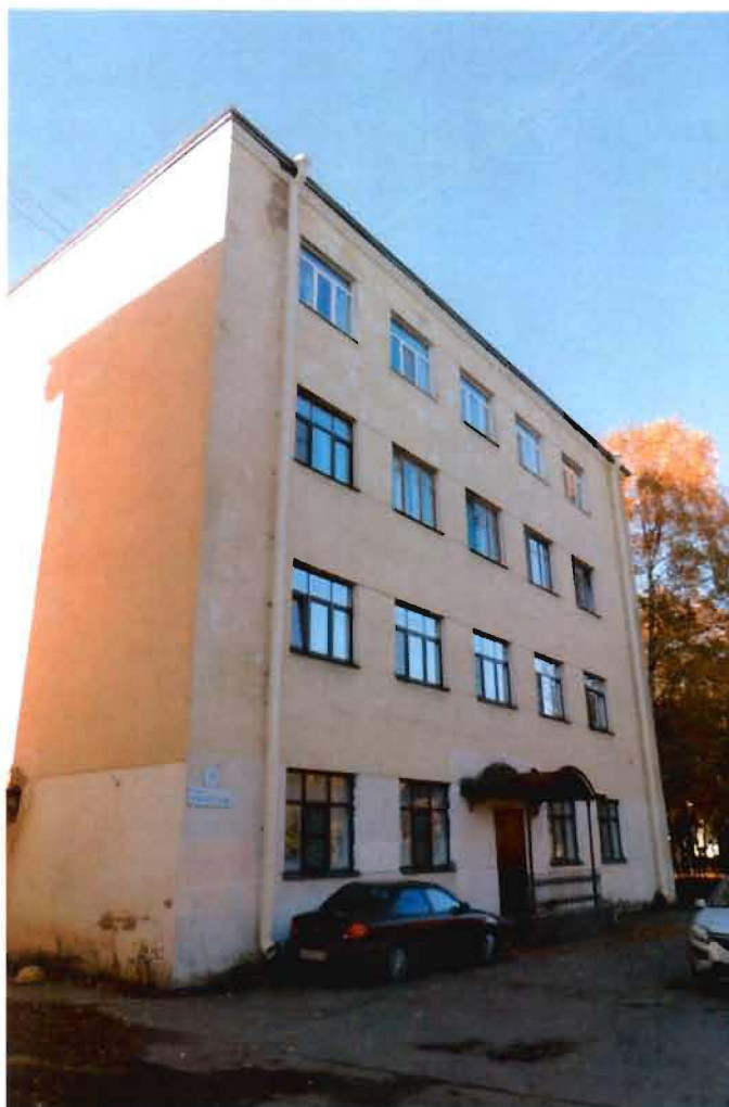
4. Торцевой северный корпус.
