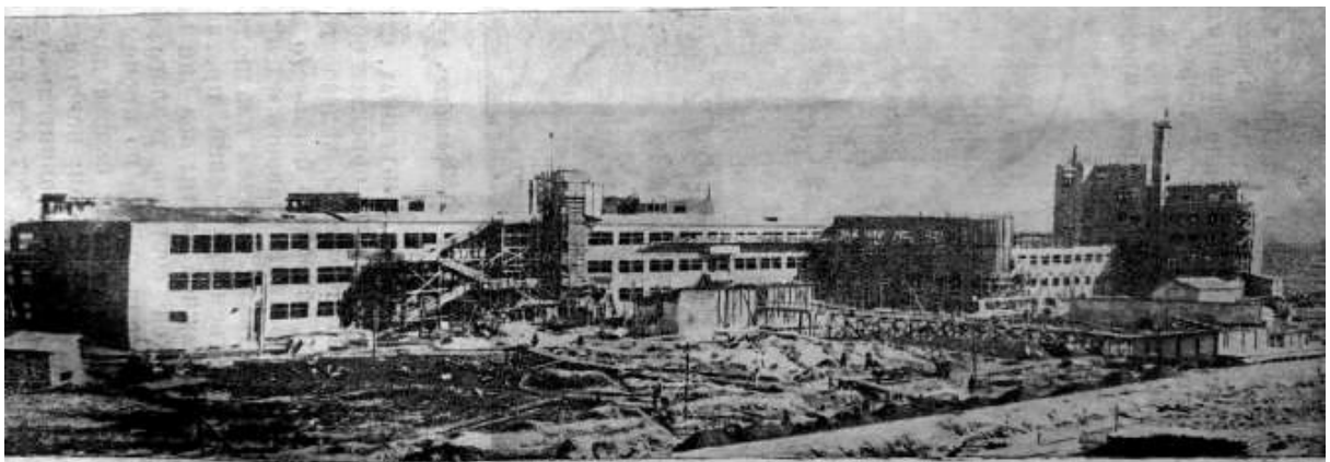
Рис. 28. Состояние работ по постройке втуза Авиагорода в мае 1932 г.
