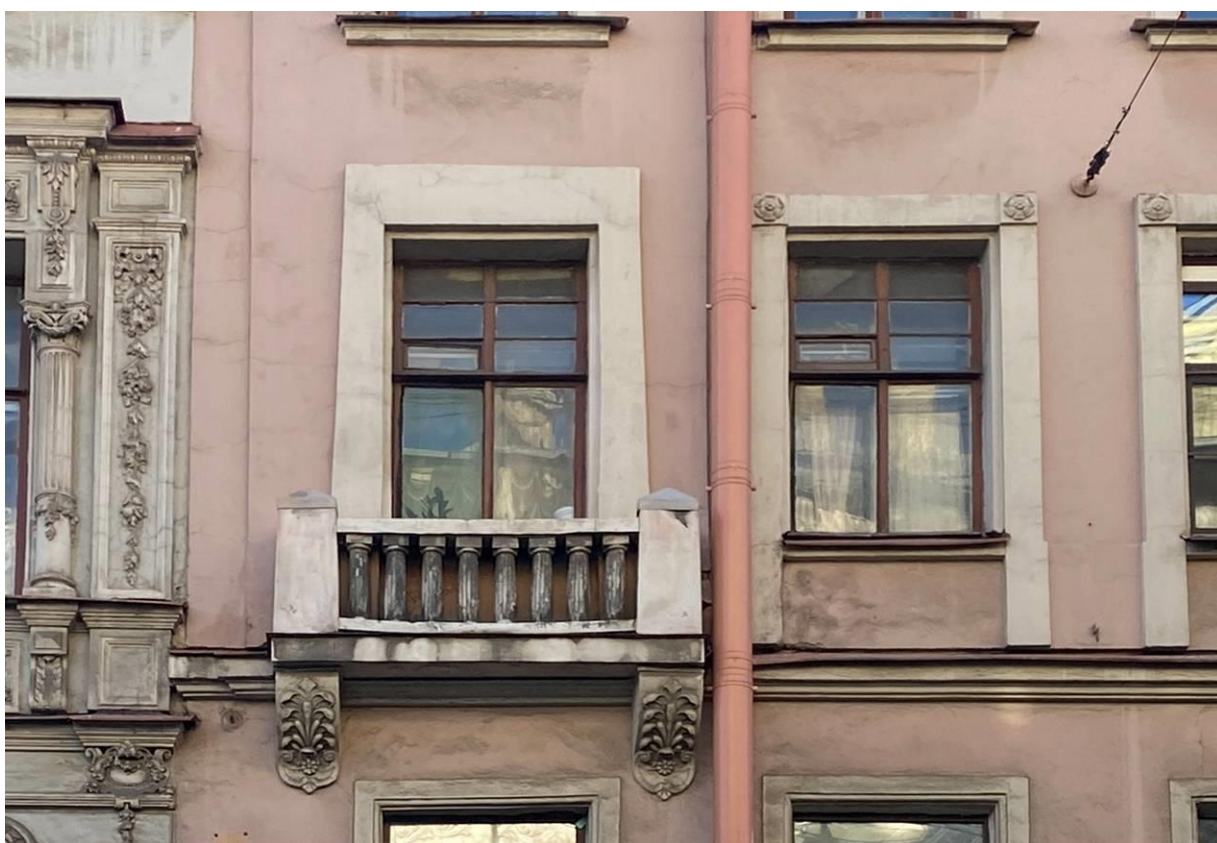
12. Лицевой фасад по Казанской ул. Левая (восточная) часть фасада. Элементы декоративная отделки 3 этажа: «французский» балкон и окно с сохранившейся исторической рассткловкой
