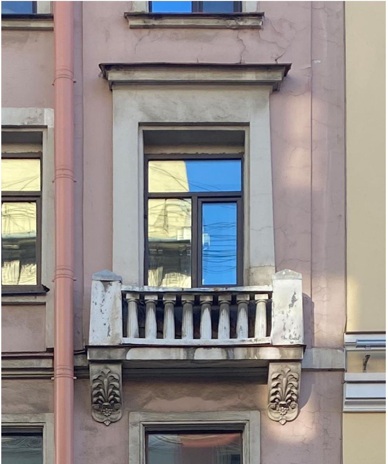
13. Лицевой фасад по Казанской ул. Правая (западная) часть фасада. Элементы декоративная отделки 3 этажа: «французский» балкон с сохранившимся историческим оформлением проема (утрачена лепная композиция в десюдепорте.
