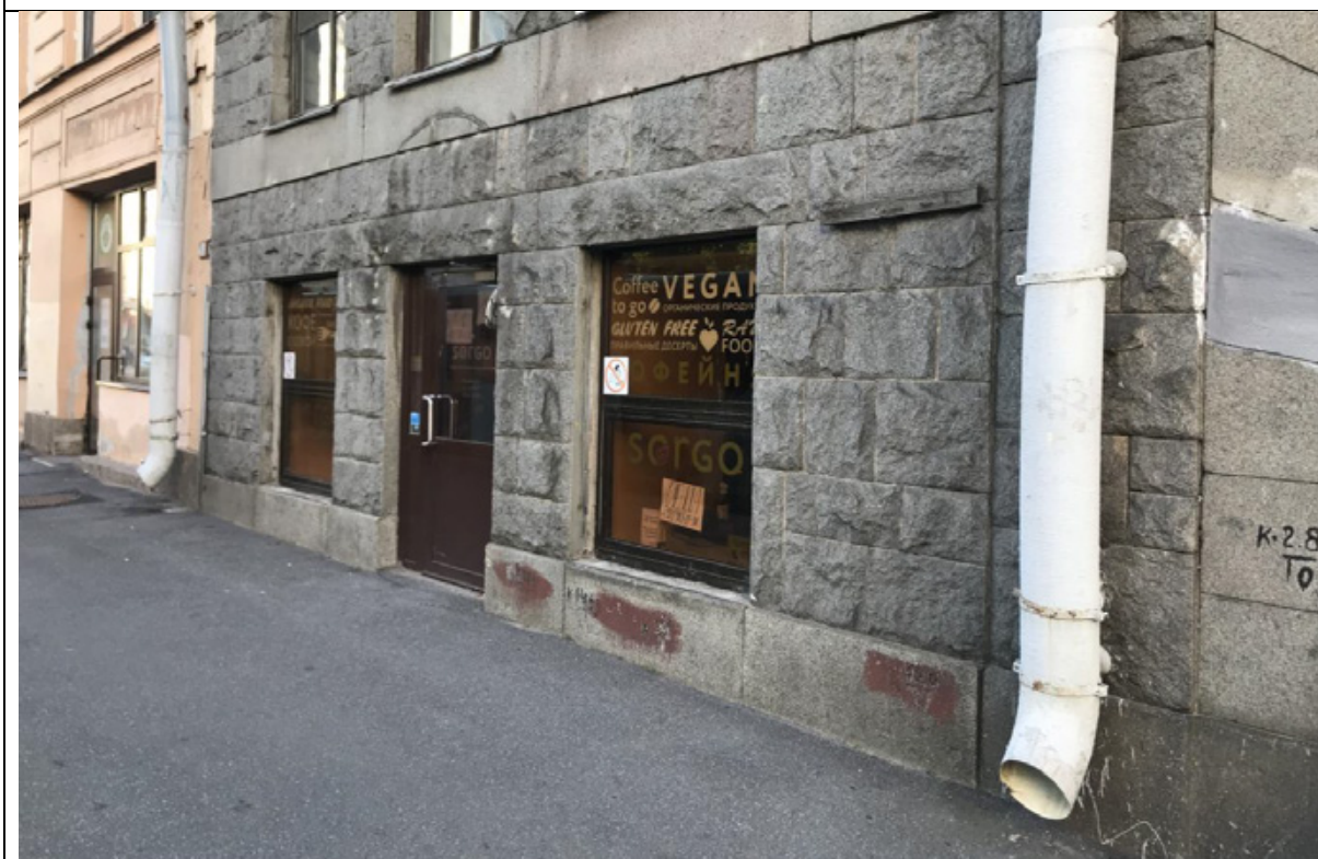
Фото 2. Вход в помещение 5-Н. Над оконными проемами отсутствуют (демонтированы) вывески, над дверным проемом – козырек. Оконные и дверное заполнения – металлопластиковые, коричневые.
