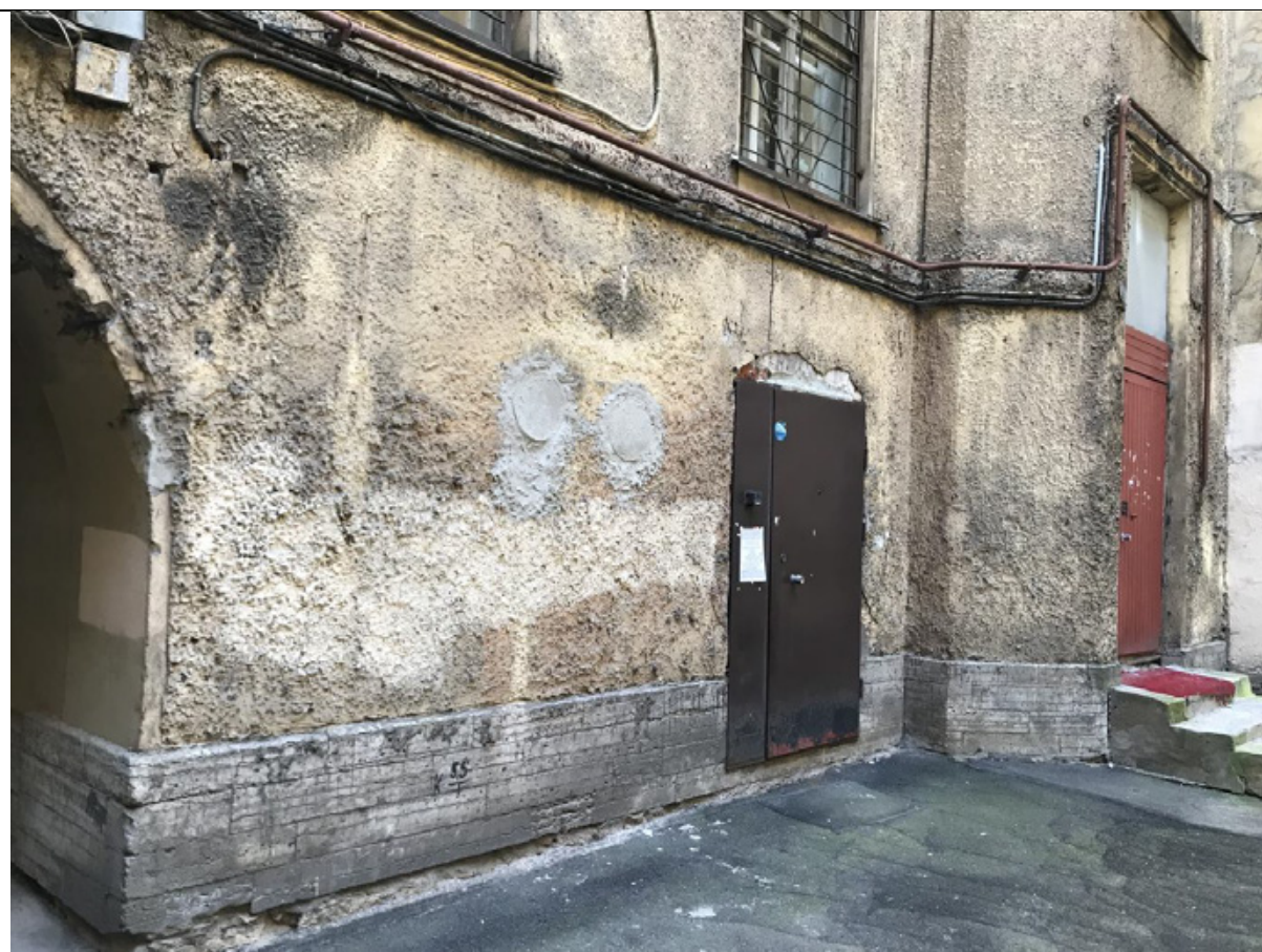
Фото 4. Фрагмент дворового фасада. Отсутствует (демонтировано) дополнительное инженерное оборудование: воздуховод и кондиционер на кронштейнах. Отверстия заделаны строительным раствором
