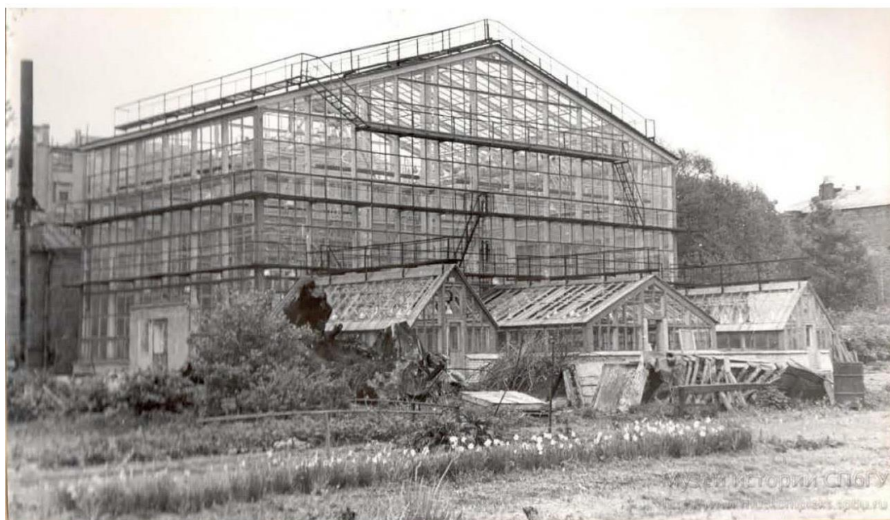
33. Оранжерея. Фотография. Весна 1974 г. Оранжерея в основном остеклена, идут работы по электрике и сантехнике. Фотография. А. Осиповой. Материалы директора ботанического сада Д.М. Залесского Музей истории СПбГУ.
