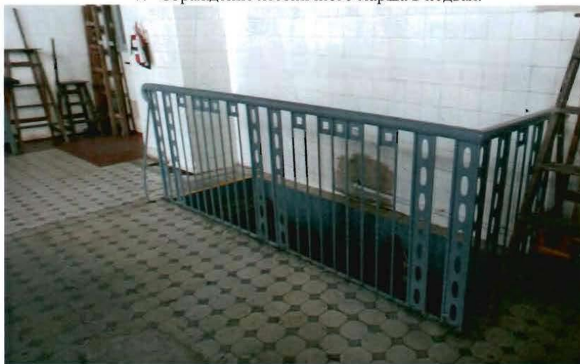
7. Ограждение лестничного марша в подвал.
