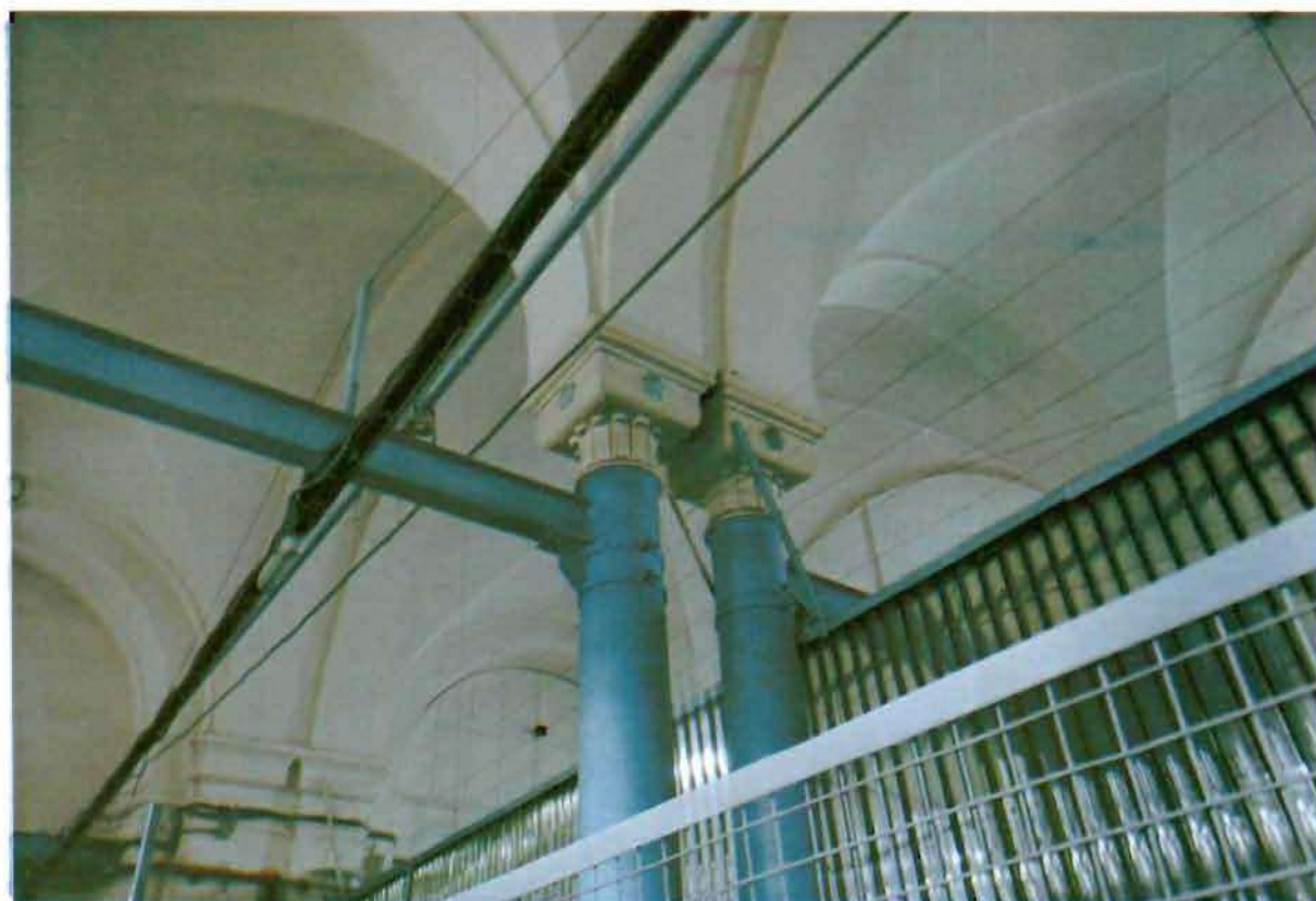
12. Чугунные опорные колонны (корпус № 3).
