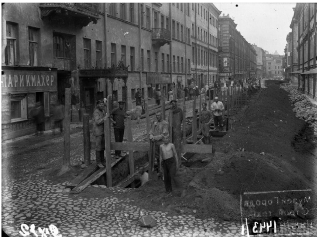
62. 1920-1930 гг. Канализационные работы в Демидовом переулке. https://goskatalog.ru/portal/#/collections?id=17737546
