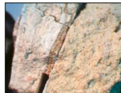
Поздние покрасочные слои по декоративному слою.
