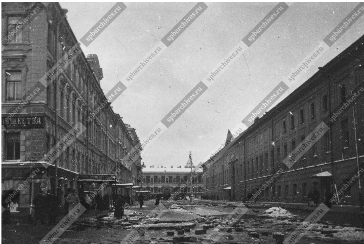
104. Вид разрушенной наводнением мостовой на ул. Глинки. Ноябрь 1903 г. – ЦГАКФФД СПб – Фотодокументы. Описание 1Б-2. Ед.хр.1144
