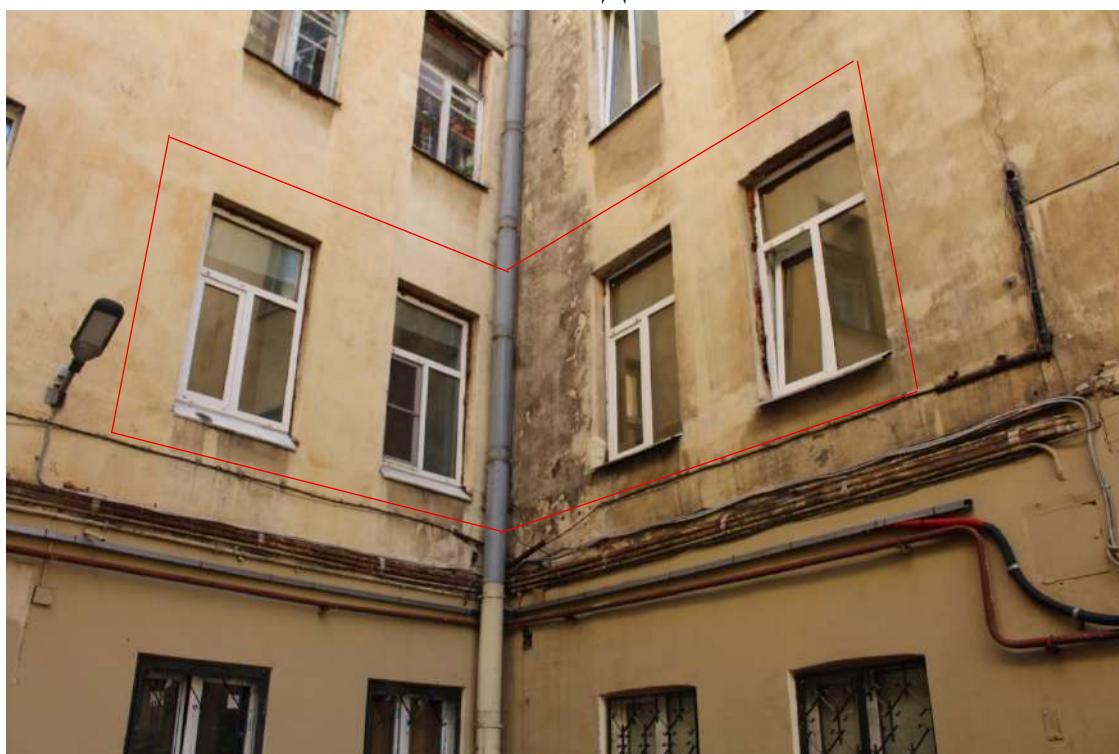
Фото 18. Вид на дворовые фасады объекта культурного наследия федерального значения «Дом, где жили: в 1877-1916 гг. - композитор Направник Э.Ф., в 1882-1908 гг. - композитор Стравинский И.Ф., в 1946-1982 гг. - геолог Наливкин Д.В.». Красным отмечены оконные проемы квартиры № 25.
