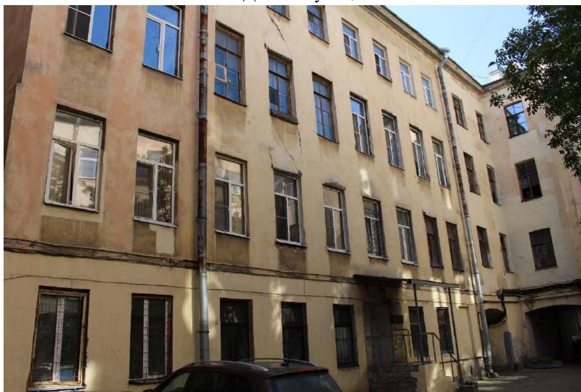
Фото 12. Вид на дворовые фасады объекта культурного наследия федерального значения «Дом, где жили: в 1877-1916 гг. - композитор Направник Э.Ф., в 1882-1908 гг. - композитор Стравинский И.Ф., в 1946-1982 гг. - геолог Наливкин Д.В.».
