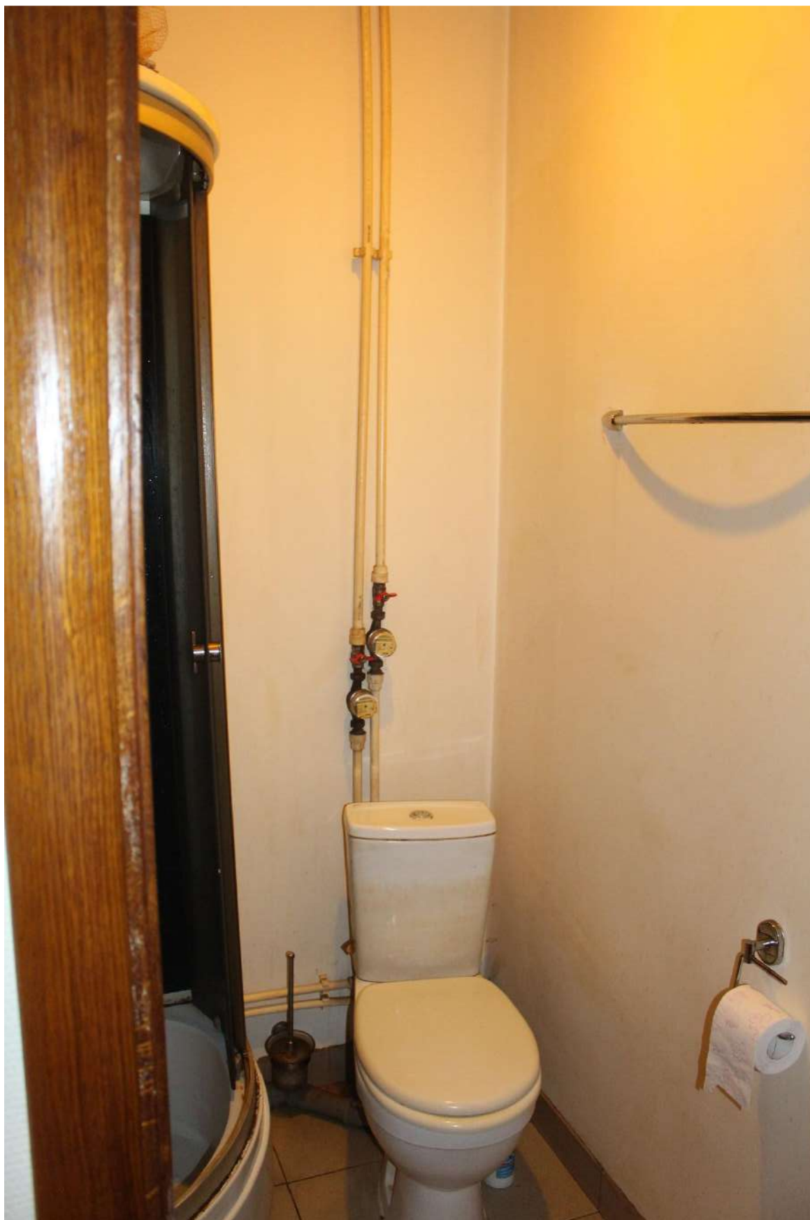
Фото 50. Объект культурного наследия федерального значения «Дом, где жили: в 1877-1916 гг. - композитор Направник Э.Ф., в 1882-1908 гг. - композитор Стравинский И.Ф., в 1946-1982 гг. - геолог Наливкин Д.В.». Квартира № 25, ч.п. 1.
