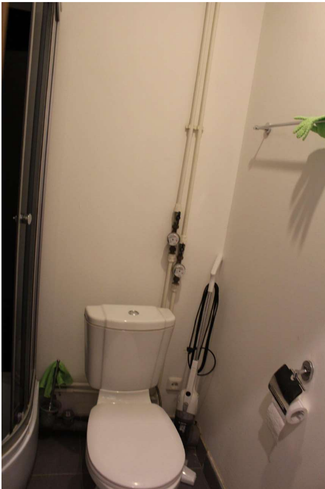
Фото 55. Объект культурного наследия федерального значения «Дом, где жили: в 1877-1916 гг. - композитор Направник Э.Ф., в 1882-1908 гг. - композитор Стравинский И.Ф., в 1946-1982 гг. - геолог Наливкин Д.В.». Квартира № 25, ч.п. 10.
