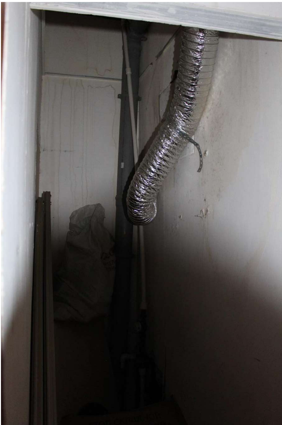
Фото 68. Объект культурного наследия федерального значения «Дом, где жили: в 1877-1916 гг. - композитор Направник Э.Ф., в 1882-1908 гг. - композитор Стравинский И.Ф., в 1946-1982 гг. - геолог Наливкин Д.В.». Квартира № 25, ч.п. 21.
