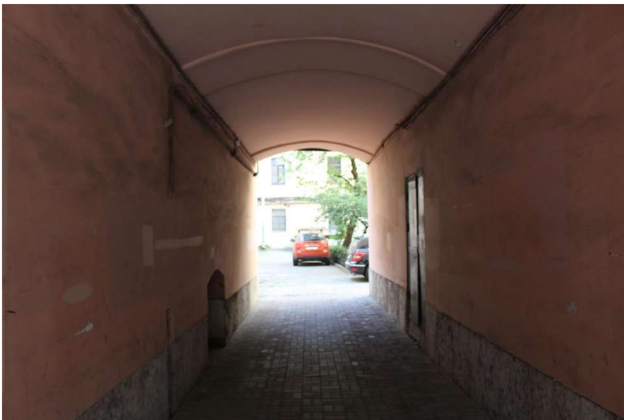
Фото 11. Вид на воротный проезд объекта культурного наследия федерального значения «Дом, где жили: в 1877-1916 гг. - композитор Направник Э.Ф., в 1882-1908 гг. - композитор Стравинский И.Ф., в 1946-1982 гг. - геолог Наливкин Д.В.» по улице Глинки.
