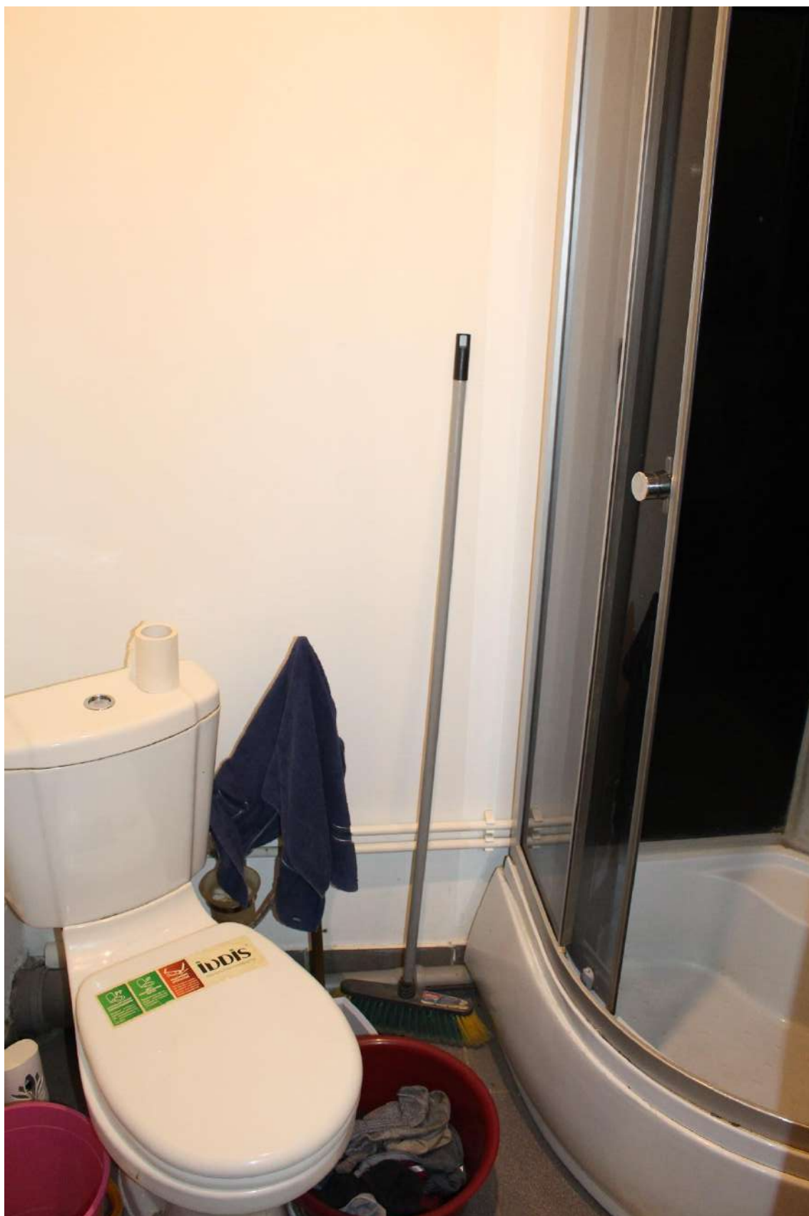
Фото 59. Объект культурного наследия федерального значения «Дом, где жили: в 1877-1916 гг. - композитор Направник Э.Ф., в 1882-1908 гг. - композитор Стравинский И.Ф., в 1946-1982 гг. - геолог Наливкин Д.В.». Квартира № 25, ч.п. 12.
