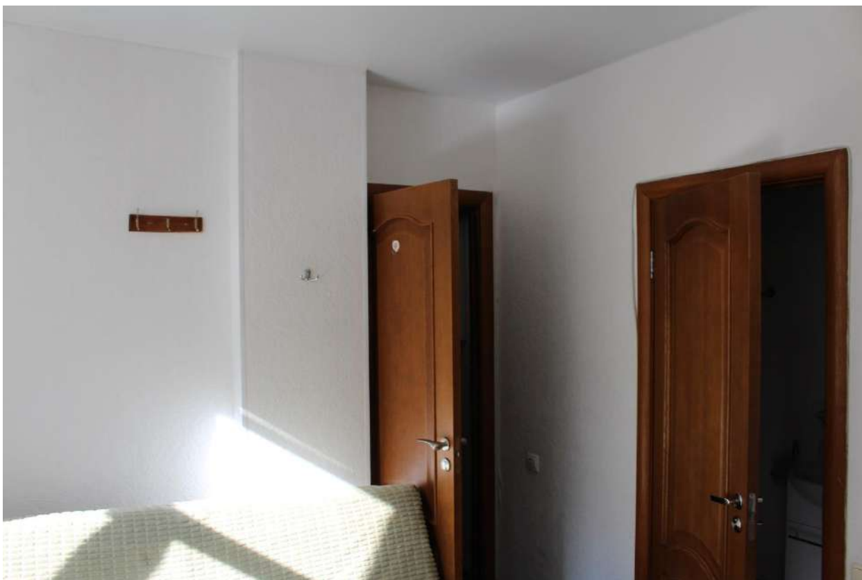
Фото 27. Объект культурного наследия федерального значения «Дом, где жили: в 1877-1916 гг. - композитор Направник Э.Ф., в 1882-1908 гг. - композитор Стравинский И.Ф., в 1946-1982 гг. - геолог Наливкин Д.В.». Квартира № 25, ч.п. 15.
