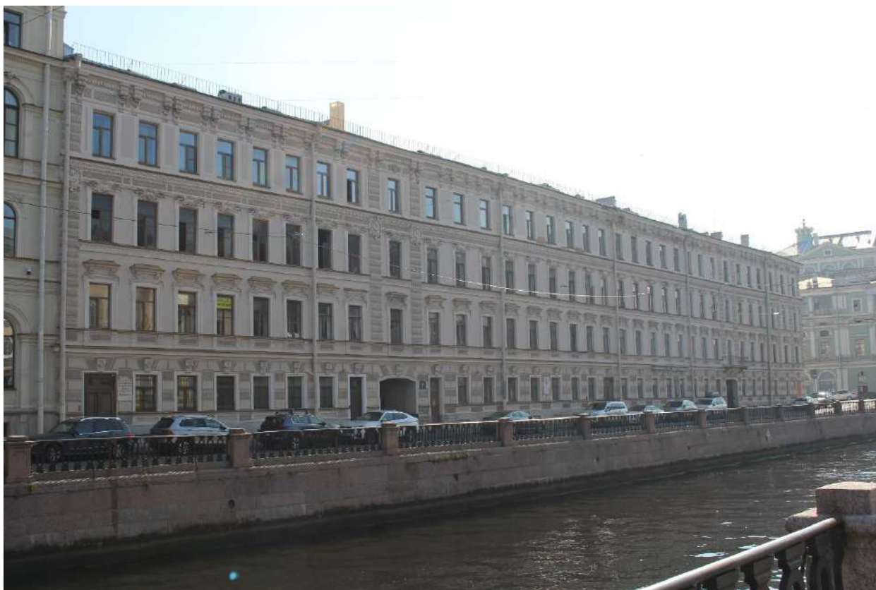
Фото 7. Вид на лицевой фасад объекта культурного наследия федерального значения «Дом, где жили: в 1877-1916 гг. - композитор Направник Э.Ф., в 1882-1908 гг. - композитор Стравинский И.Ф., в 1946-1982 гг. - геолог Наливкин Д.В.» по набережной Крюкова канала.
