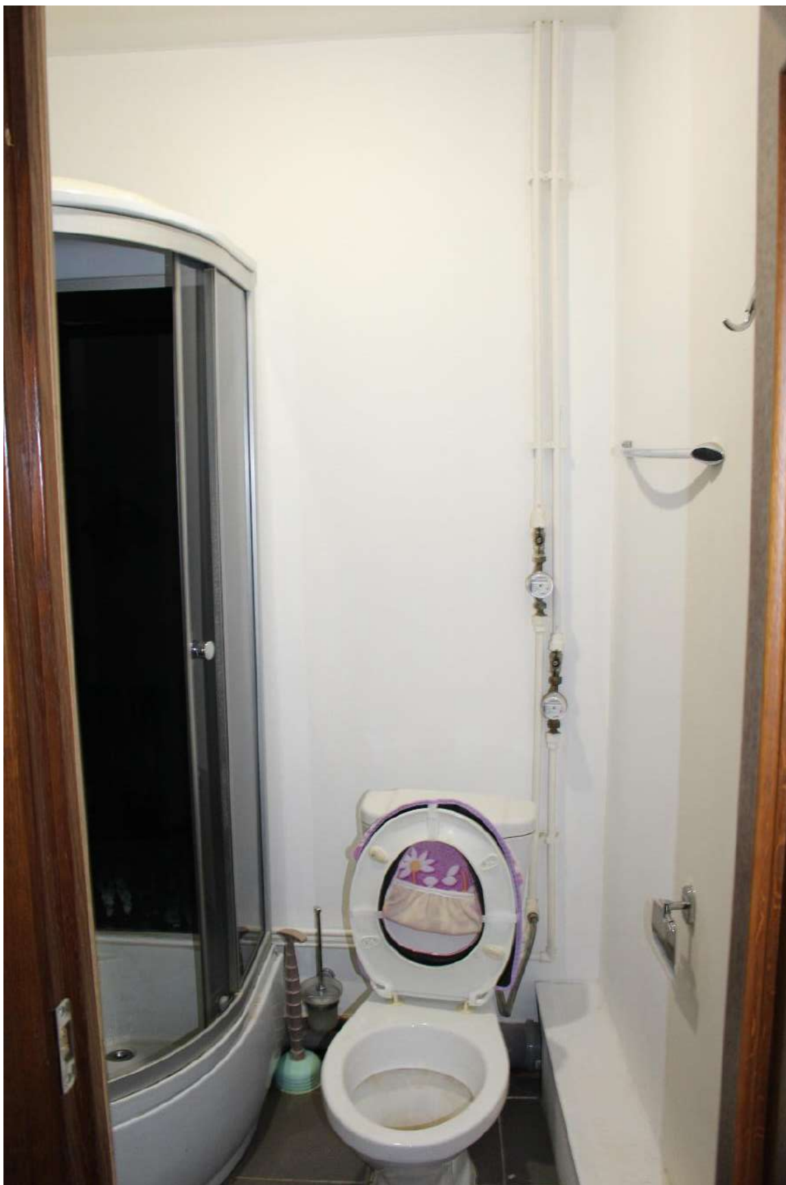
Фото 73. Объект культурного наследия федерального значения «Дом, где жили: в 1877-1916 гг. - композитор Направник Э.Ф., в 1882-1908 гг. - композитор Стравинский И.Ф., в 1946-1982 гг. - геолог Наливкин Д.В.». Квартира № 25, ч.п. 24.
