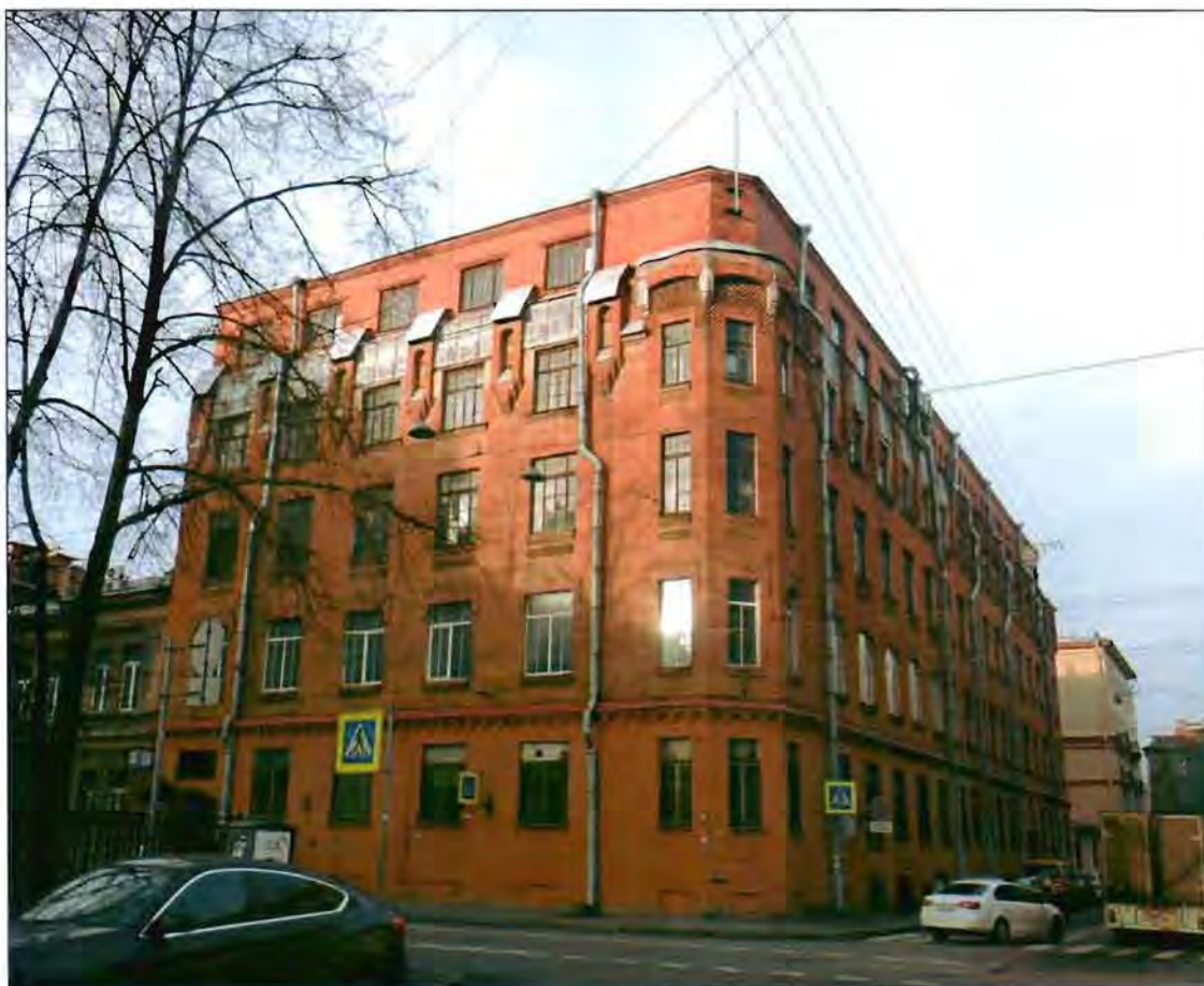
1. Общий вид с востока.
