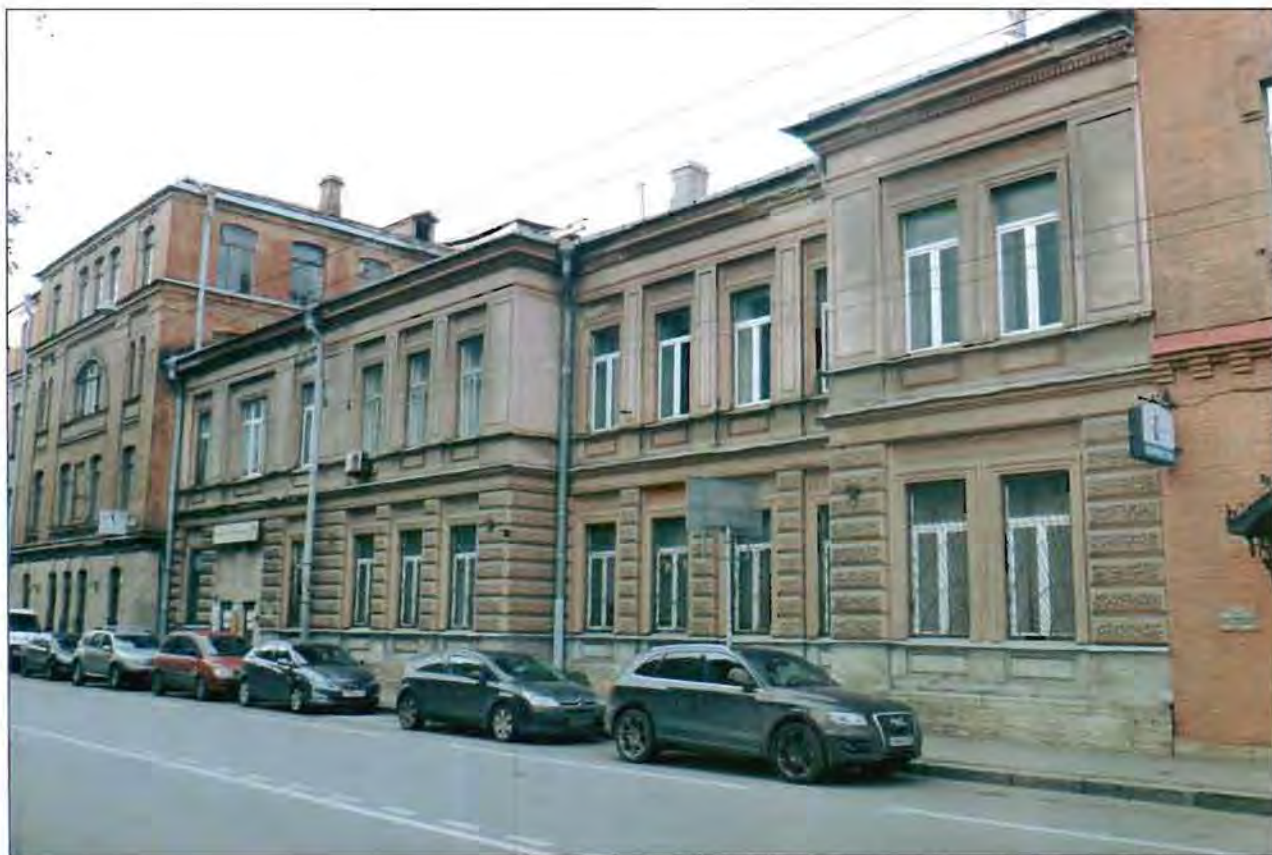
1. Общий вид с востока.
