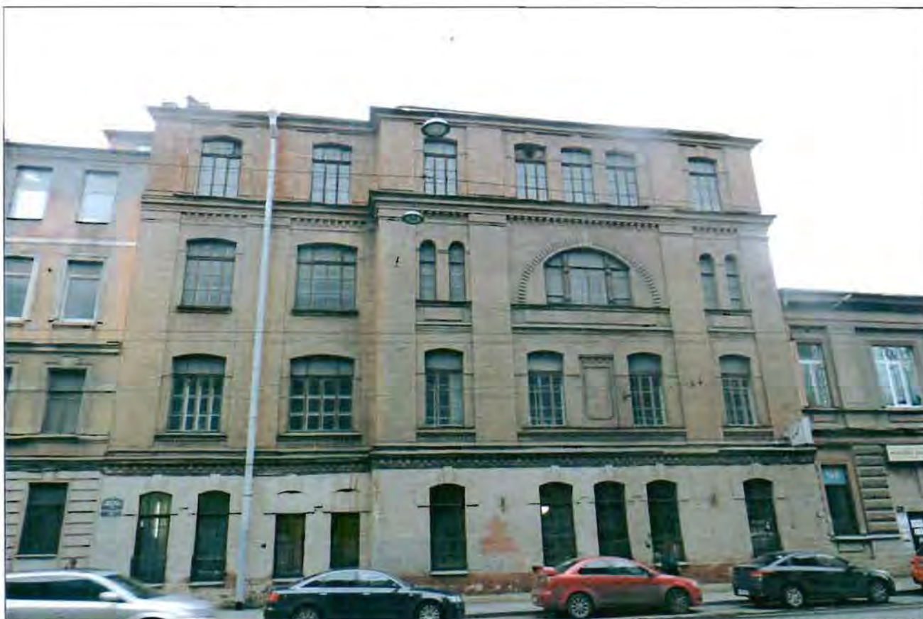
1. Восточный фасад. Общий вид.
