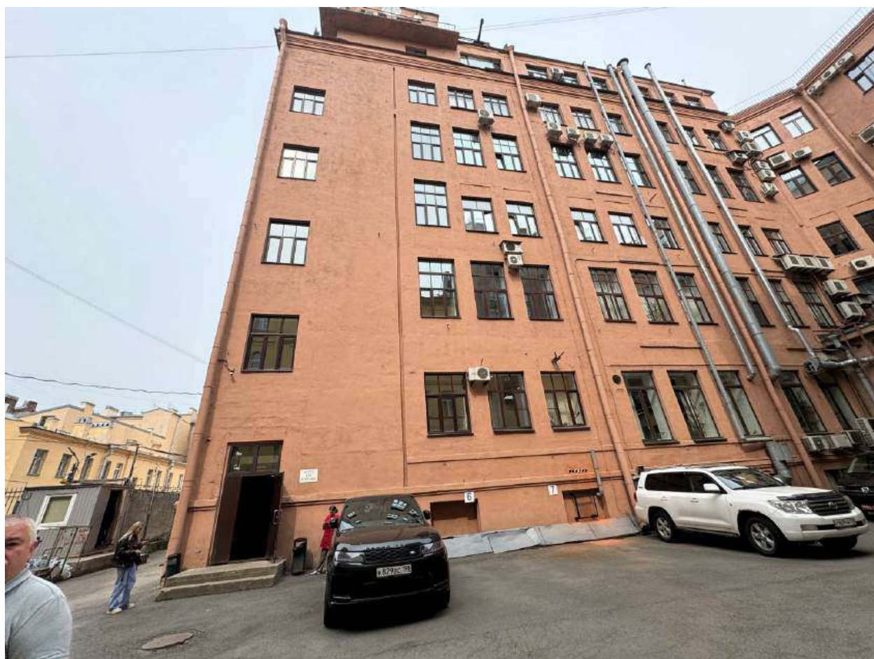
Фото 7. Вид на дворовые фасады объекта культурного наследия.
