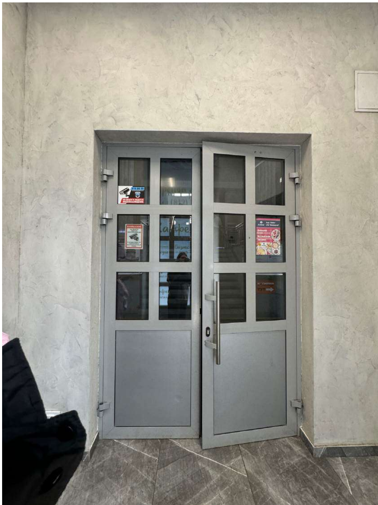
Фото 112. Вид на дверное заполнение объекта культурного наследия.
