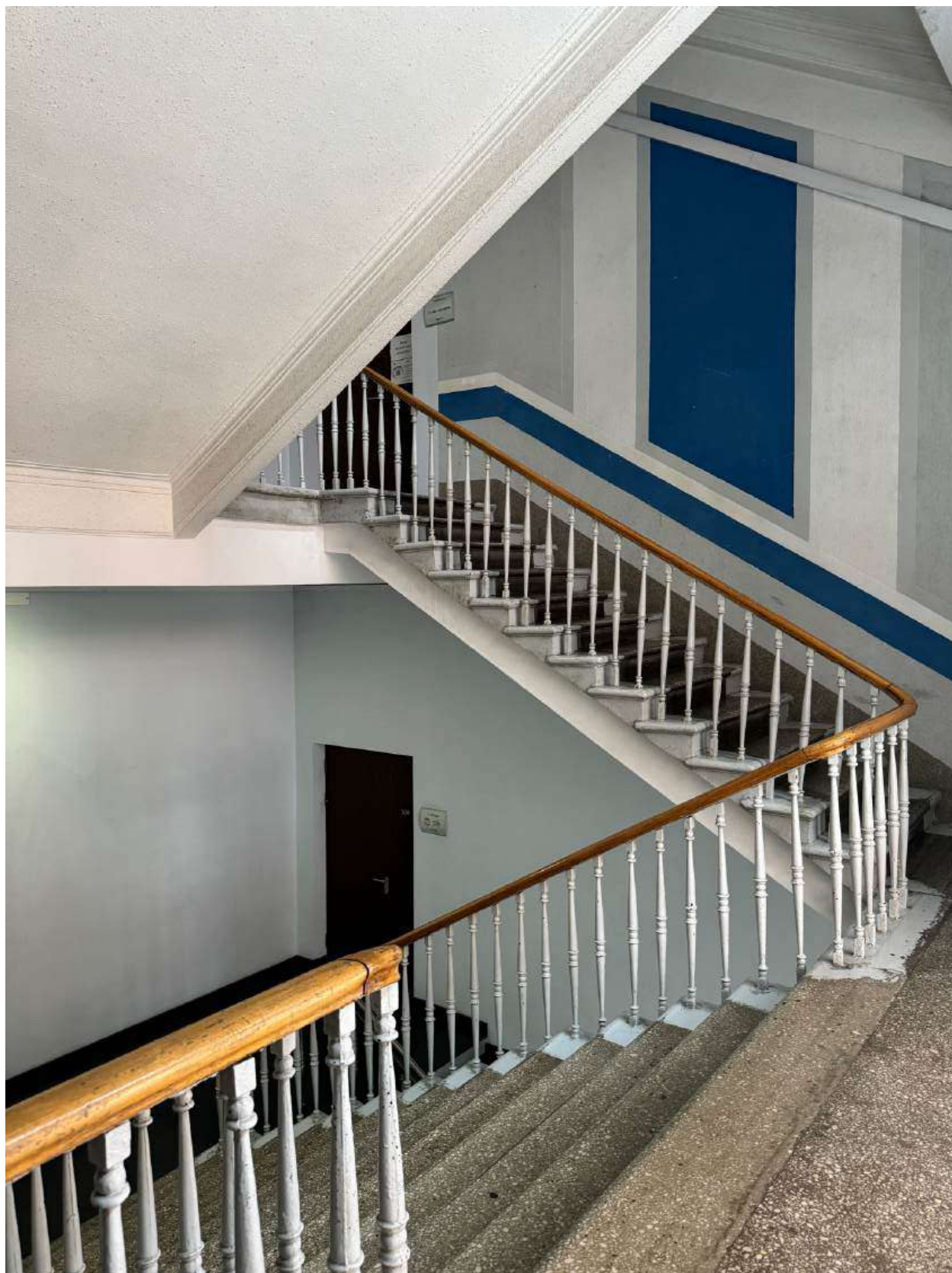
Фото 67. Вид на парадную лестницу объекта культурного наследия.
