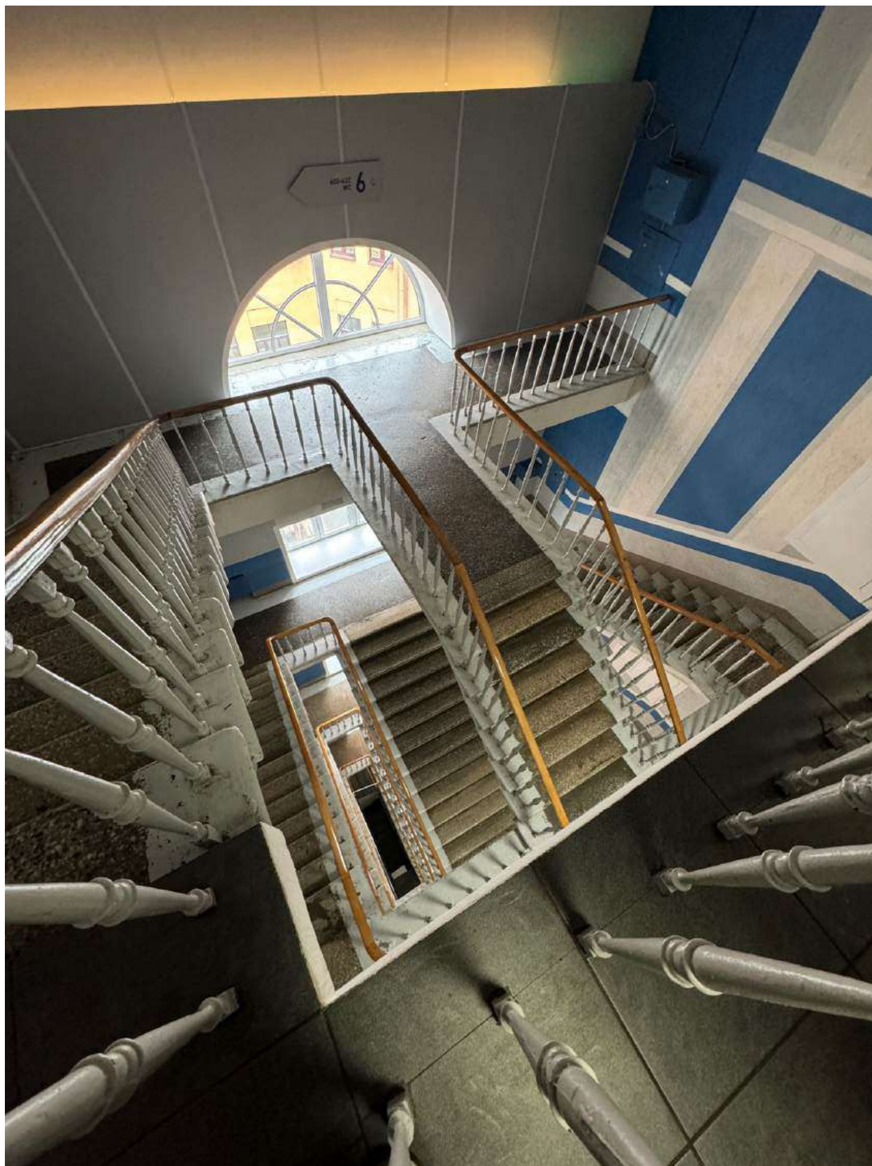
Фото 12. Вид на парадную лестницу объекта культурного наследия.
