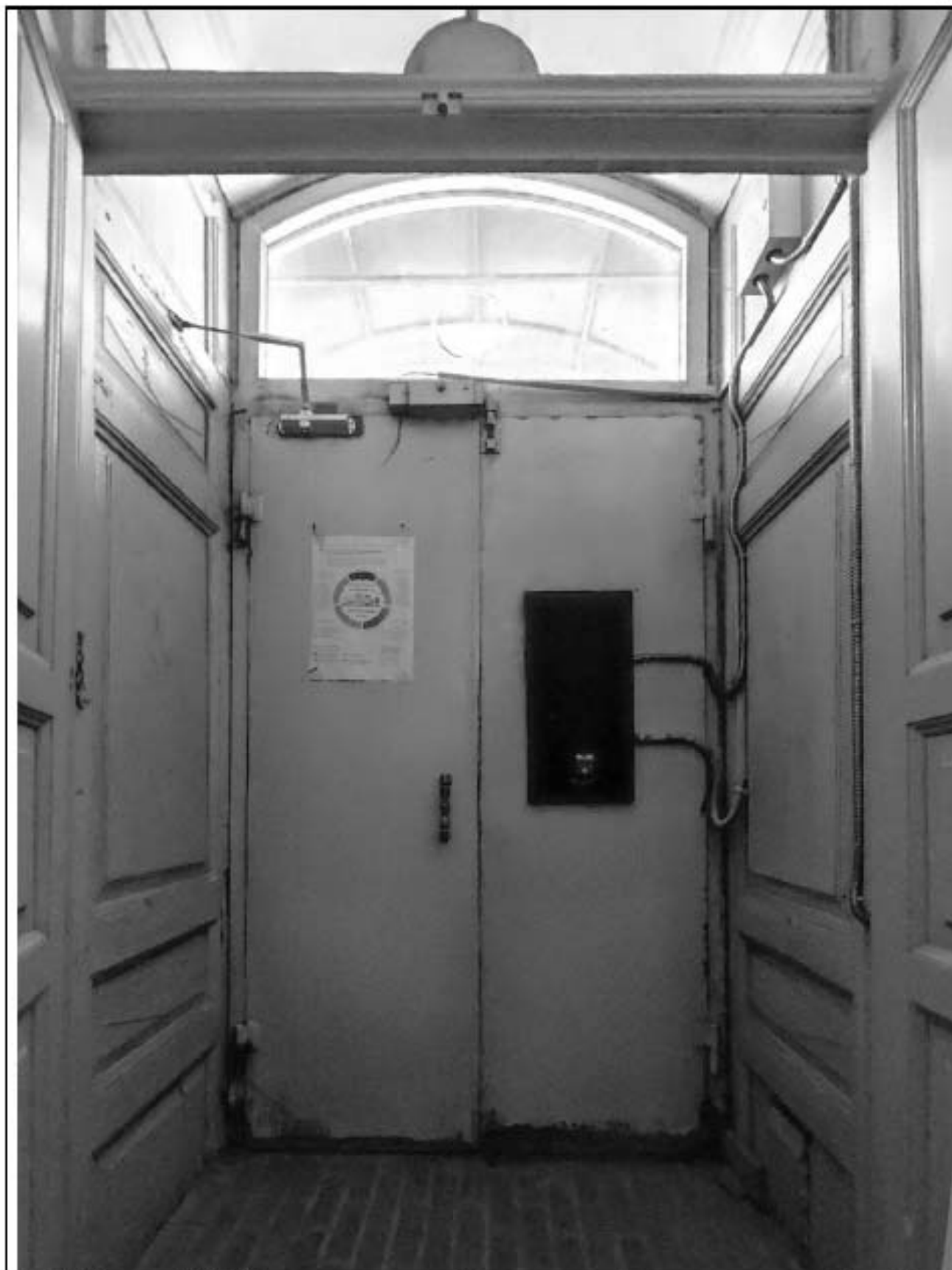
10. Подъезд № 2. Вид наружных дверей изнутри, вид боковых стенок тамбура. Дата съемки: 17.09.2025.
