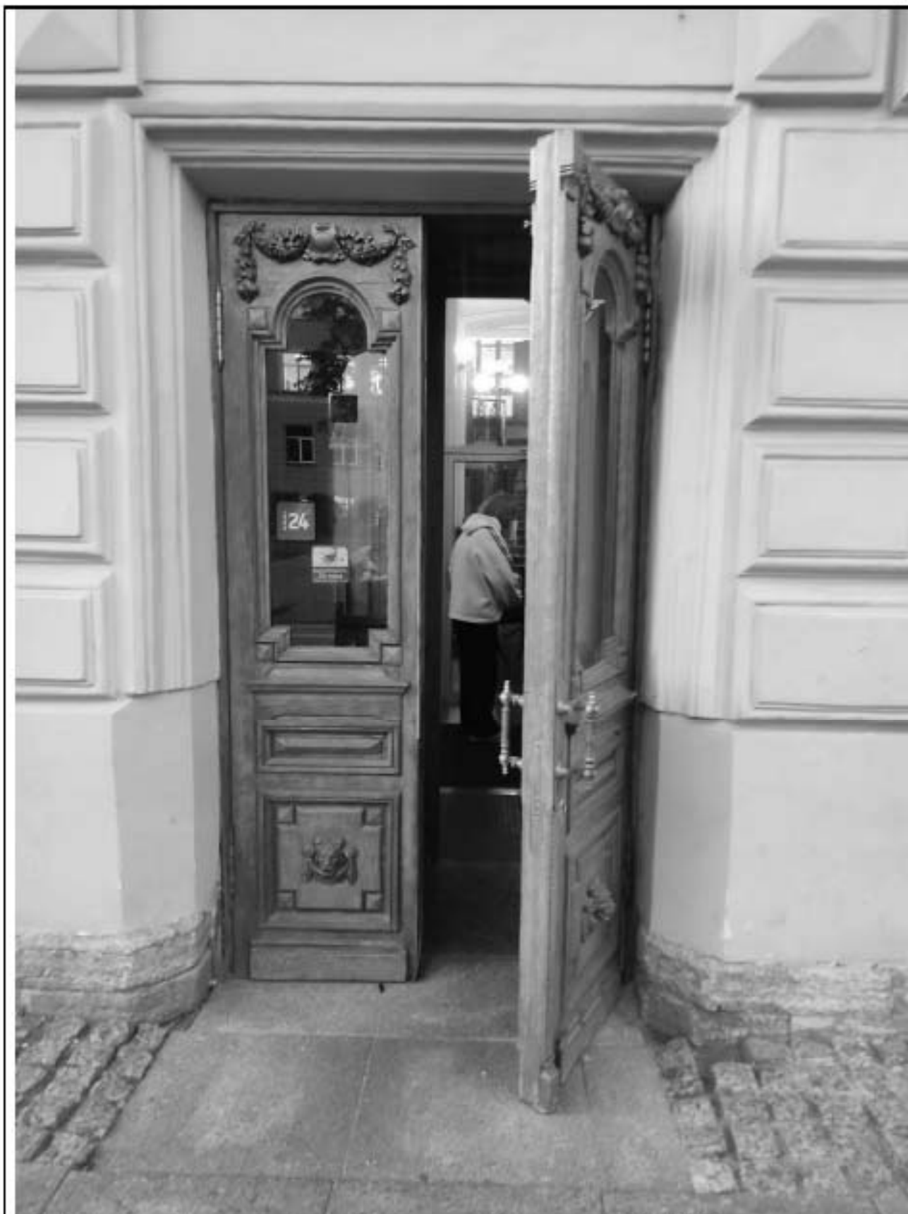
8. Восточный подъезд. Современные двери. Дата съемки: 02.09.2025.
