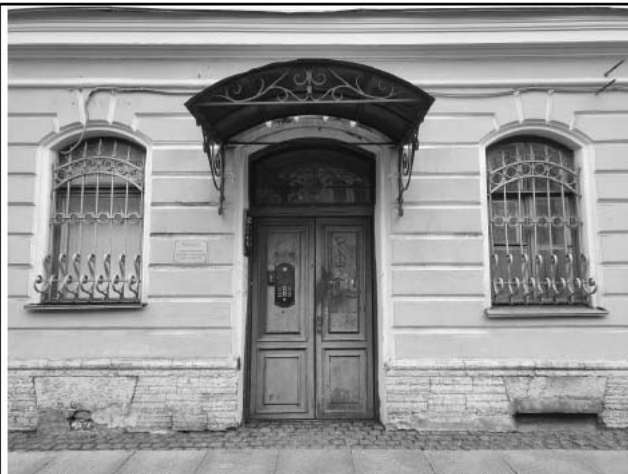
5. Подъезд № 2. Вид дверей и козырька спереди. Дата съемки: 04.09.2025.
