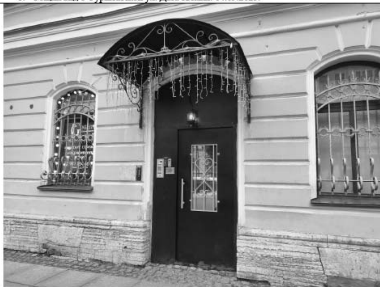
2. Подъезд № 1. Вид дверей и козырька. Дата съемки: 04.09.2025.
