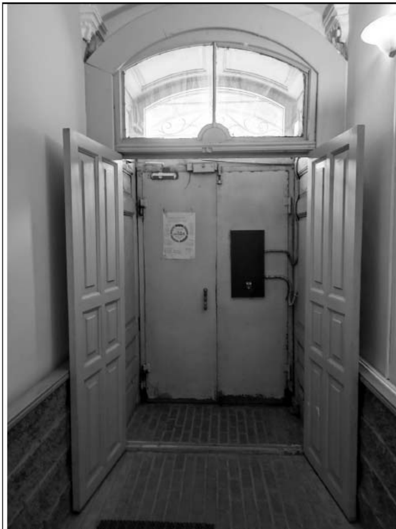
9. Подъезд № 2. Вид тамбура с исторической фрамужой и внутренними дверей (современные). Дата съемки: 17.09.2025.
