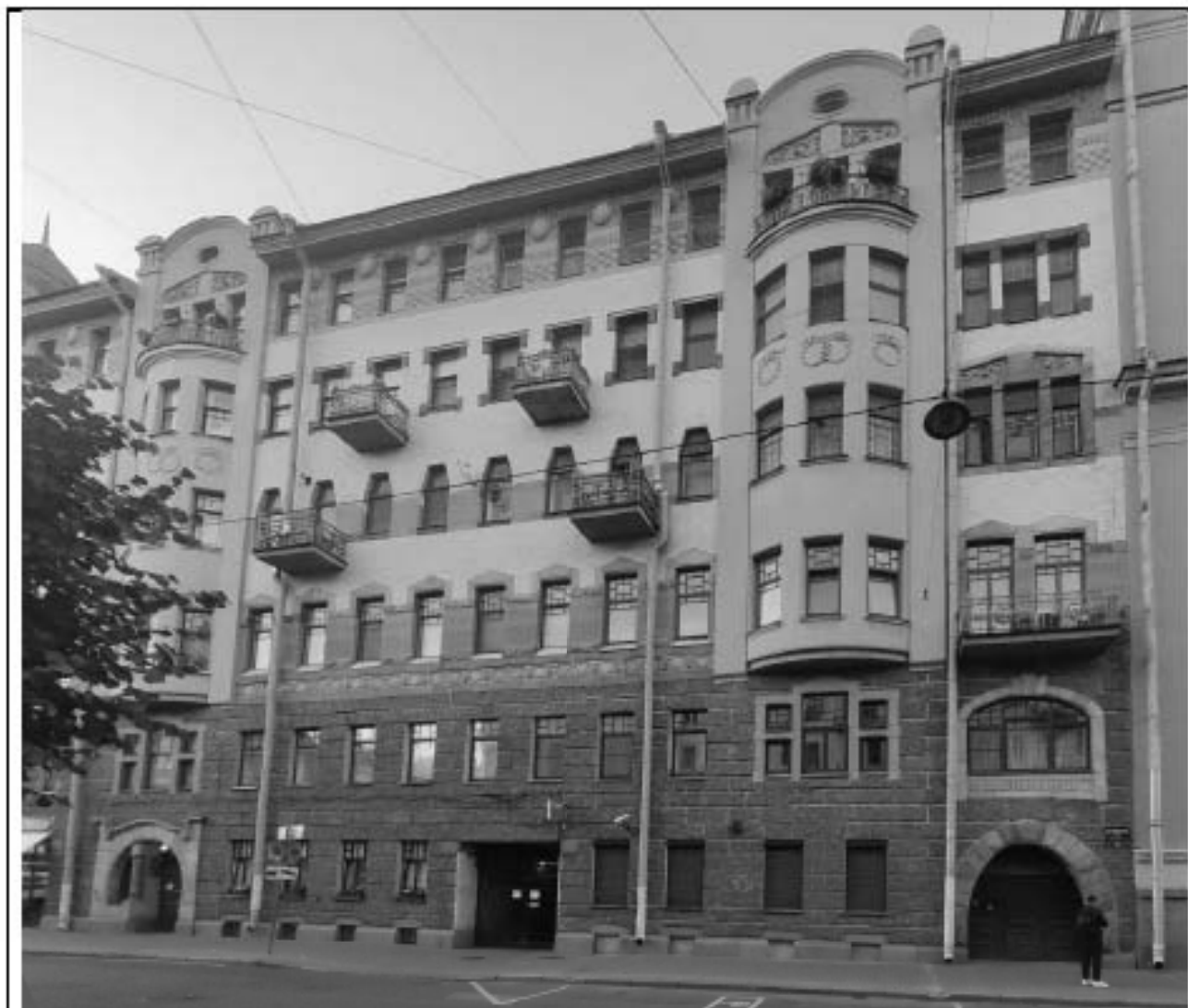
2. Фасад по Захарьевской улице. Дата съемки: 02.09.2025.
