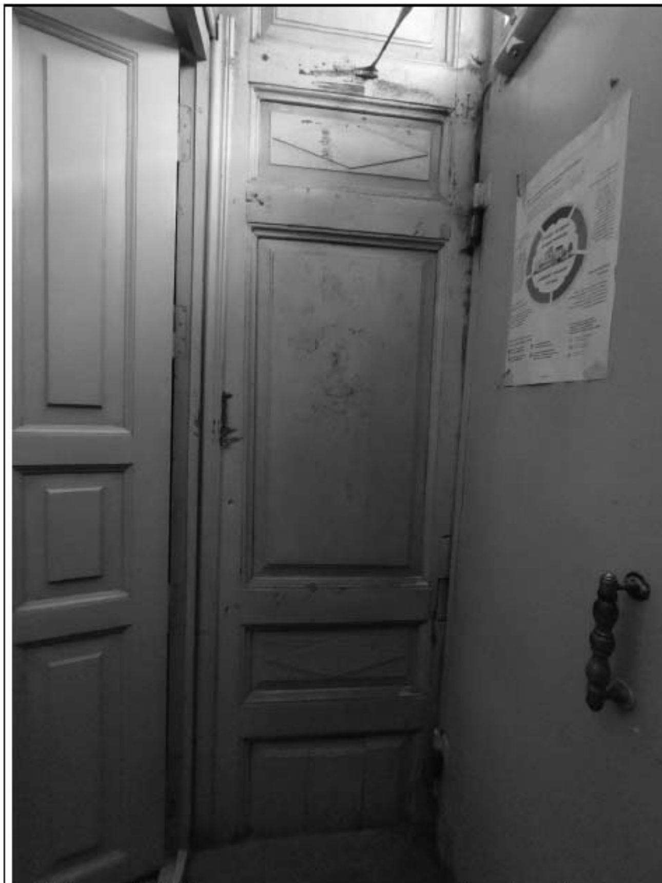
12. Подъезд № 2. Вид исторических столярных панелей тамбура. Дата съемки: 17.09.2025.
