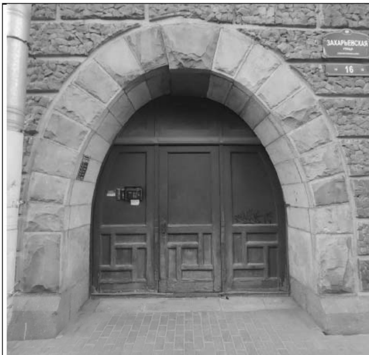
3. Подъезд № 2. Вид дверей снаружи. Дата съемки: 02.09.2025.
