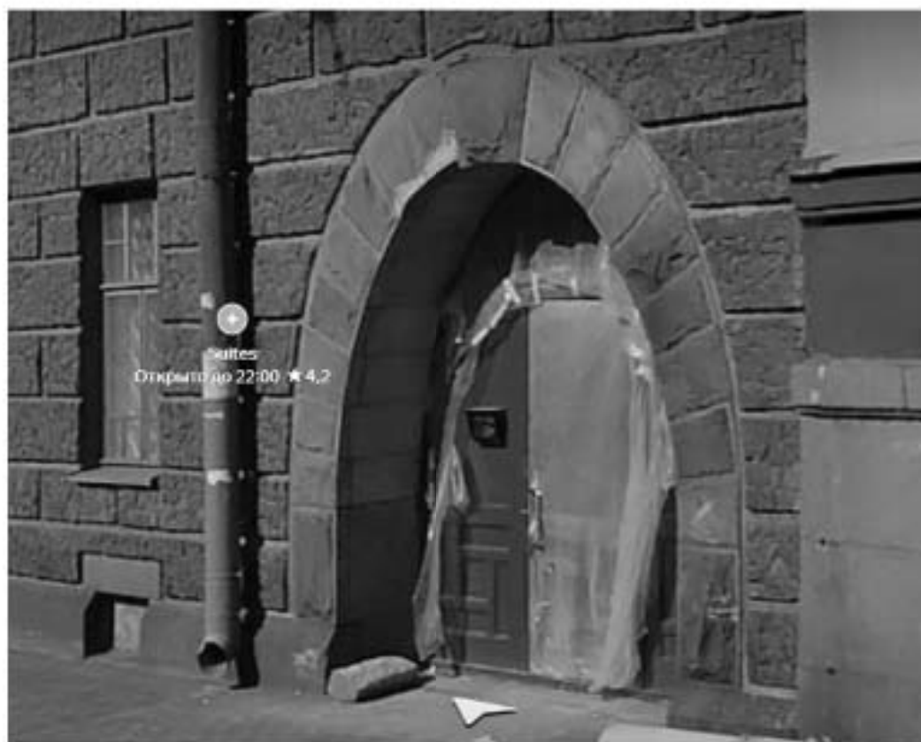
64. 2009 г. Двери заменены. Выполнен ремонт трещины кладки арки. Источник. Яндекс-панорамы.
