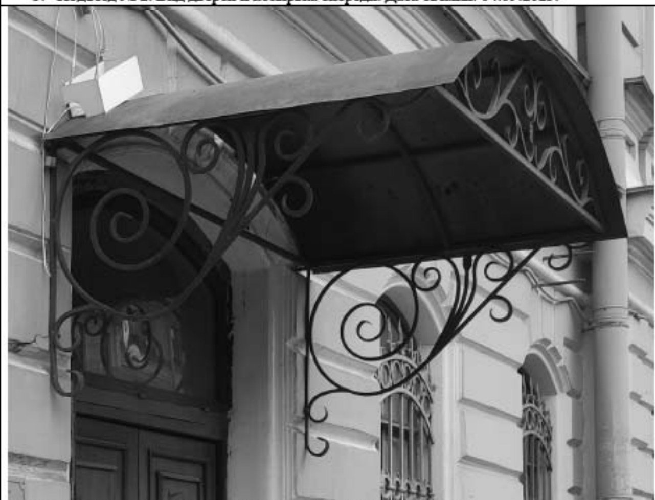
6. Подъезд № 2. Вид козырька слева. Дата съемки: 04.09.2025.
