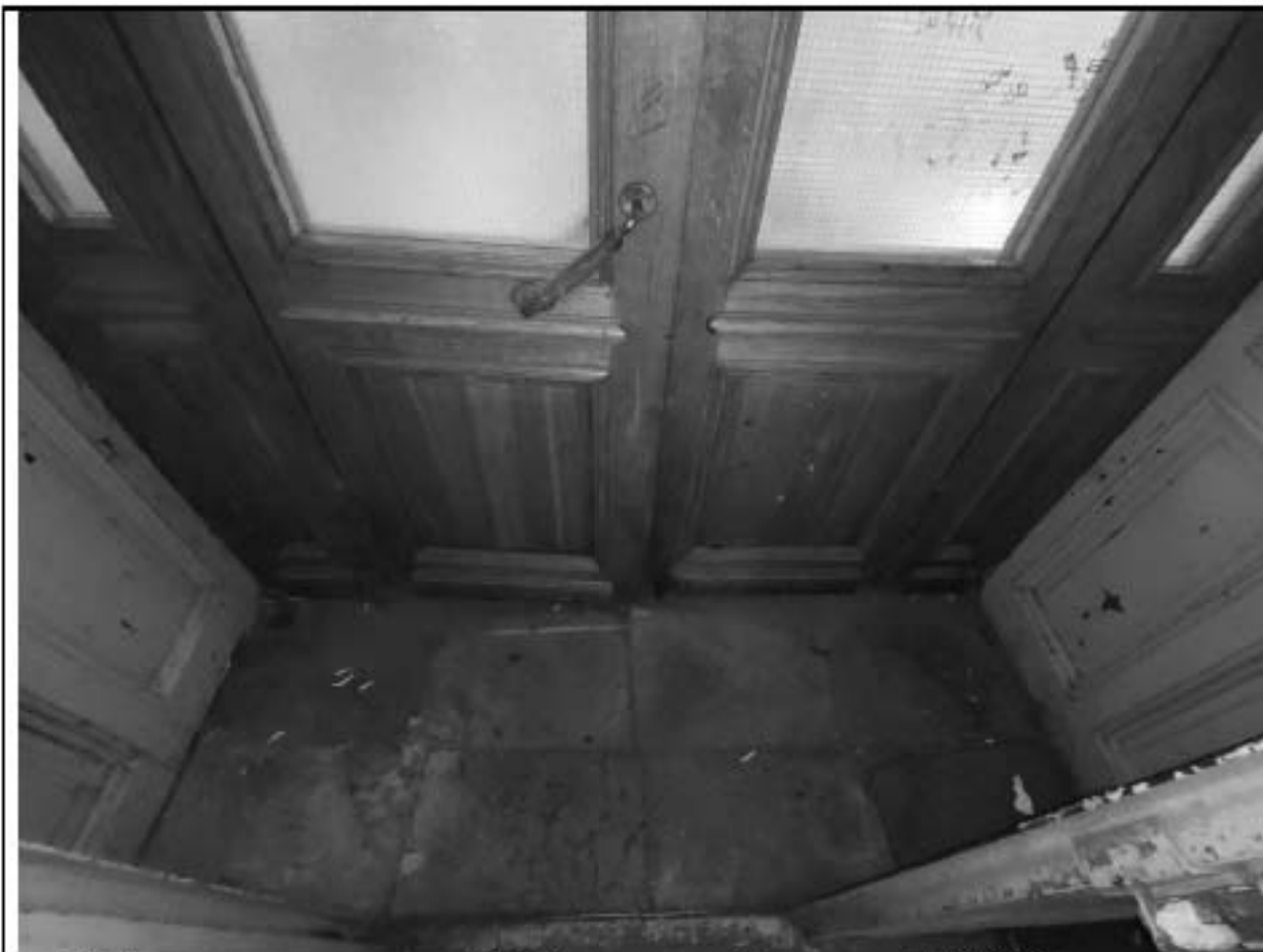
9. Наружные двери подъезда № 3. Вид изнутри. Дата съемки: 02.09.2025.
