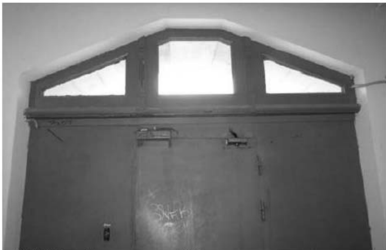
62. 2016 г. Аналог – фрамуга входа на лестницу № 6. Вид изнутри.
