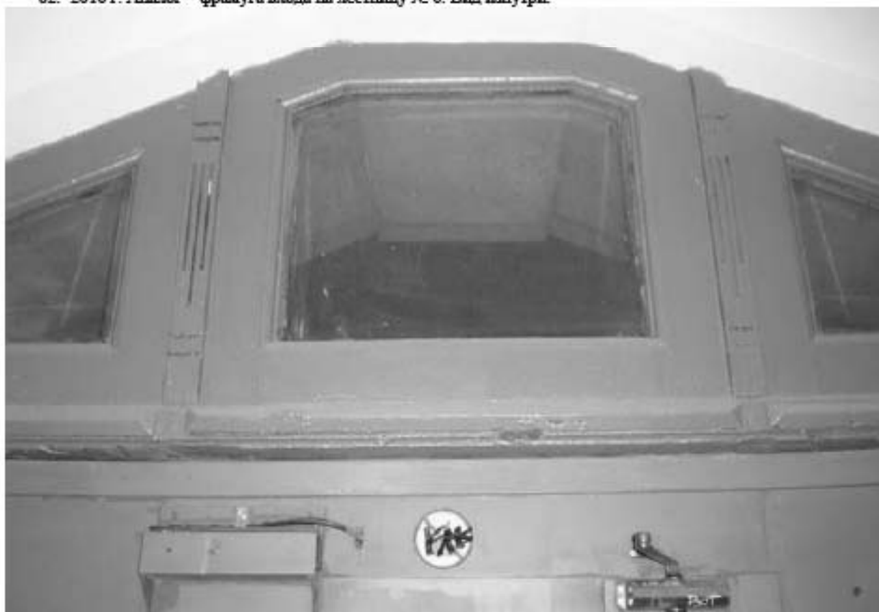
63. 2016 г. Аналог – фрамуга входа на лестницу № 6. Вид изнутри. Стекла с фацетом.
