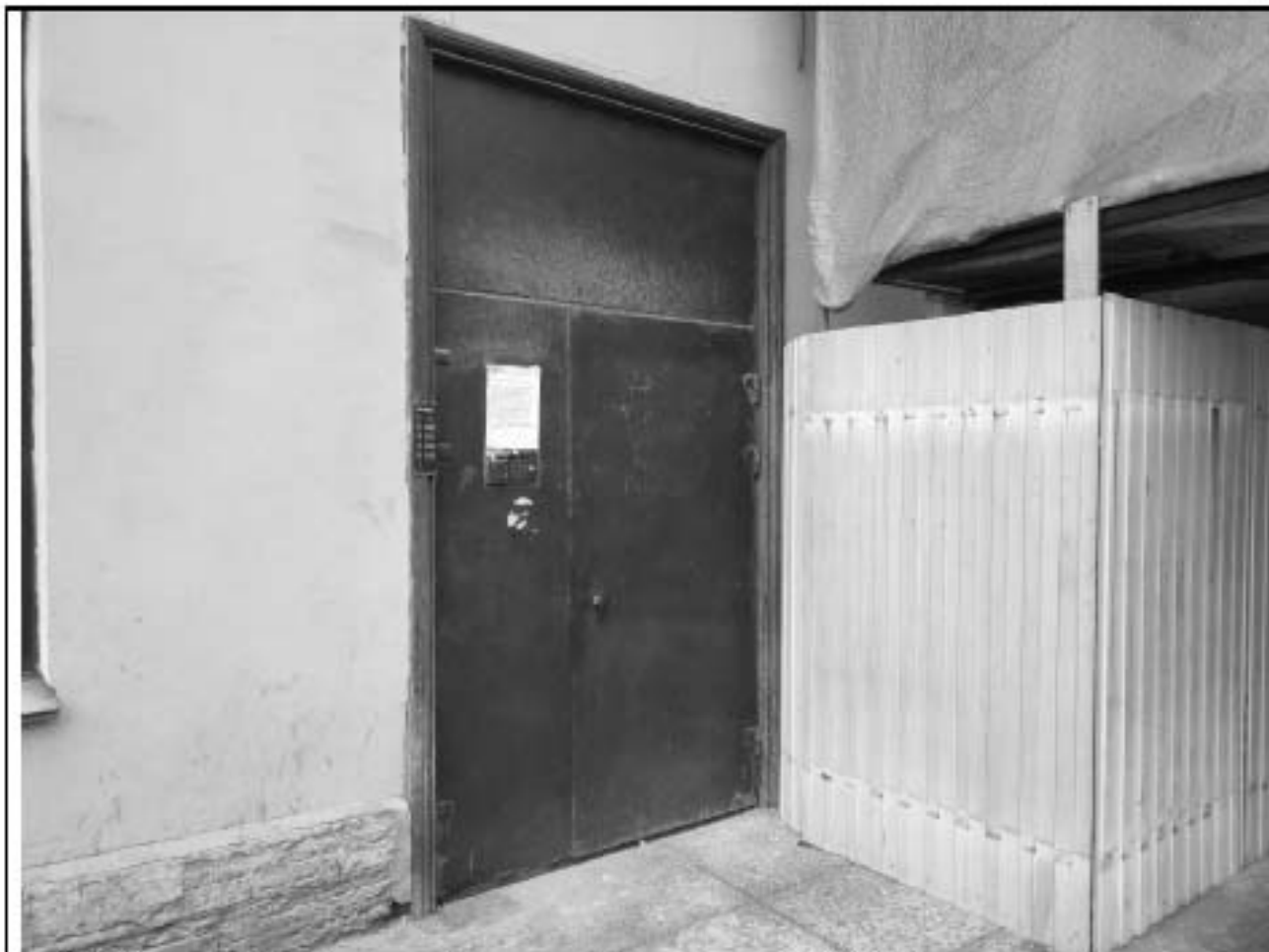
19. Подъезд № 4. Вид дверей снаружи. Дата съемки: 04.09.2025.
