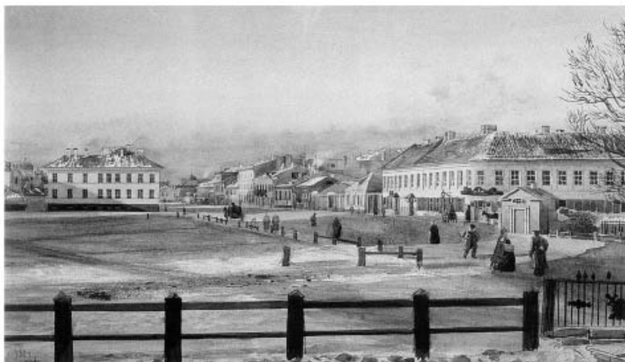
13. 1862 г. На дальнем плане слева – восточный фасад первого офицерского корпуса Преображенских казарм. «Угол Кирочной и Потемкинской улиц в Петербурге». М. Я. Виллине, акварель. ГРМ, инв. № Р-438.
