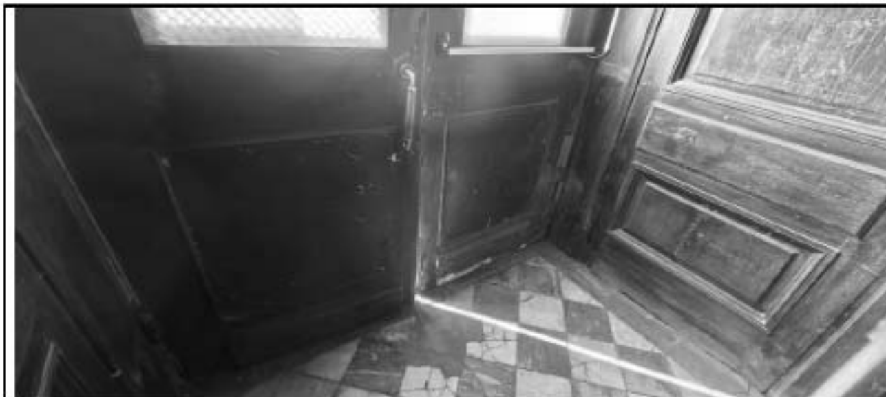
9. Парадный подъезд. Вид тамбура и наружных дверей изнутри. Дата съемки: 03.10.2025.
