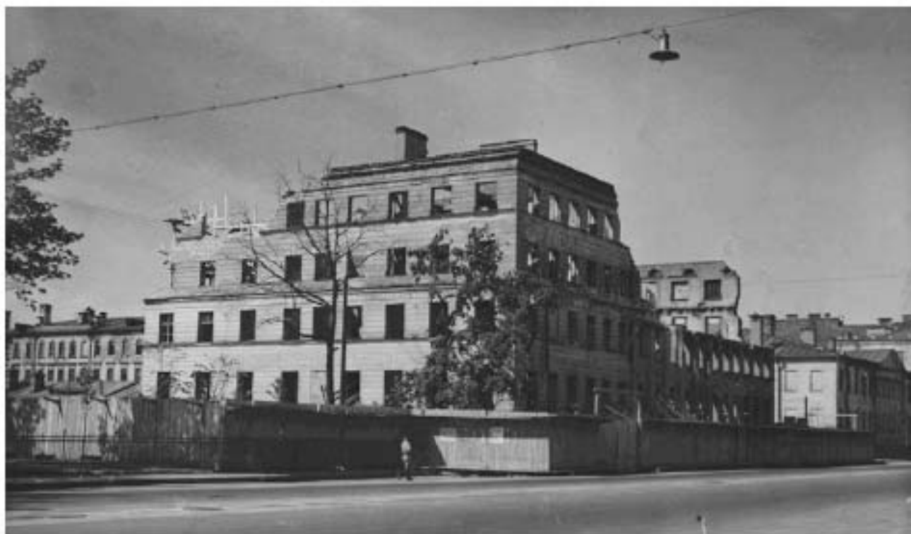
16. 1950 г. Улица Салтыкова-Щедрина, 33. Начало работ по восстановлению дома. ГМИ СПб, инв. № 371/23.
