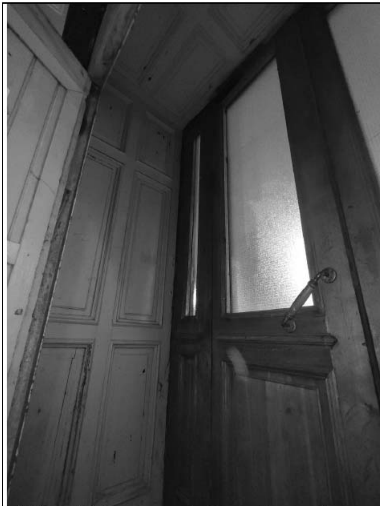
11. Подъезд № 3. Вид наружных дверей и обшивки тамбура изнутри. Дата съемки: 02.09.2025.
