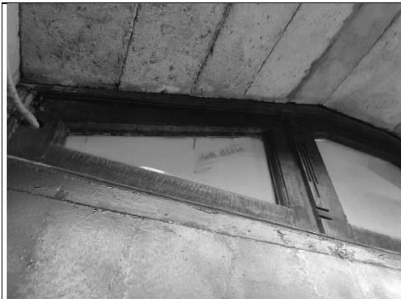
7. Подъезд № 6. Вид исторической остекленной фрамуги. Дата съемки: 02.09.2025.
