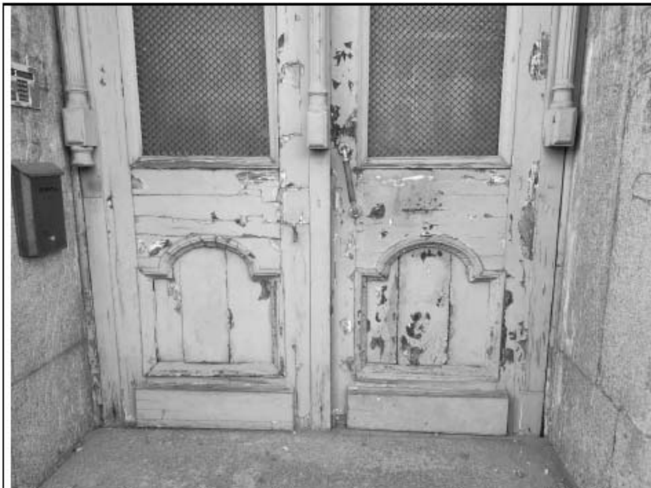
5. Парадный подъезд. Вид нижней части дверей снаружи. Дата съемки: 02.09.2025.
