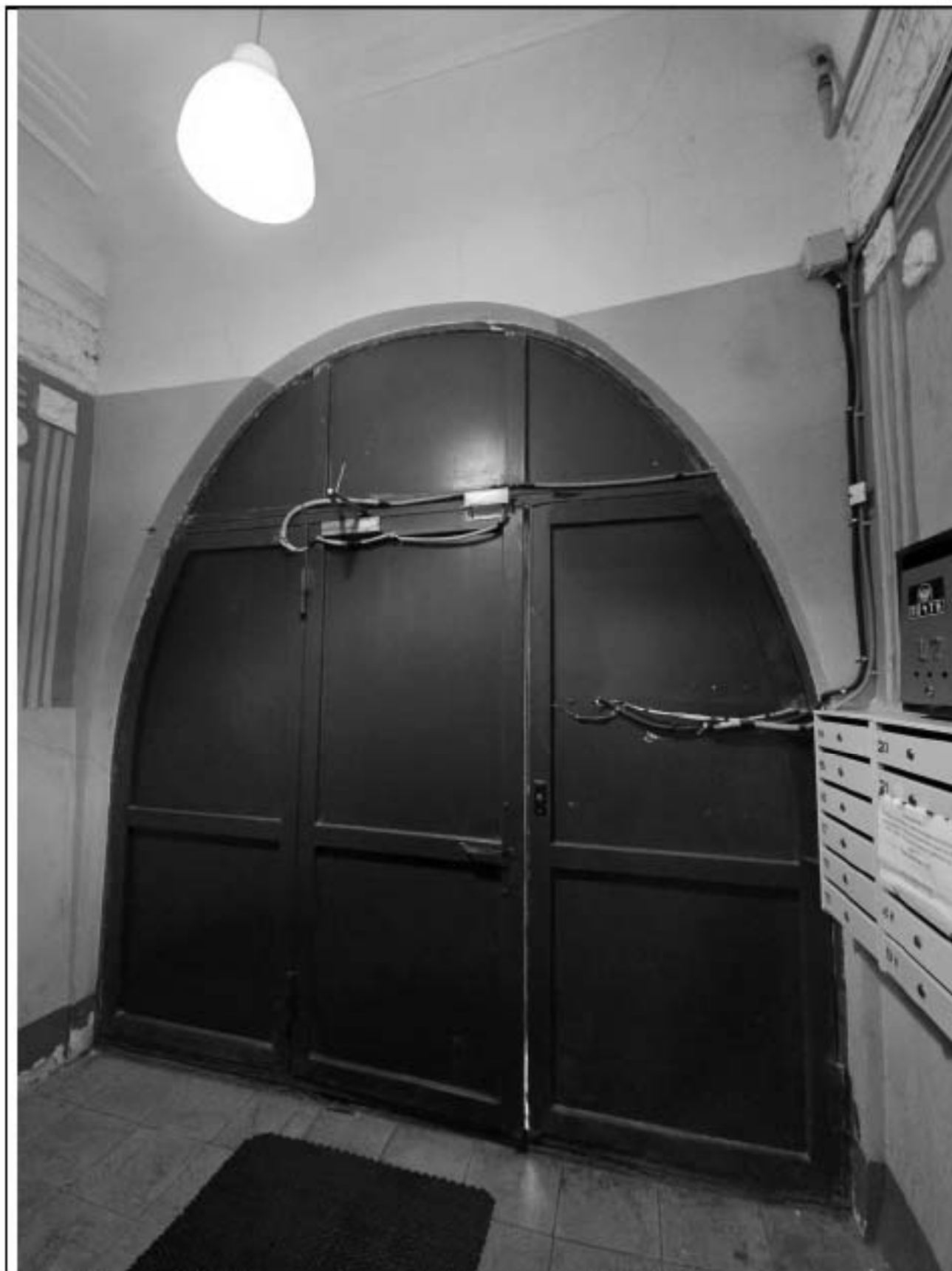
4. Подъезд № 2. Вид дверей изнутри. Дата съемки: 02.09.2025.
