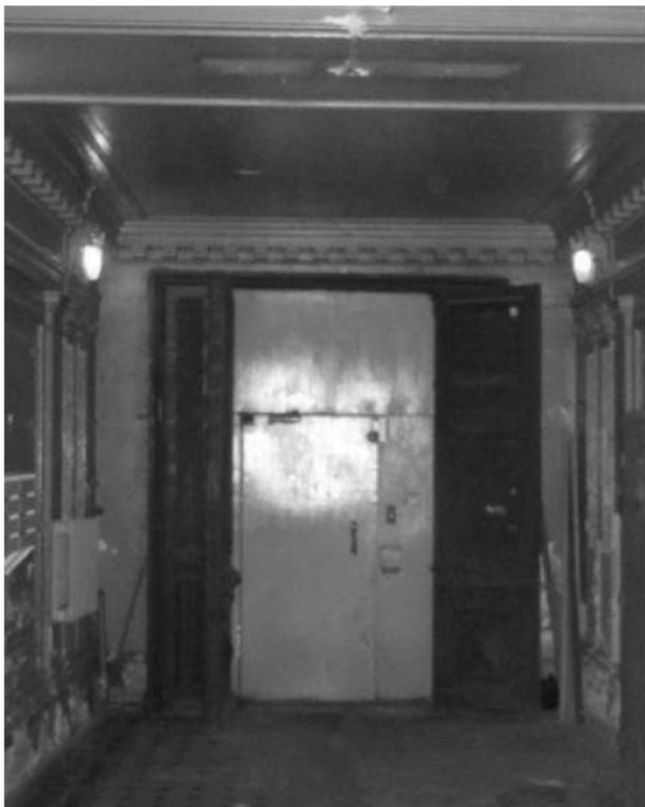
25. 2015 г. Тамбур подъезда № 3 (левый по Кировской ул.). Вид из подъезда. На 2025 г. внутренние створки утрачены, тамбур сохраняется.
