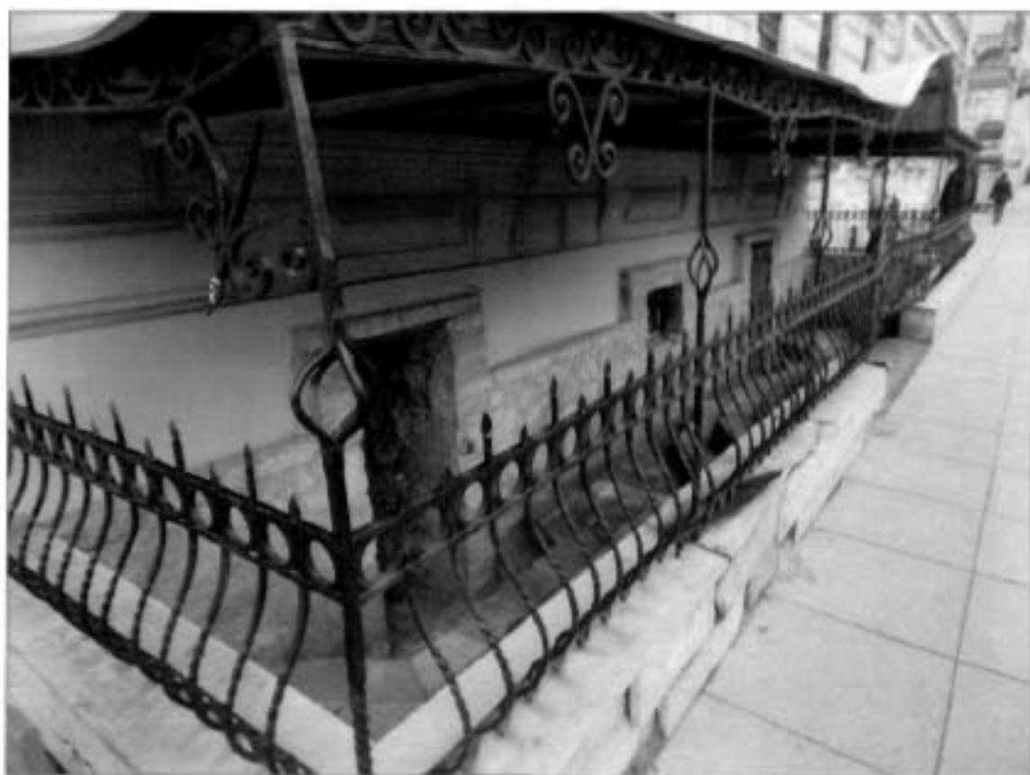
4. Лит. А. Оформление приямка южного фасада.
