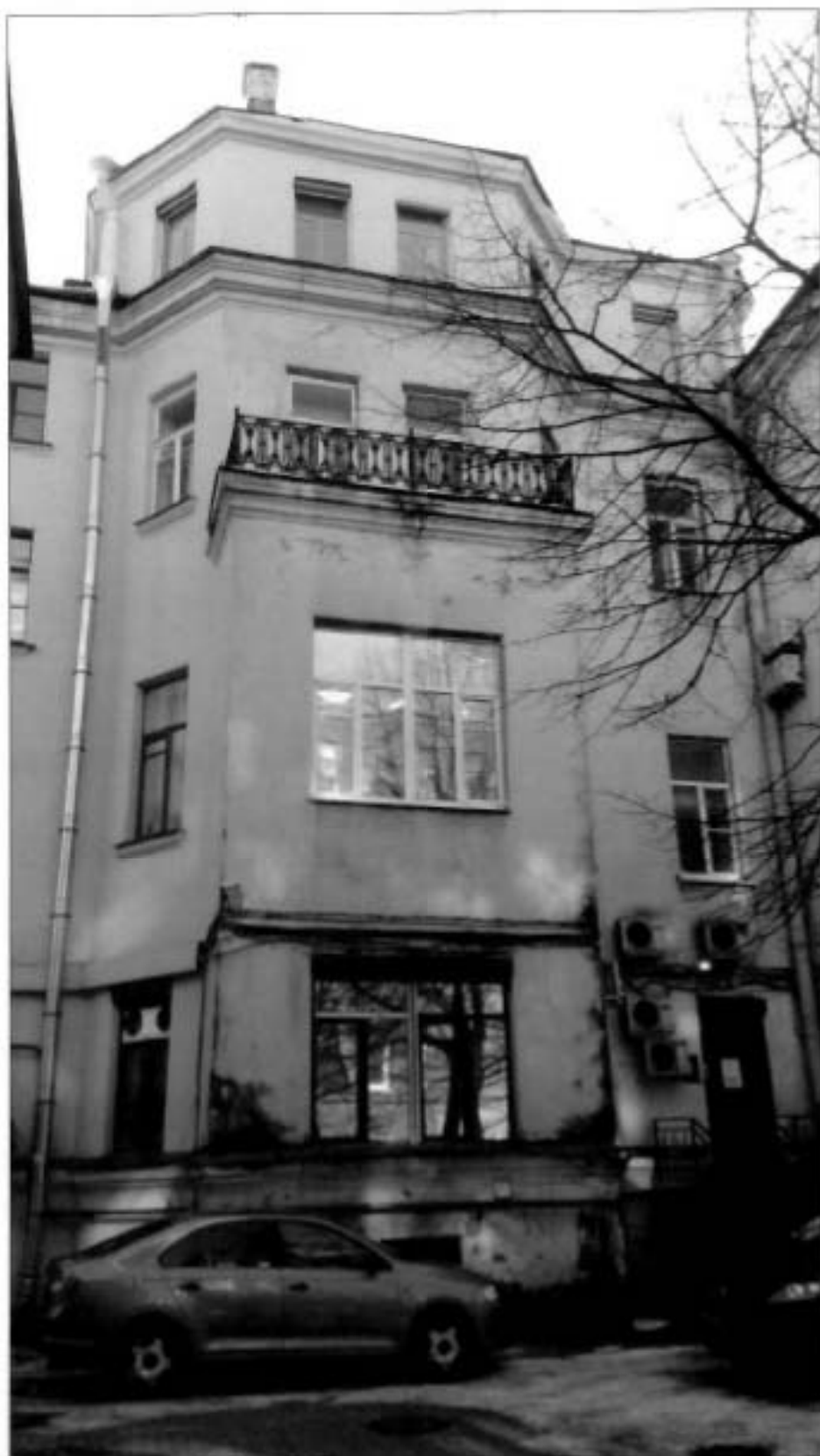
7. Лит. А. Ризалит дворового фасада.
