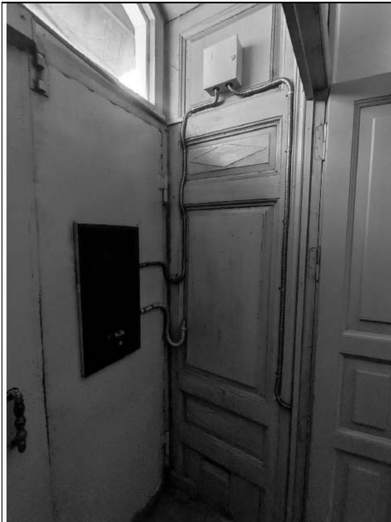
11. Подъезд № 2. Вид исторических столярных панелей тамбура. Дата съемки: 17.09.2025.
