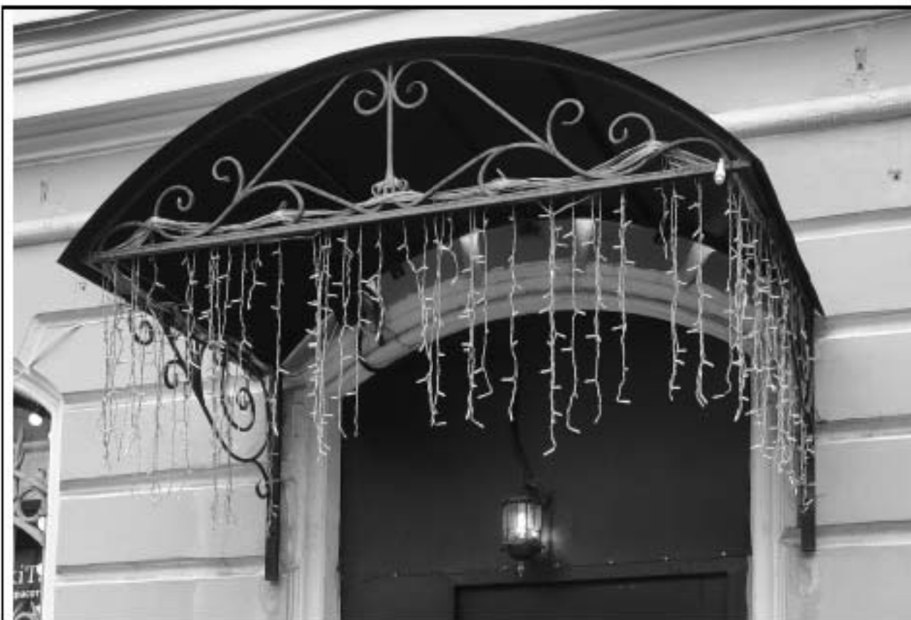
3. Подъезд № 1. Козырек. Дата съемки: 17.09.2025.
