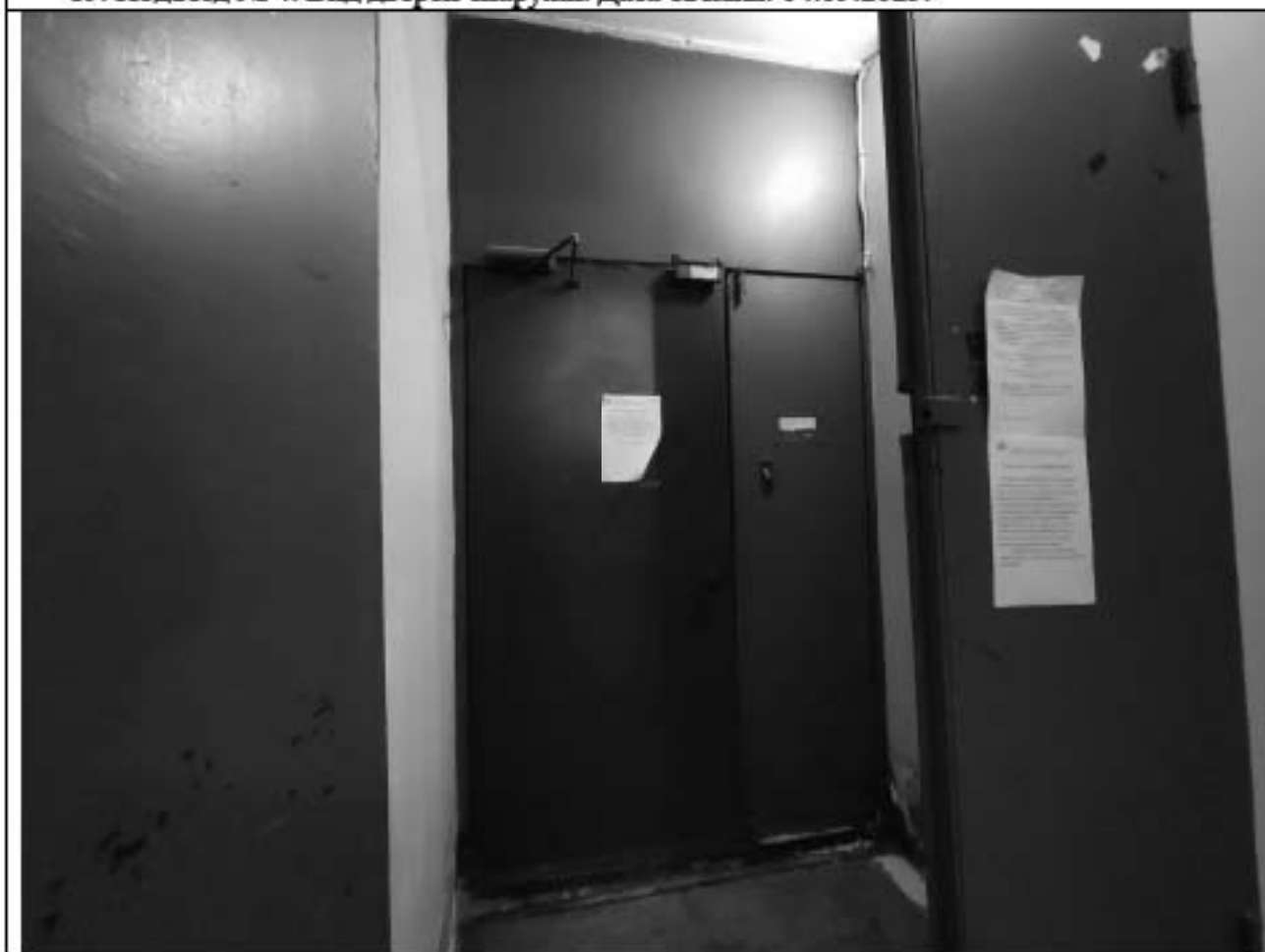
20. Подъезд № 4. Вид изнутри. Дата съемки: 08.11.2025.
