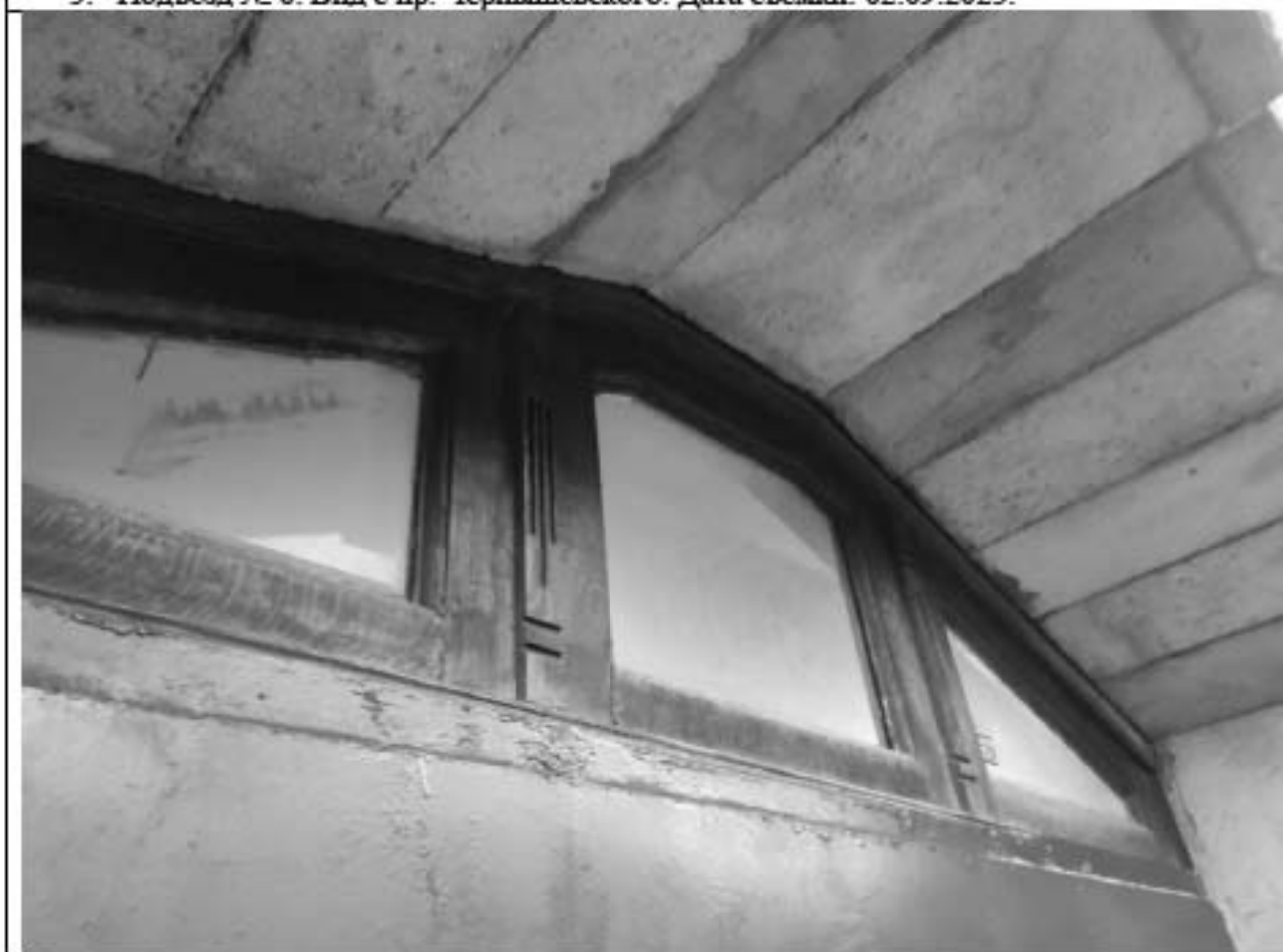
6. Подъезд № 6. Вид исторической остекленной фрамуги. Дата съемки: 02.09.2025.
