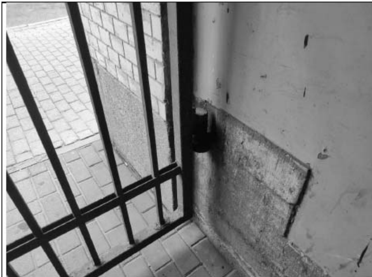
11. Вид нижних петель на левой створке ворот. Дата съемки: 04.09.2025.
