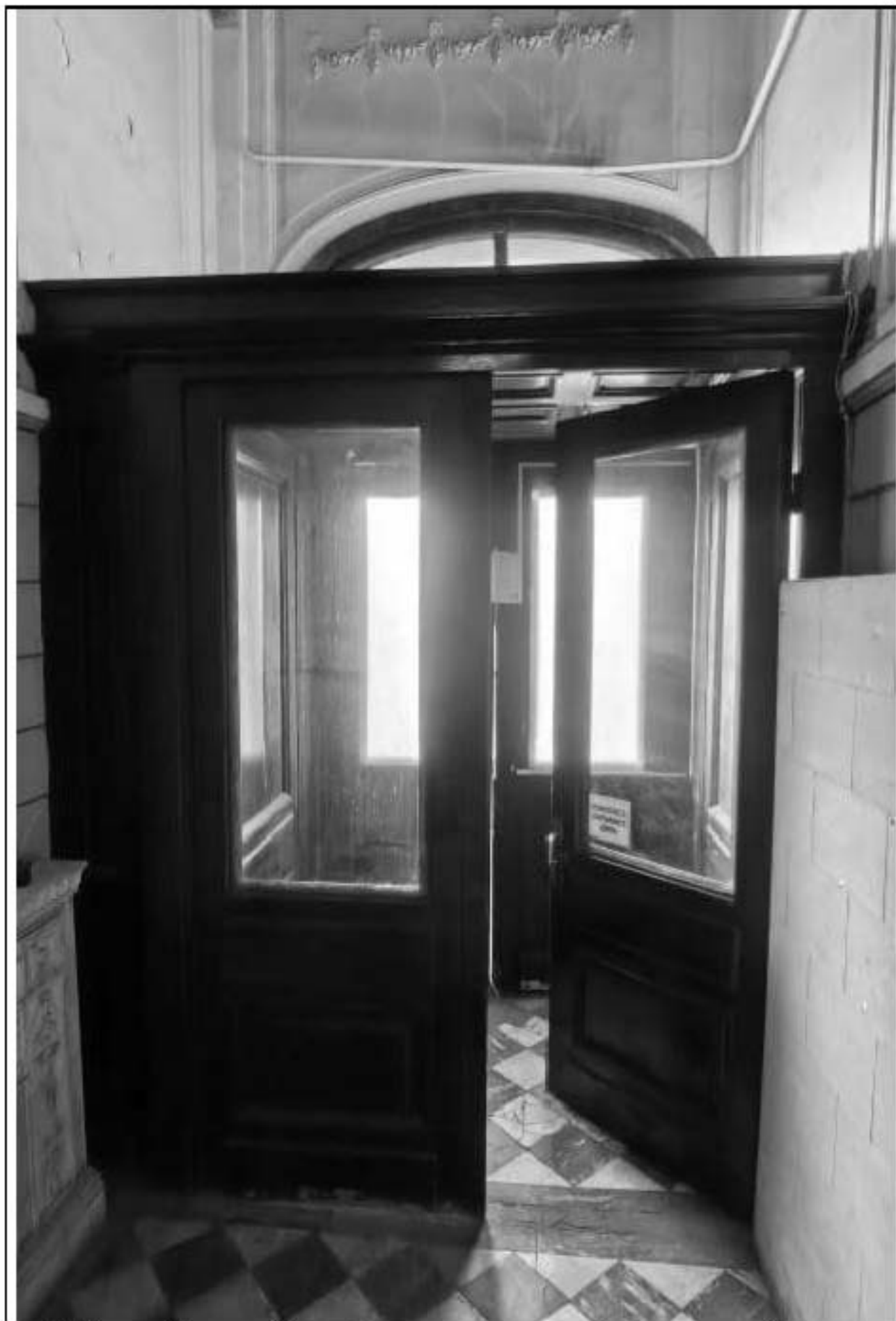
12. Парадный подъезд. Вид тамбура и внутренних дверей из помещения. Дата съемки: 03.10.2025.
