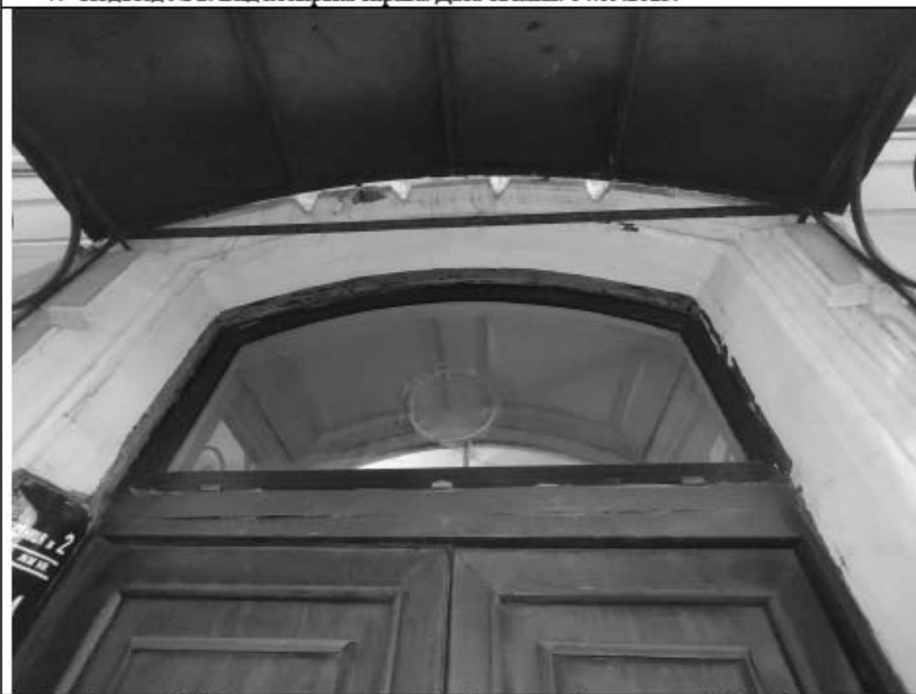
8. Подъезд № 2. Вид козырька снизу. Вид фрамуги. Дата съемки: 02.09.2025.
