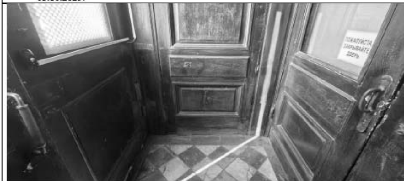
10. Парадный подъезд. Вид тамбура изнутри. Дата съемки: 03.10.2025.
