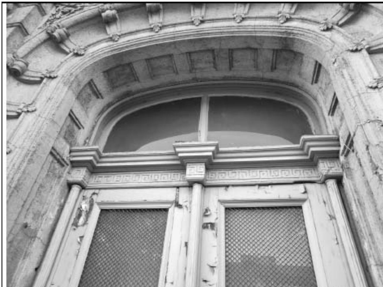
3. Парадный подъезд. Верхняя часть дверей и фрамуга. Дата съемки: 02.09.2025.
