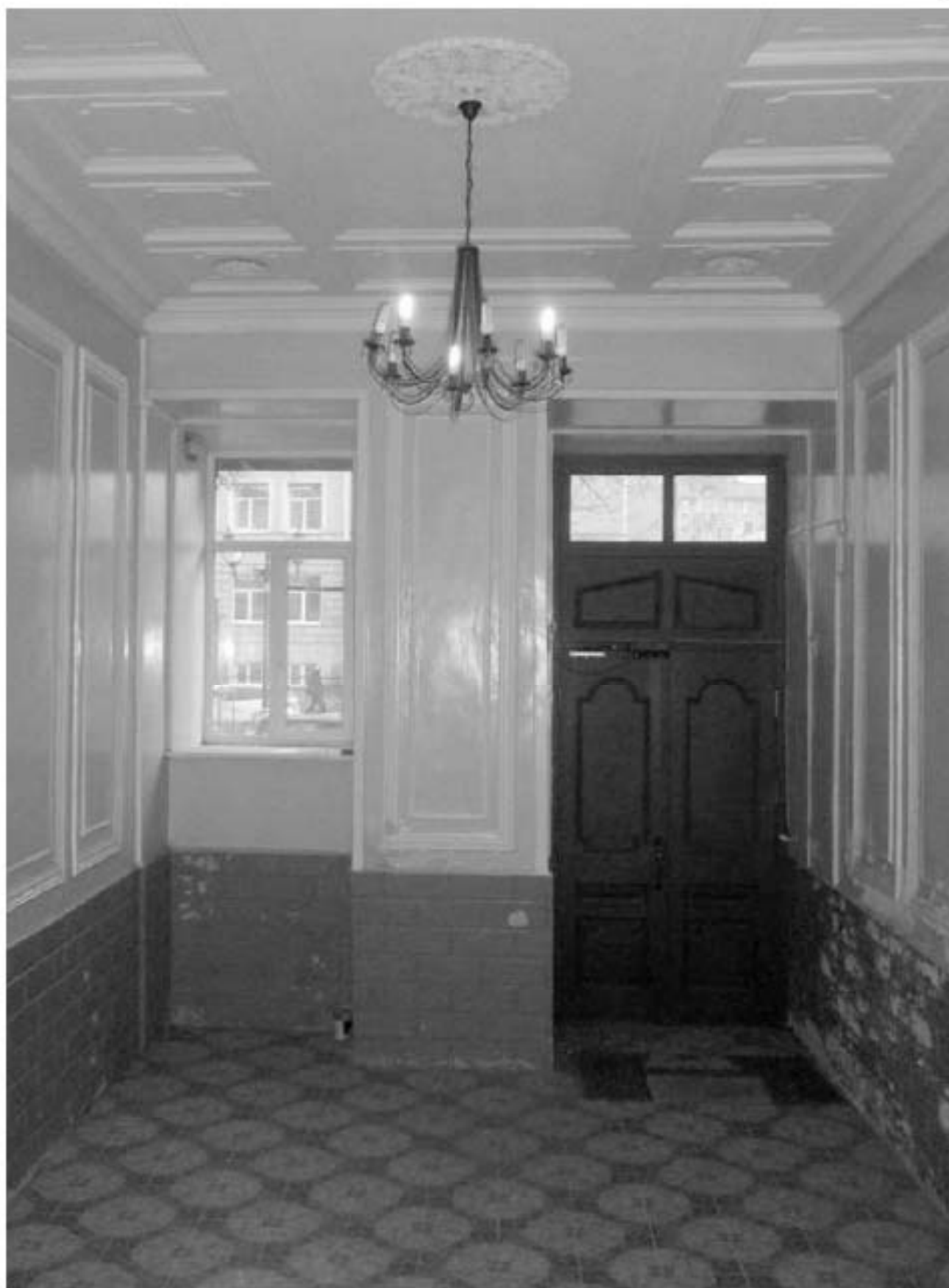
48. 2015 г. Дверь левого подъезда. Вид изнутри.
