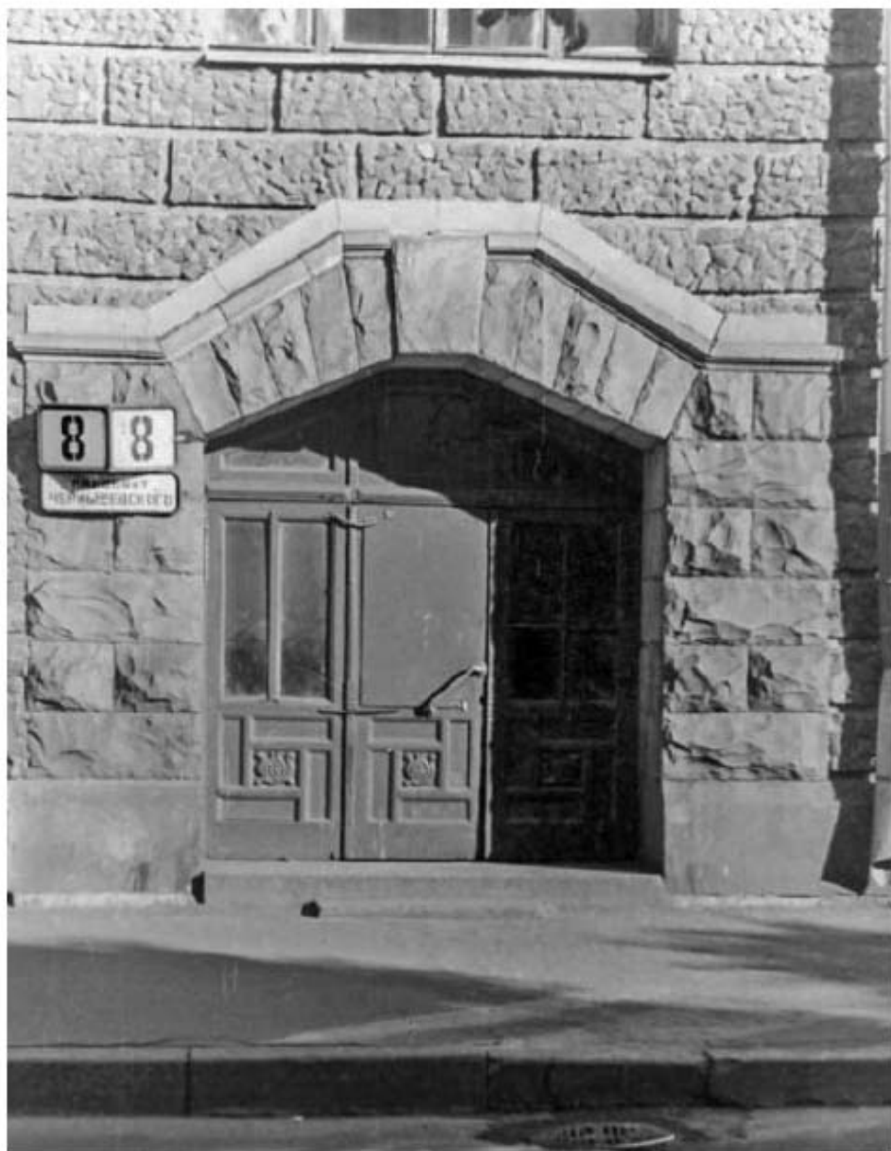
61. 1986 г. Аналог – столярное заполнение входа на лестницу № 6 (подъезд по Чернышевскому пр.). В настоящее время двери утрачены (заменены на металлические). Фрамуга сохраняется.
