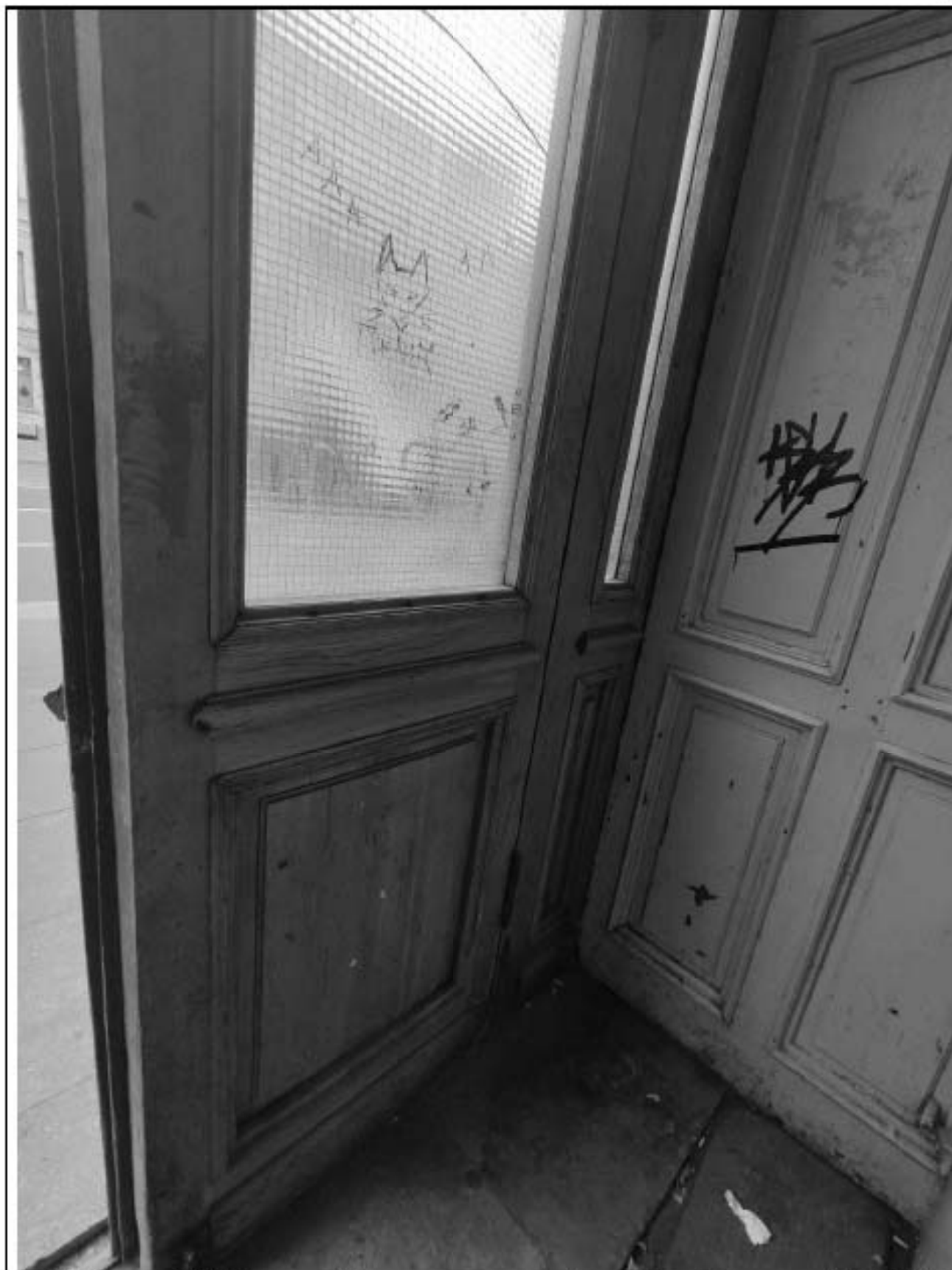
12. Подъезд № 3. Внутренний вид наружных дверей и тамбура. Дата съемки: 02.09.2025.
