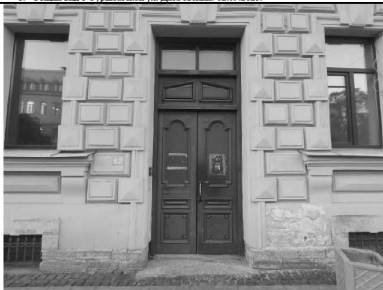
2. Западный подъезд. Дата съемки: 02.09.2025.
