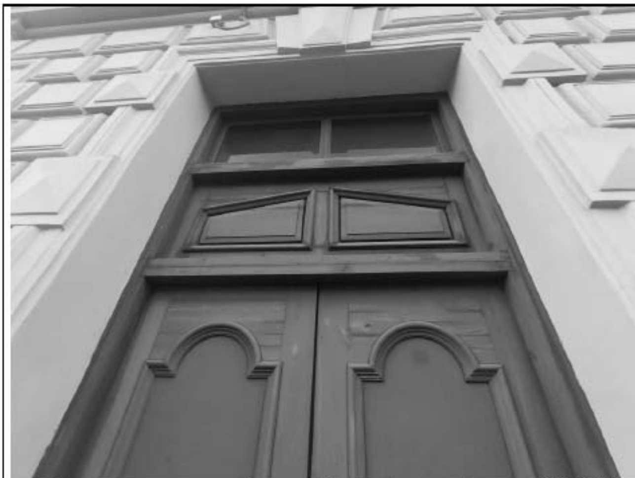
3. Двери западного подъезда. Вид верхней части и фрамуги. Дата съемки: 02.09.2025.
