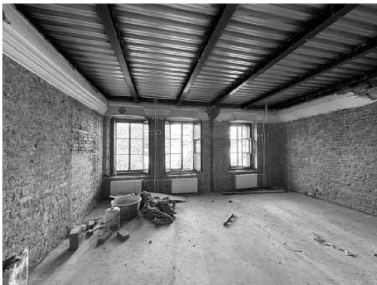
28. Объект культурного наследия федерального значения «Дом Брюллова А.П. (Сюзора П.Ю.)» по адресу: Санкт-Петербург, Кадетская линия В.О., дом 21, литера А.
