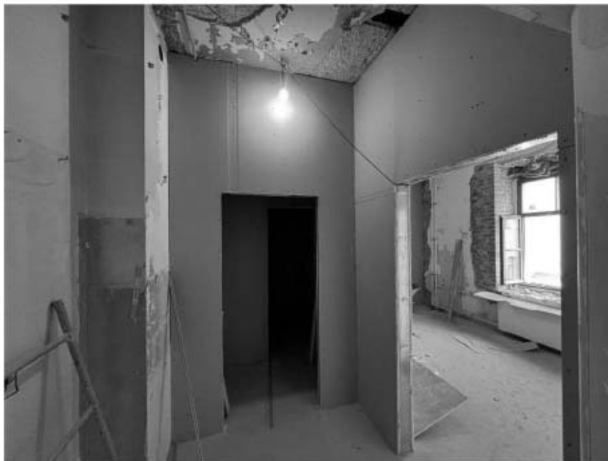
35. Объект культурного наследия федерального значения «Дом Брюллова А.П. (Сюзора П.Ю.)» по адресу: Санкт-Петербург, Кадетская линия В.О., дом 21, литера А.
