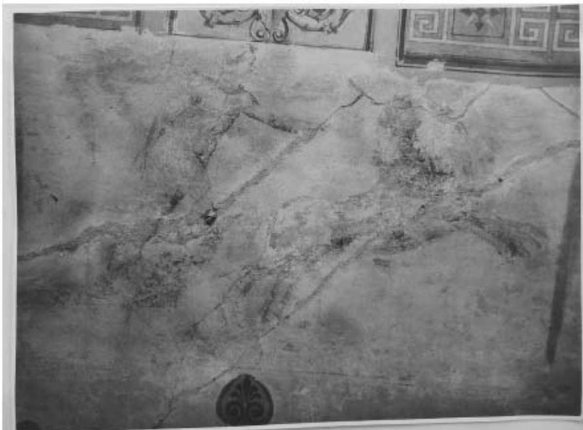
Илл. 74. Деталь первоначальной росписи (колесница Аполлона), раскрытая под шпаклевкой над центральным окном, при реставрации 1955 г. // ЦГАНТД СПб. Фонд 488. Описание 311. Дело 2.
