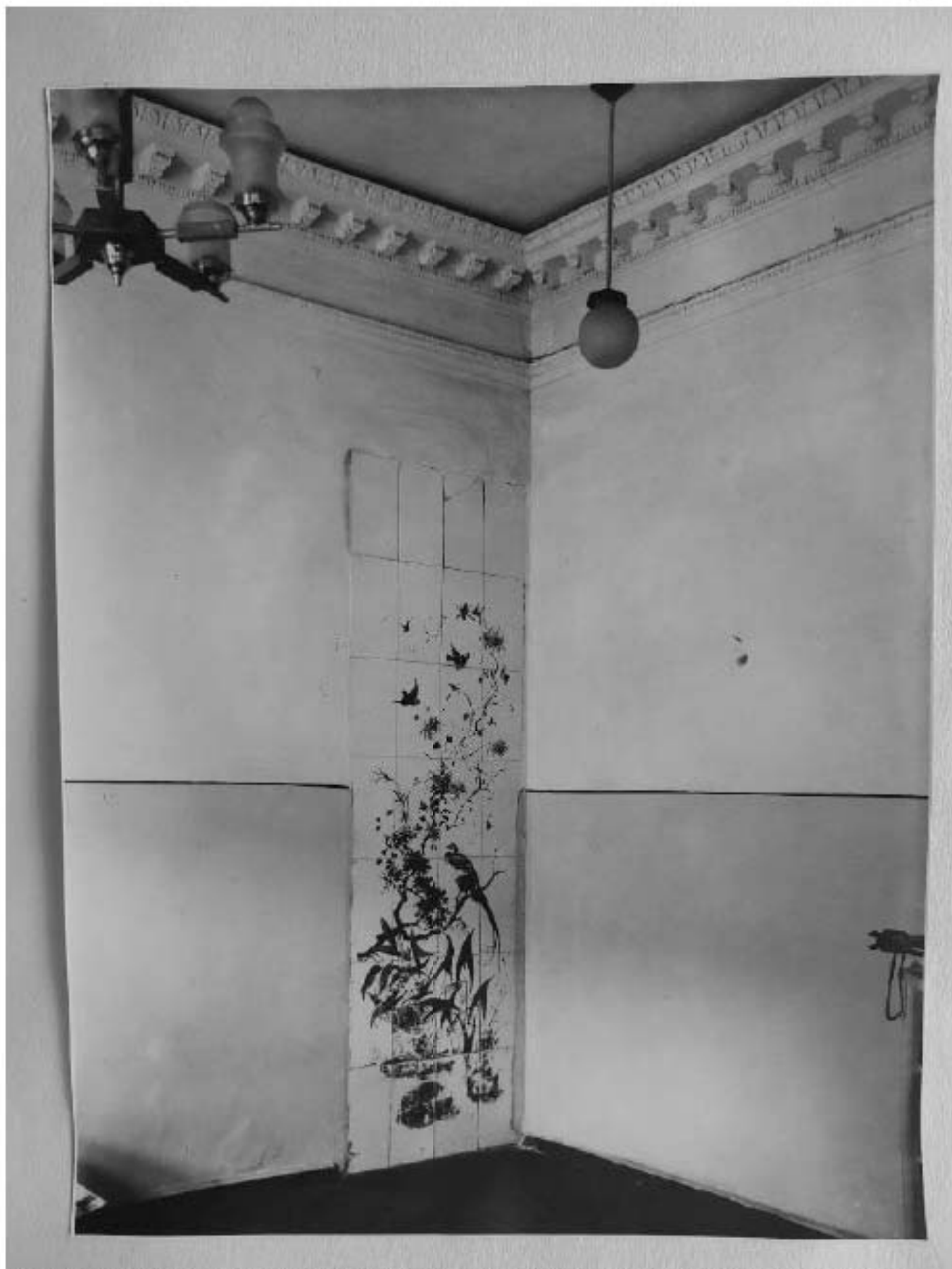
Илл. 83. Зеркало кафельной печи. Фото 1956 г. // ЦГАНТД СПб. Фонд 488. Опись 311. Дело 2.
