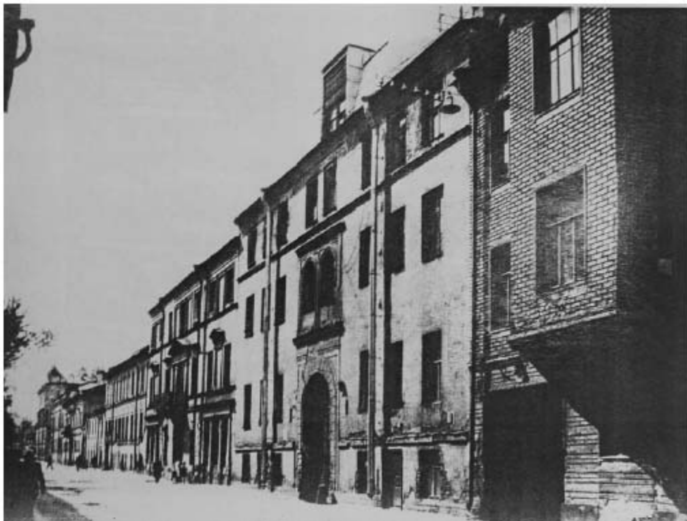
Илл. 54. Здание б. дома А.П. Брюллова. Фасад по Тучкову переулку. Период создания: 1920-е гг. //
