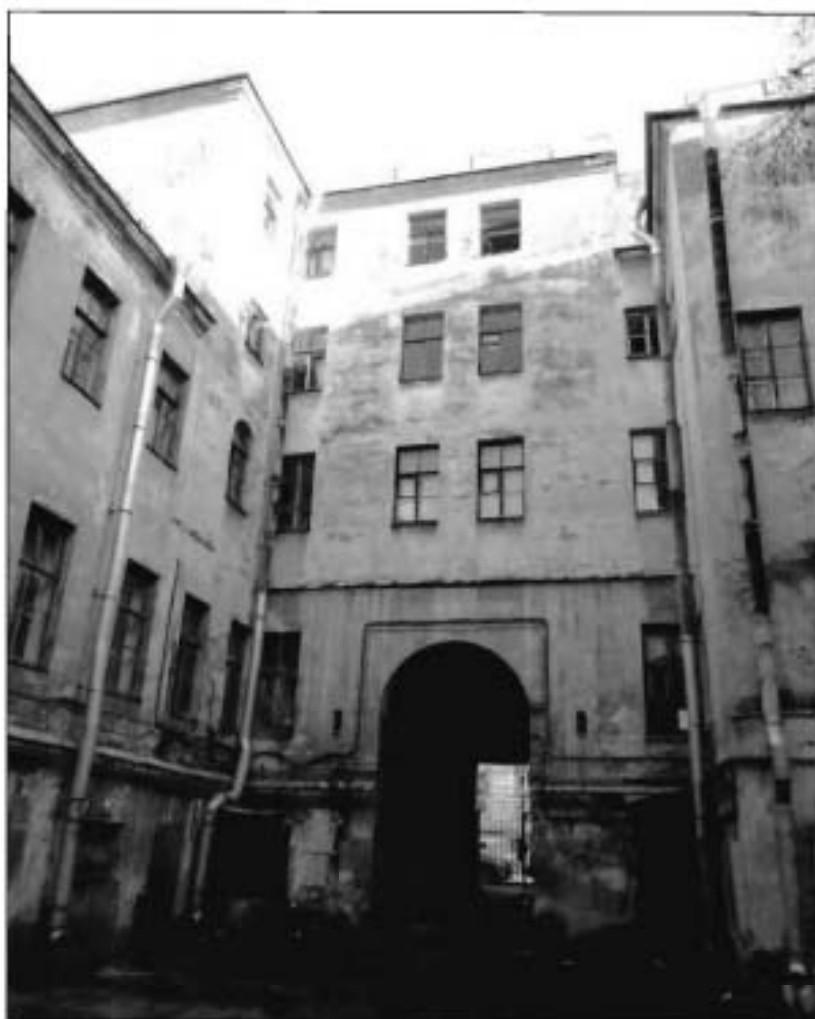
4. Фасады восточного двора объекта культурного наследия.
