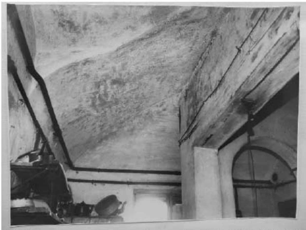
Илл. 86. Своды над помещением кухни во 2-м этаже. Фото 1956 г. // ЦГАНТД СПб. Фонд 488. Описание 311. Дело 2.
