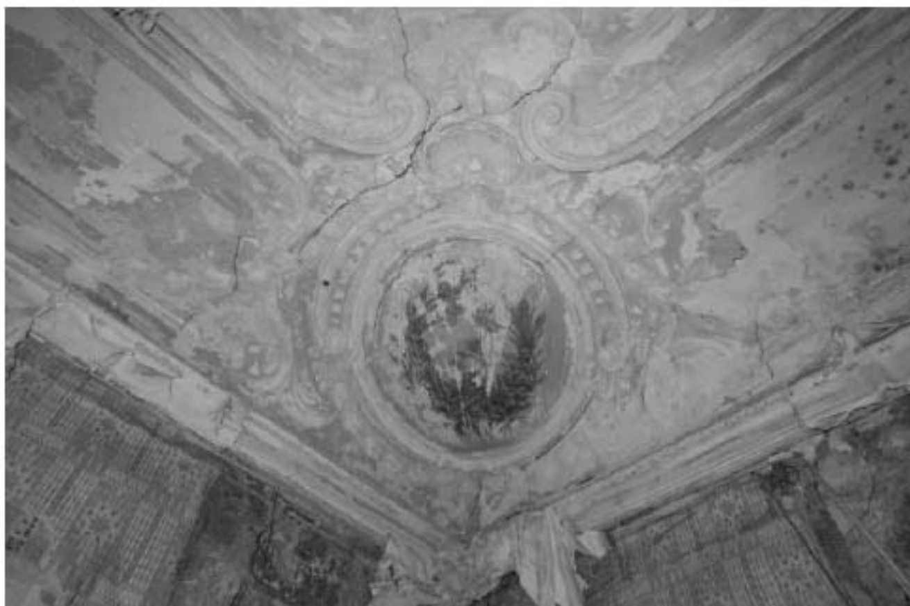
Илл. 107. Дом арх. А. П. Брюллова - Дом С. А. Сюзор (по Кадетской линии). Лепной декор. 2016 г. // https://www.citywalls.ru/house51.html
