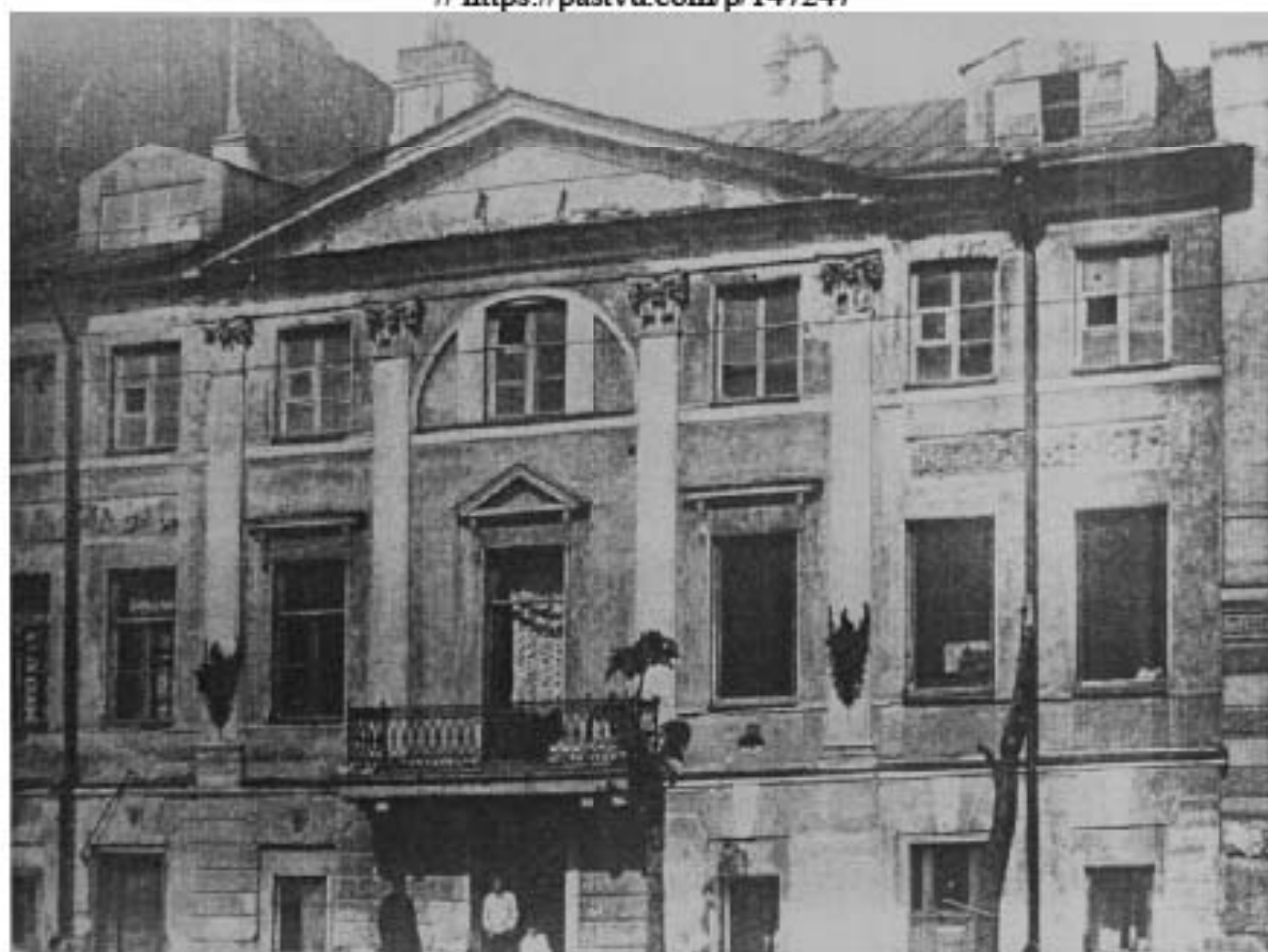
Илл. 53. Здание б. дома А.П. Брюллова. Фасад по Съездовской линии. Период создания: 1920-е гг. //
