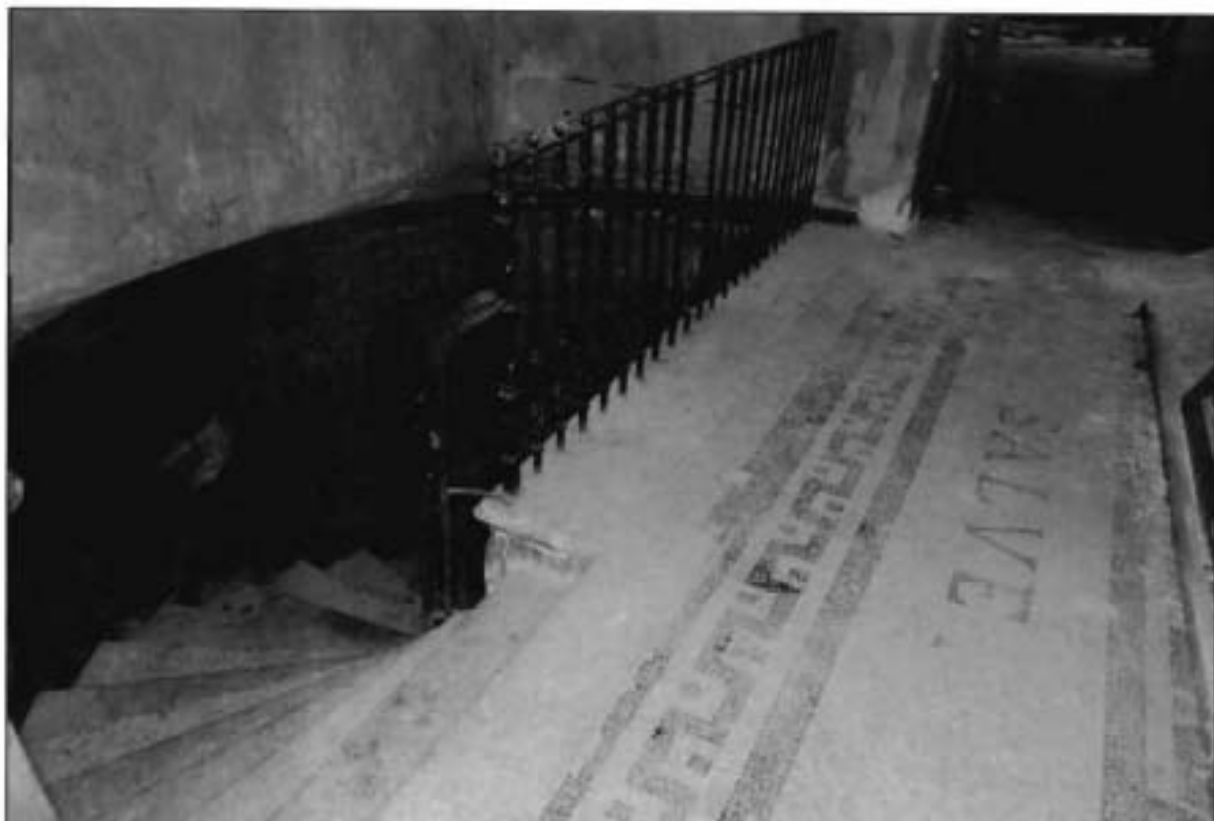
6. Интерьер объекта культурного наследия. Фрагмент. Помещение 5ЛК.
