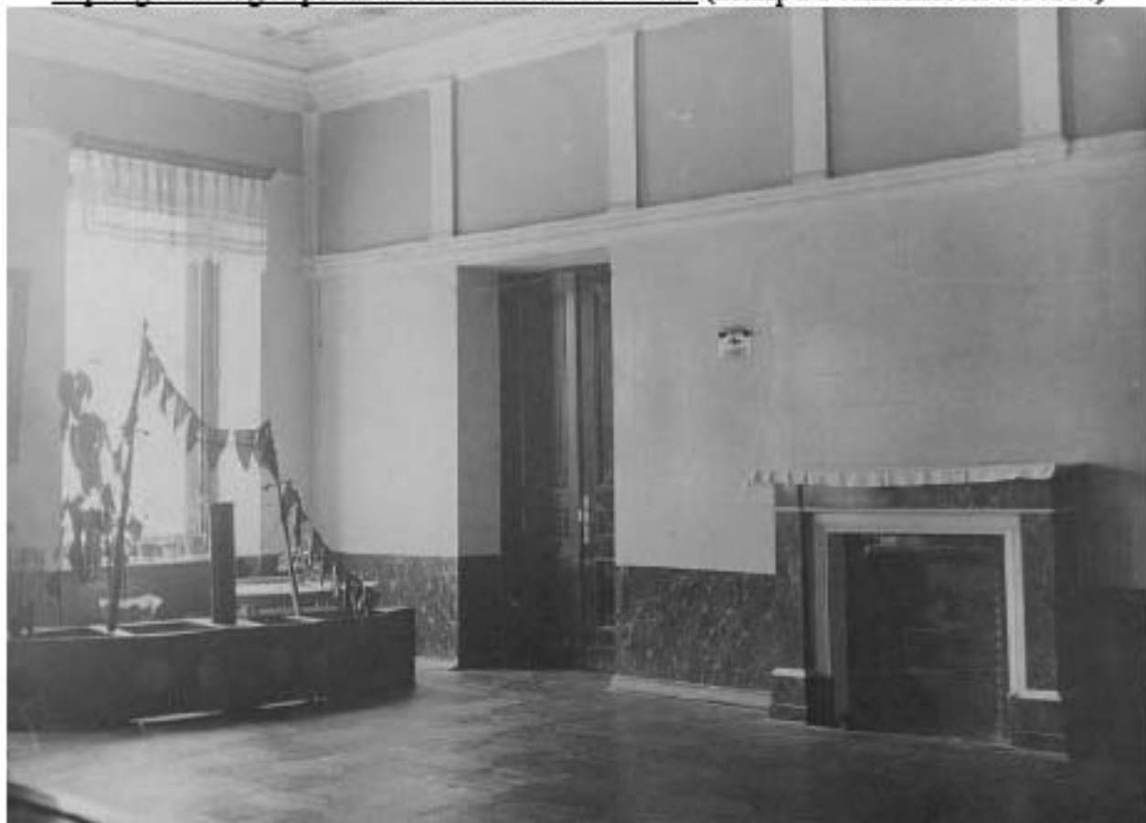
Илл. 64. Дом Брюллова на Съездовской линии д. 21. Камин и угол зала. Период создания: 1938 г. // https://goskatalog.ru/portal/#/collections?id=37749446 (номер в Госкаталоге: 37537370)
