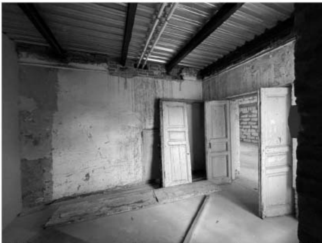
46. Объект культурного наследия федерального значения «Дом Брюллова А.П. (Сюзора П.Ю.)» по адресу: Санкт-Петербург, Кадетская линия В.О., дом 21, литера А.
