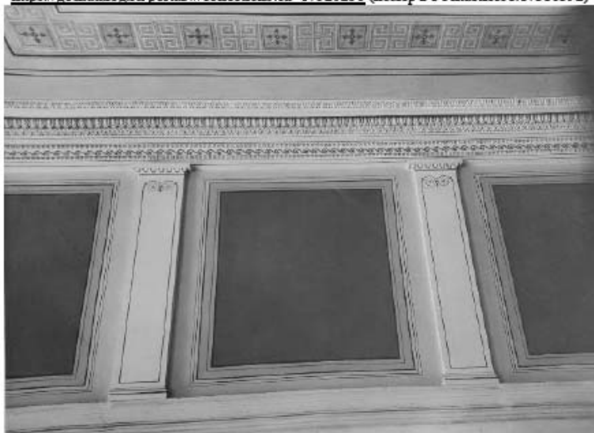
Илл.68. Карниз и обработка верхней части стены большого зала во 2-м этаже после реставрации 1955 г. // ЦГАНТД СПб. Фонд 488. Опись 311. Дело 2.
