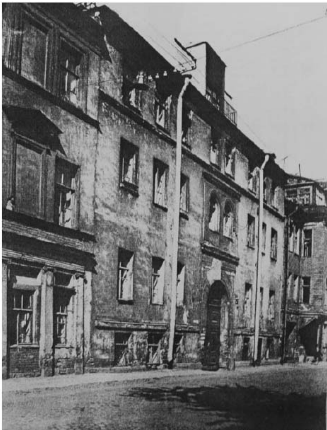
Илл. 55. Здание б. дома А.П. Брюллова. Фасад по Тучкову переулку. Период создания 1920-е гг. //
