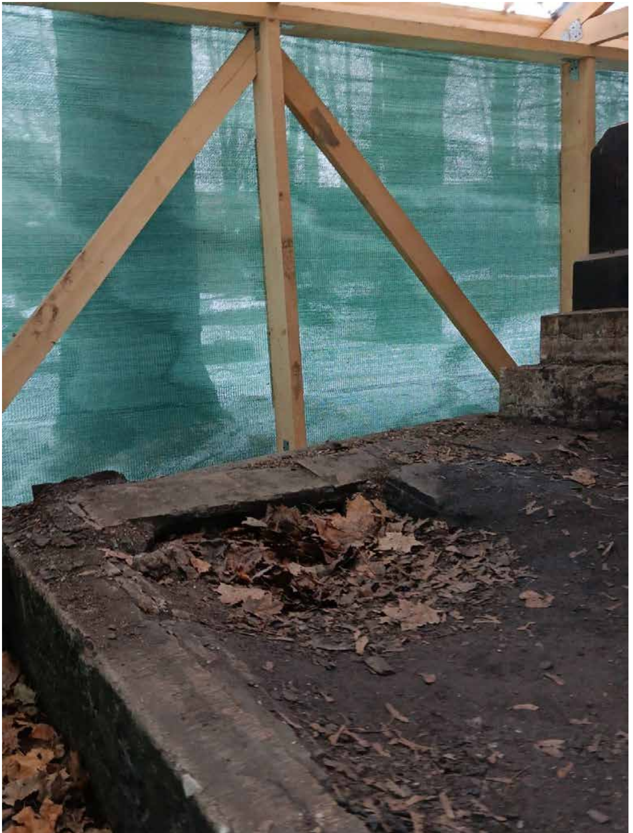
Фото 6. Объект культурного наследия регионального значения «Смоленское лютеранское кладбище». Могила генерал-майора А. фон Бекмана (1807-1833), предмет охраны объекта культурного наследия. Фрагмент временного защитного ограждения в виде деревянного каркаса, обшитого защитными материалами. Конструкции беседки, крыши, мощения демонтированы, находятся в мастерской для проведения реставрационных работ.
