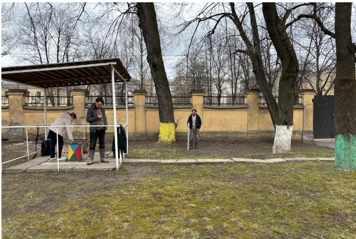
Рис. 11. ОАН «Участок культурного слоя Санкт-Петербурга XVIII –начала XIX в., по адресу: Санкт- Петербург, 14-я линия В.О., дом 57-61». Шурф №1. Вид до начала работ. Вид с востока
