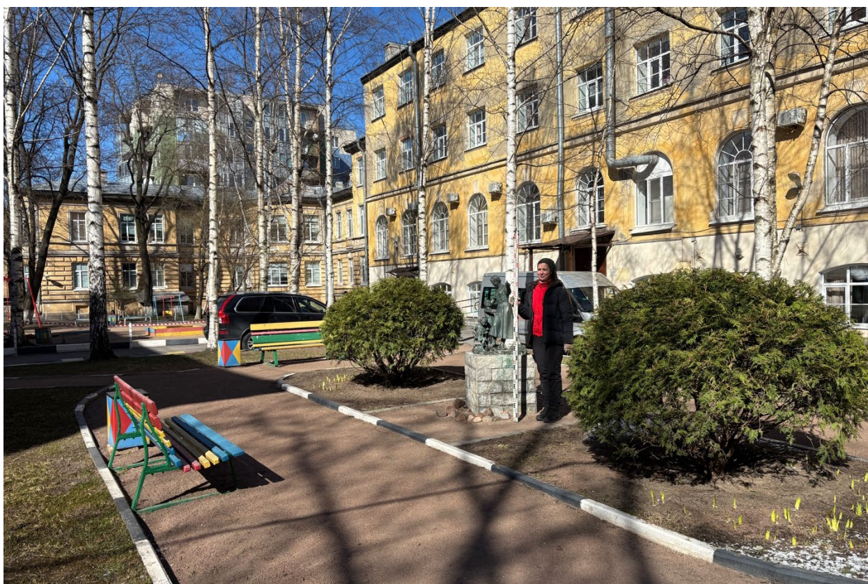
Рис. 8. Общий вид на ОАН «Участок культурного слоя Санкт-Петербурга XVIII –начала XIX в., по адресу: Санкт- Петербург, 14-я линия В.О., дом 57-61». Точка фортификации №4. Вид с юга
