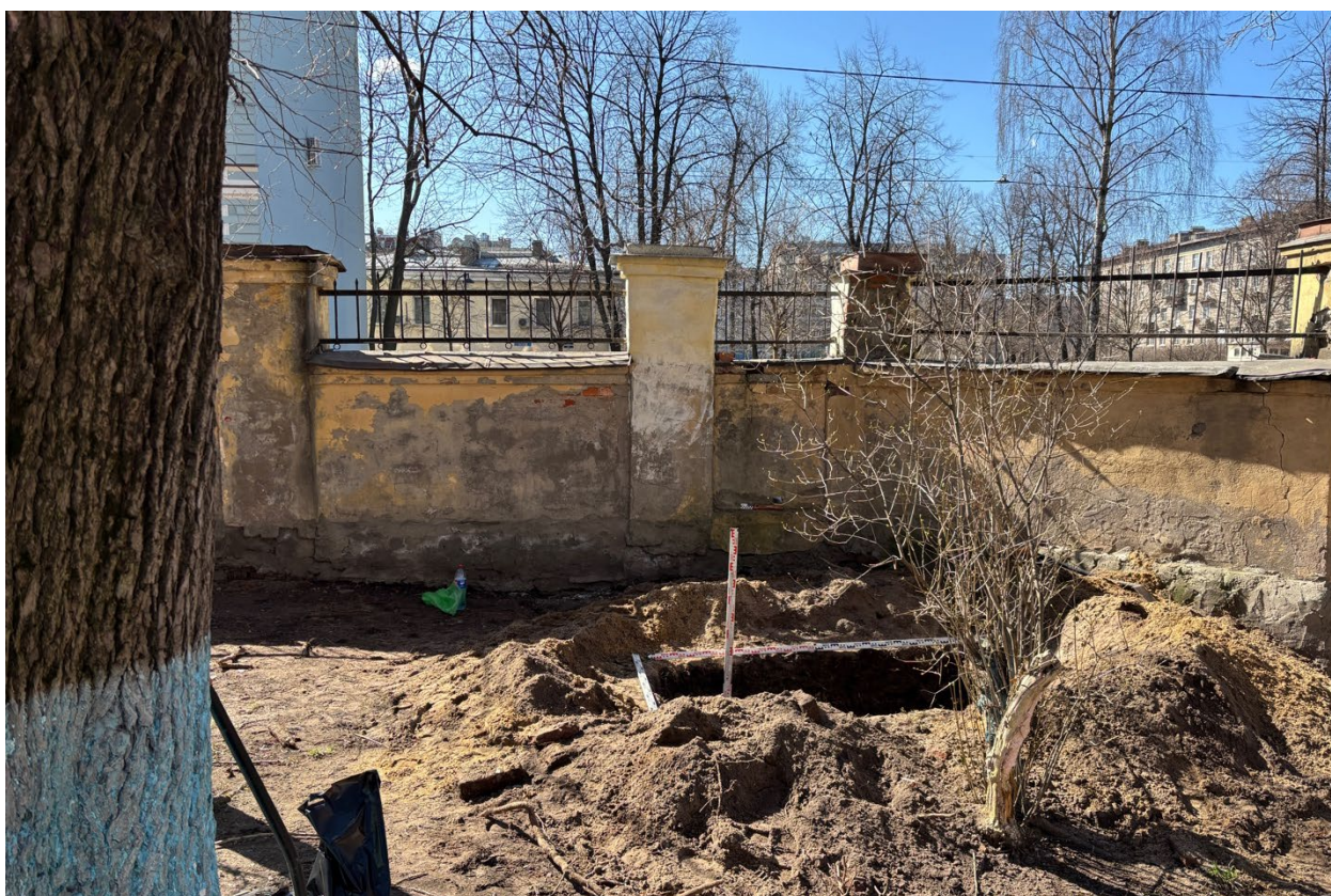
Рис. 44. ОАН «Участок культурного слоя Санкт-Петербурга XVIII –начала XIX в., по адресу: Санкт- Петербург, 14-я линия В.О., дом 57-61». Шурф №2. Вид выкопанного шурфа. Вид с востока
