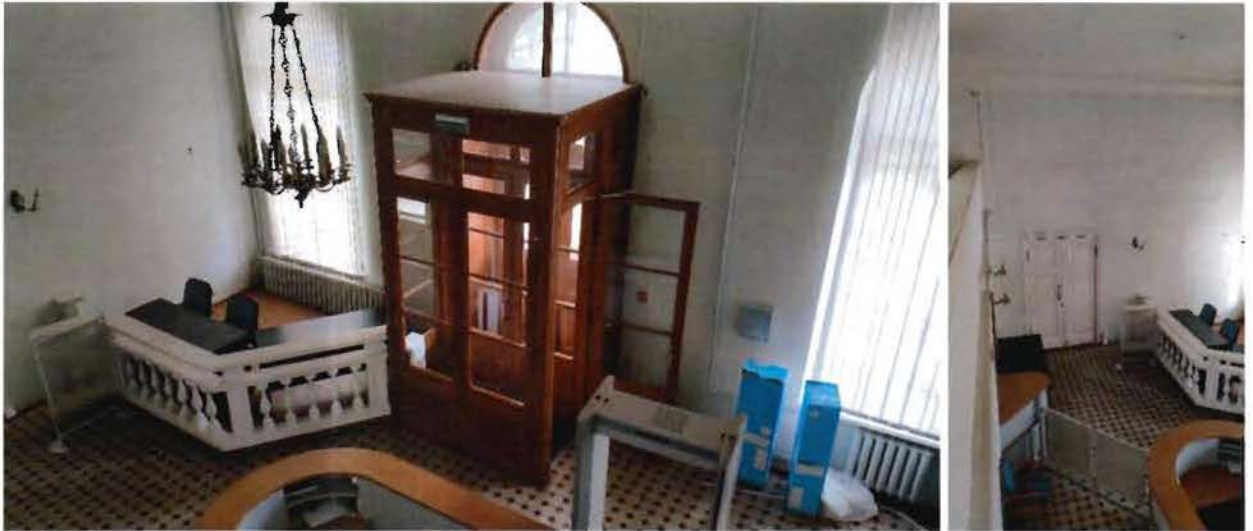
51, 52, 53. Помещения 2 этажа западного крыла объекта культурного наследия
