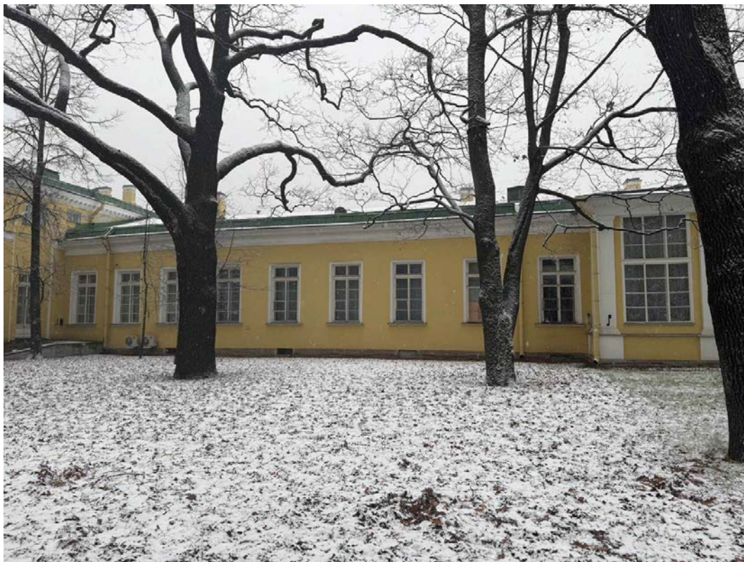
Фотография 11. ОКН федерального значения: "Дворец" (в составе "Дворец Таврический"), южный фасад, зал №14 (помещение №146 по плану ПИБ), г. Санкт-Петербург, Шпалерная улица, д. 47 лит. А, дата съемки 12.11.2025. Вид с юго-востока на северо-запад.
