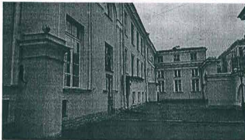
Фото 6, 7, 8. Восточный фасад восточного крыла объекта культурного наследия
