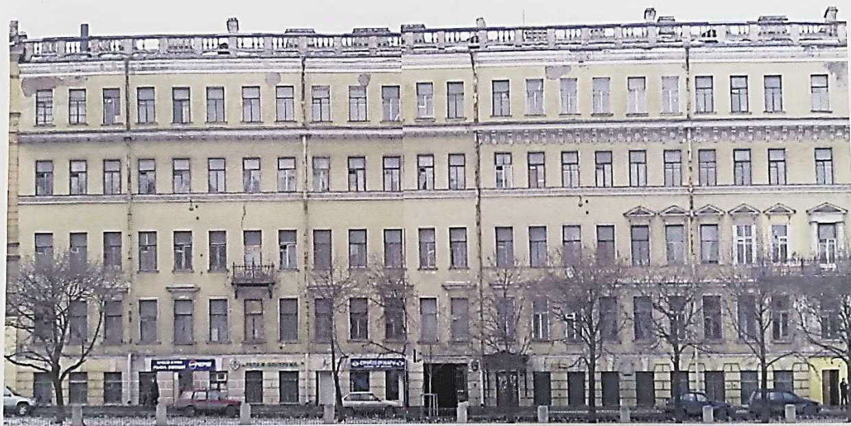
Фотоплан лицевого фасада (монтаж)
