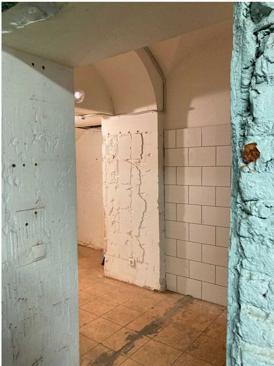
Фото 13. Проход в помещения №6.2, 7
