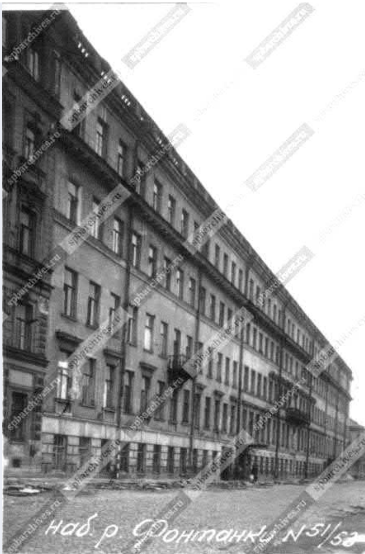
Илл.29. ЦГАКФД СПб Шифр: Гр 72406 Аннотация: Фасад дома №51-53 на набережной реки Фонтанки. Дата съёмки: 1949 г.
