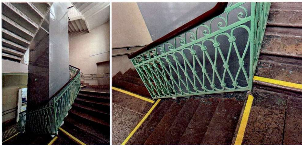
Фото 32, 33. Лестница Л-5 объекта культурного наследия.
