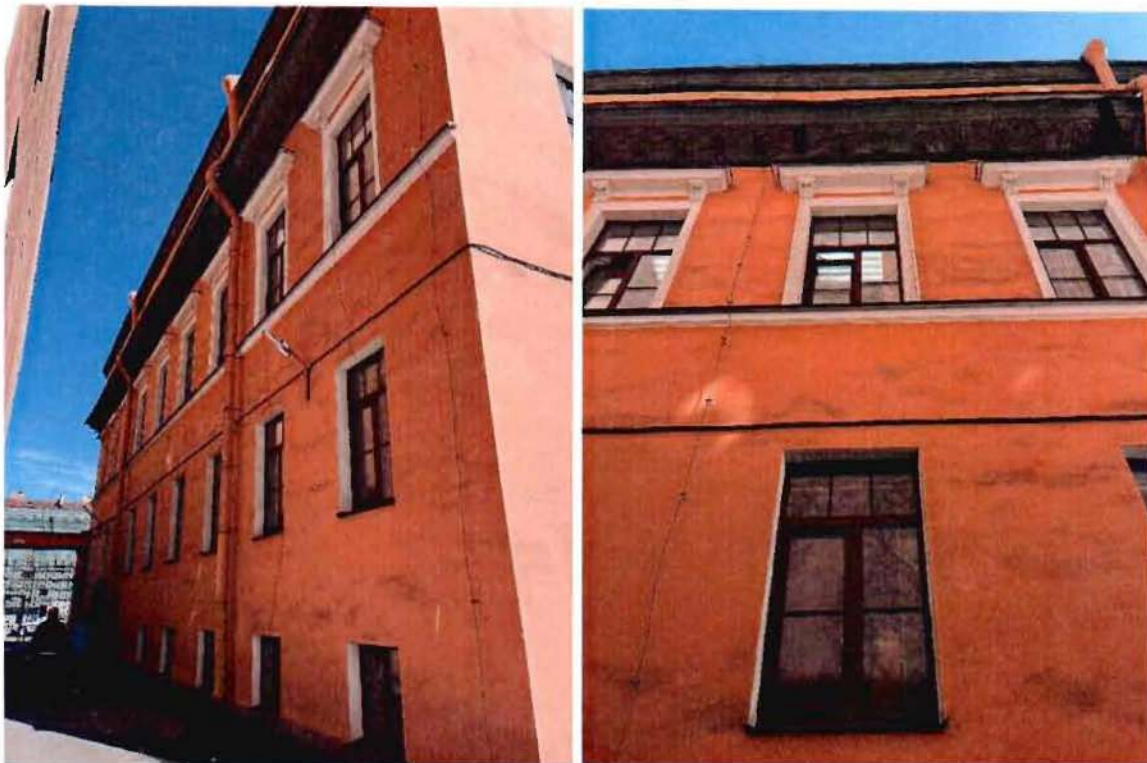
4, 5. Западный фасад объекта культурного наследия.
