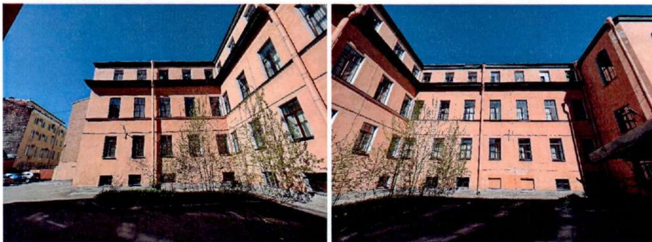
Фото 10, 11. Дворовые фасады объекта культурного наследия, западная часть.
