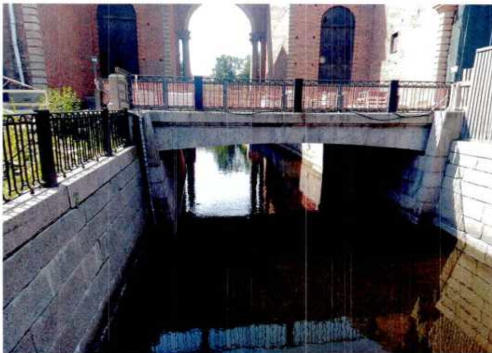
2. Канал, расположенный с южной стороны.
