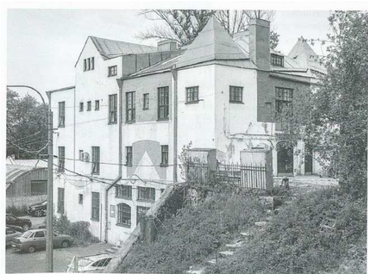
49. Вокзал станции Ланская. Вид с юго-востока. Фотография 2016 г. // Кириков Б. М. Архитектура петербургского модерна. Общественные здания. Кн. Вторая. – СПб., 2017. С.49.
