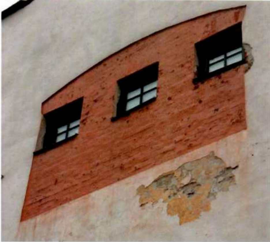
9. Фрагмент стены с северо-западной стороны
