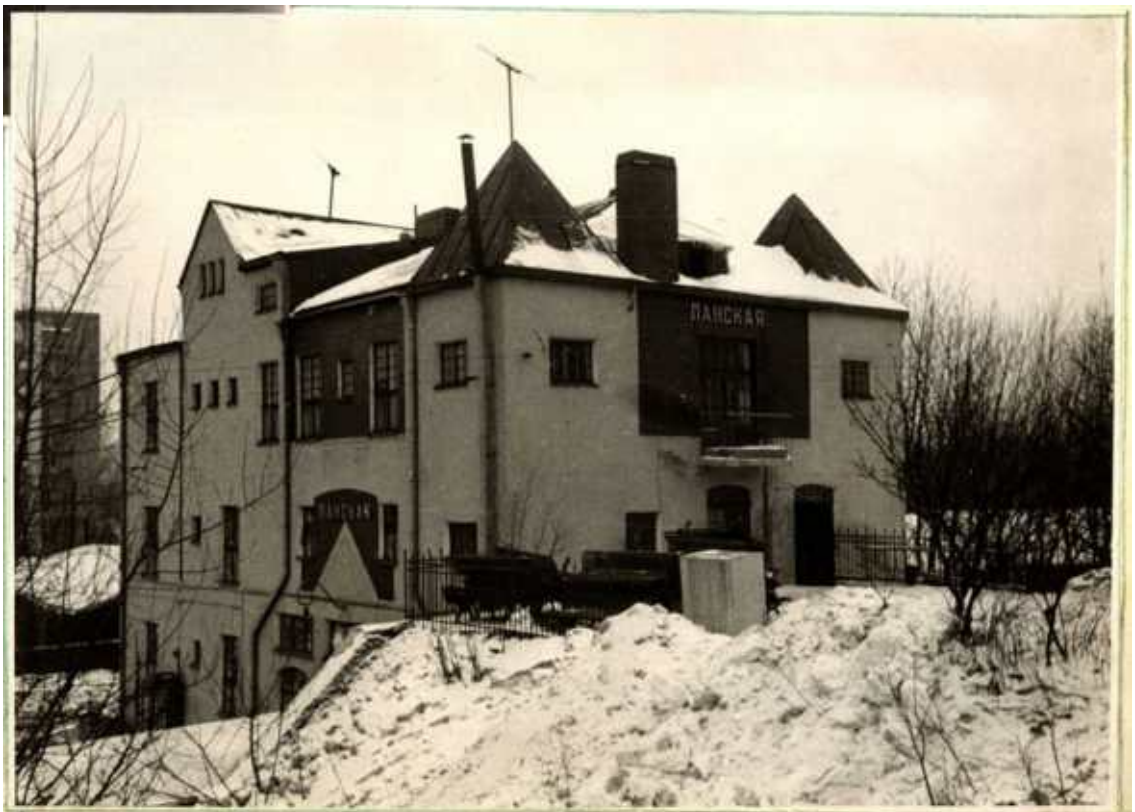
28. Станция Ланская. Вид с юго-востока. Б/д. Из фондов РЖД // URL: https://terijoki.spb.ru/%2F/photos/picture.php?/117099/category/2082 (дата обращения: 10.02.2026).
