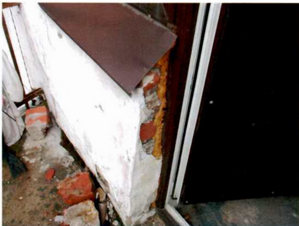
24. Элементы балкона 2ого этажа с юго-западной стороны.
