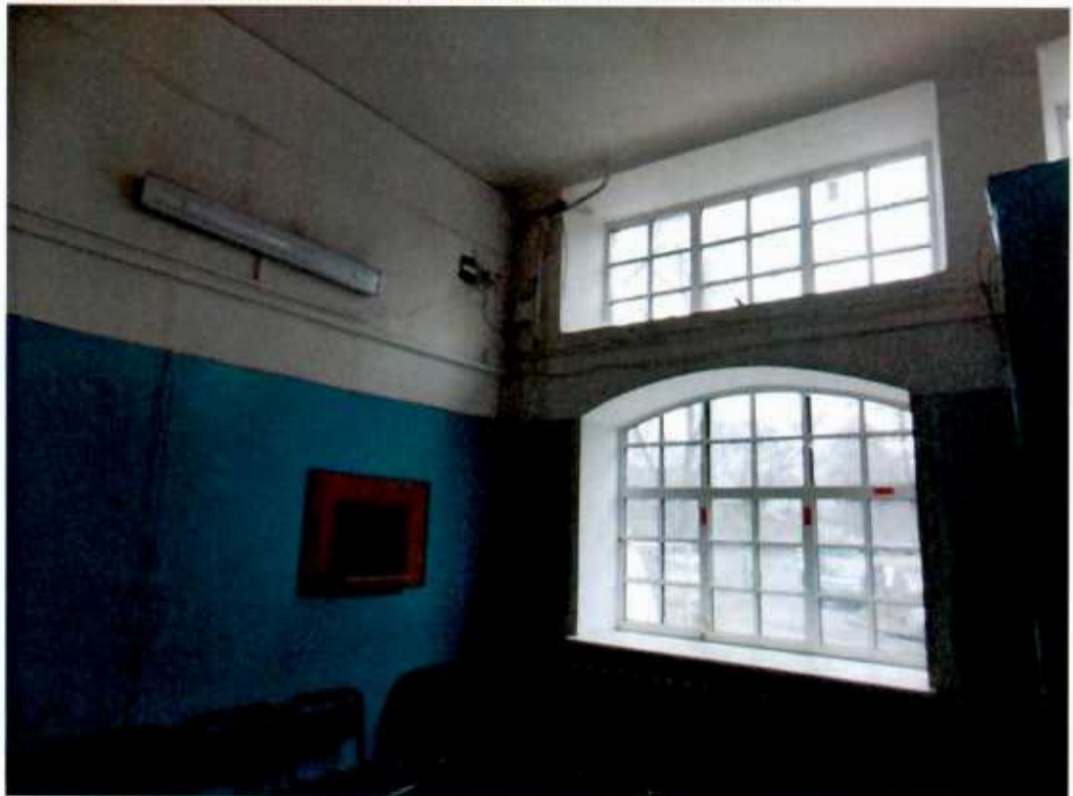
16. Фрагмент интерьера парадного зала ж.д. станции Ланская
