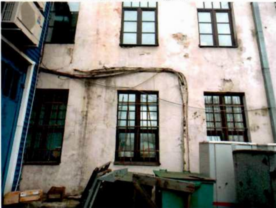
10. Фрагменты стены с северо-западной стороны
