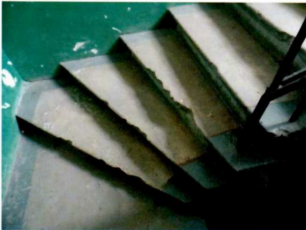
21. Фрагмент лестничного марша
