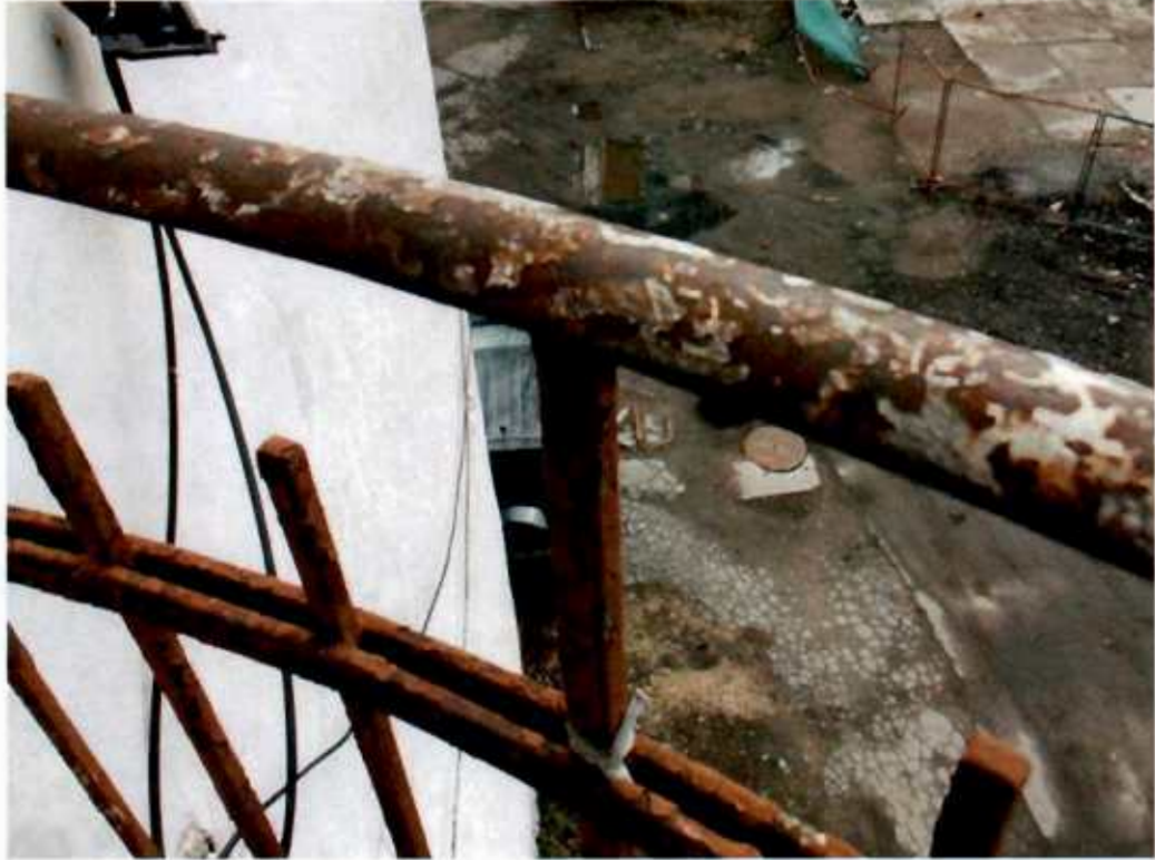
23. Элементы балкона 2ого этажа с юго-западной стороны.
