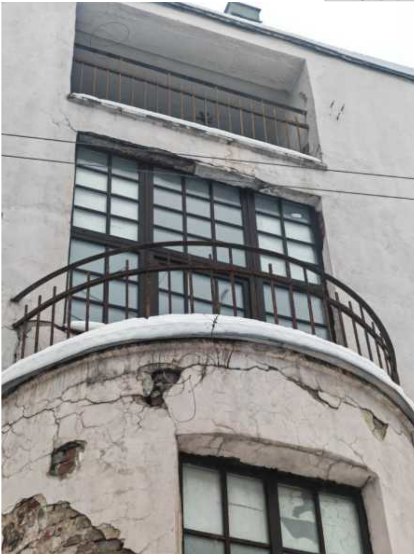
9. Объект культурного наследия регионального значения «Вокзал железнодорожной станции Ланская». Фрагмент юго-западного фасада здания. Ограждение балкона. Дата фотофиксации: 19 января 2026 года.
