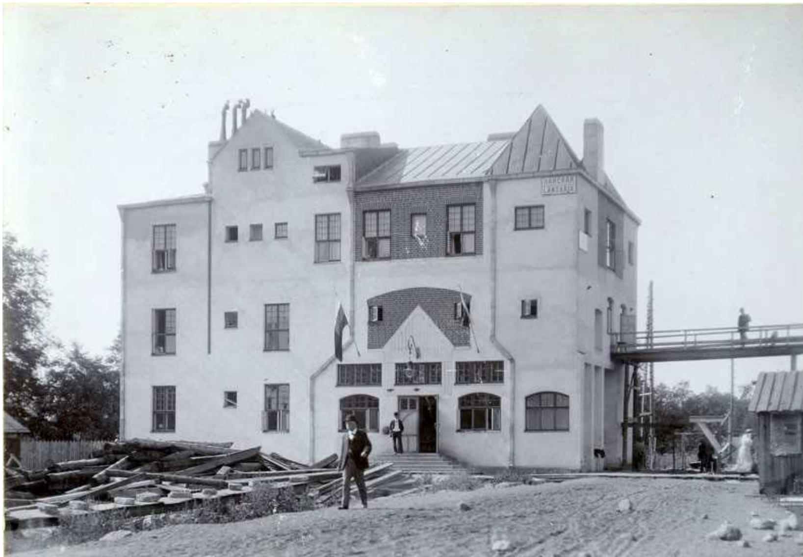
21. Новый вокзал станции Ланская. Фото 1911 г. // URL: https://terijoki.spb.ru/%2F/photos/picture.php?/103656/category/2082 (дата обращения: 10.02.2026).
