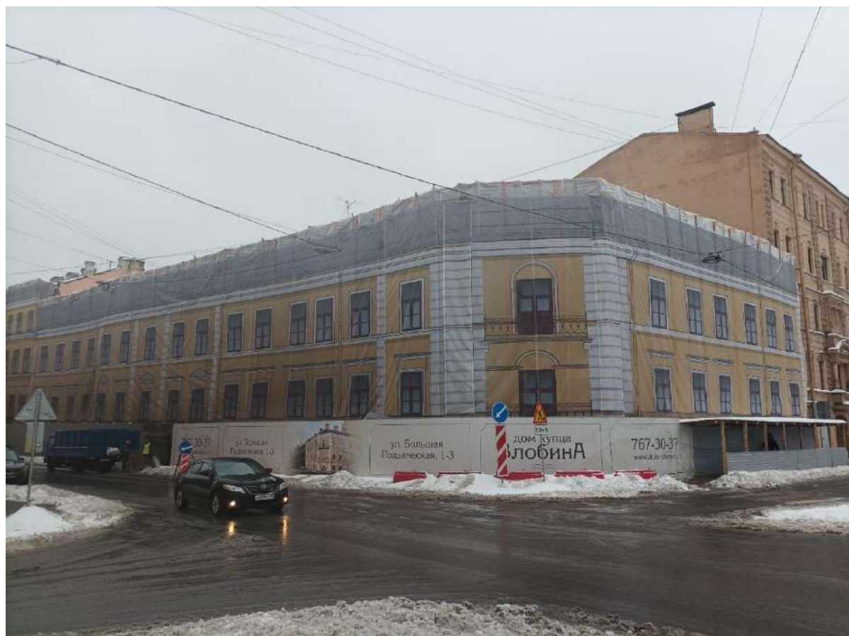
Фото 2. Западный фасад, торцевой северо-западный фасад и северный фасад.
