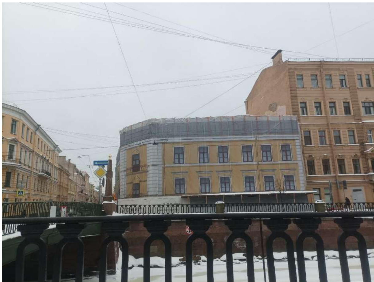
Фото 1. Северный фасад и торцевой северо-западный фасад.
