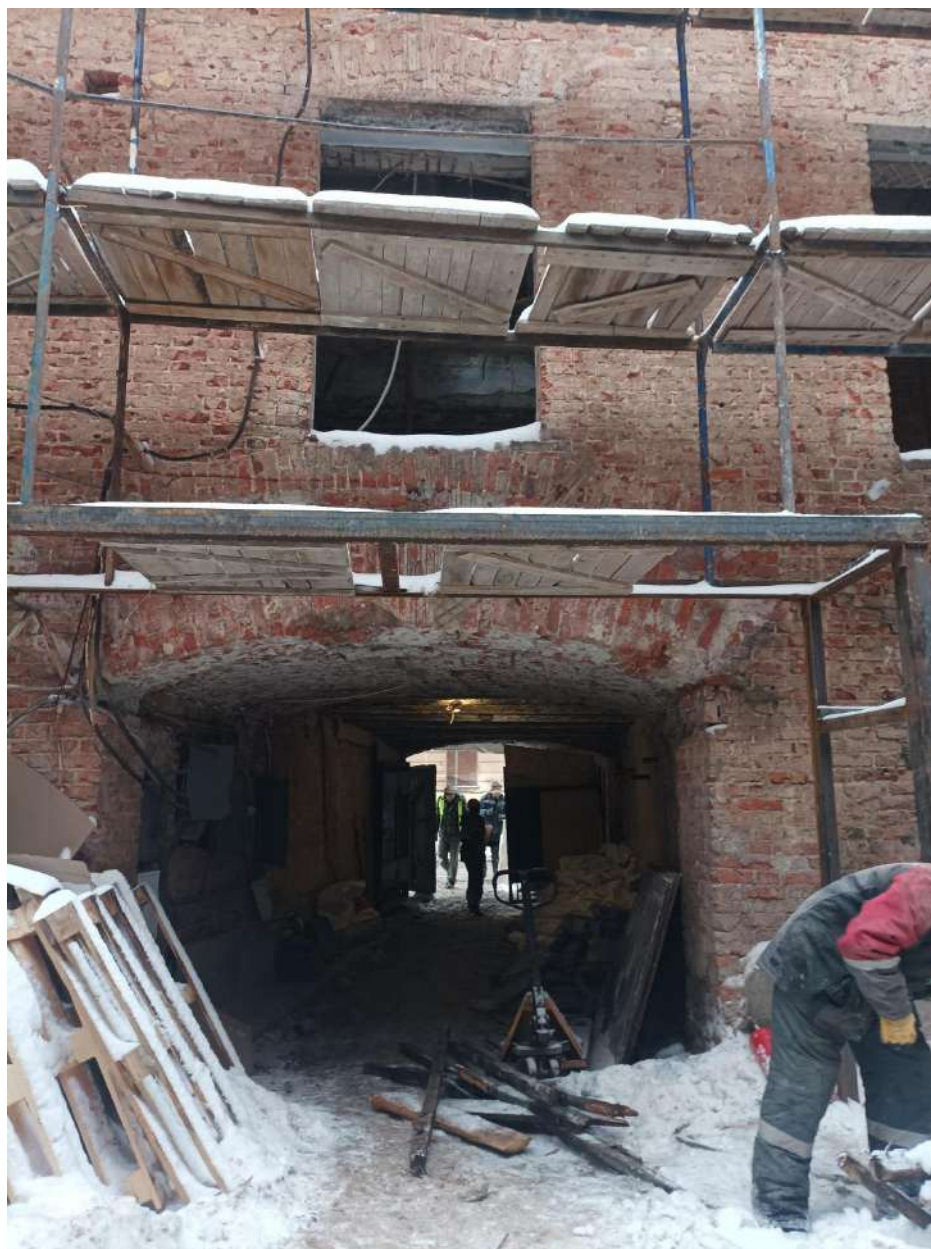
Фото 7. Проездная арка западного фасада со стороны двора.
