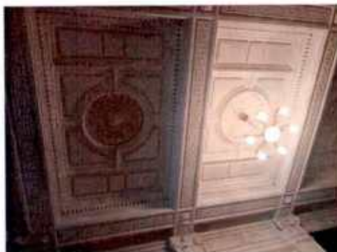
29. Здание 12. Оформление потолка вестибюля парадной лестницы 1ЛК. (фото выполнено 27.06.2023).
