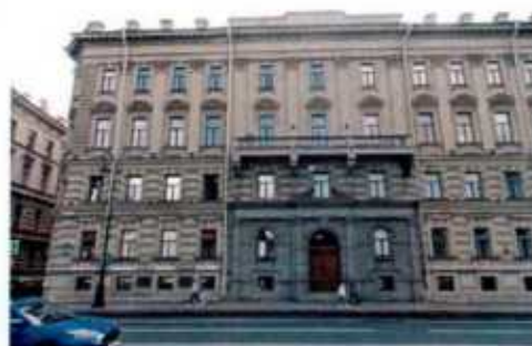
2. Лицевой северо-западный фасад, оформление входной зоны. (фото выполнено 27.06.2023).
