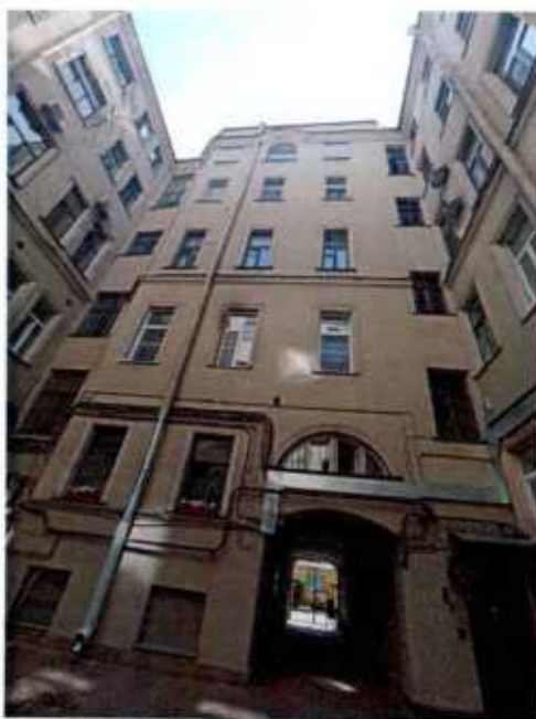
7. Здание 12. Дворовой фасад. (фото выполнено 27.06.2023).
