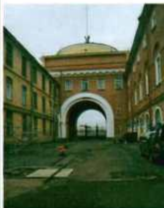
9. (Фрагмент дворового фасада)
