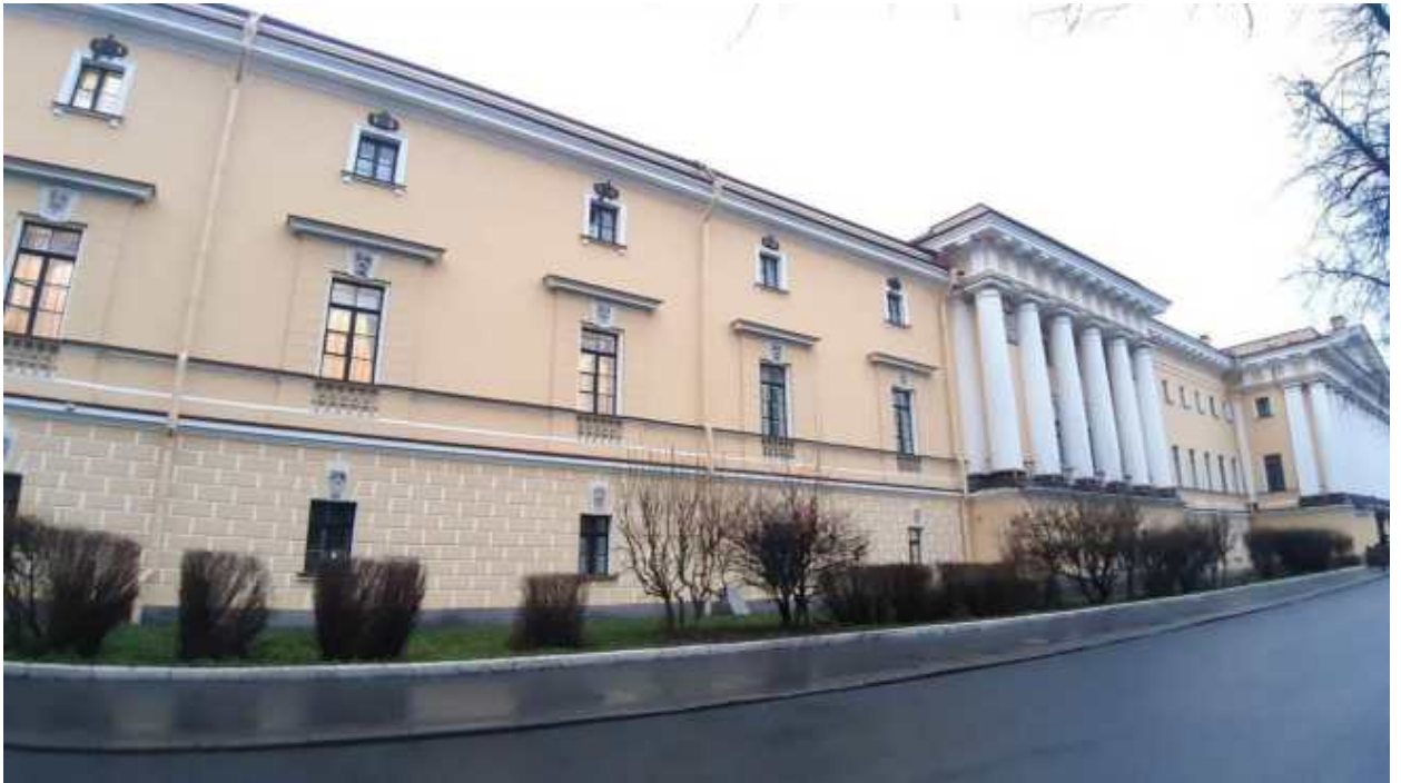
11. «Главное Адмиралтейство» (Адмиралтейский проезд, д. 1, лит. А). Лицевой фасад по Адмиралтейскому проезду (фрагмент). Фото мест установки оборудования и прокладки кабельных трасс. Штиглиц М.С. 22.12.2025.
