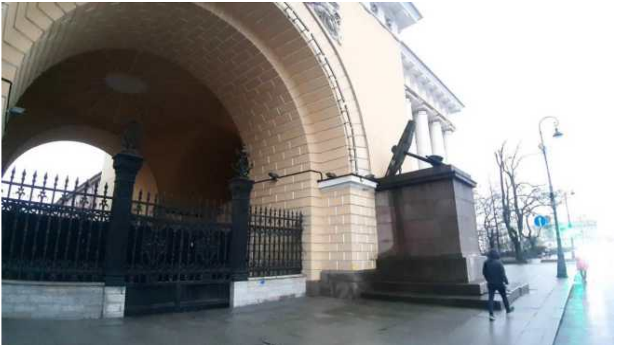
32. «Главное Адмиралтейство» (Адмиралтейский проезд, д. 1, лит. А). Лицевой фасад по Адмиралтейской наб. (фрагмент). Фото мест установки оборудования и прокладки кабельных трасс. Штиглиц М.С. 22.12.2025.
