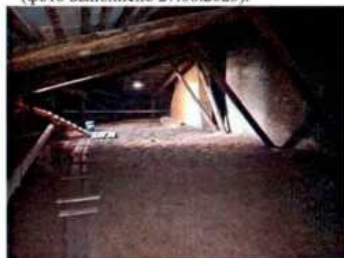
46. Здание 14. Фрагмент стропильной системы. (фото выполнено 27.06.2023).
