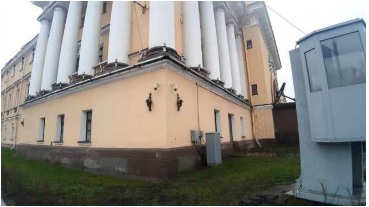
39. «Главное Адмиралтейство» (Адмиралтейский проезд, д. 1, лит. А). Лицевой фасад по Адмиралтейской наб. (фрагмент). Фото мест установки оборудования и прокладки кабельных трасс. Штиглиц М.С. 22.12.2025.
