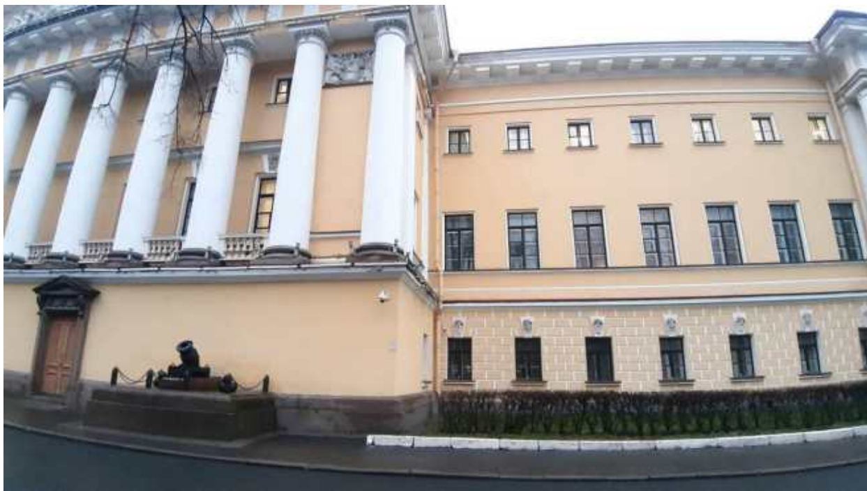
19. «Главное Адмиралтейство» (Адмиралтейский проезд, д. 1, лит. А). Лицевой фасад по Адмиралтейскому проезду (фрагмент). Фото мест установки оборудования и прокладки кабельных трасс. Штиглиц М.С. 22.12.2025.
