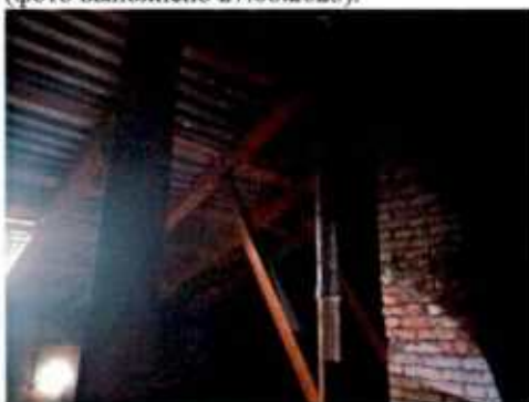
45. Здание 14. Фрагмент стропильной системы. (фото выполнено 27.06.2023).
