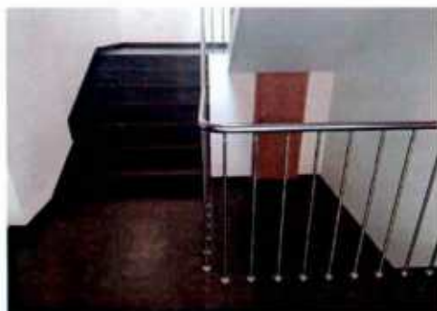
35. Лестница в помещении 23-Н. (фото выполнено 13.07.2023).
