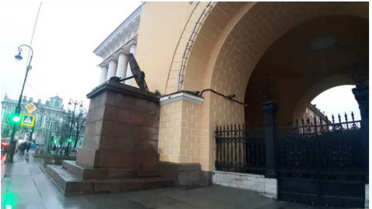
36. «Главное Адмиралтейство» (Адмиралтейский проезд, д. 1, лит. А). Лицевой фасад по Адмиралтейской наб. (фрагмент). Фото мест установки оборудования и прокладки кабельных трасс. Штиглиц М.С. 22.12.2025.
