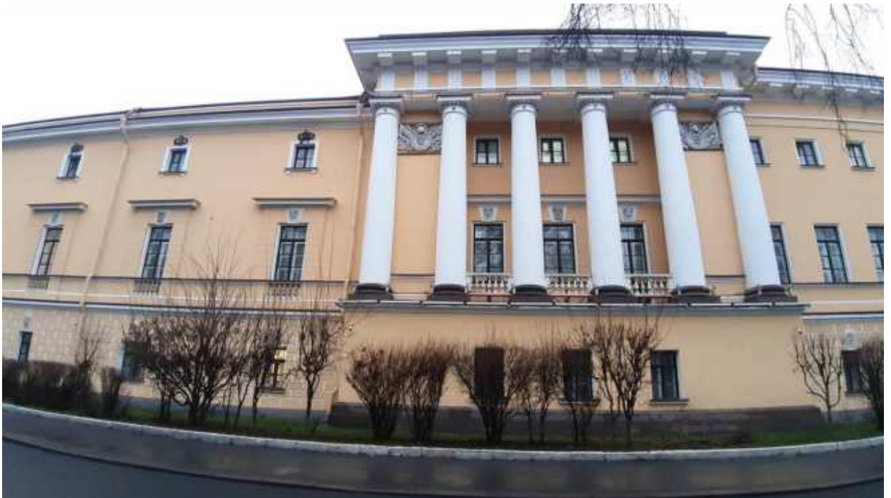
10. «Главное Адмиралтейство» (Адмиралтейский проезд, д. 1, лит. А). Лицевой фасад по Адмиралтейскому проезду (фрагмент). Фото мест установки оборудования и прокладки кабельных трасс. Штиглиц М.С. 22.12.2025.
