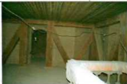
5. (Центральная башня, интерьер)
