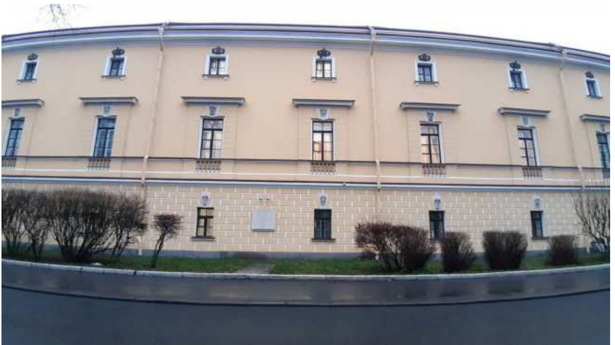
12. «Главное Адмиралтейство» (Адмиралтейский проезд, д. 1, лит. А). Лицевой фасад по Адмиралтейскому проезду (фрагмент). Фото мест установки оборудования и прокладки кабельных трасс. Штиглиц М.С. 22.12.2025.
