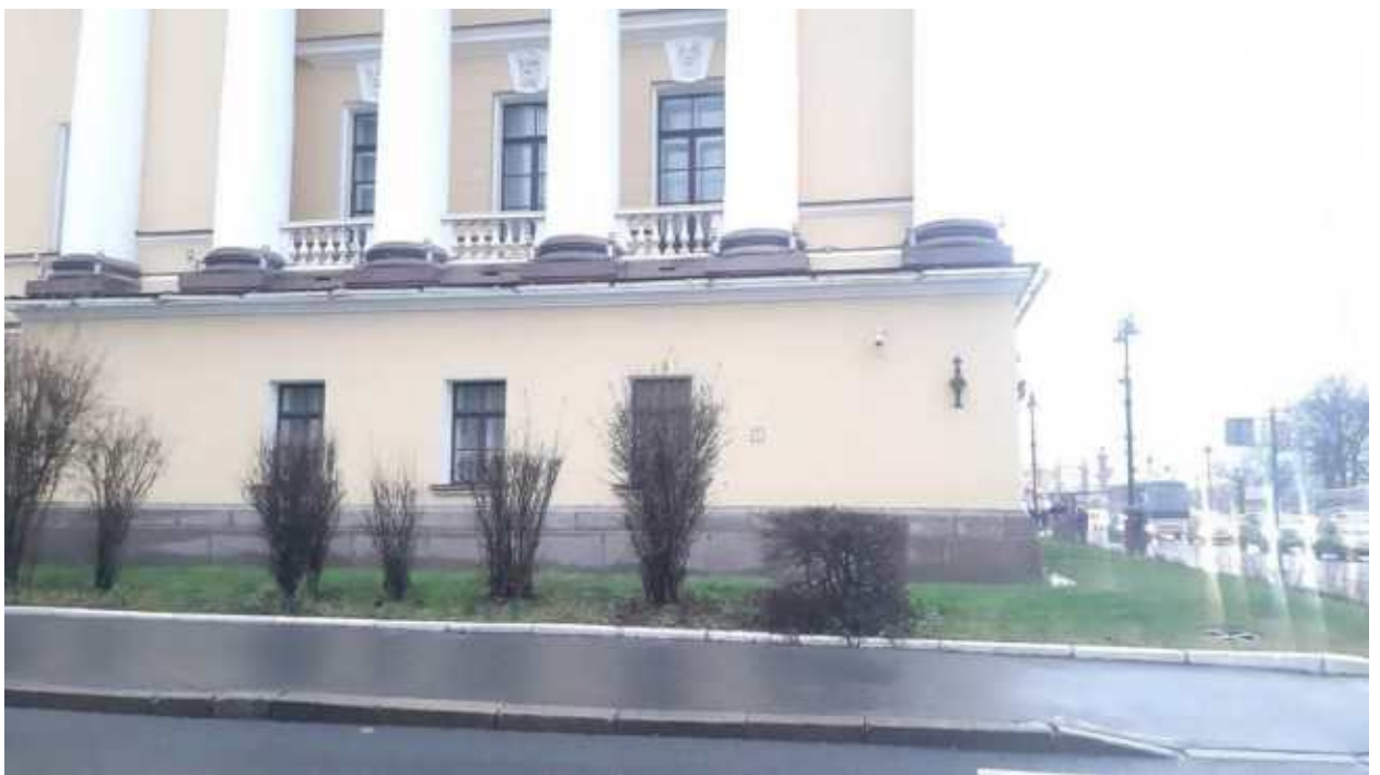
4. «Главное Адмиралтейство» (Адмиралтейский проезд, д. 1, лит. А). Лицевой фасад по Адмиралтейскому проезду (фрагмент). Фото мест установки оборудования и прокладки кабельных трасс. Штиглиц М.С. 22.12.2025.
