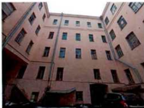
11. Здание 14. Дворовой фасад. (фото выполнено 24.03.2023).
