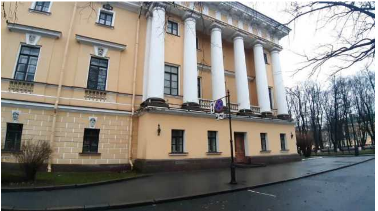
24. «Главное Адмиралтейство» (Адмиралтейский проезд, д. 1, лит. А). Лицевой фасад по Адмиралтейскому проезду (фрагмент). Фото мест установки оборудования и прокладки кабельных трасс. Штиглиц М.С. 22.12.2025.
