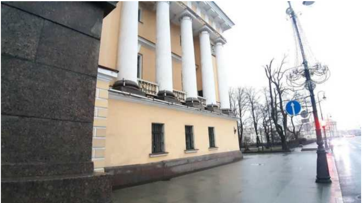
30. «Главное Адмиралтейство» (Адмиралтейский проезд, д. 1, лит. А). Лицевой фасад по Адмиралтейской наб. (фрагмент). Фото мест установки оборудования и прокладки кабельных трасс. Штиглиц М.С. 22.12.2025.
