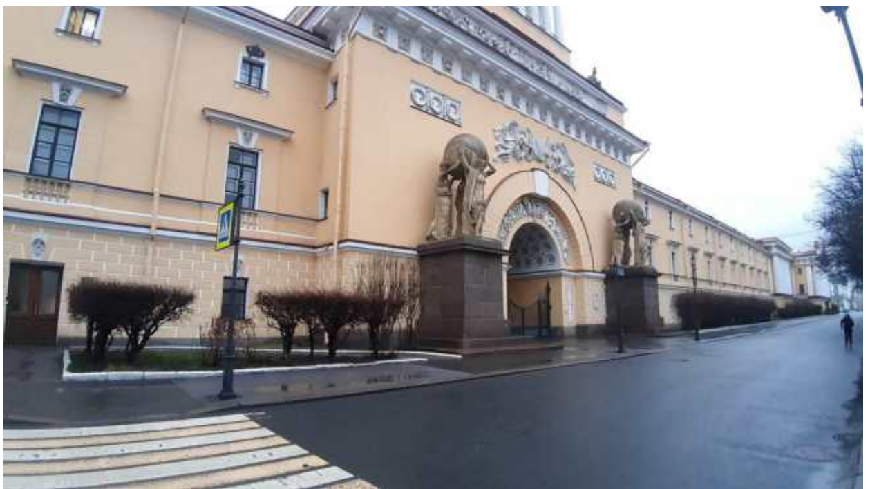
14. «Главное Адмиралтейство» (Адмиралтейский проезд, д. 1, лит. А). Лицевой фасад по Адмиралтейскому проезду (фрагмент). Фото мест установки оборудования и прокладки кабельных трасс. Штиглиц М.С. 22.12.2025.
