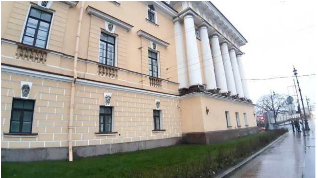
41. «Главное Адмиралтейство» (Адмиралтейский проезд, д. 1, лит. А). Лицевой фасад по Дворцовому проезду (фрагмент). Фото мест установки оборудования и прокладки кабельных трасс. Штиглиц М.С. 22.12.2025.
