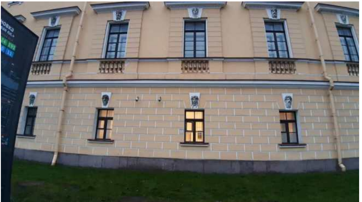
46. «Главное Адмиралтейство» (Адмиралтейский проезд, д. 1, лит. А). Лицевой фасад по Дворцовому проезду (фрагмент). Фото мест установки оборудования и прокладки кабельных трасс. Штиглиц М.С. 22.12.2025.
