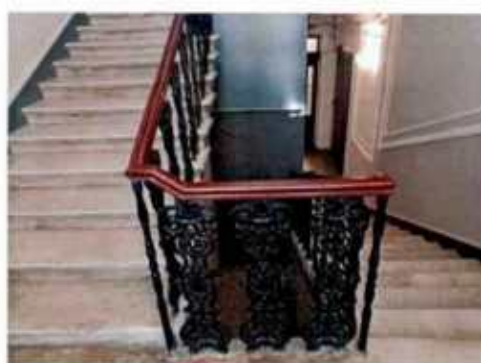
26. Здание 12. Парадная лестница 1ЛК. (фото выполнено 27.06.2023).
