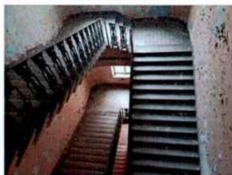
22. Здание 14. Лестница 5ЛК. (фото выполнено 24.03.2023).
