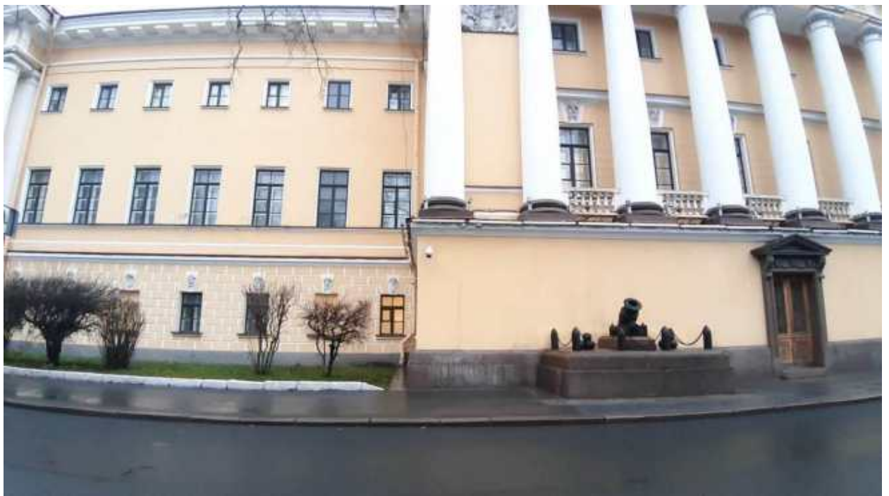
8. «Главное Адмиралтейство» (Адмиралтейский проезд, д. 1, лит. А). Лицевой фасад по Адмиралтейскому проезду (фрагмент). Фото мест установки оборудования и прокладки кабельных трасс. Штиглиц М.С. 22.12.2025.
