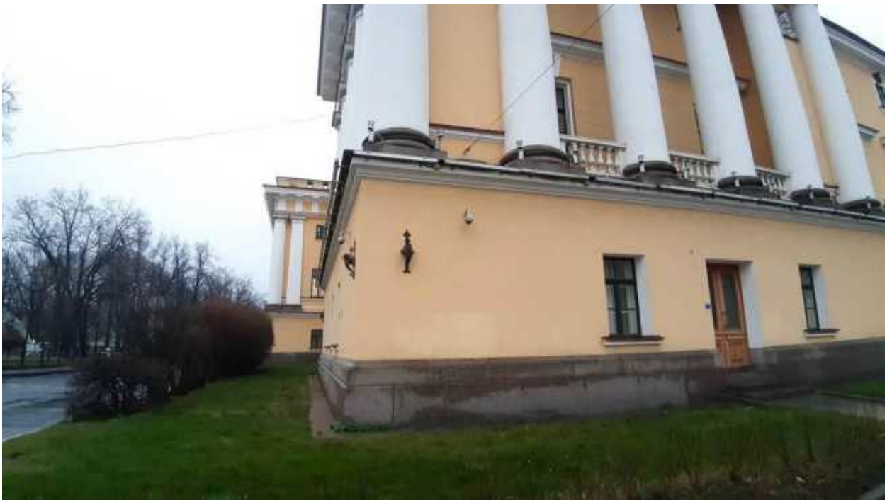
48. «Главное Адмиралтейство» (Адмиралтейский проезд, д. 1, лит. А). Лицевой фасад по Дворцовому проезду (фрагмент). Фото мест установки оборудования и прокладки кабельных трасс. Штиглиц М.С. 22.12.2025.
