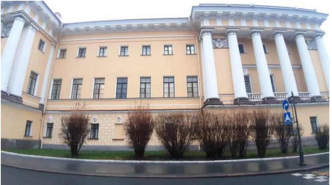
5. «Главное Адмиралтейство» (Адмиралтейский проезд, д. 1, лит. А). Лицевой фасад по Адмиралтейскому проезду (фрагмент). Фото мест установки оборудования и прокладки кабельных трасс. Штиглиц М.С. 22.12.2025.
