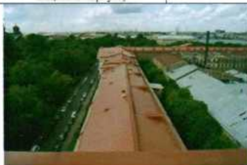
11. (Фрагмент крыши юго-западной части лицевого корпуса)
