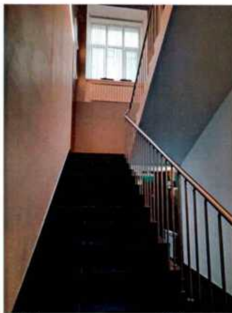
34. Лестница в помещении 29-Н. (фото выполнено 13.07.2023).
