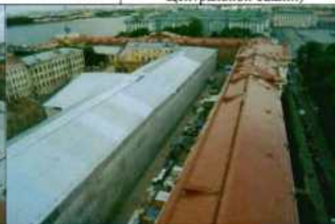
12. (Фрагмент крыши юго-восточной части лицевого корпуса)
