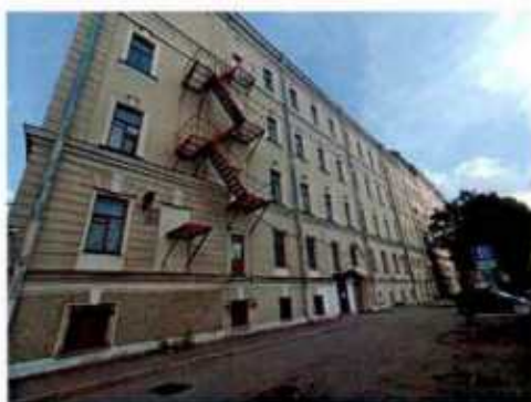
5. Юго-восточный фасад. (фото выполнено 27.06.2023).
