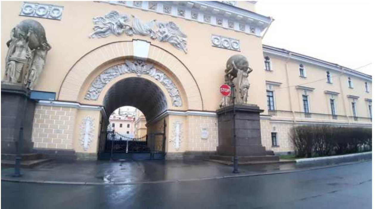
15. «Главное Адмиралтейство» (Адмиралтейский проезд, д. 1, лит. А). Лицевой фасад по Адмиралтейскому проезду (фрагмент). Фото мест установки оборудования и прокладки кабельных трасс. Штиглиц М.С. 22.12.2025.
