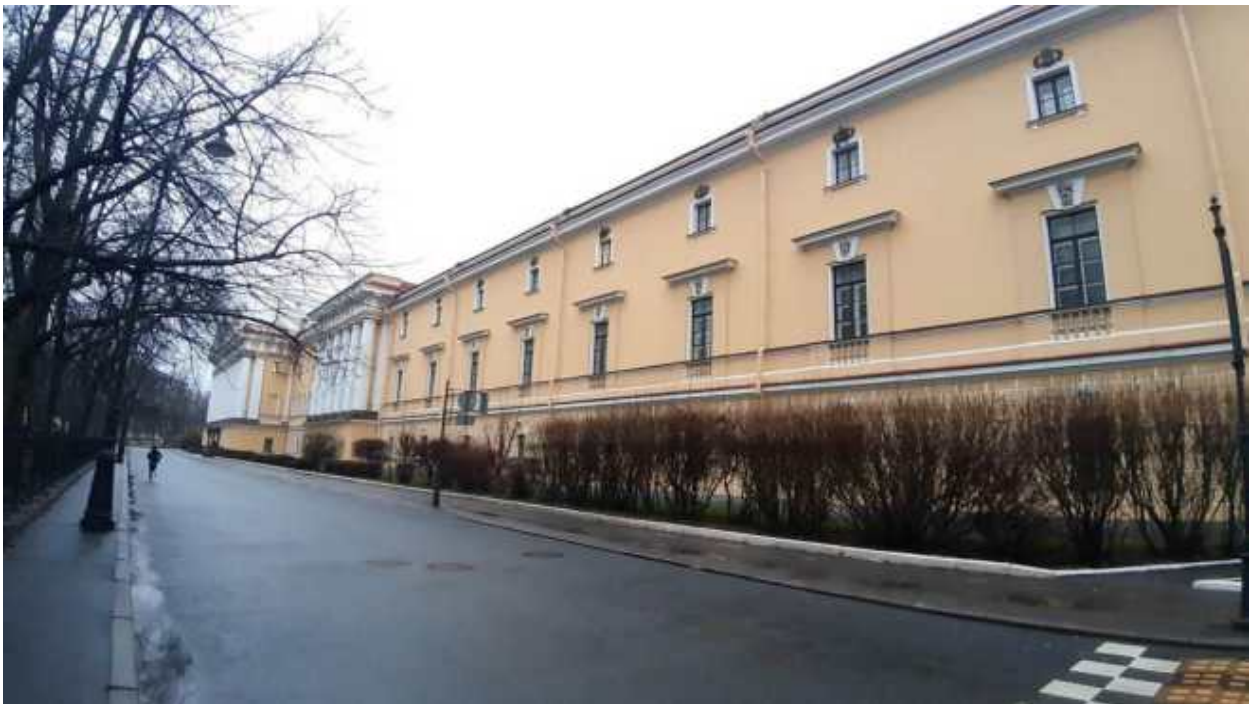
16. «Главное Адмиралтейство» (Адмиралтейский проезд, д. 1, лит. А). Лицевой фасад по Адмиралтейскому проезду (фрагмент). Фото мест установки оборудования и прокладки кабельных трасс. Штиглиц М.С. 22.12.2025.
