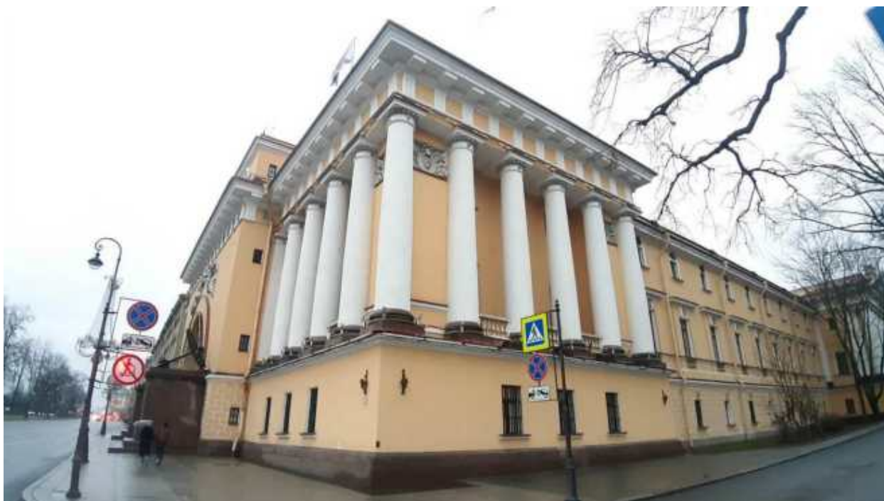
28. «Главное Адмиралтейство» (Адмиралтейский проезд, д. 1, лит. А). Лицевой фасад по Адмиралтейскому проезду (фрагмент). Фото мест установки оборудования и прокладки кабельных трасс. Штиглиц М.С. 22.12.2025.
