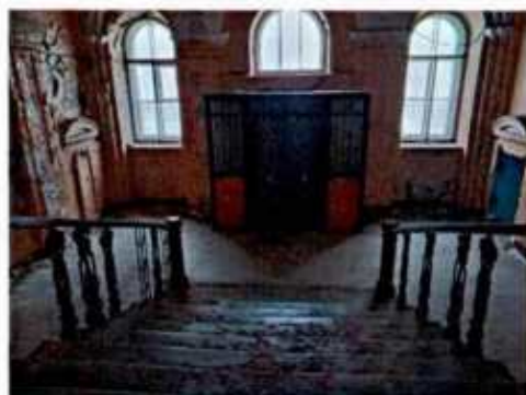
21. Здание 14. Парадная лестница 6ЛК. (фото выполнено 24.03.2023).
