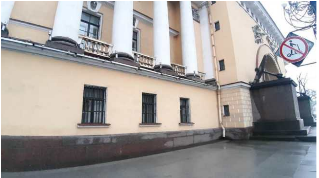
33. «Главное Адмиралтейство» (Адмиралтейский проезд, д. 1, лит. А). Лицевой фасад по Адмиралтейской наб. (фрагмент). Фото мест установки оборудования и прокладки кабельных трасс. Штиглиц М.С. 22.12.2025.
