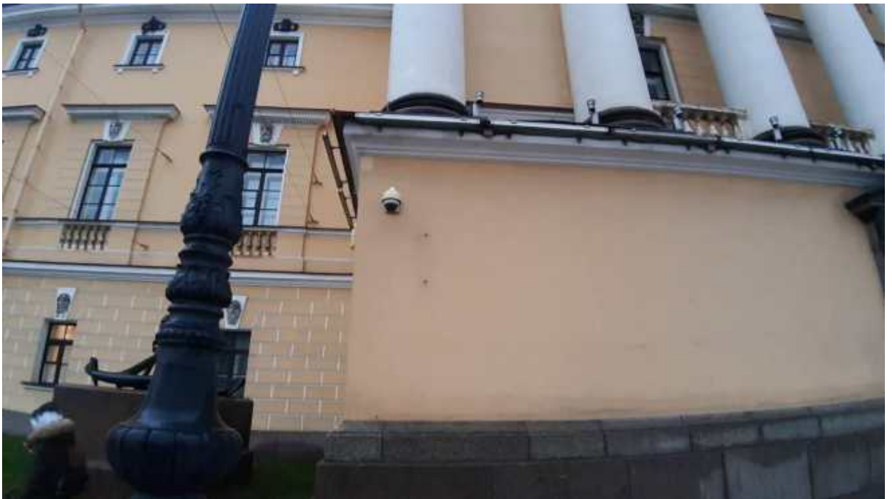
44. «Главное Адмиралтейство» (Адмиралтейский проезд, д. 1, лит. А). Лицевой фасад по Дворцовому проезду (фрагмент). Фото мест установки оборудования и прокладки кабельных трасс. Штиглиц М.С. 22.12.2025.
