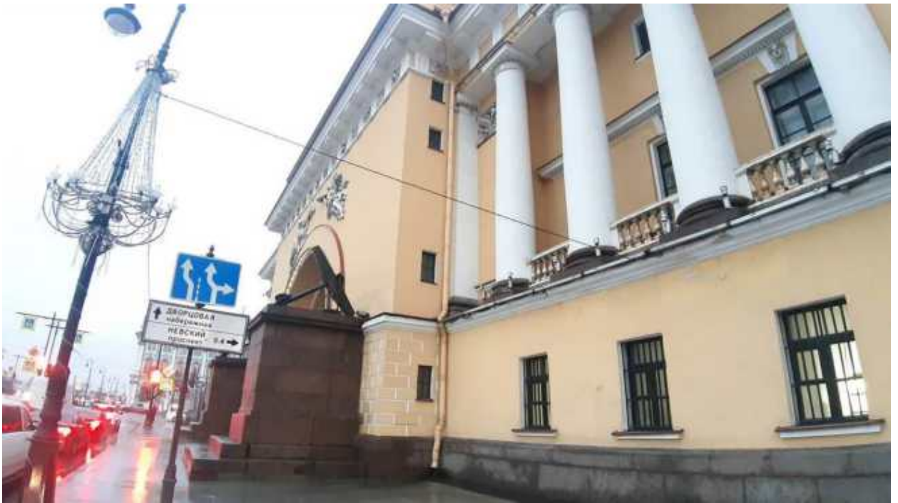
35. «Главное Адмиралтейство» (Адмиралтейский проезд, д. 1, лит. А). Лицевой фасад по Адмиралтейской наб. (фрагмент). Фото мест установки оборудования и прокладки кабельных трасс. Штиглиц М.С. 22.12.2025.
