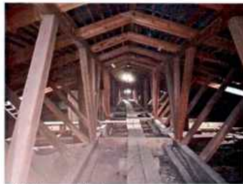
44. Здание 14. Фрагмент стропильной системы. (фото выполнено 27.06.2023).
