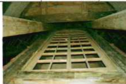
6. (Центральная башня, интерьер)
