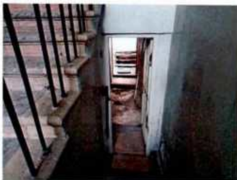
23. Здание 14. Лестница 4ЛК. (фото выполнено 24.03.2023).
