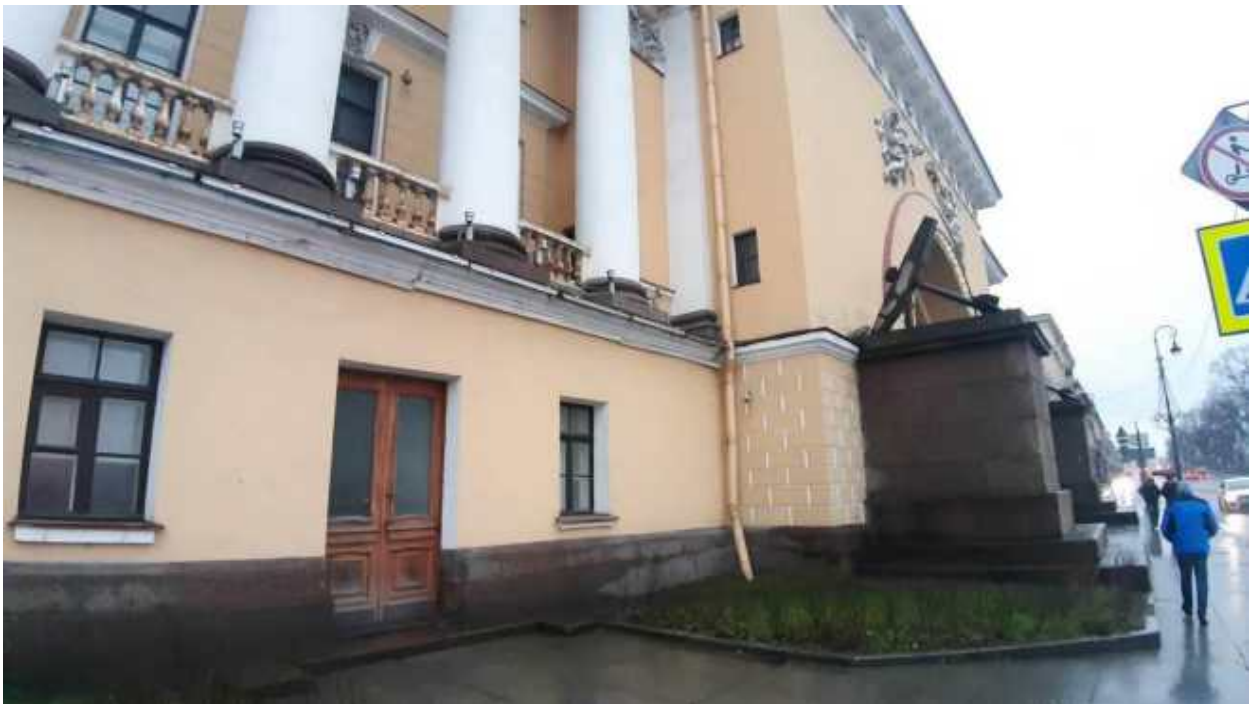
38. «Главное Адмиралтейство» (Адмиралтейский проезд, д. 1, лит. А). Лицевой фасад по Адмиралтейской наб. (фрагмент). Фото мест установки оборудования и прокладки кабельных трасс. Штиглиц М.С. 22.12.2025.
