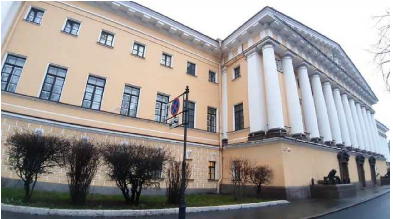
9. «Главное Адмиралтейство» (Адмиралтейский проезд, д. 1, лит. А). Лицевой фасад по Адмиралтейскому проезду (фрагмент). Фото мест установки оборудования и прокладки кабельных трасс. Штиглиц М.С. 22.12.2025.
