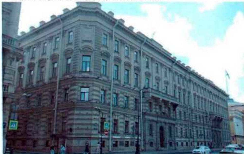
1. Лицевой северо-западный фасад (фото от 27.06.2023).
