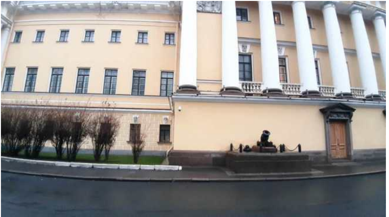
21. «Главное Адмиралтейство» (Адмиралтейский проезд, д. 1, лит. А). Лицевой фасад по Адмиралтейскому проезду (фрагмент). Фото мест установки оборудования и прокладки кабельных трасс. Штиглиц М.С. 22.12.2025.
