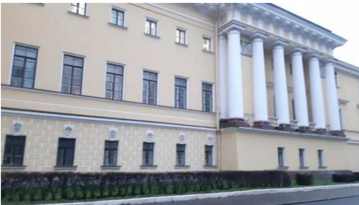
20. «Главное Адмиралтейство» (Адмиралтейский проезд, д. 1, лит. А). Лицевой фасад по Адмиралтейскому проезду (фрагмент). Фото мест установки оборудования и прокладки кабельных трасс. Штиглиц М.С. 22.12.2025.
