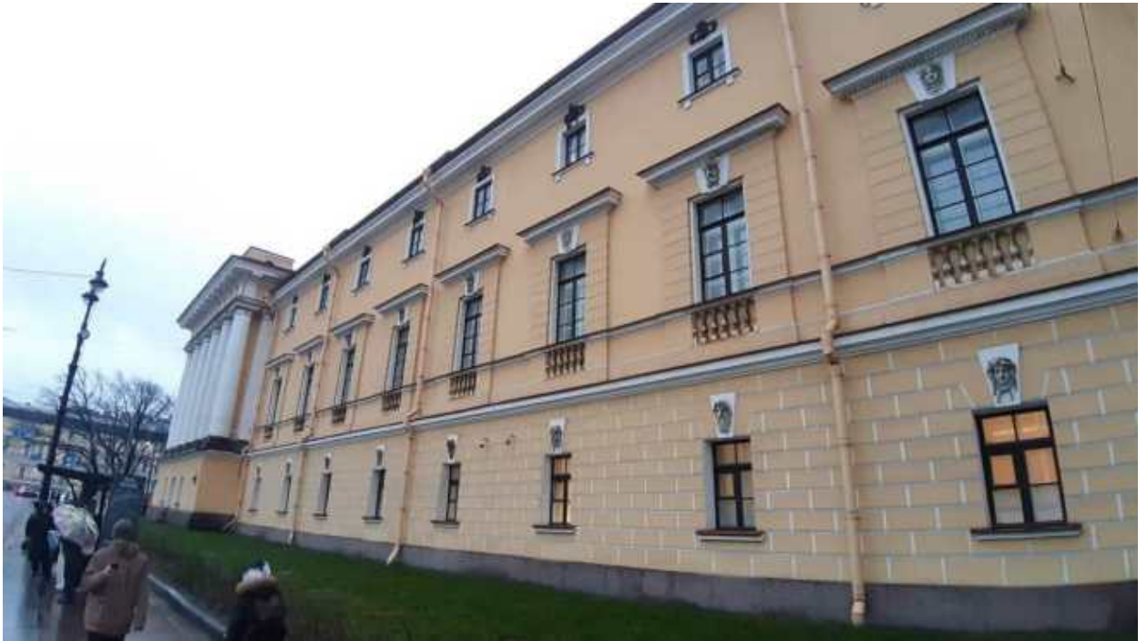
45. «Главное Адмиралтейство» (Адмиралтейский проезд, д. 1, лит. А). Лицевой фасад по Дворцовому проезду (фрагмент). Фото мест установки оборудования и прокладки кабельных трасс. Штиглиц М.С. 22.12.2025.
