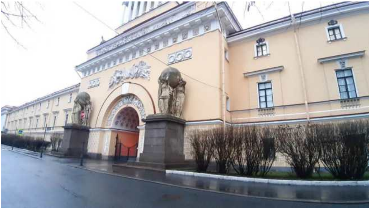
13. «Главное Адмиралтейство» (Адмиралтейский проезд, д. 1, лит. А). Лицевой фасад по Адмиралтейскому проезду (фрагмент). Фото мест установки оборудования и прокладки кабельных трасс. Штиглиц М.С. 22.12.2025.
