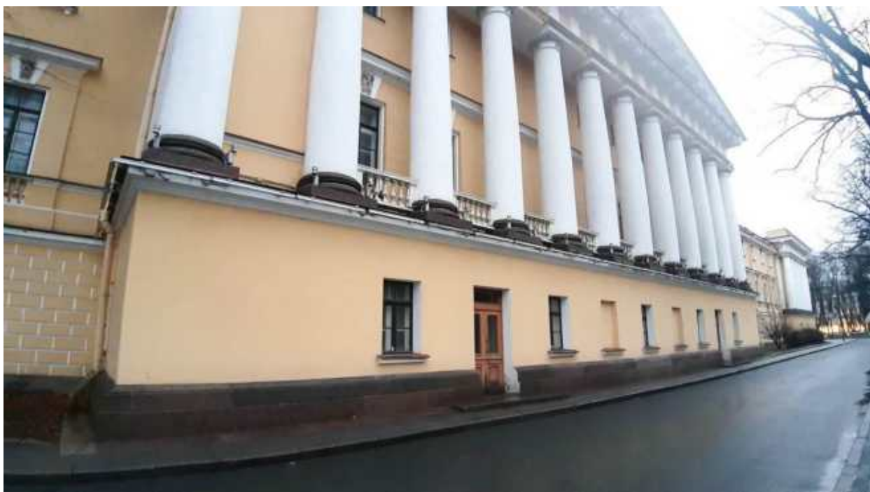
26. «Главное Адмиралтейство» (Адмиралтейский проезд, д. 1, лит. А). Лицевой фасад по Адмиралтейскому проезду (фрагмент). Фото мест установки оборудования и прокладки кабельных трасс. Штиглиц М.С. 22.12.2025.
