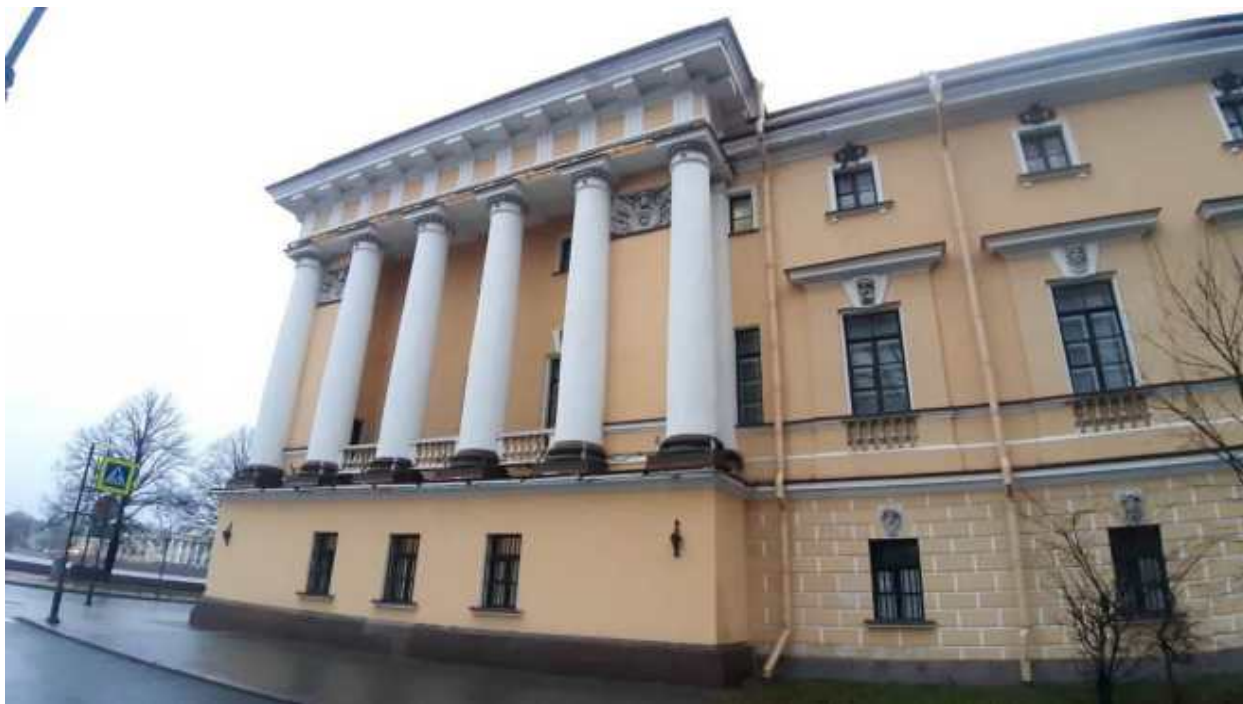
27. «Главное Адмиралтейство» (Адмиралтейский проезд, д. 1, лит. А). Лицевой фасад по Адмиралтейскому проезду (фрагмент). Фото мест установки оборудования и прокладки кабельных трасс. Штиглиц М.С. 22.12.2025.
