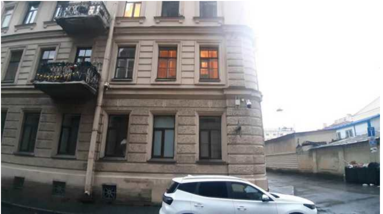
51. «Дом Т.В.Макаровой» (Адмиралтейская наб., д. 6, лит. А). Лицевой фасад по Азовскому пер. (фрагмент). Фото мест установки оборудования и прокладки кабельных трасс. Штиглиц М.С. 22.12.2025.
