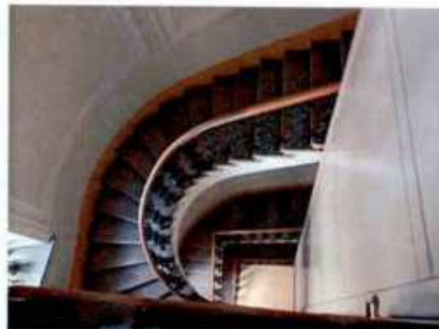
24. Здание 12. Лестница 2ЛК. (фото выполнено 27.06.2023).
