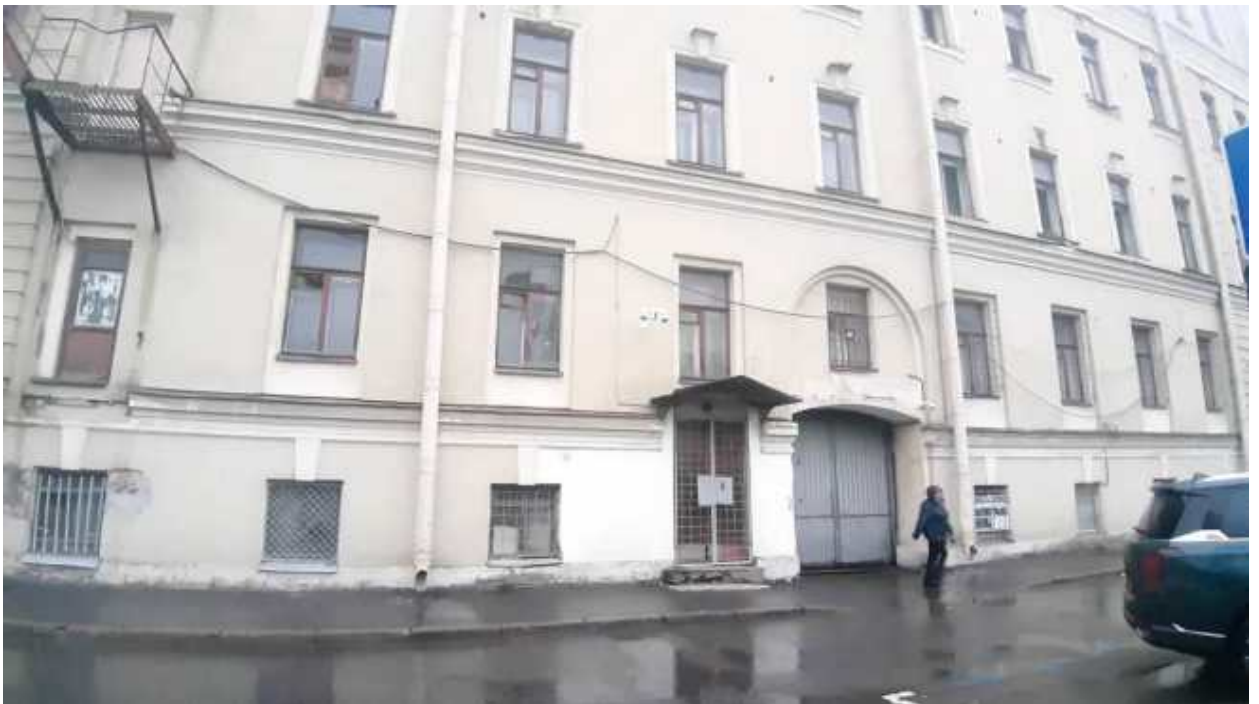
56. «Здания Государственного Дворянского земельного банка» (Адмиралтейская наб., д. 12-14, лит. А). Лицевой фасад по Черноморскому пер. (фрагмент). Фото мест установки оборудования и прокладки кабельных трасс. Штиглиц М.С. 22.12.2025.
