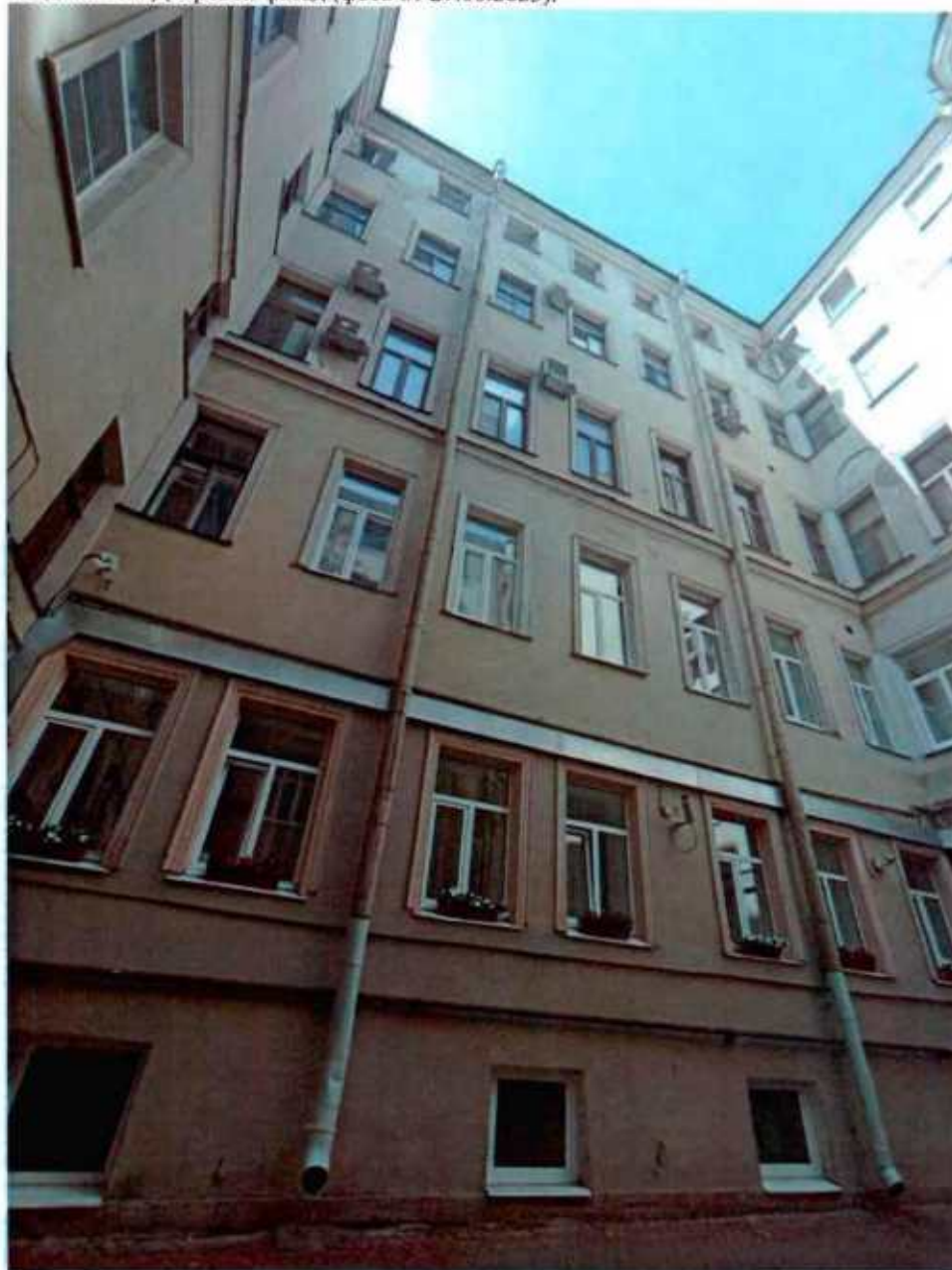
8. Здание 12. Дворовой фасад (фото от 27.06.2023).
