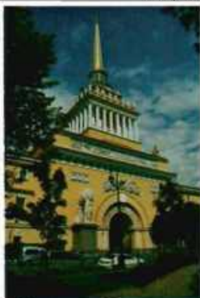
2. (Центральная башня, лицевой фасад)
