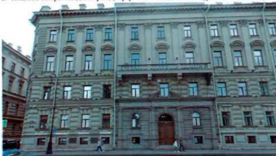
2. Лицевой северо-западный фасад, оформление входной зоны (фото от 27.06.2023).
