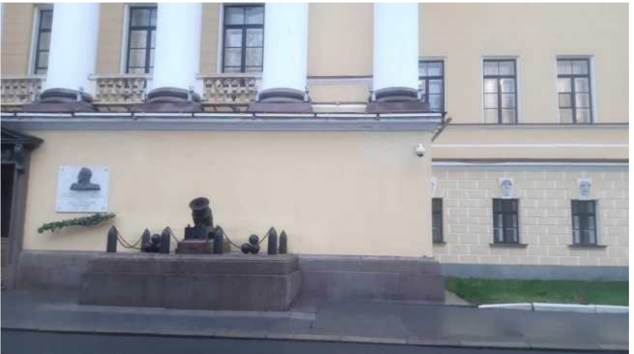
6. «Главное Адмиралтейство» (Адмиралтейский проезд, д. 1, лит. А). Лицевой фасад по Адмиралтейскому проезду (фрагмент). Фото мест установки оборудования и прокладки кабельных трасс. Штиглиц М.С. 22.12.2025.
