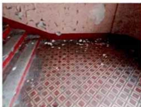
19. Здание 14. Лестничная площадка. (фото выполнено 24.03.2023).
