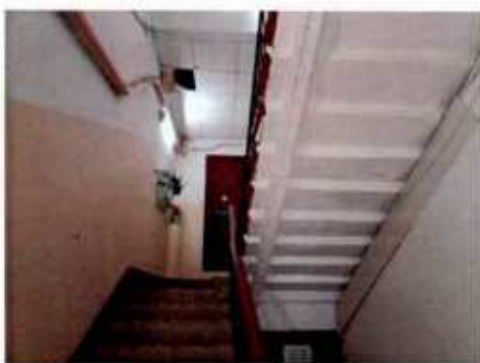
25. Здание 12. Лестница 3ЛК. (фото выполнено 27.06.2023).
