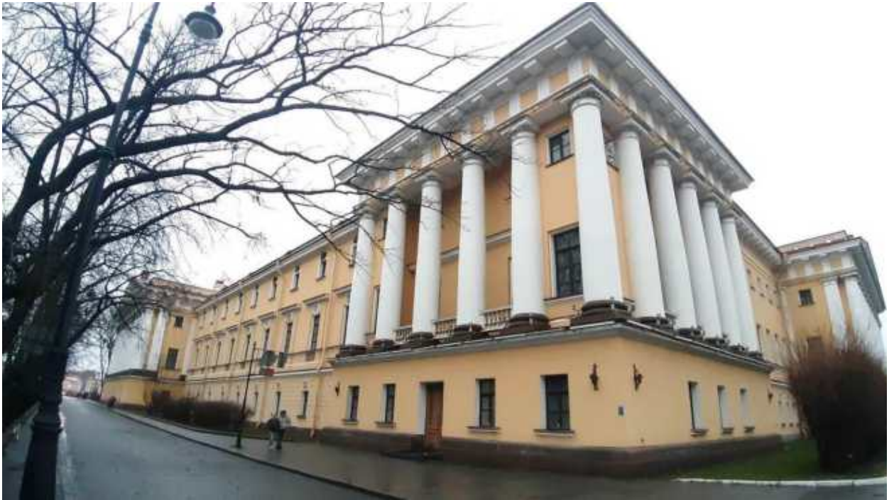
23. «Главное Адмиралтейство» (Адмиралтейский проезд, д. 1, лит. А). Лицевой фасад по Адмиралтейскому проезду (фрагмент). Фото мест установки оборудования и прокладки кабельных трасс. Штиглиц М.С. 22.12.2025.
