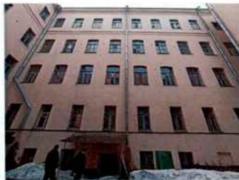
12. Здание 14. Дворовой фасад. (фото выполнено 24.03.2023).
