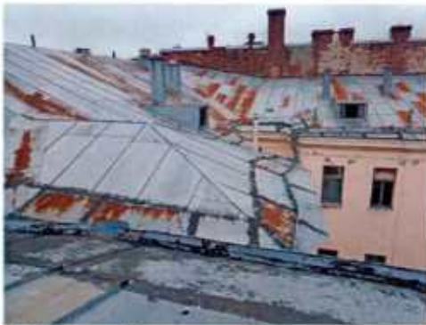
43. Кровля. Покрытие: (фото выполнено 27.06.2023).
