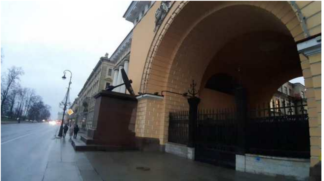
31. «Главное Адмиралтейство» (Адмиралтейский проезд, д. 1, лит. А). Лицевой фасад по Адмиралтейской наб. (фрагмент). Фото мест установки оборудования и прокладки кабельных трасс. Штиглиц М.С. 22.12.2025.
