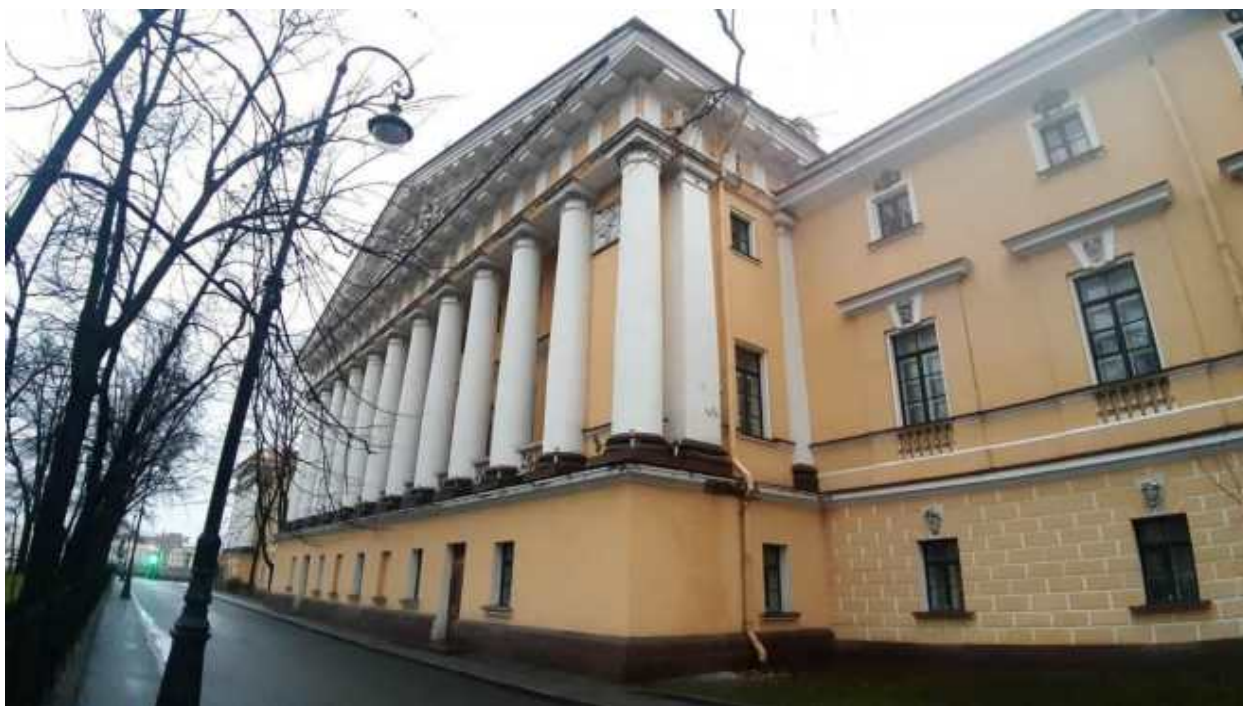
25. «Главное Адмиралтейство» (Адмиралтейский проезд, д. 1, лит. А). Лицевой фасад по Адмиралтейскому проезду (фрагмент). Фото мест установки оборудования и прокладки кабельных трасс. Штиглиц М.С. 22.12.2025.
