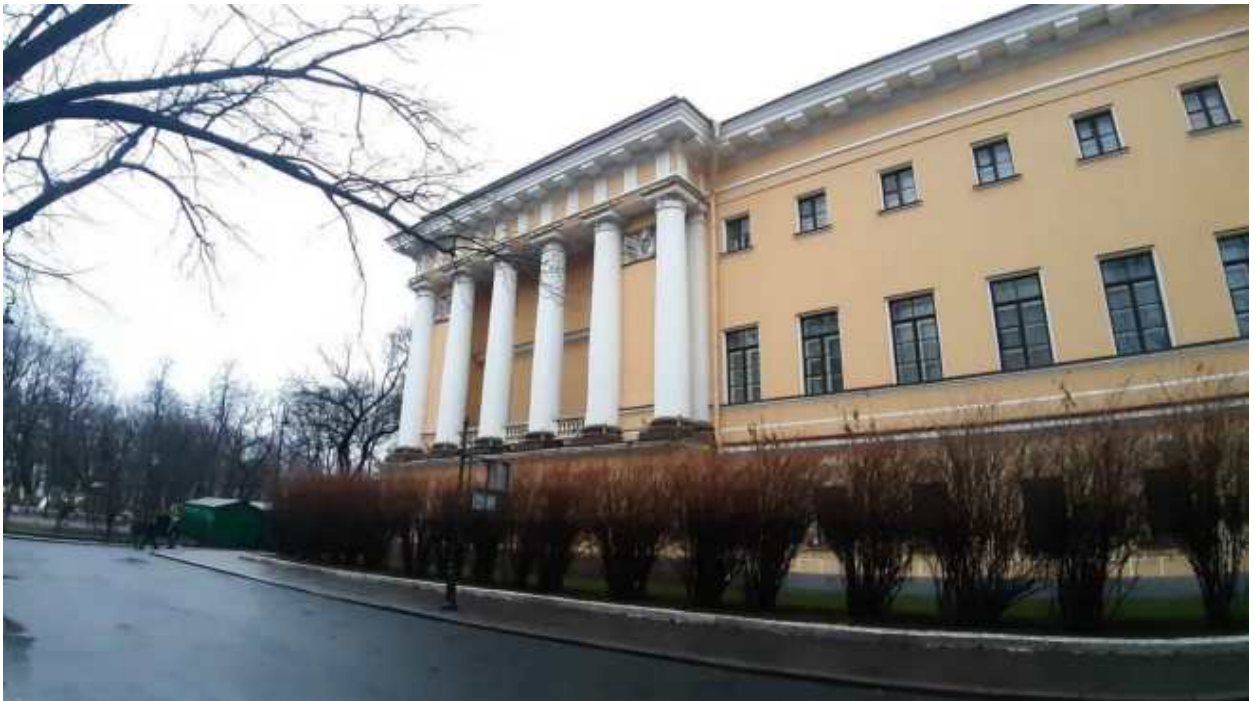
22. «Главное Адмиралтейство» (Адмиралтейский проезд, д. 1, лит. А). Лицевой фасад по Адмиралтейскому проезду (фрагмент). Фото мест установки оборудования и прокладки кабельных трасс. Штиглиц М.С. 22.12.2025.
