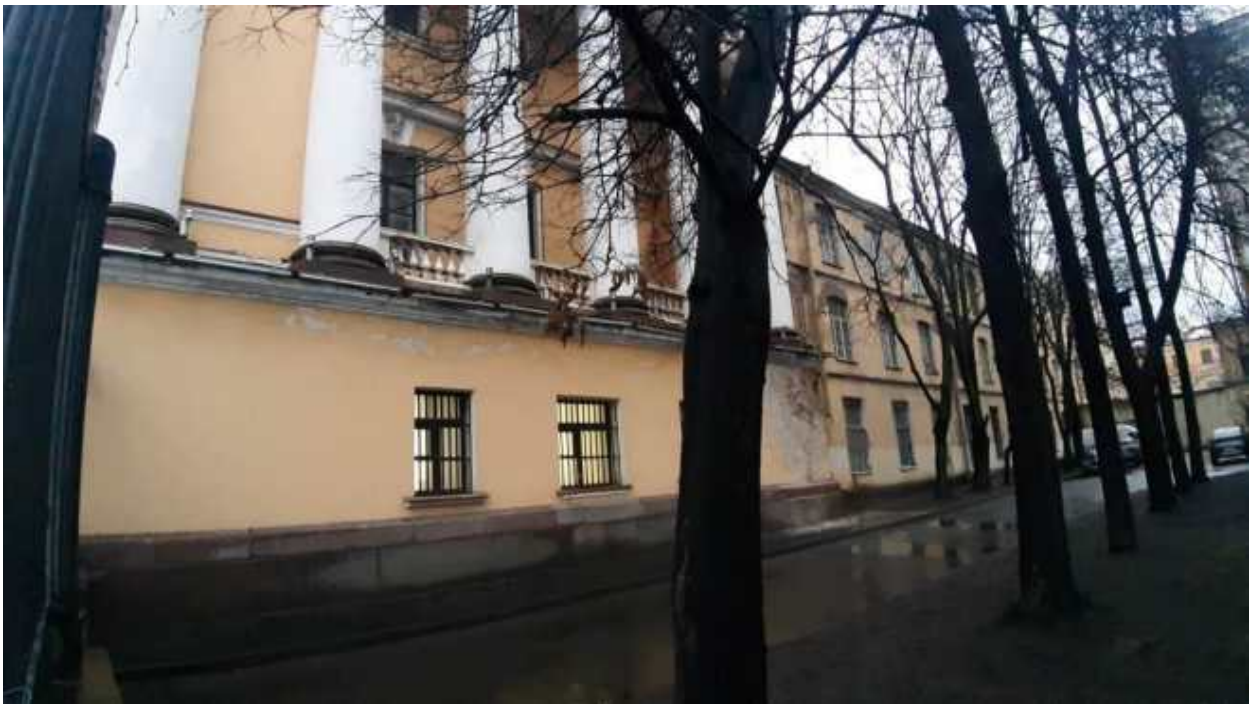
34. «Главное Адмиралтейство» (Адмиралтейский проезд, д. 1, лит. А). Лицевой фасад по Черноморскому пер. (фрагмент). Фото мест установки оборудования и прокладки кабельных трасс. Штиглиц М.С. 22.12.2025.
