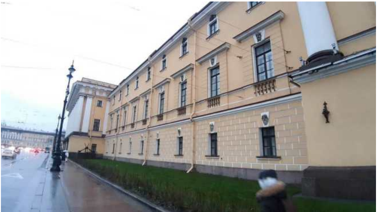
40. «Главное Адмиралтейство» (Адмиралтейский проезд, д. 1, лит. А). Лицевой фасад по Дворцовому проезду (фрагмент). Фото мест установки оборудования и прокладки кабельных трасс. Штиглиц М.С. 22.12.2025.
