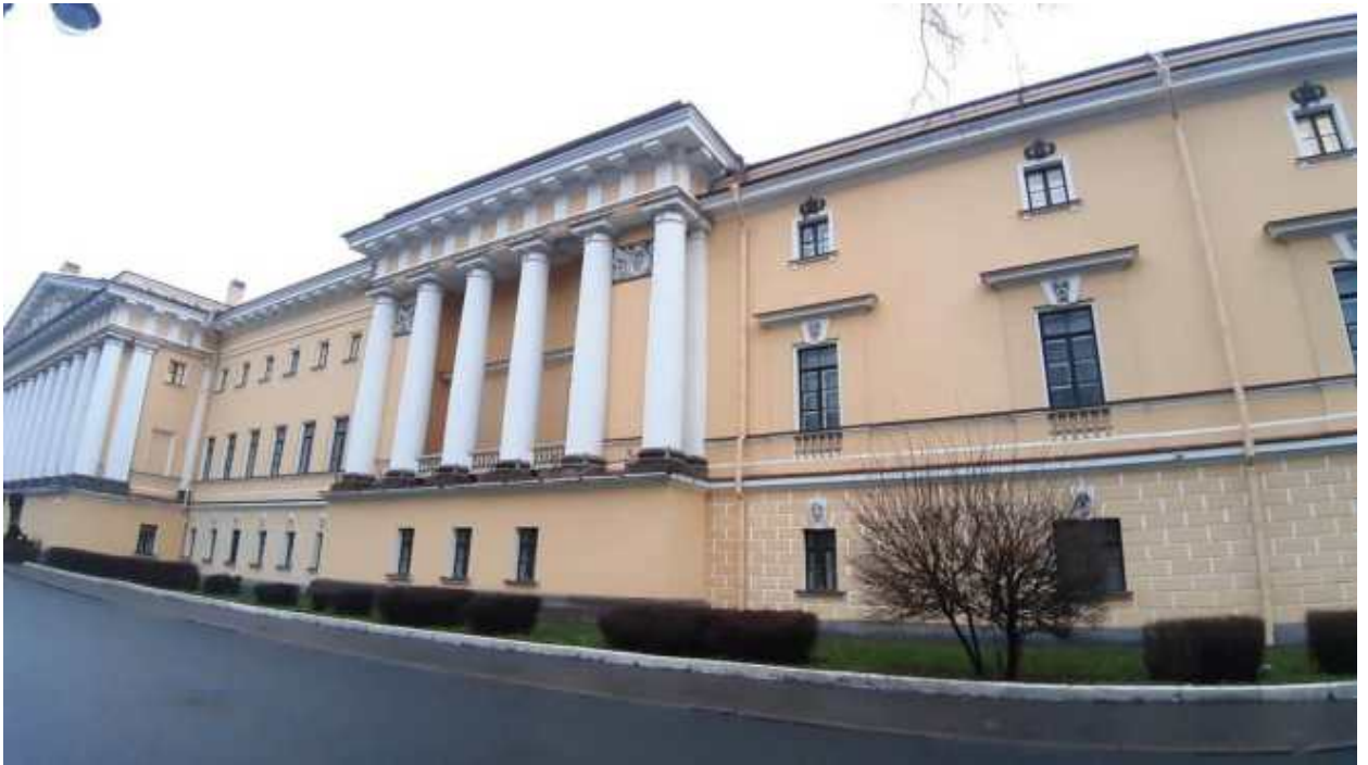
17. «Главное Адмиралтейство» (Адмиралтейский проезд, д. 1, лит. А). Лицевой фасад по Адмиралтейскому проезду (фрагмент). Фото мест установки оборудования и прокладки кабельных трасс. Штиглиц М.С. 22.12.2025.
