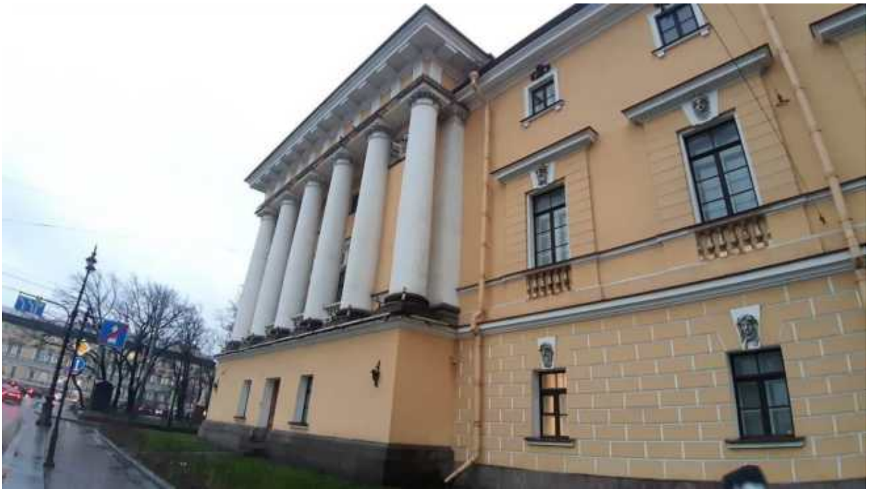
47. «Главное Адмиралтейство» (Адмиралтейский проезд, д. 1, лит. А). Лицевой фасад по Дворцовому проезду (фрагмент). Фото мест установки оборудования и прокладки кабельных трасс. Штиглиц М.С. 22.12.2025.
