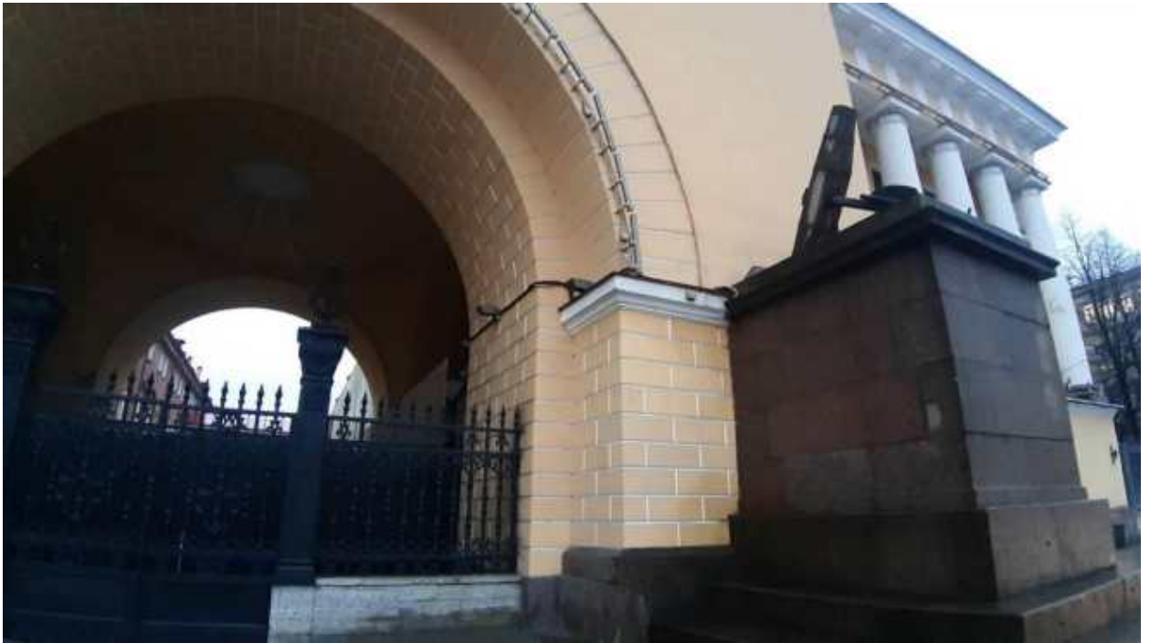
37. «Главное Адмиралтейство» (Адмиралтейский проезд, д. 1, лит. А). Лицевой фасад по Адмиралтейской наб. (фрагмент). Фото мест установки оборудования и прокладки кабельных трасс. Штиглиц М.С. 22.12.2025.
