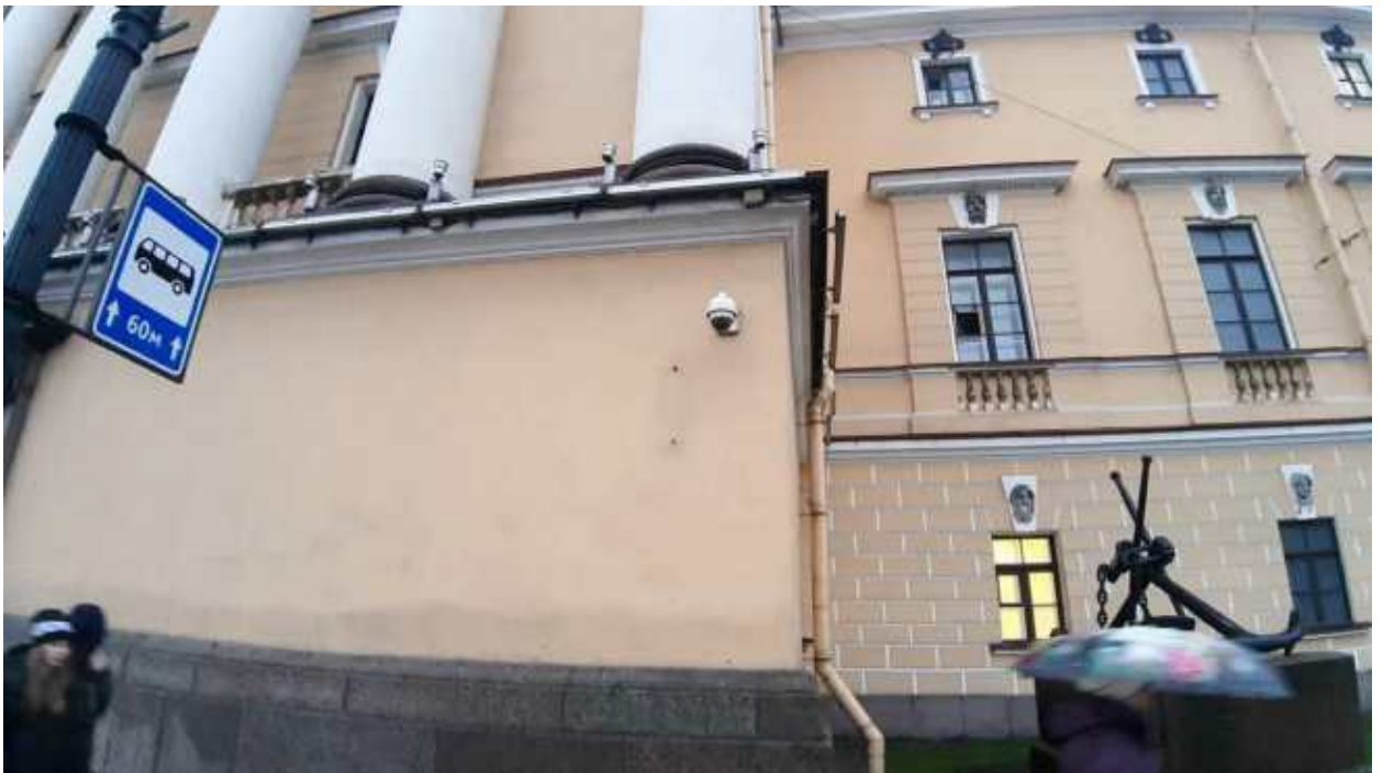
42. «Главное Адмиралтейство» (Адмиралтейский проезд, д. 1, лит. А). Лицевой фасад по Дворцовому проезду (фрагмент). Фото мест установки оборудования и прокладки кабельных трасс. Штиглиц М.С. 22.12.2025.
