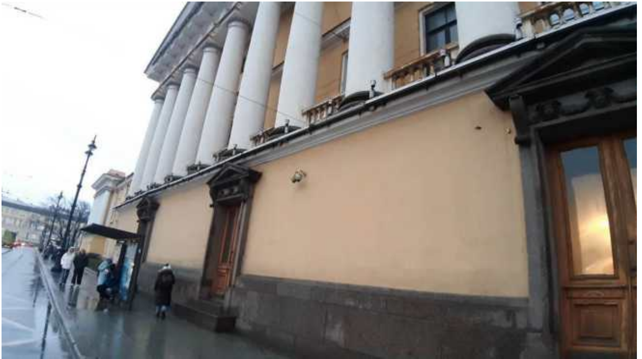
43. «Главное Адмиралтейство» (Адмиралтейский проезд, д. 1, лит. А). Лицевой фасад по Дворцовому проезду (фрагмент). Фото мест установки оборудования и прокладки кабельных трасс. Штиглиц М.С. 22.12.2025.
