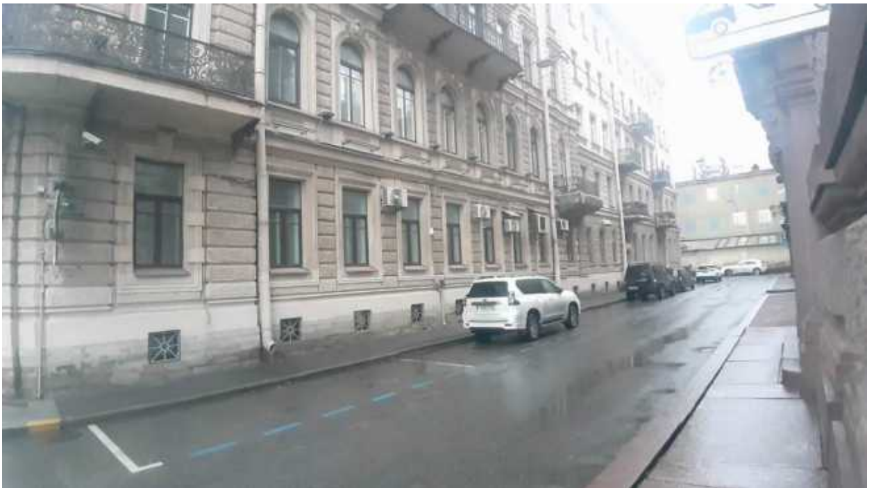
52. «Дом Т.В.Макаровой» (Адмиралтейская наб., д. 6, лит. А). Лицевой фасад по Азовскому пер. (фрагмент). Фото мест установки оборудования и прокладки кабельных трасс. Штиглиц М.С. 22.12.2025.
