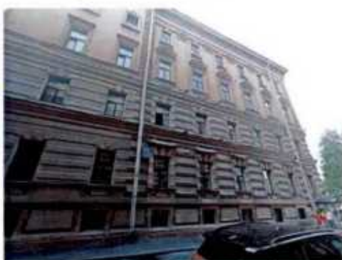
3. Северо-восточный фасад. (фото выполнено 27.06.2023).
