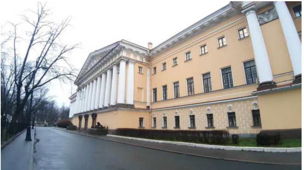
18. «Главное Адмиралтейство» (Адмиралтейский проезд, д. 1, лит. А). Лицевой фасад по Адмиралтейскому проезду (фрагмент). Фото мест установки оборудования и прокладки кабельных трасс. Штиглиц М.С. 22.12.2025.
