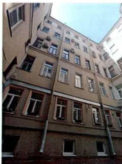
8. Здание 12. Дворовой фасад. (фото выполнено 27.06.2023).
