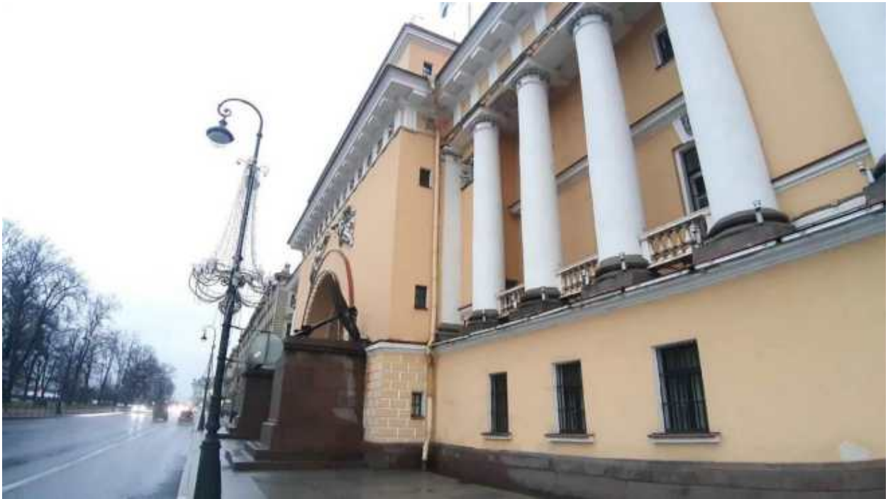
29. «Главное Адмиралтейство» (Адмиралтейский проезд, д. 1, лит. А). Лицевой фасад по Адмиралтейской наб. (фрагмент). Фото мест установки оборудования и прокладки кабельных трасс. Штиглиц М.С. 22.12.2025.
