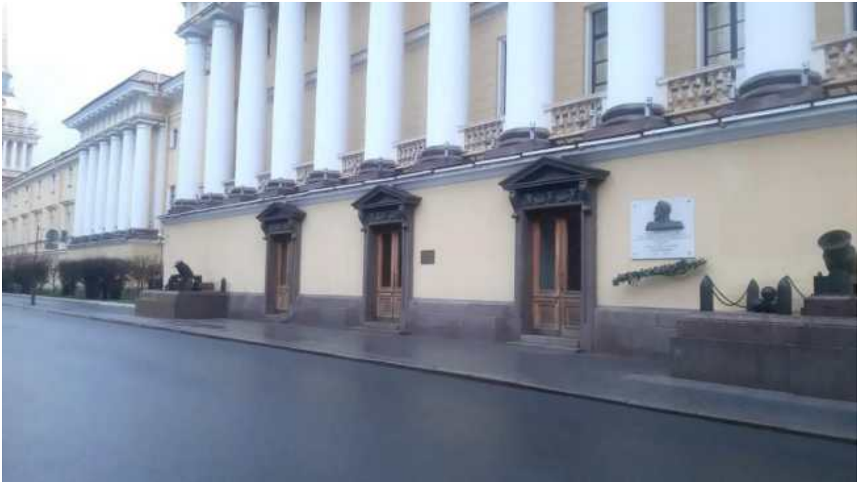
7. «Главное Адмиралтейство» (Адмиралтейский проезд, д. 1, лит. А). Лицевой фасад по Адмиралтейскому проезду (фрагмент). Фото мест установки оборудования и прокладки кабельных трасс. Штиглиц М.С. 22.12.2025.
