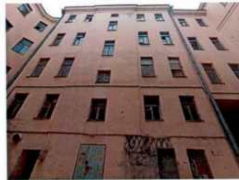
14. Здание 14. Дворовой фасад. (фото выполнено 24.03.2023).
