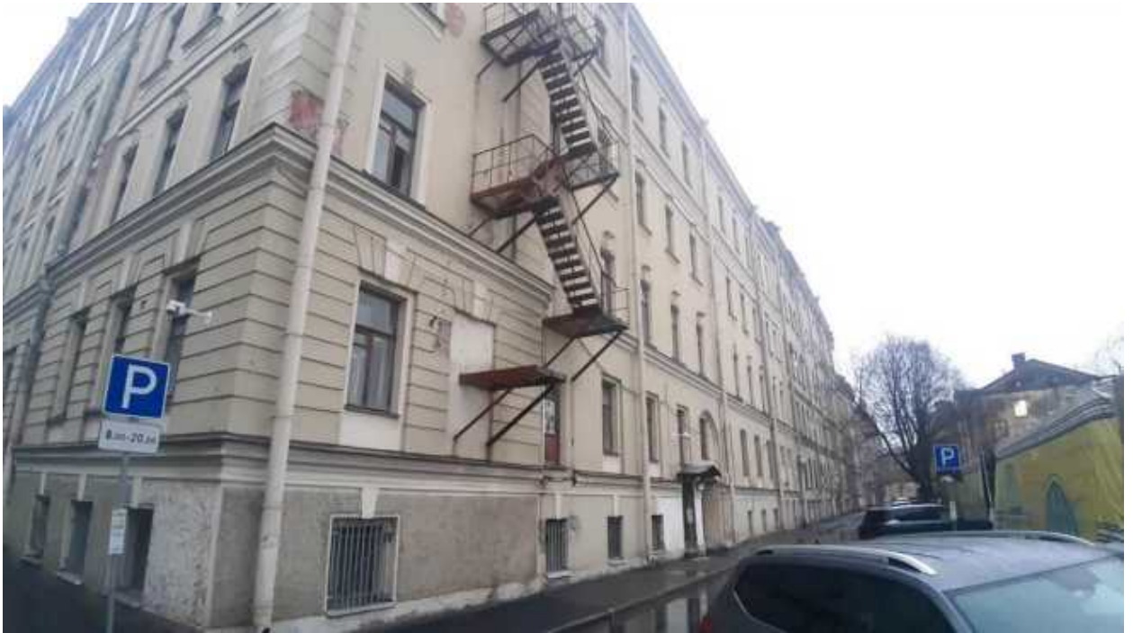
55. «Здания Государственного Дворянского земельного банка» (Адмиралтейская наб., д. 12-14, лит. А). Лицевой фасад по Черноморскому пер. (фрагмент). Фото мест установки оборудования и прокладки кабельных трасс. Штиглиц М.С. 22.12.2025.
