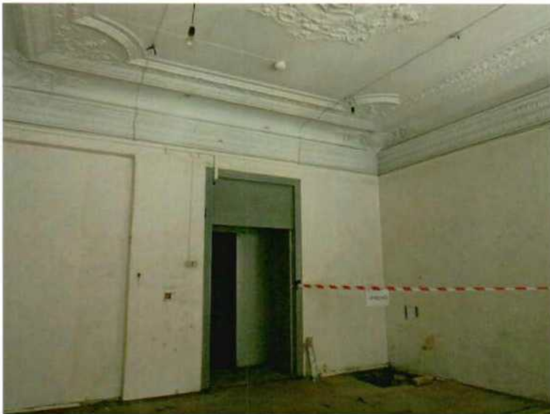
4. Помещение 1 этажа (13-Н(17)).
