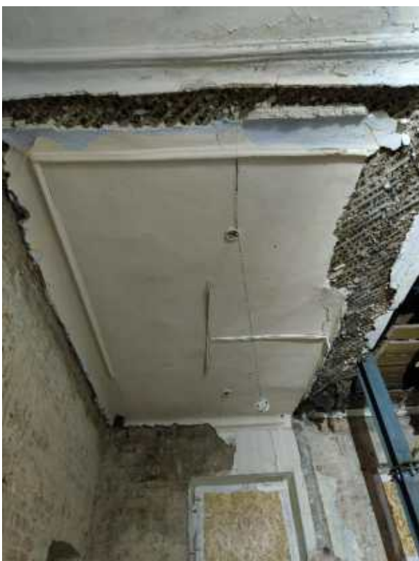
18. «Дом Е.С. и М.Б. Трофимовых», ул. Бронницкая, д. 1-3, лит. А. Второй этаж. Фрагмент. Фото 24.10.2025г.
