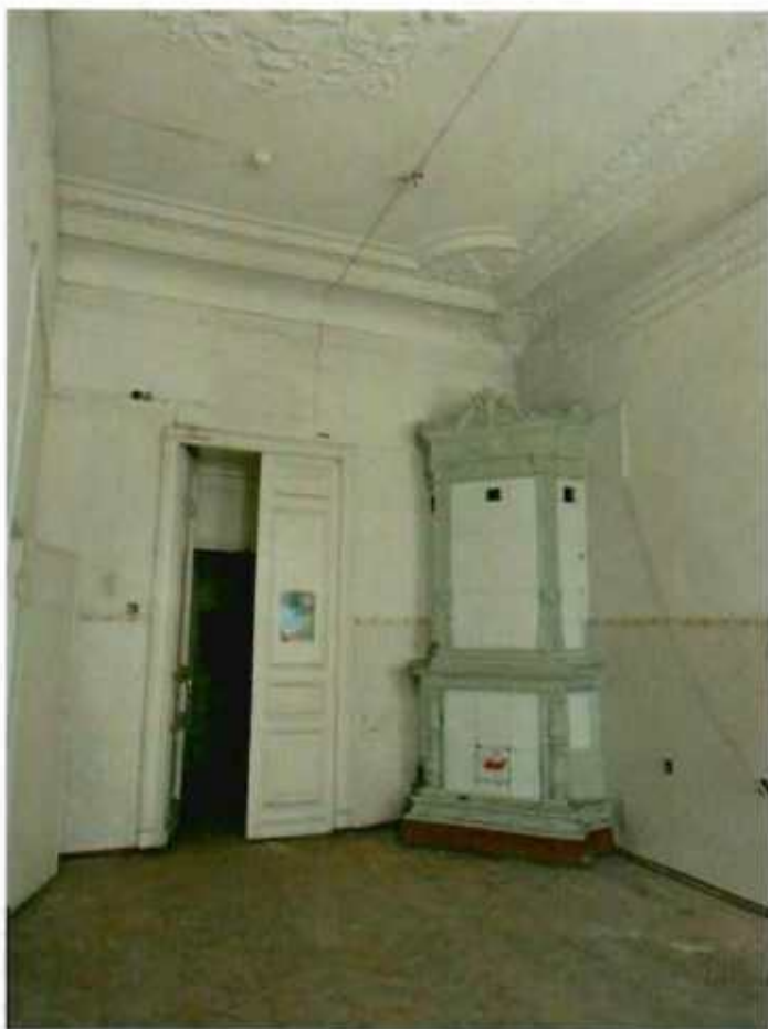
6. Помещение 2 этажа (18-Н(16)).
