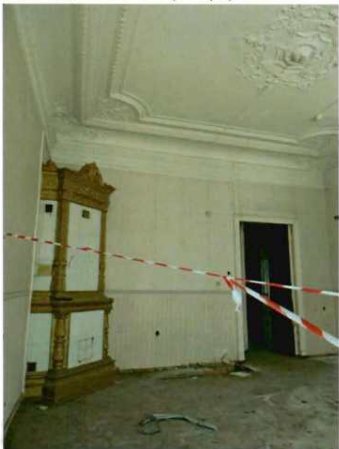
7. Помещение 2 этажа (19-Н(3)).
