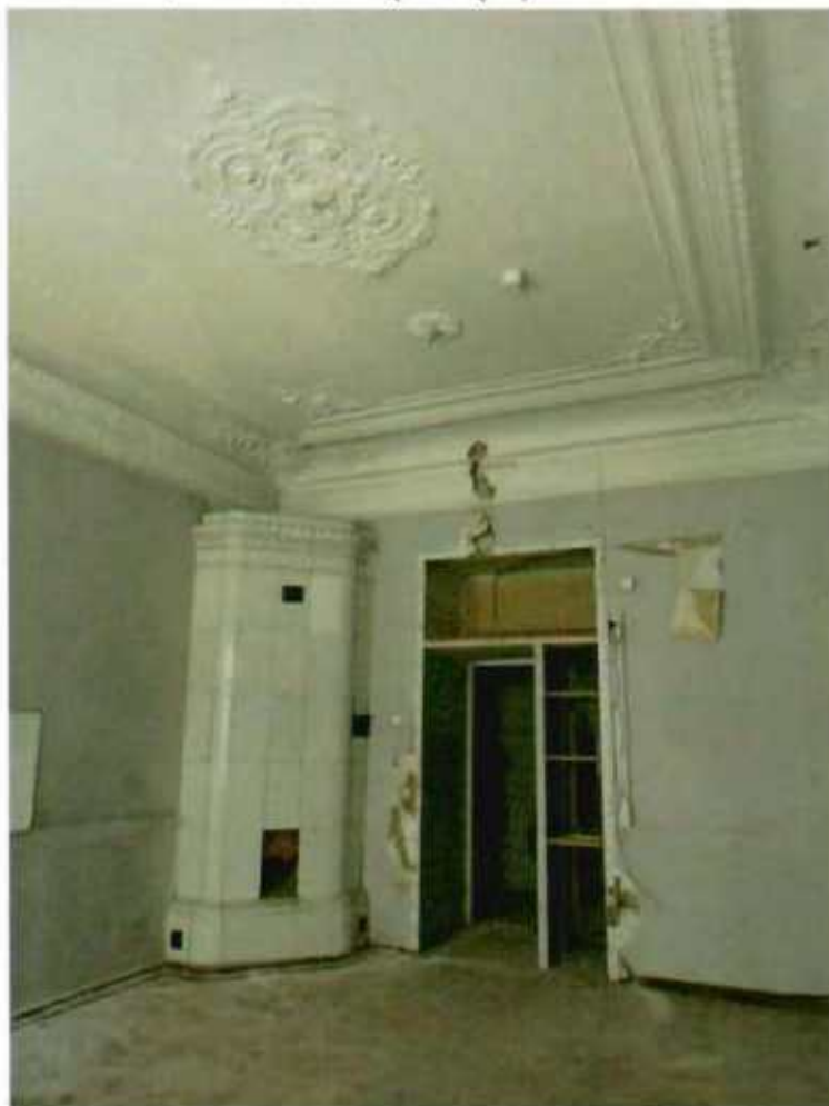
5. Помещение 1 этажа (14-Н(8)).
