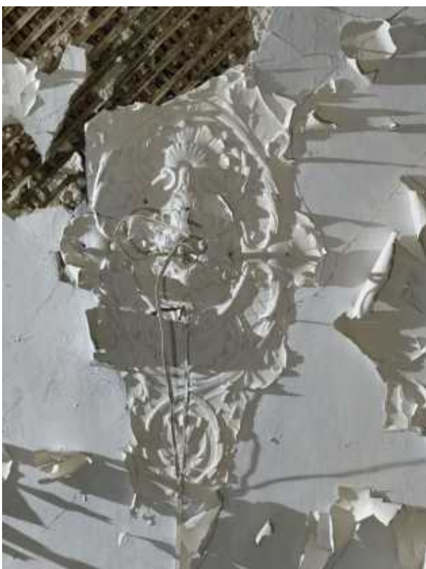
22. «Дом Е.С. и М.Б. Трофимовых», ул. Бронницкая, д. 1-3, лит. А. Второй этаж. Фрагмент. Фото 24.10.2025г.
