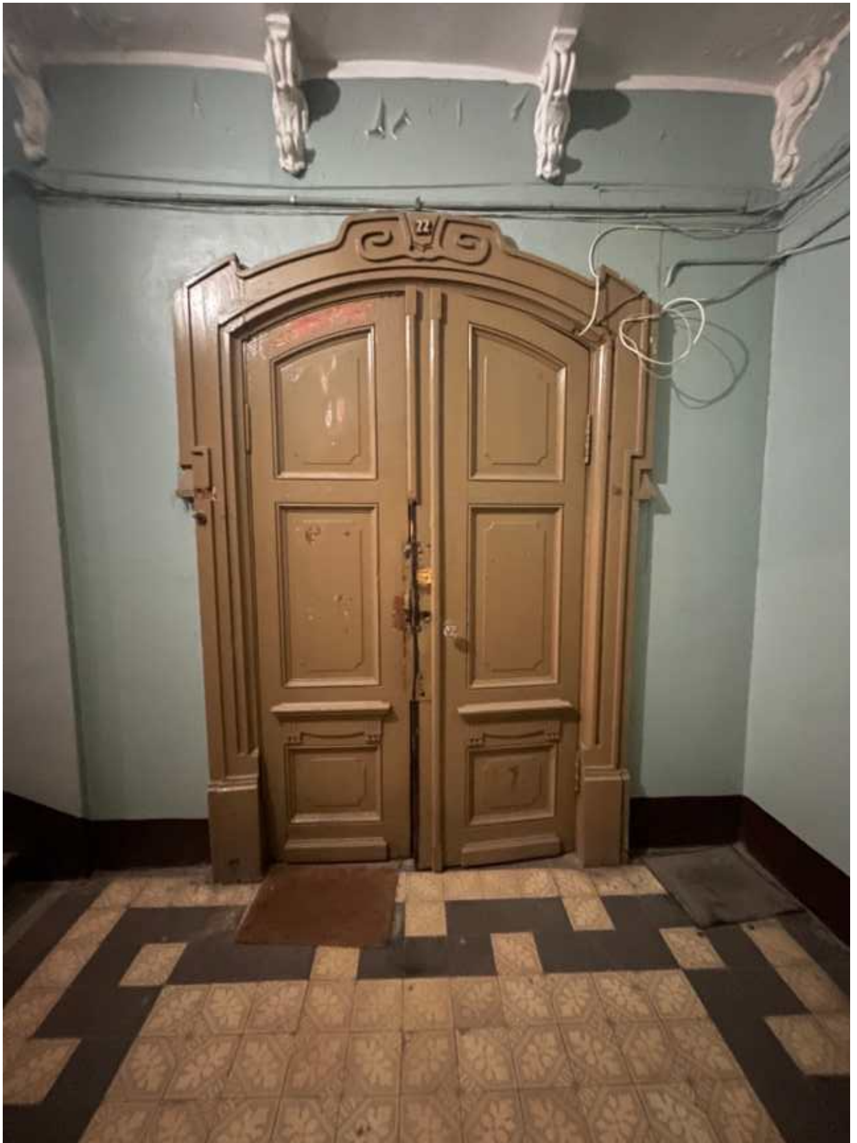
3. Входная дверь квартиры со стороны лестницы.
