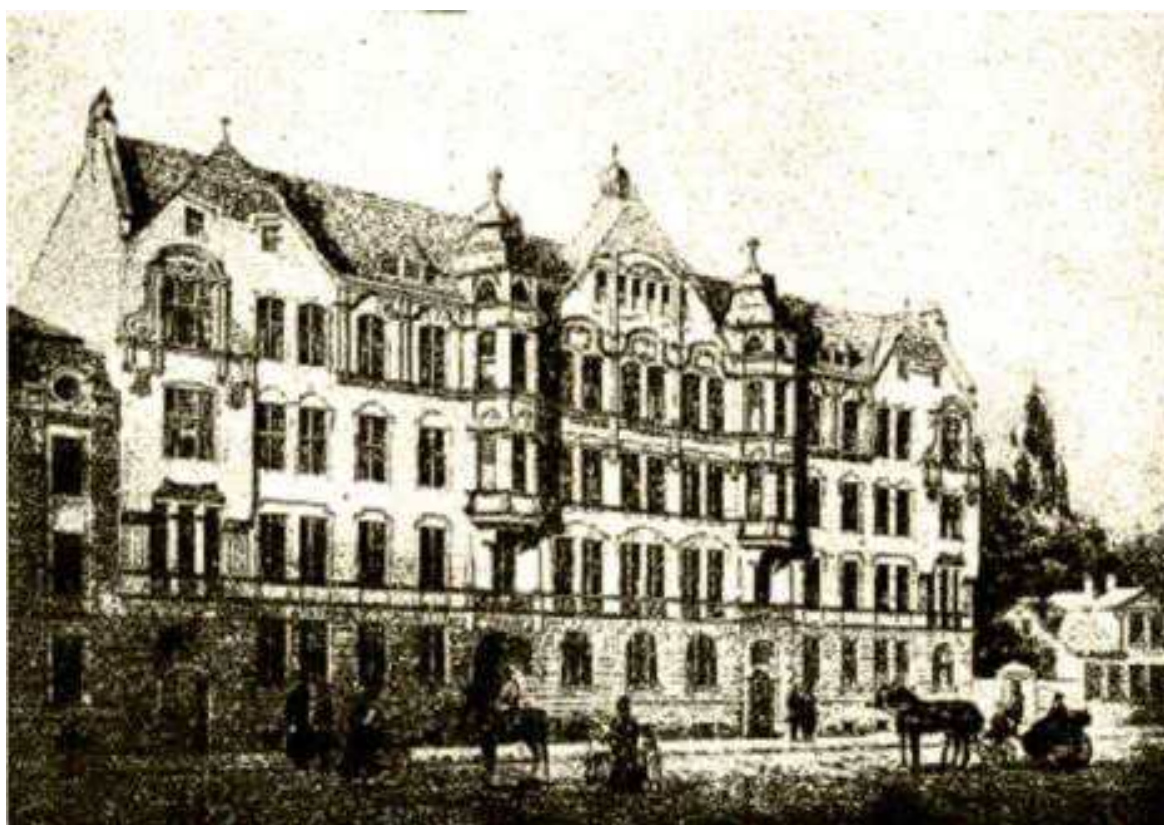
2. Вид здания после постройки. Фотография начала XX в.
