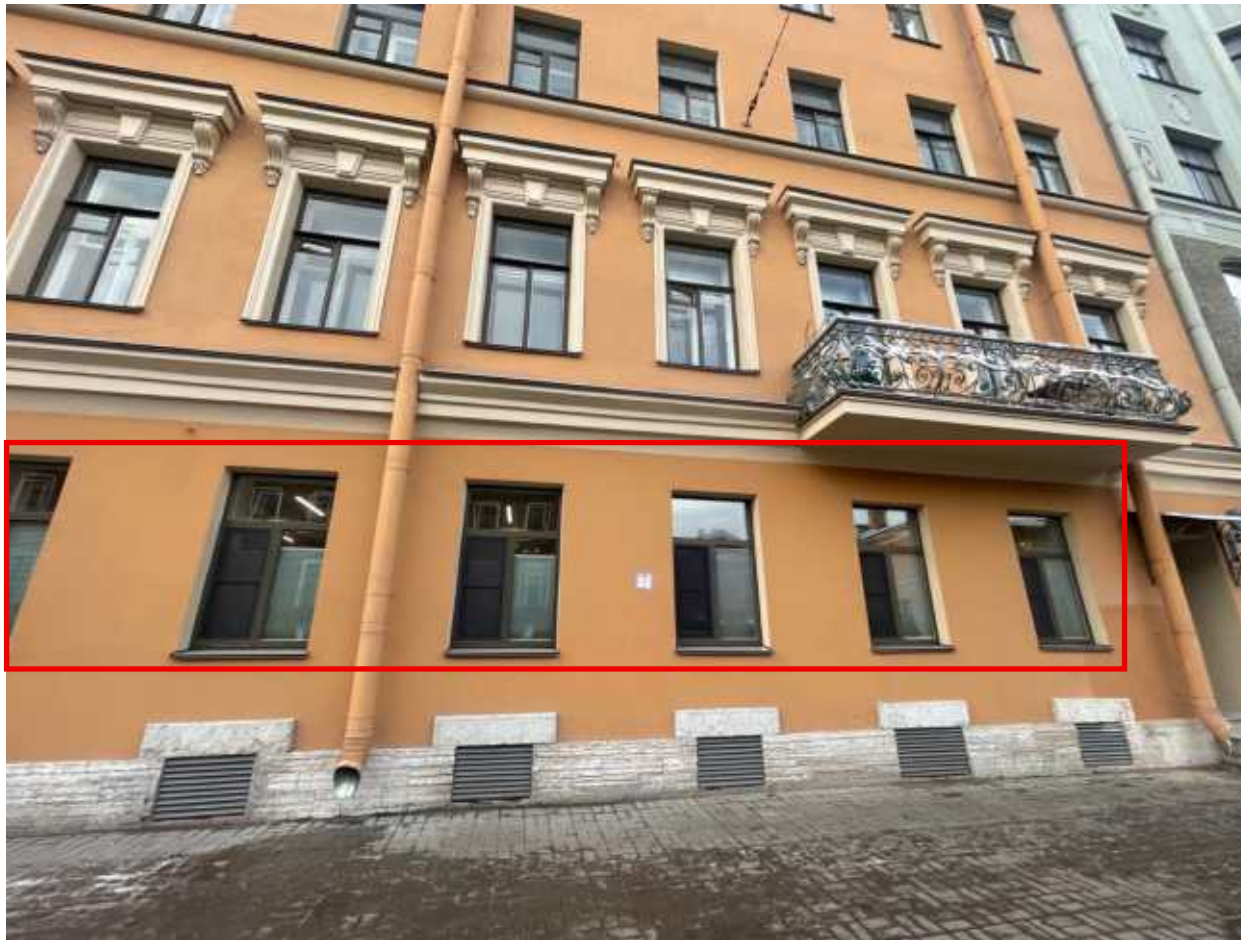
2. Фрагмент лицевого фасада. Красной линией отмечены оконные проемы помещения.
