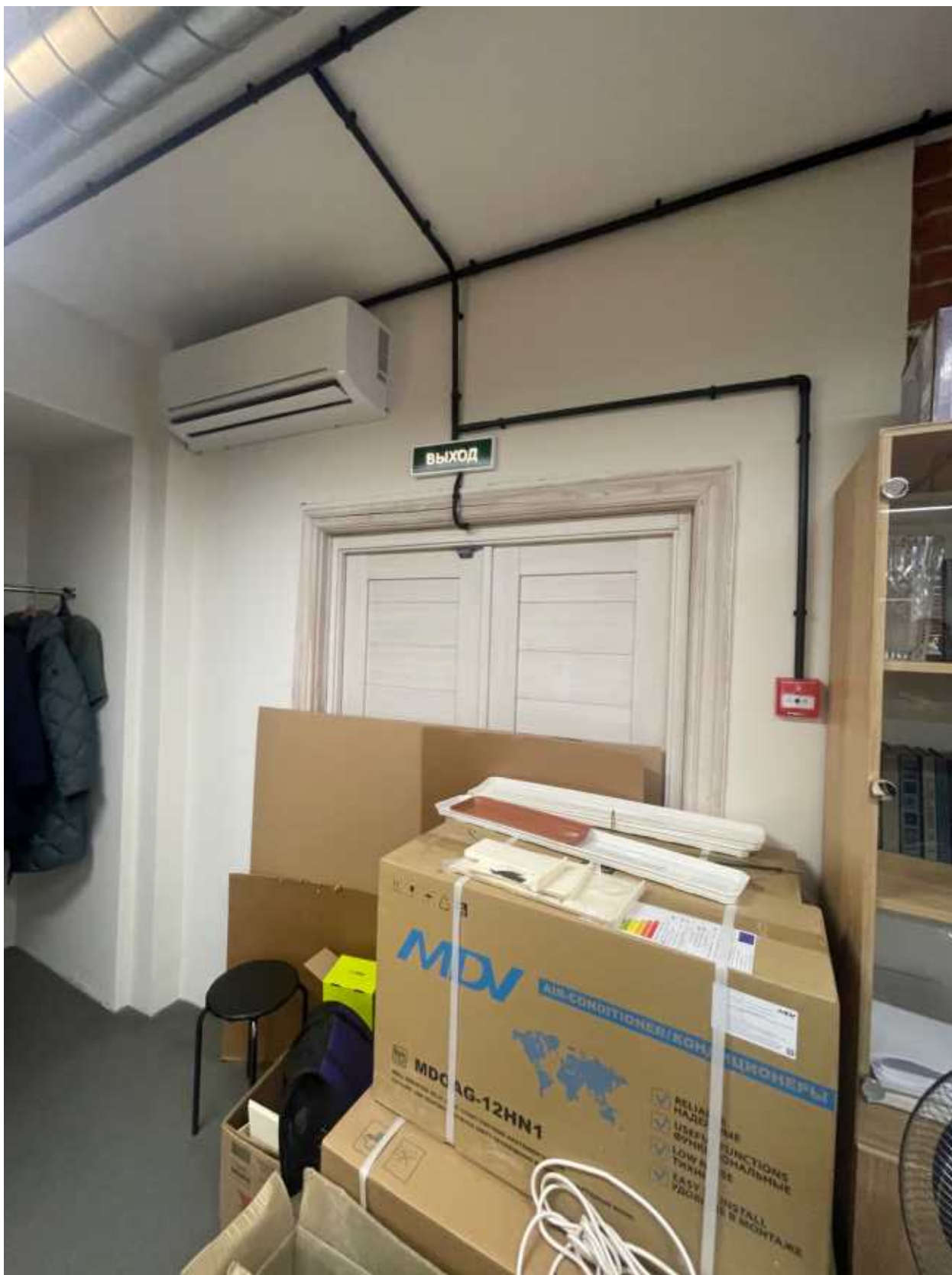
21. Входная дверь со стороны лестничной клетки изнутри.
