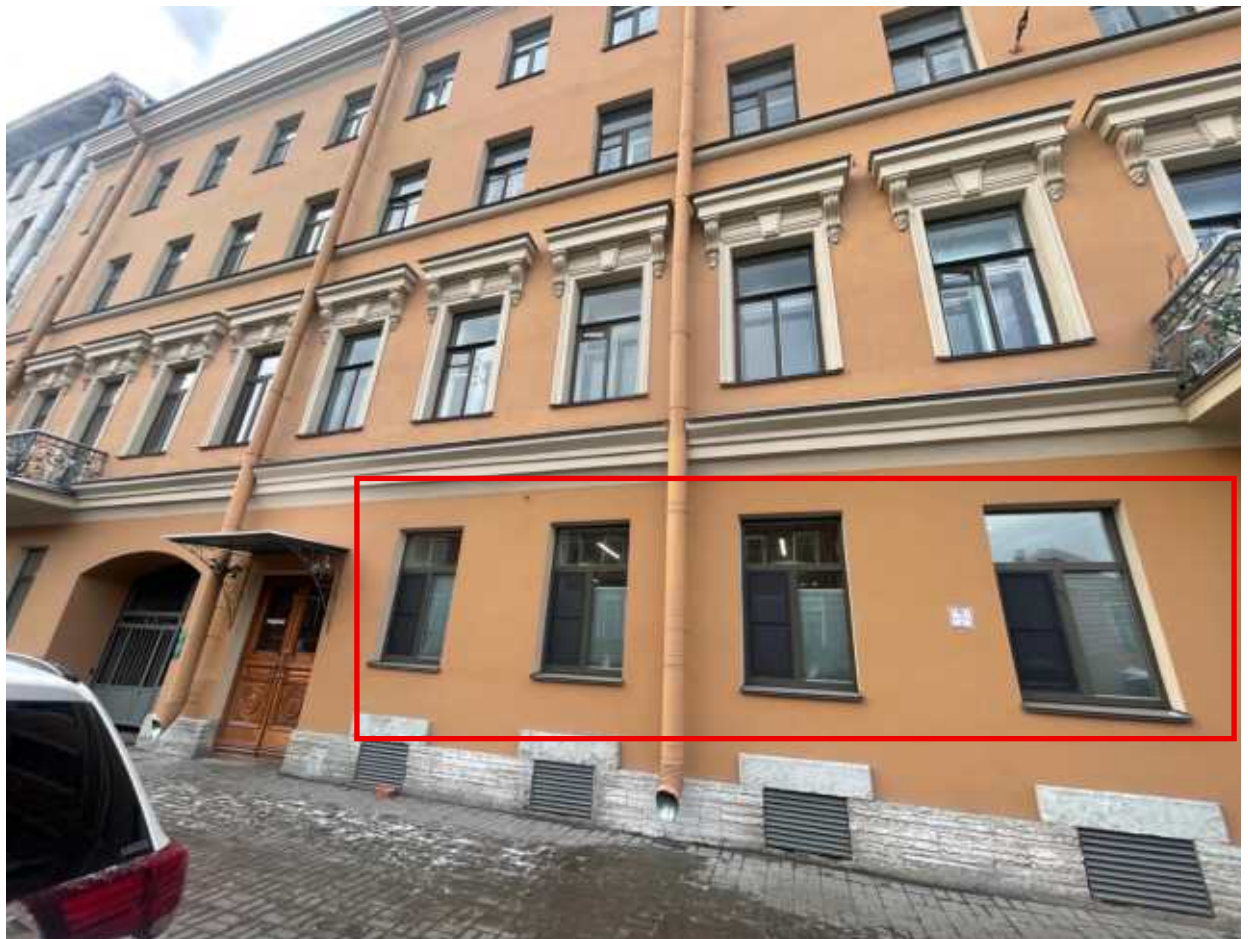
3. Фрагмент лицевого фасада. Красной линией отмечены оконные проемы помещения.
