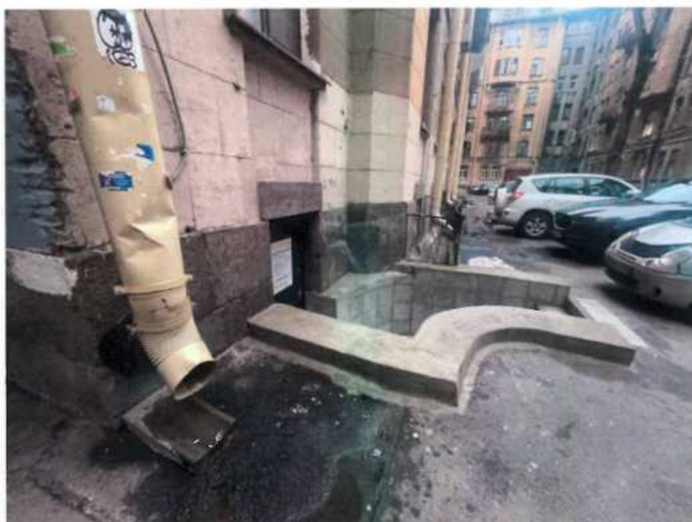
Рис. 11 Вход в часть помещения 31-Н на дату 28.11.2025 г.
