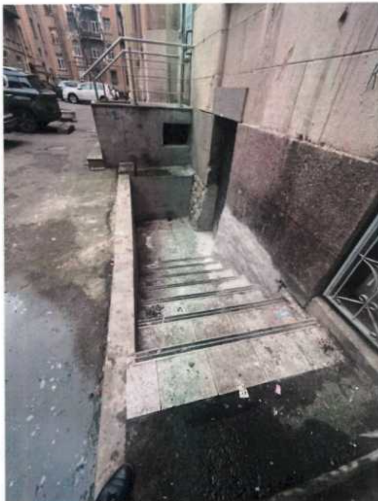
Рис. 8 Вход в часть помещения 2-Н на дату 28.11.2025 г.
