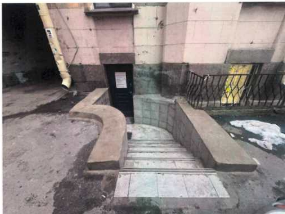
Рис. 10 Вход в часть помещения 31-Н на дату 28.11.2025 г.
