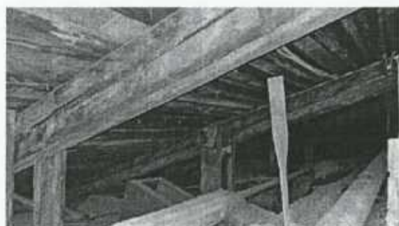
Вид деревянных конструкций кровли чердака
