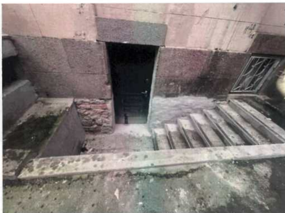
Рис. 9 Вход в часть помещения 2-Н на дату 28.11.2025 г.
