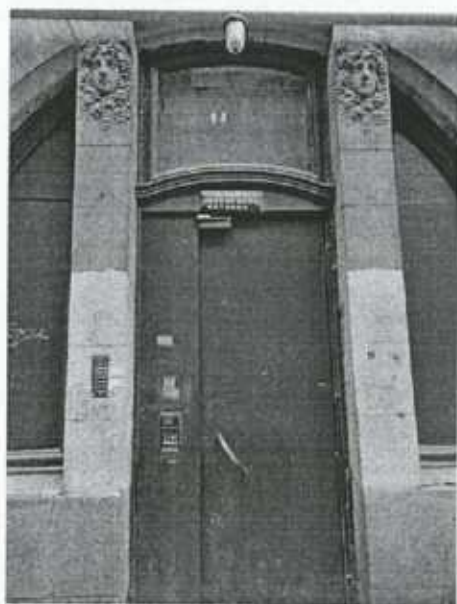
Вход в парадную № 2. Вид на лицевой фасад со стороны литеры Б.
