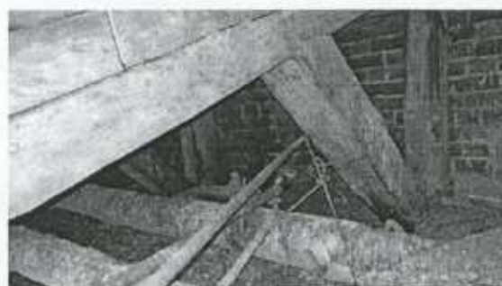
Вид деревянных конструкций кровли чердака
