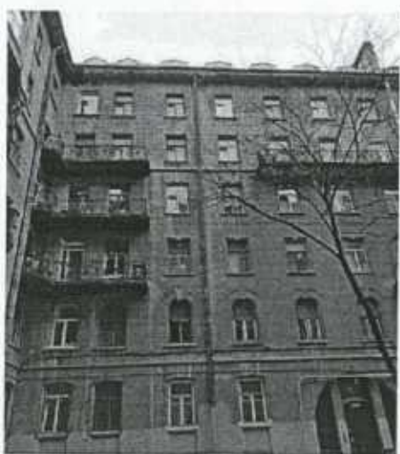
Вид на лицевой фасад со стороны лит. Б.
