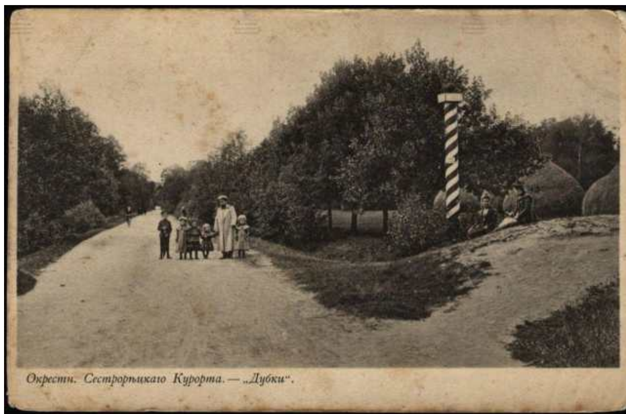
15. Вход в парк «Дубки». Фотооткрытка. 1900-1914 г. Источник: https://pastvu.com
