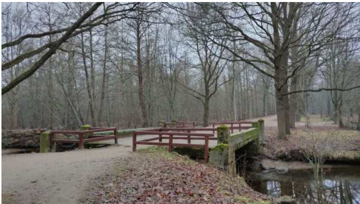
Фото 14. Вид на мост в южной части объекта культурного наследия федерального значения «Парк Дубки», расположенного по адресу: Санкт-Петербург, г. Сестрорецк, Дубковское шоссе, 59
